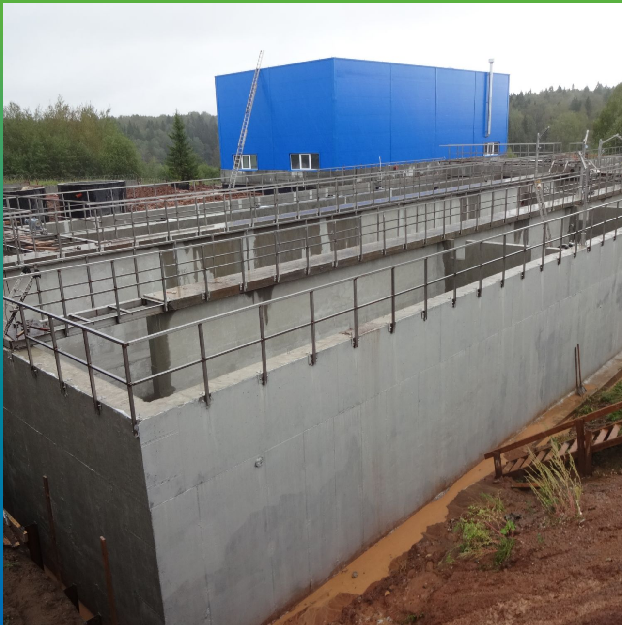
Отстойник после проведения работ по гидроизоляции
