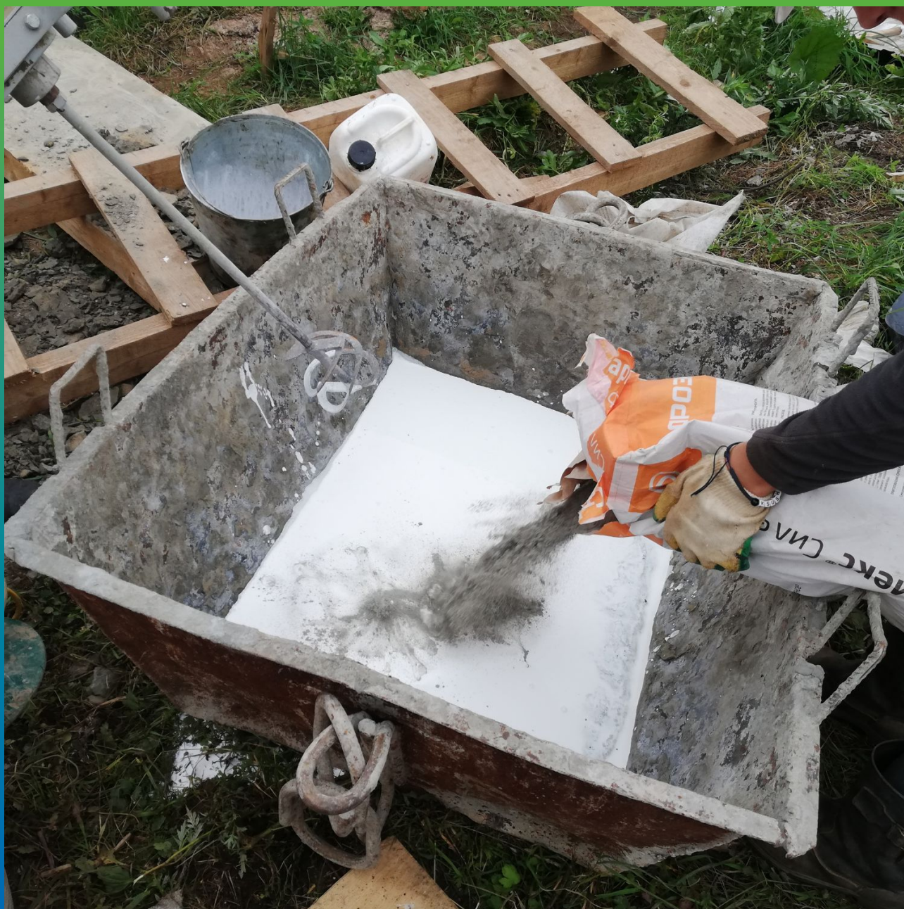
Перемешивание А+Б компонентов эластичной гидроизоляции Стармекс Сил Флекс
