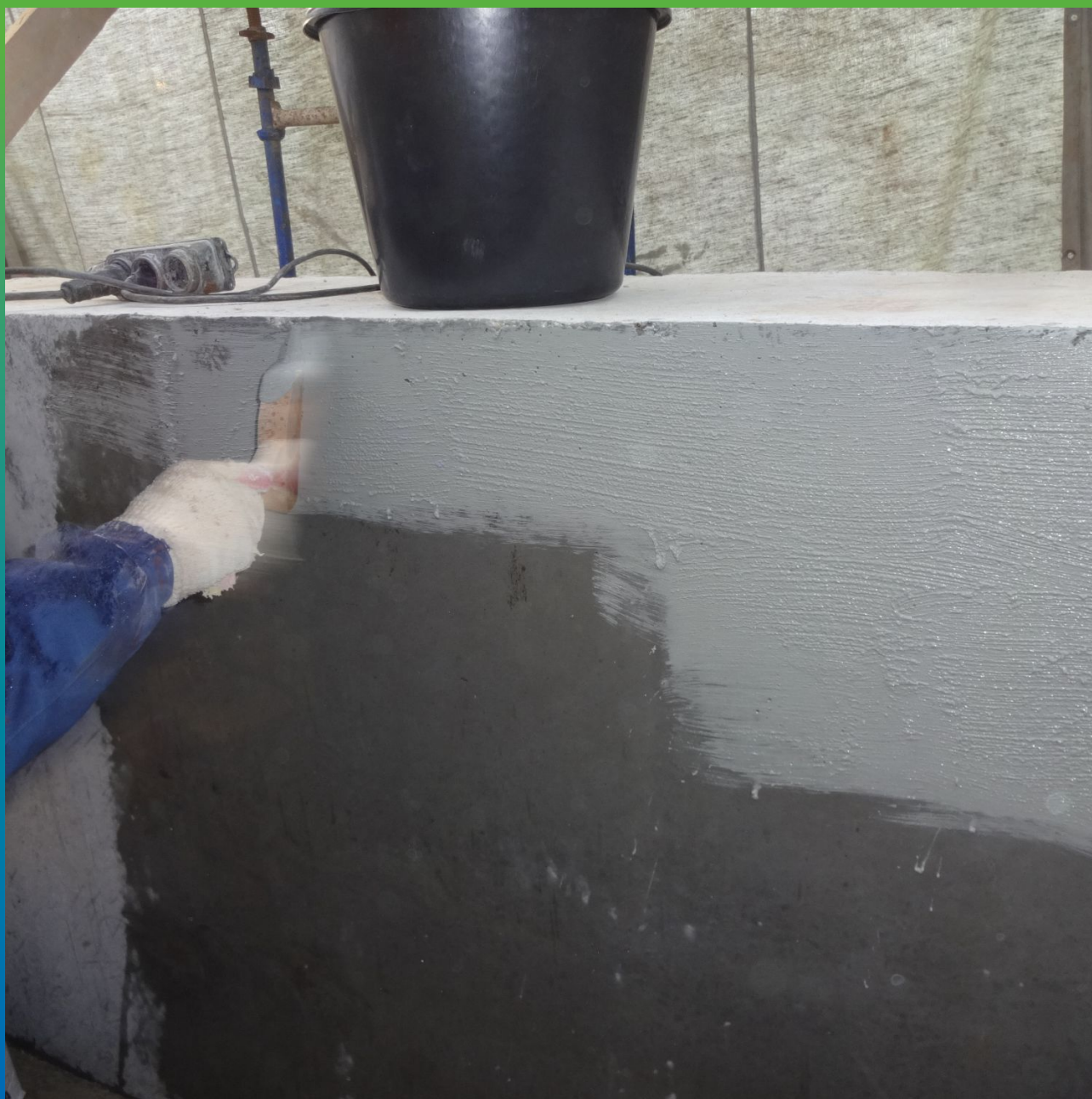
Нанесение гидроизоляции на внешние конструкции
