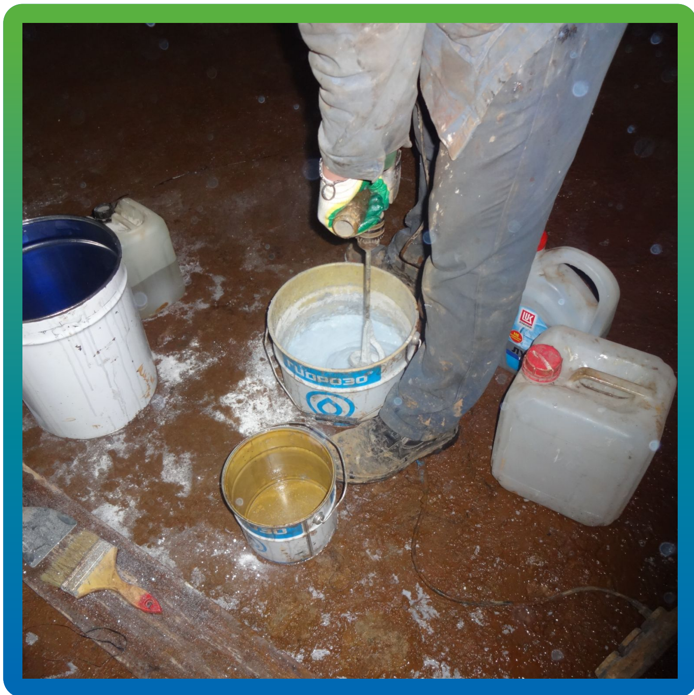
Перемешивание А+Б компонентов
