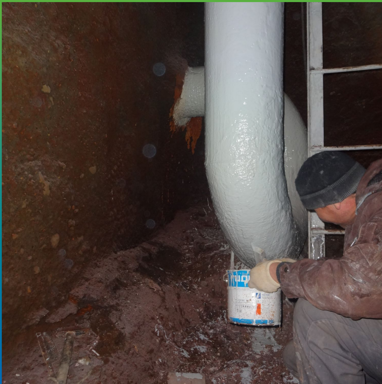
Нанесение материалов на металлические конструкции
