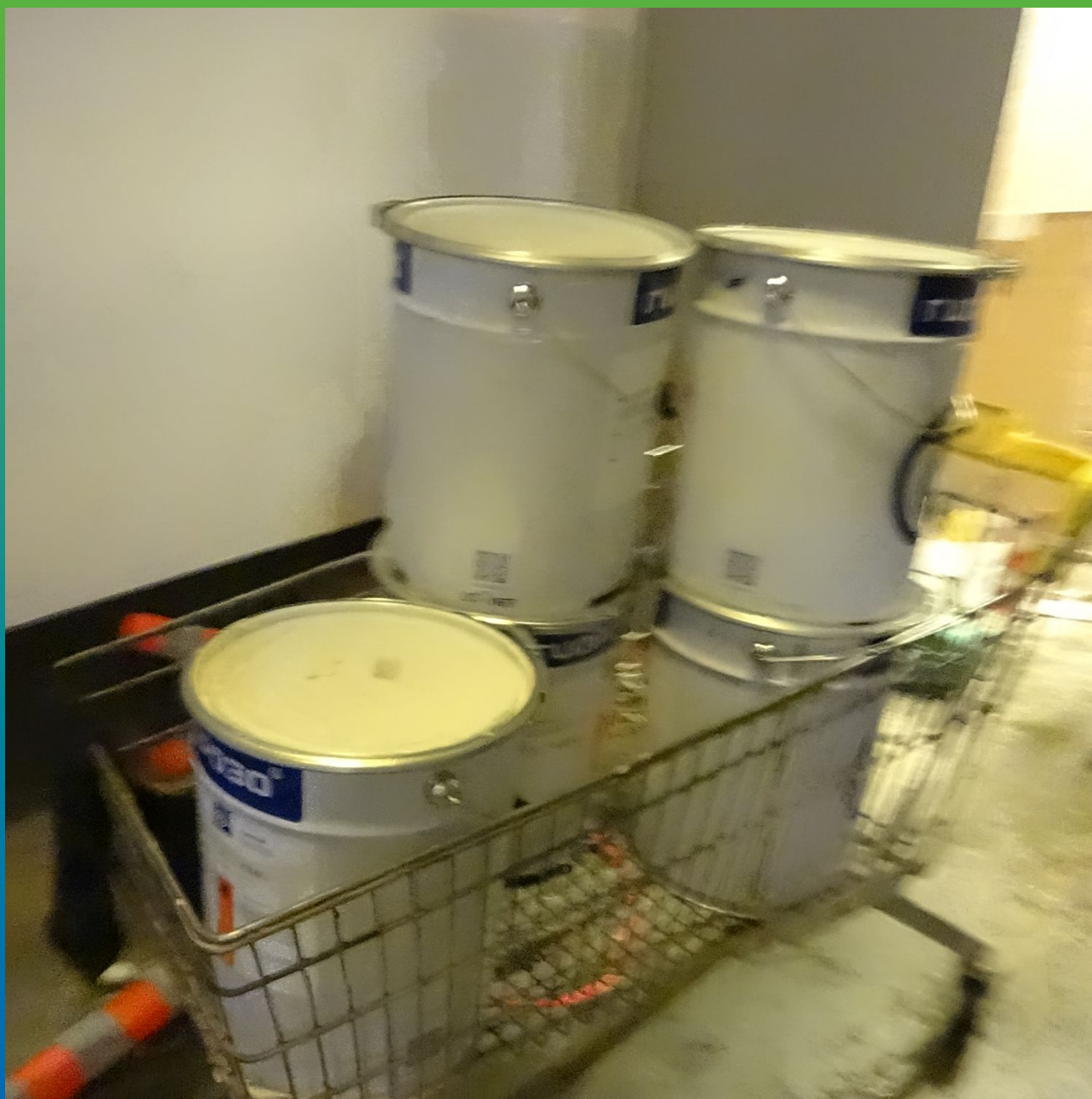
Материалы "Гидрозо" на объекте
