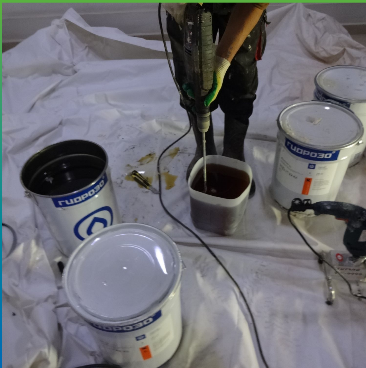
Перемешивание компонентов низкоскоростной мешалкой
