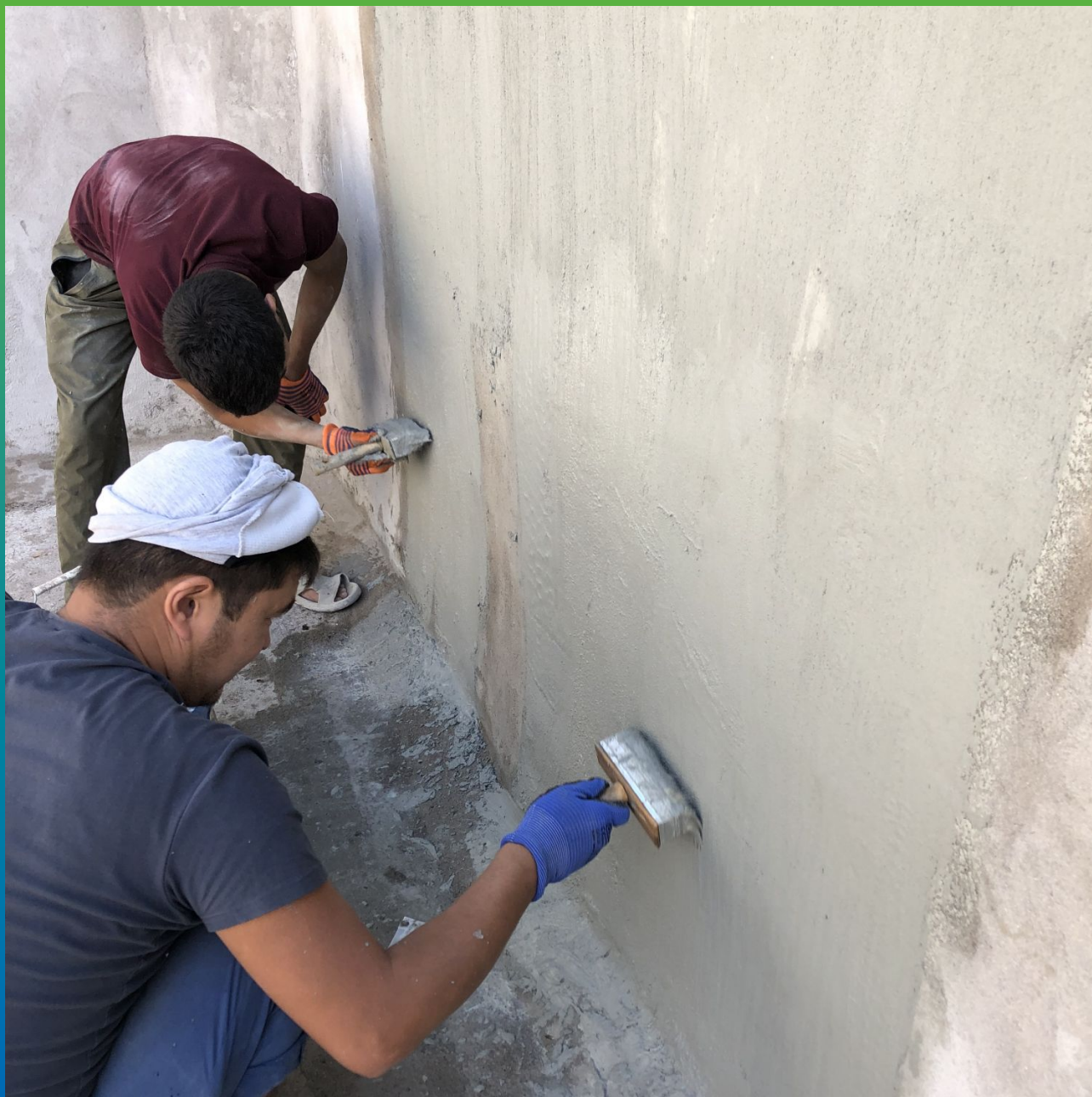
Нанесение материала общий вид
