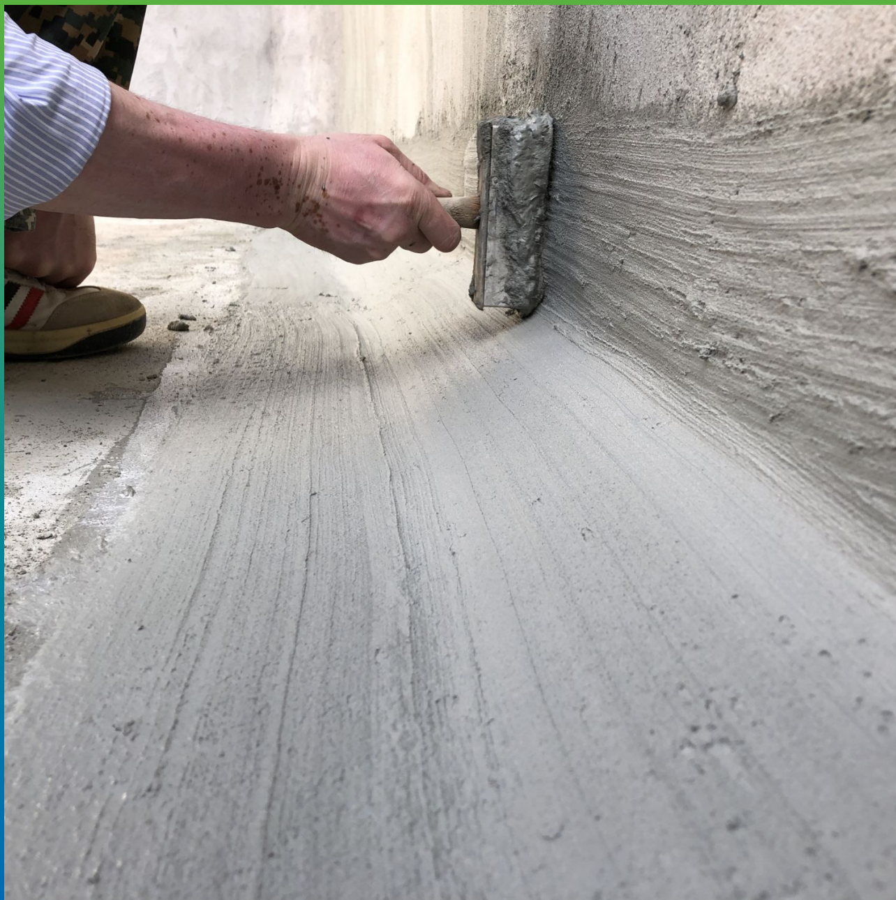
Нанесение эластичной гидроизоляции Стармекс Сил Флекс по шву стена-пол
