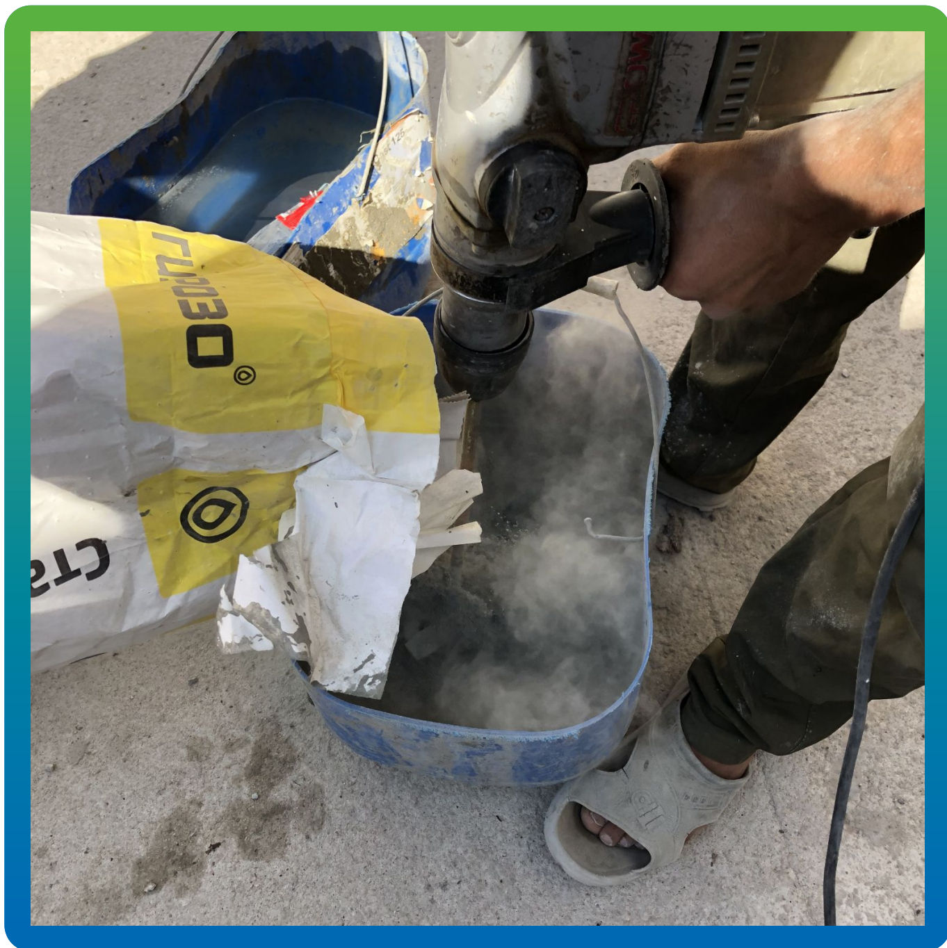
Замешивание материала с водой
