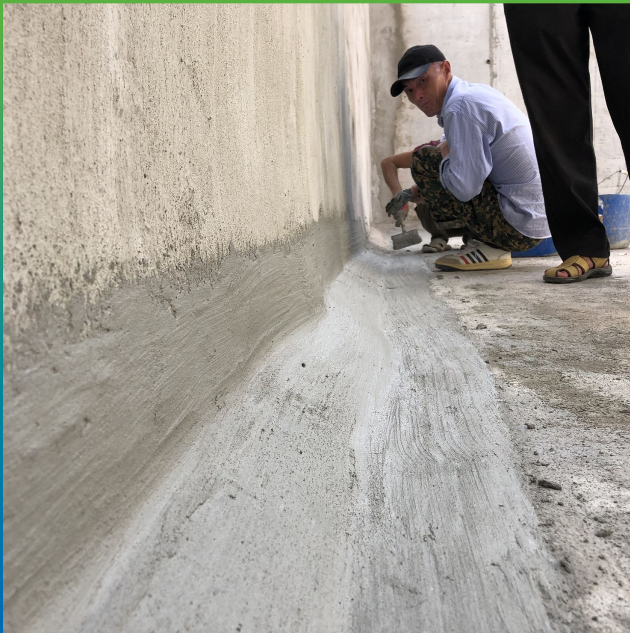
Нанесение эластичной гидроизоляции Стармекс Сил Флекс
