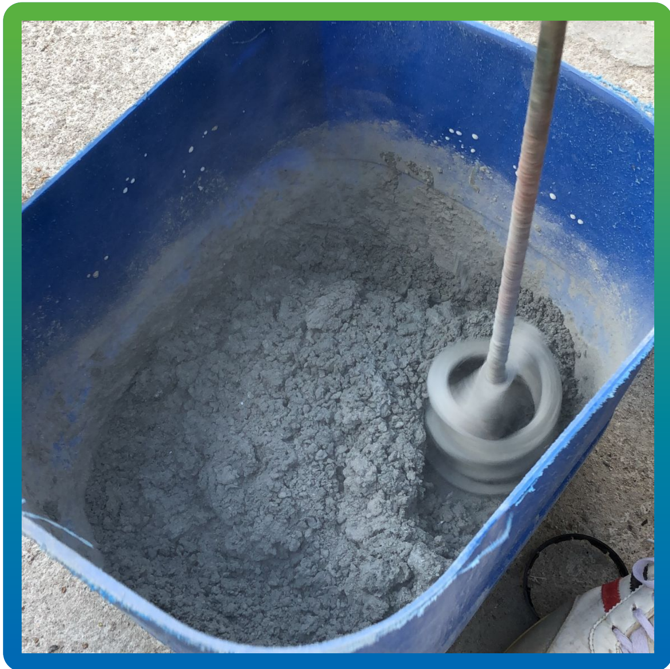
Замешивание Стармекс Сил Флекс Компоненты А и Б
