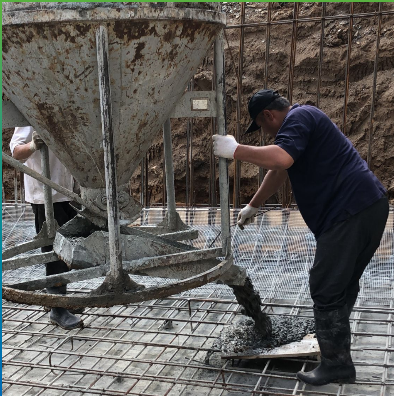
Приём первой партии бетона на площадку через щит
