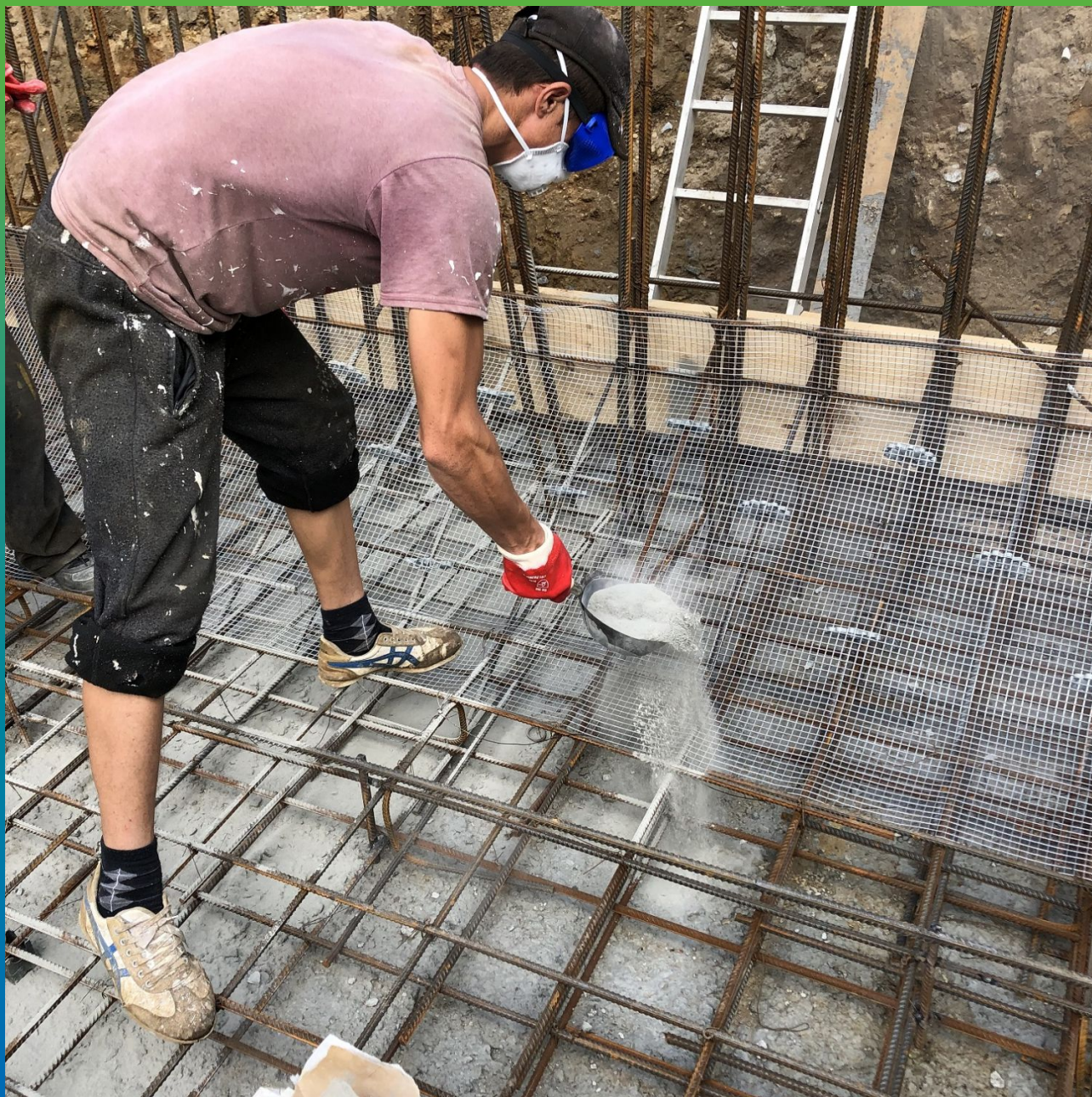
Нанесение сухой смеси на подбетонку
