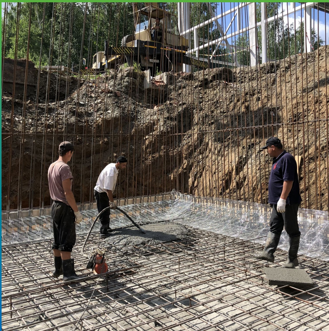
Вибрирование бетона
