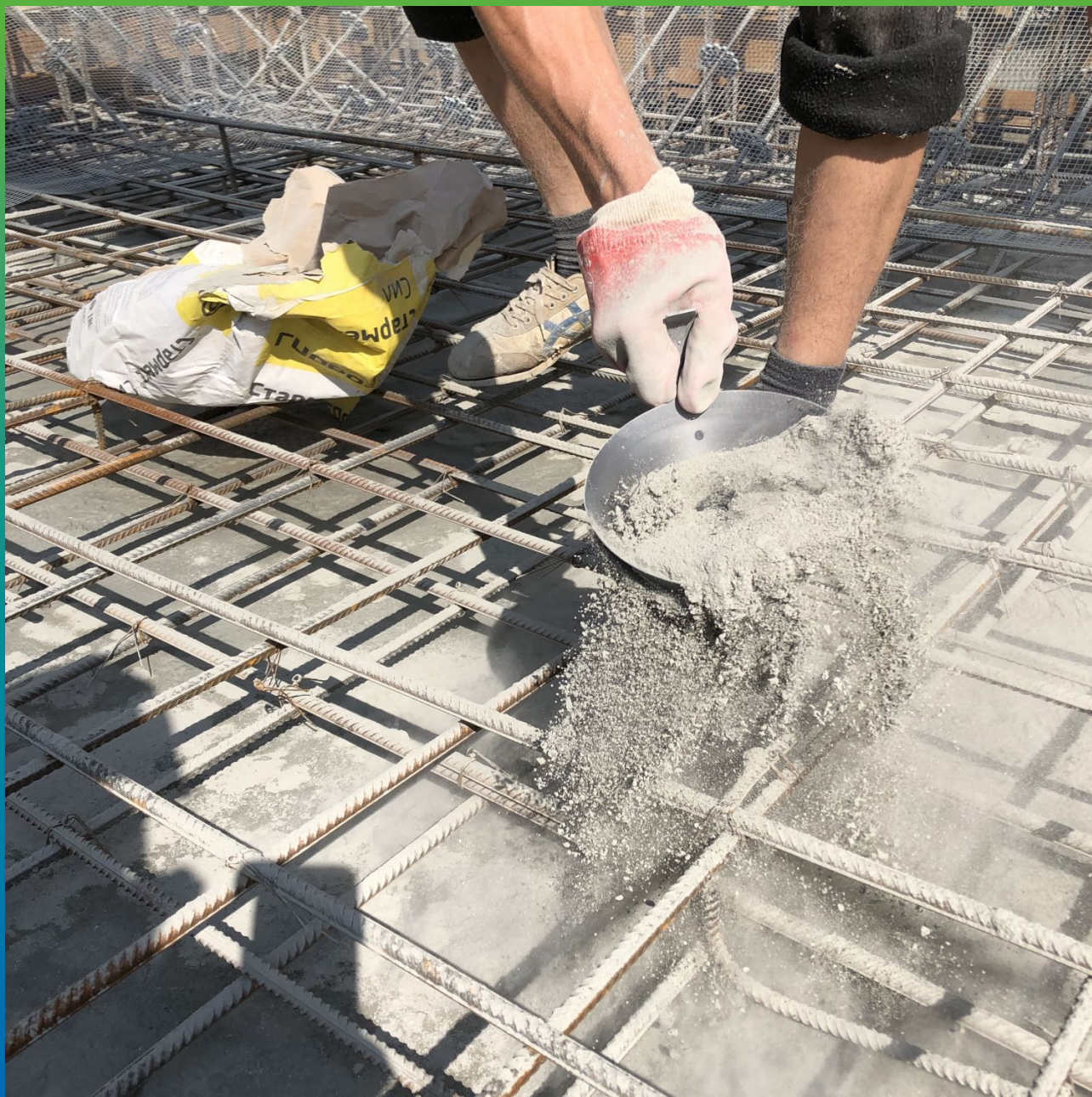
Нанесение сухой смеси на подбетонку
