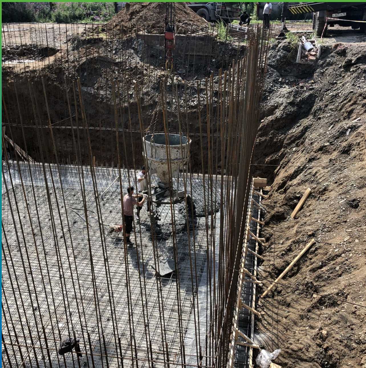
Приём последующих порций бетона без щита
