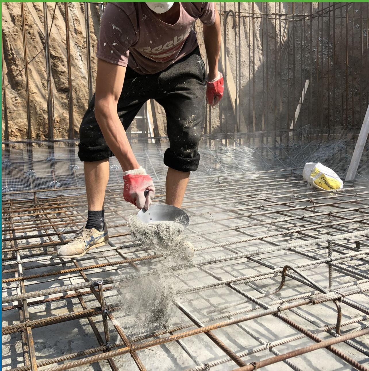
Нанесение сухой смеси на подбетонку
