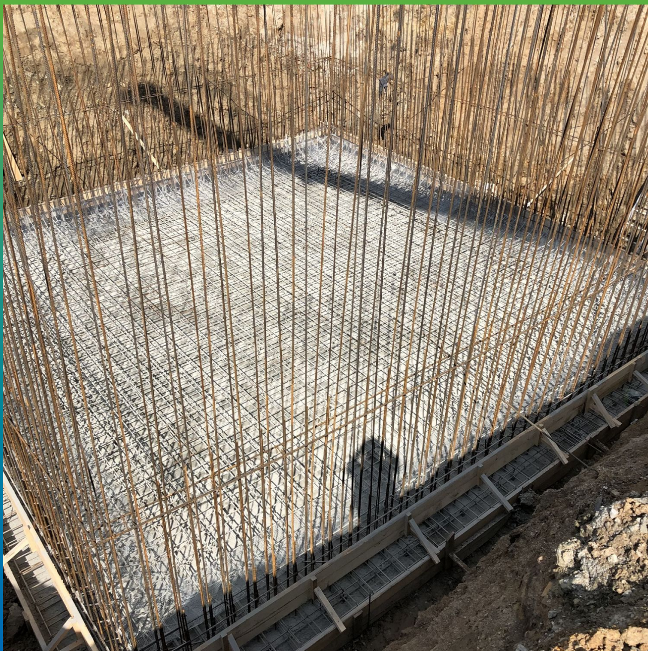
Общий вид площадки с нанесенным материалом
