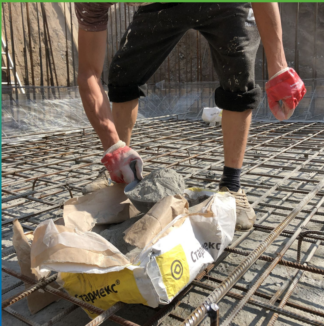
Нанесение сухой смеси на подбетонку
