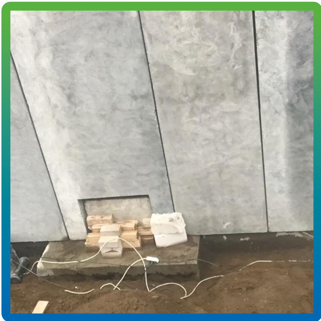
Готовое основание для проведения работ по гидроизоляции.
