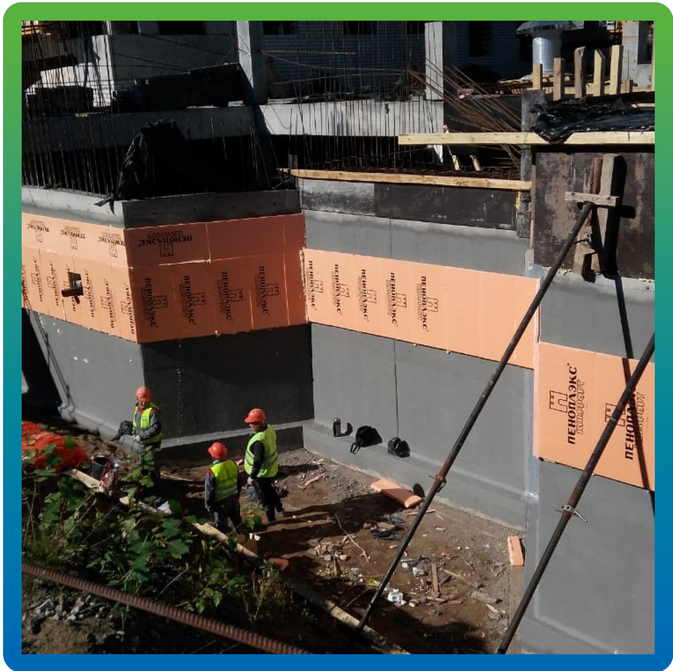
Монтаж утеплителя на гидроизоляционный состав.
