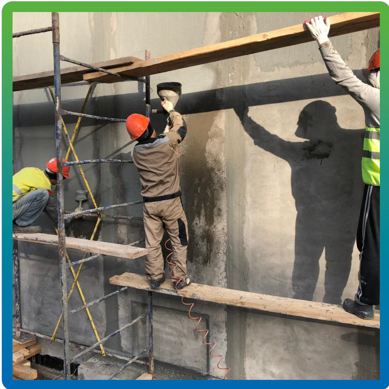
Нанесение гидроизоляционного покрытия Стармекс Сил.
