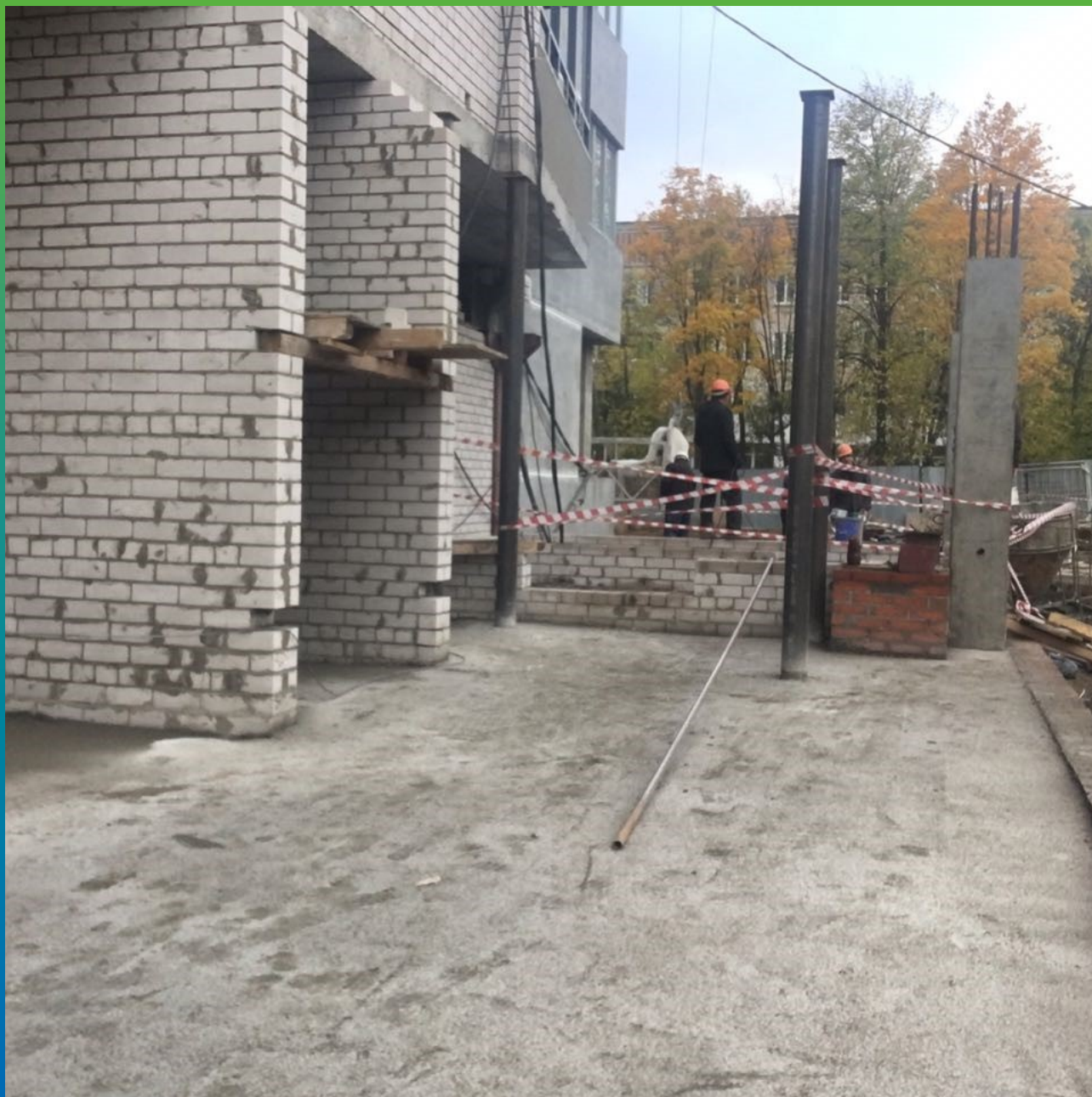
Подготовленное основание для укладки мембраны
