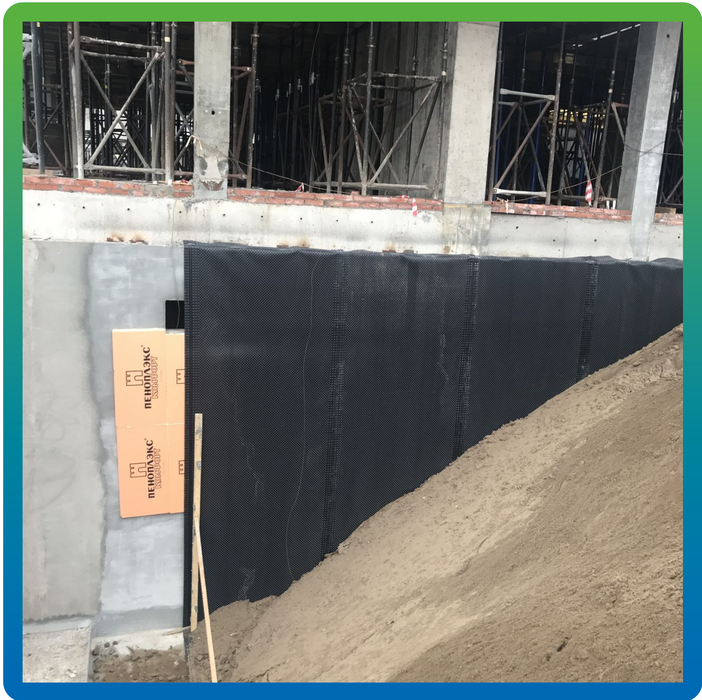
Готовый участок стен паркинга с обратной засыпкой.
