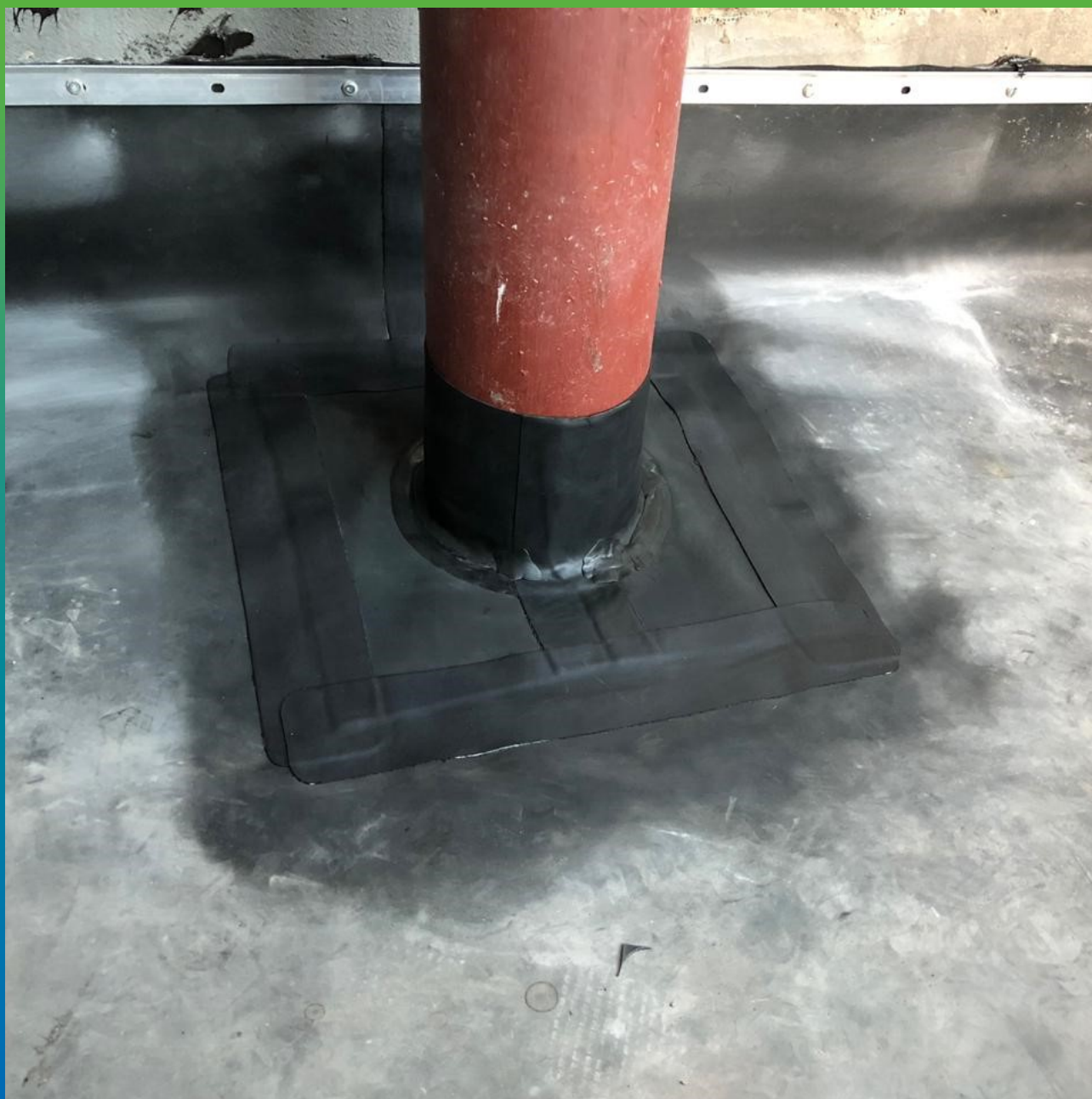
Монтаж элементов обвода к основному полотну мембраны
