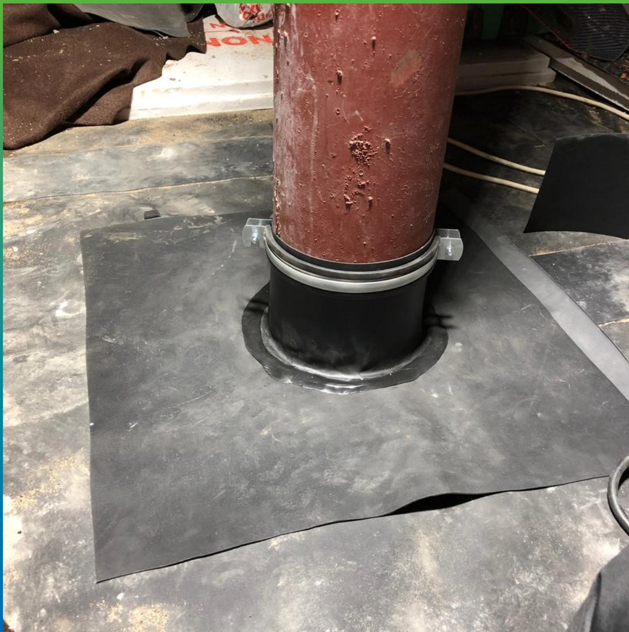
Обвод труб на гидроизолируемой поверхности
