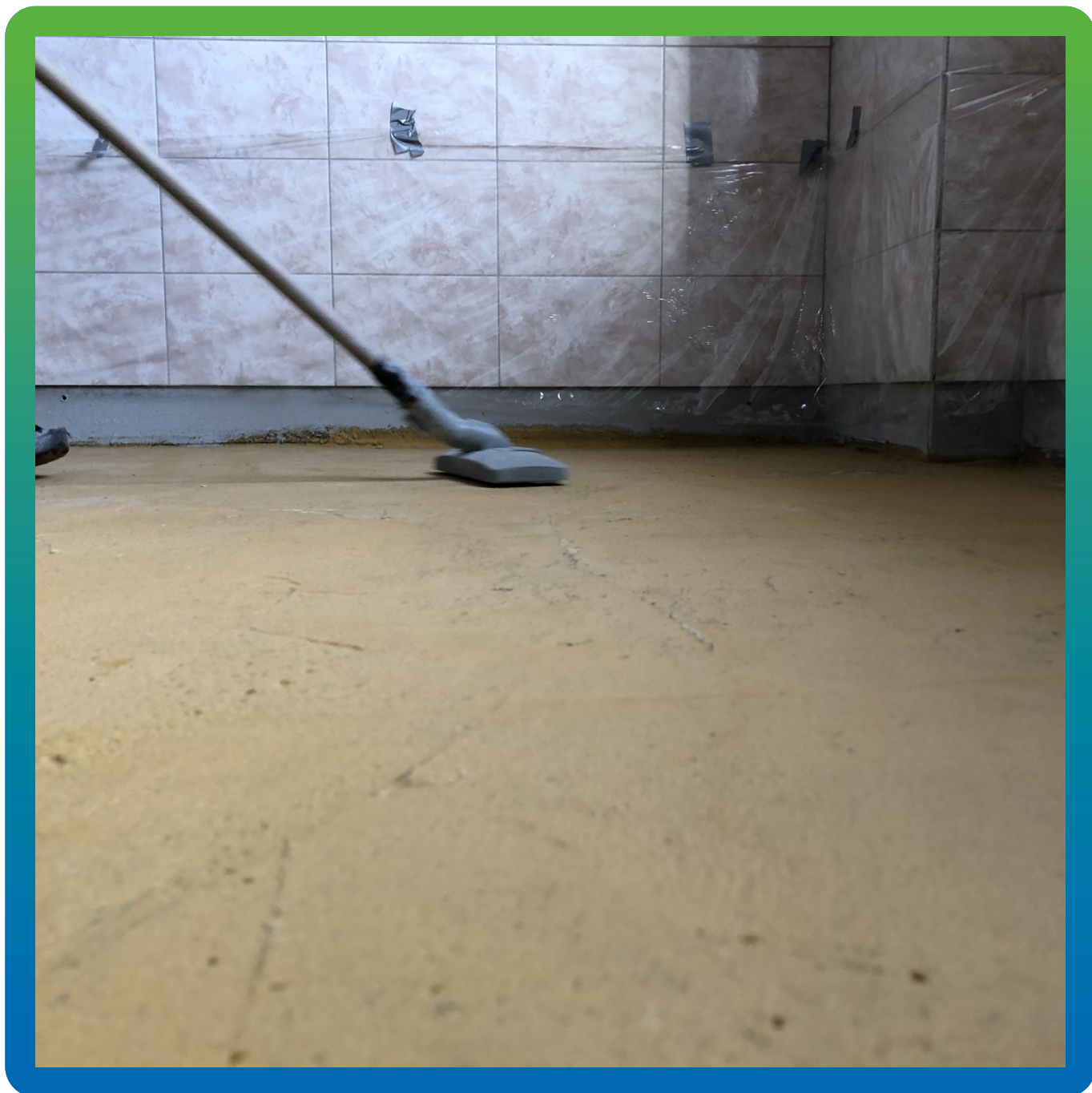
Обеспыливание загрунтованного основания после устранения недочетов
