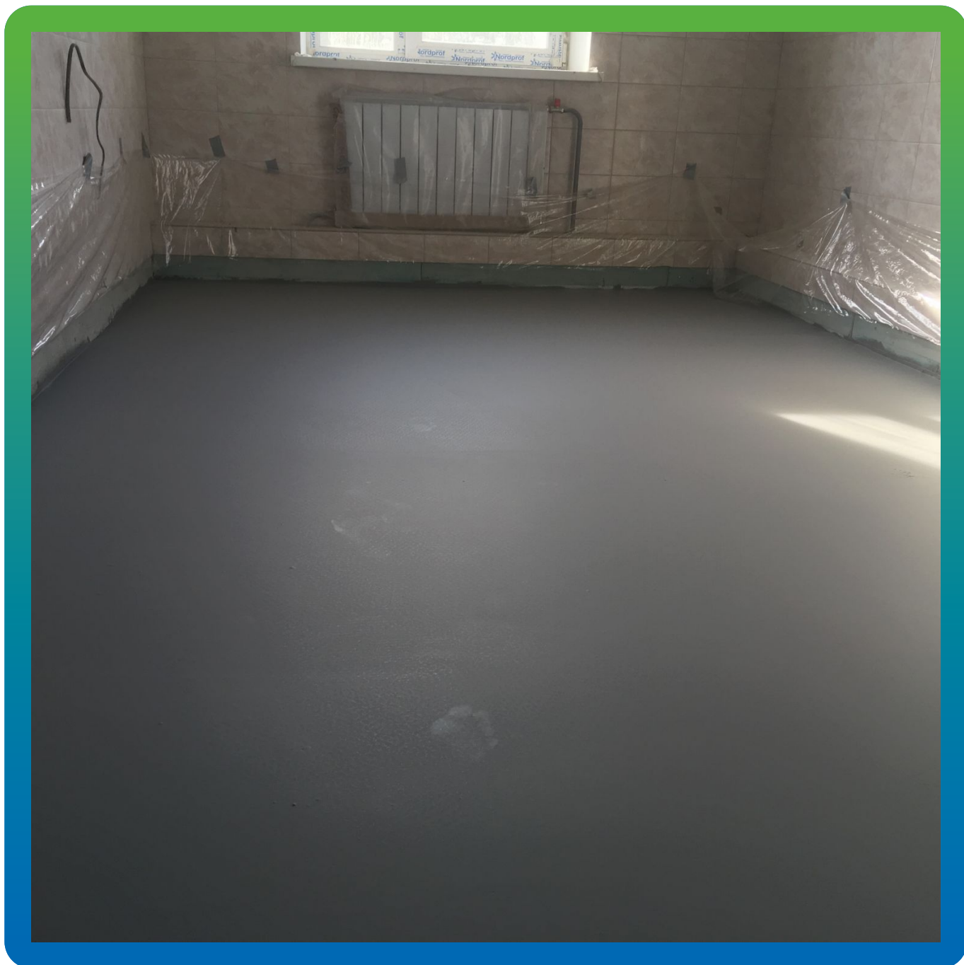
Финальный вид готового покрытия - ДенТоп ПМ 605 Флоу
