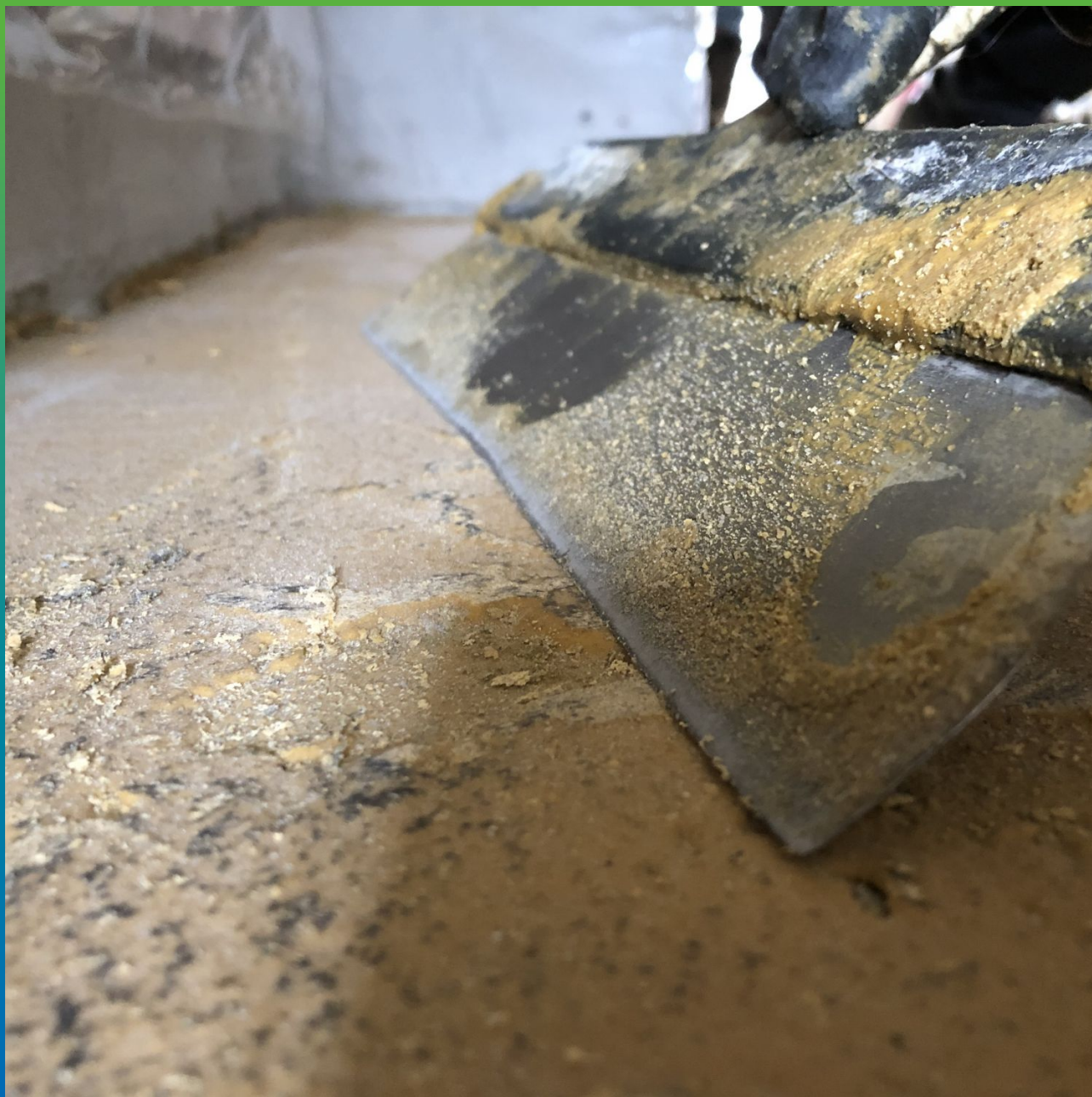
Ликвидация неровностей/дефектов по грунту
