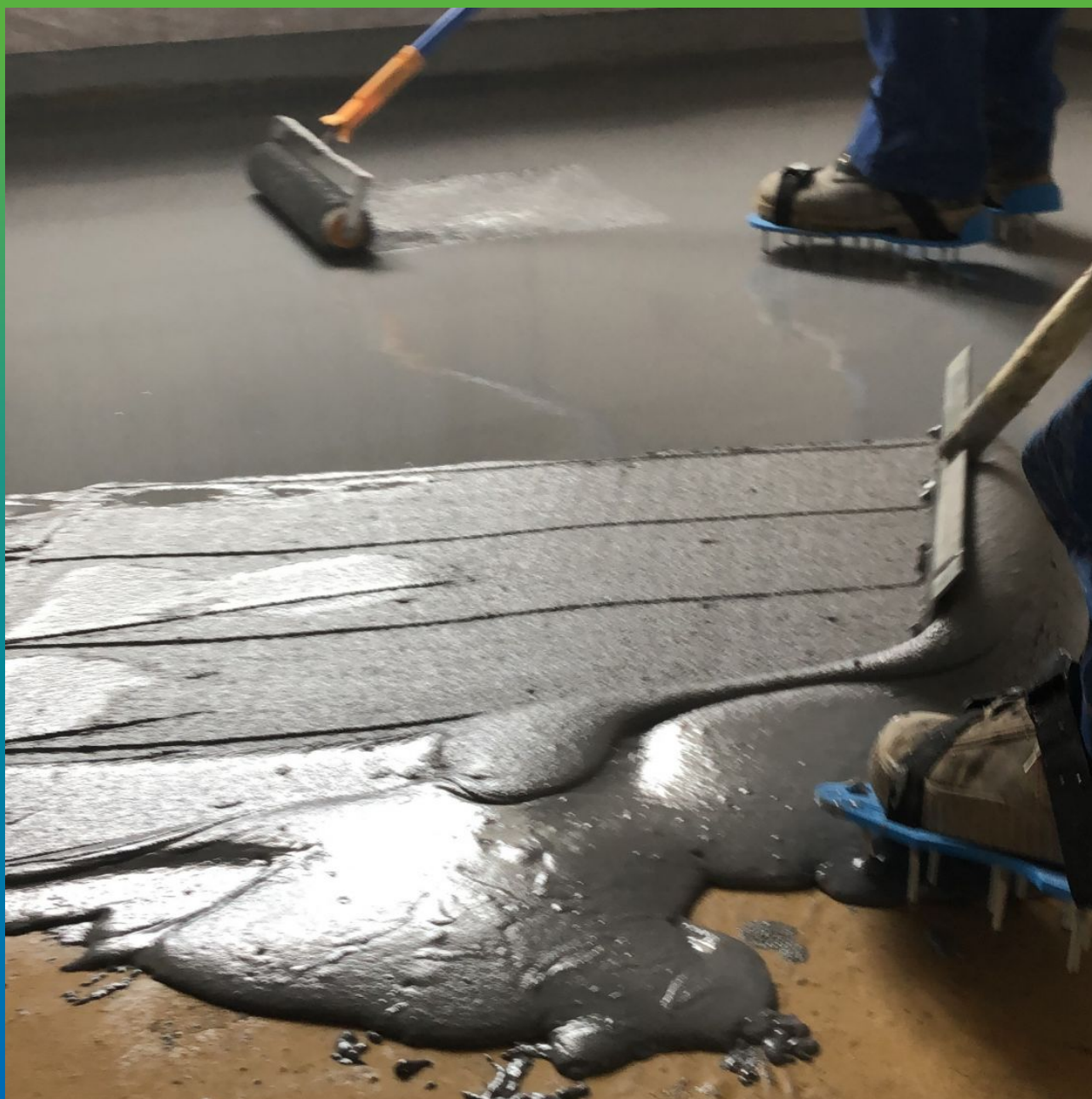
Нанесение основного слоя - ДенСтол ПМ 605 Флоу
