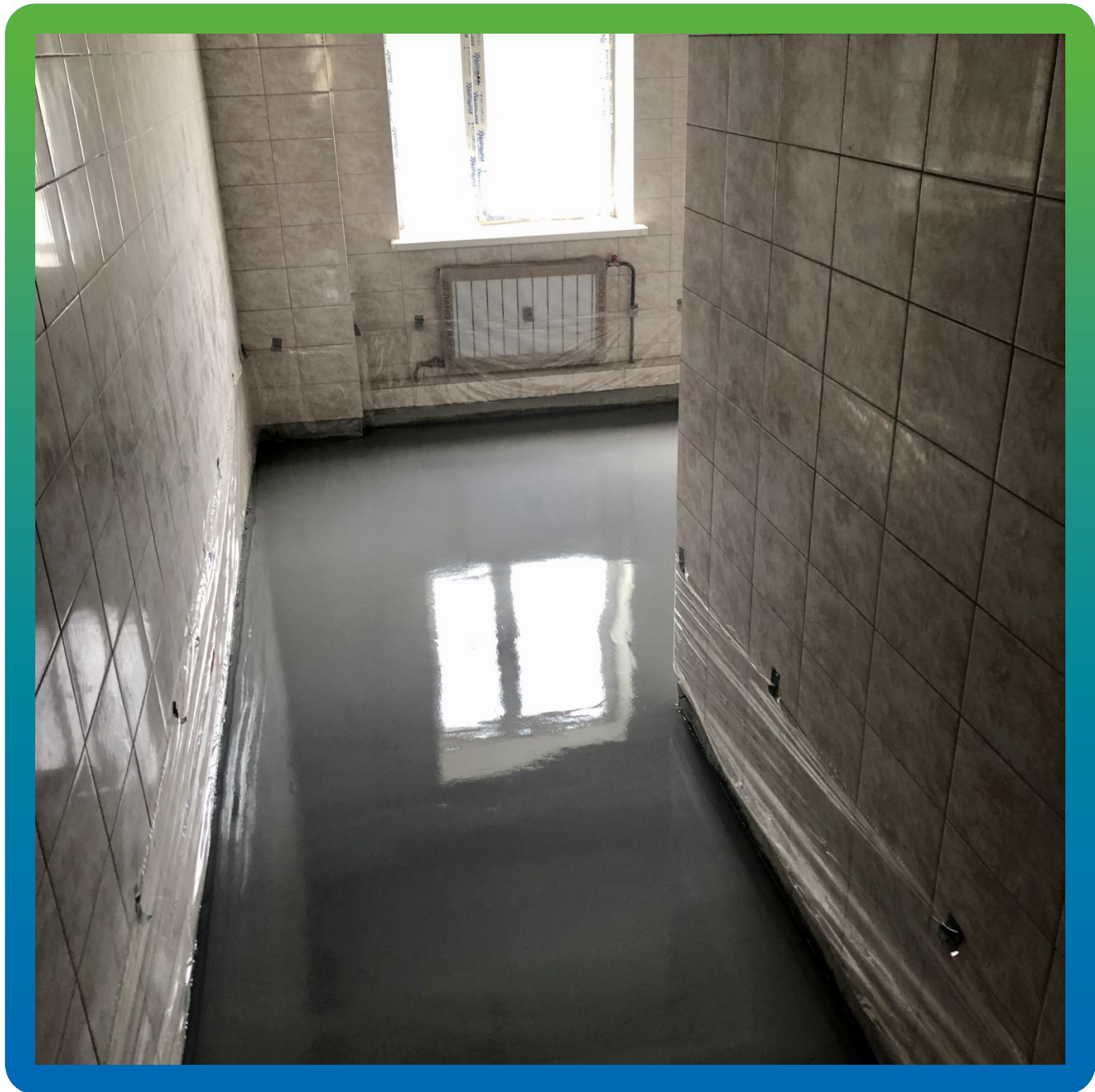
Вид свежеложенного покрытия ДенТоп ПМ 605 Флоу
