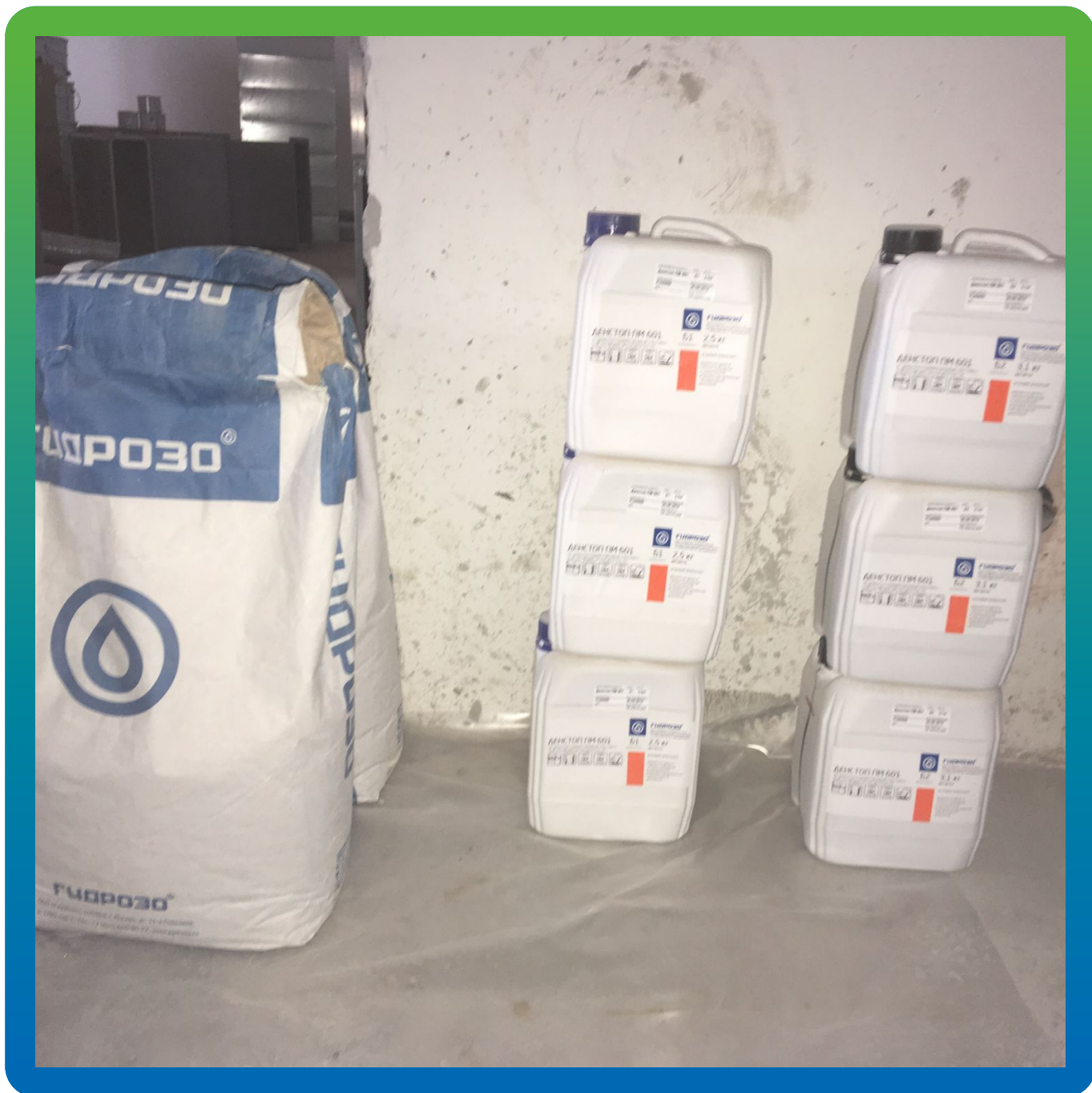
Вид материалов Гидрозо на объекте
