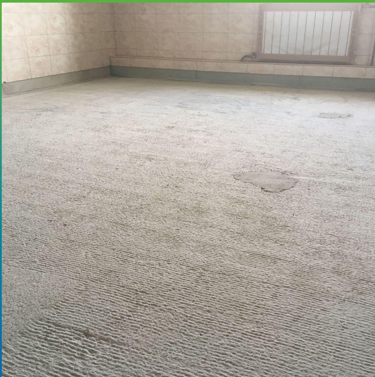
Вид подготовленной поверхности (фрезерование)
