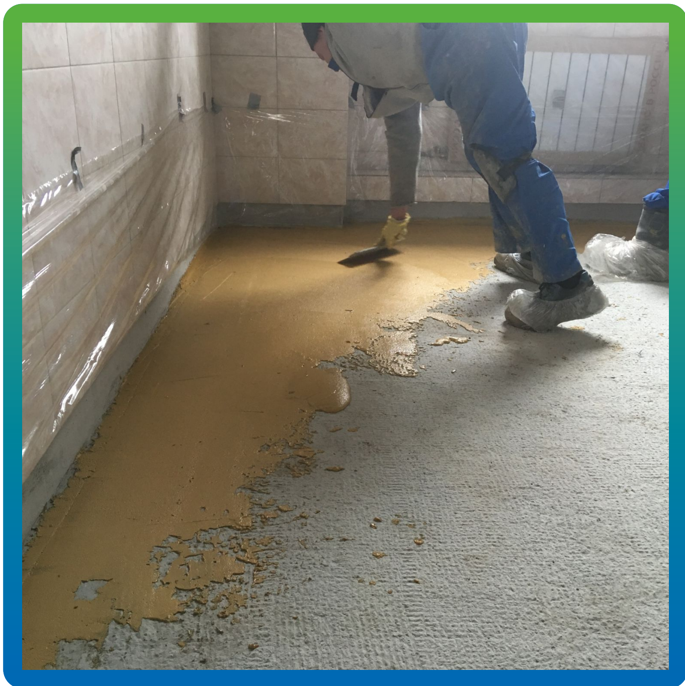
Нанесение грунтовочного состава ДенсТоп ПМ 601
