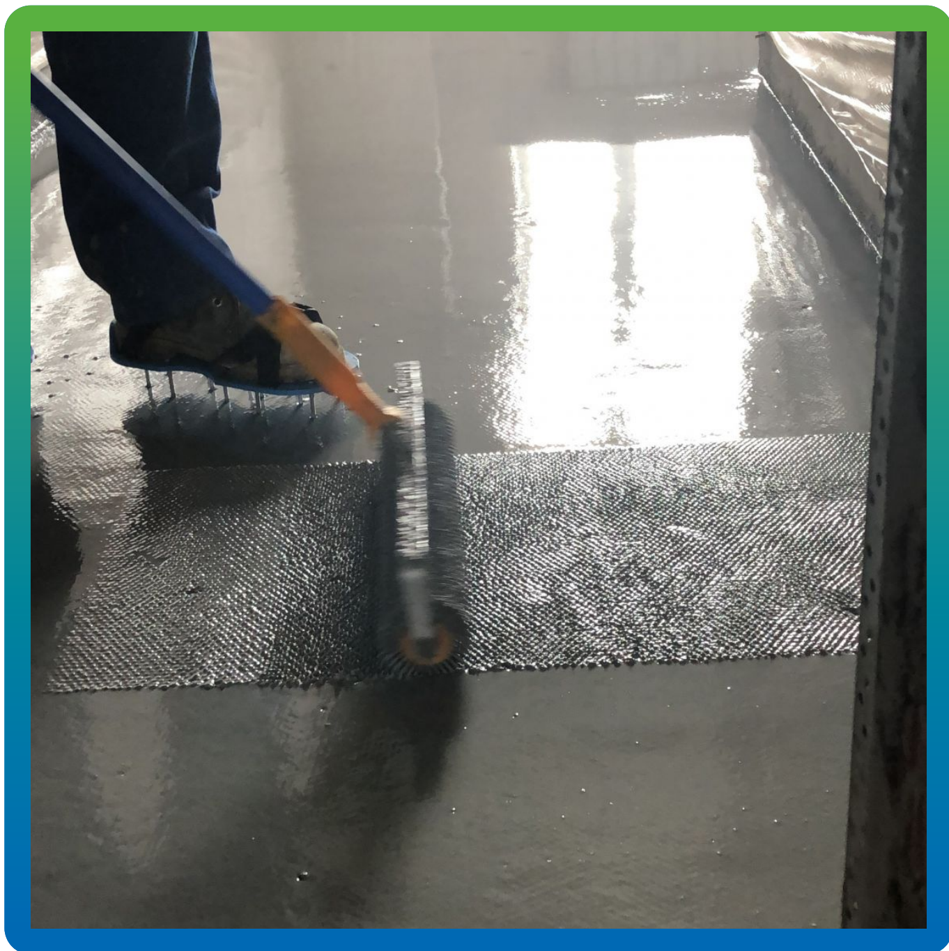
Удаление излишков воздуха из покрытия с помощью игольчатого валика
