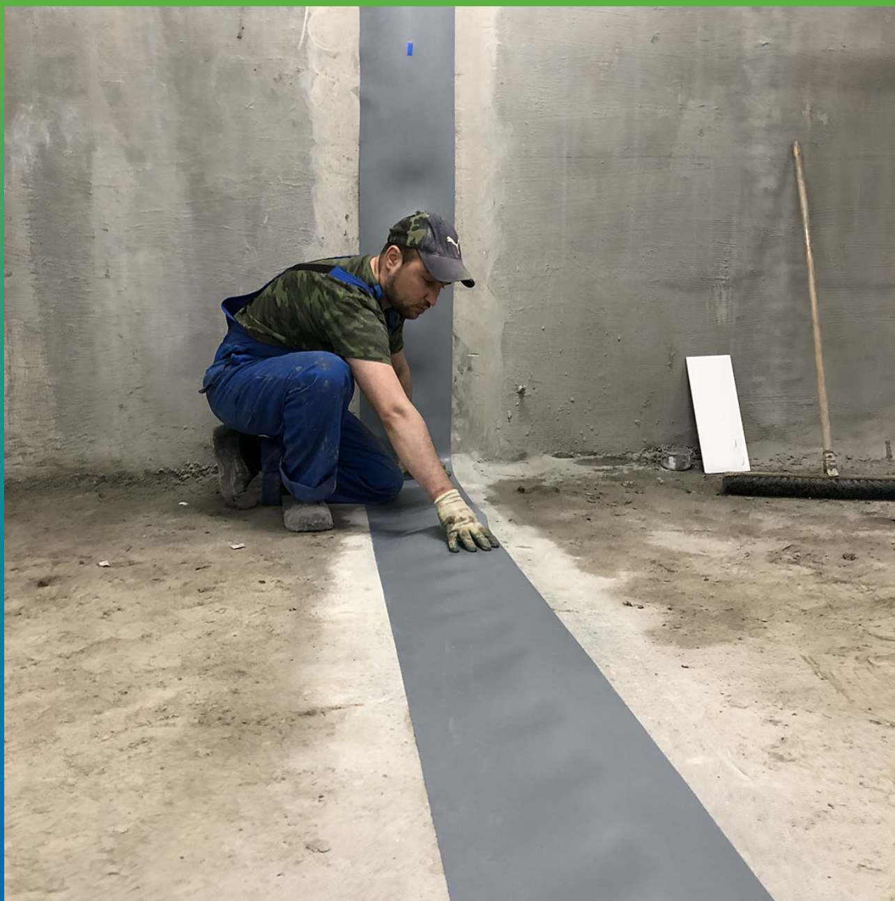
Монтаж системы Манопрокс 331/ Манодил Про
