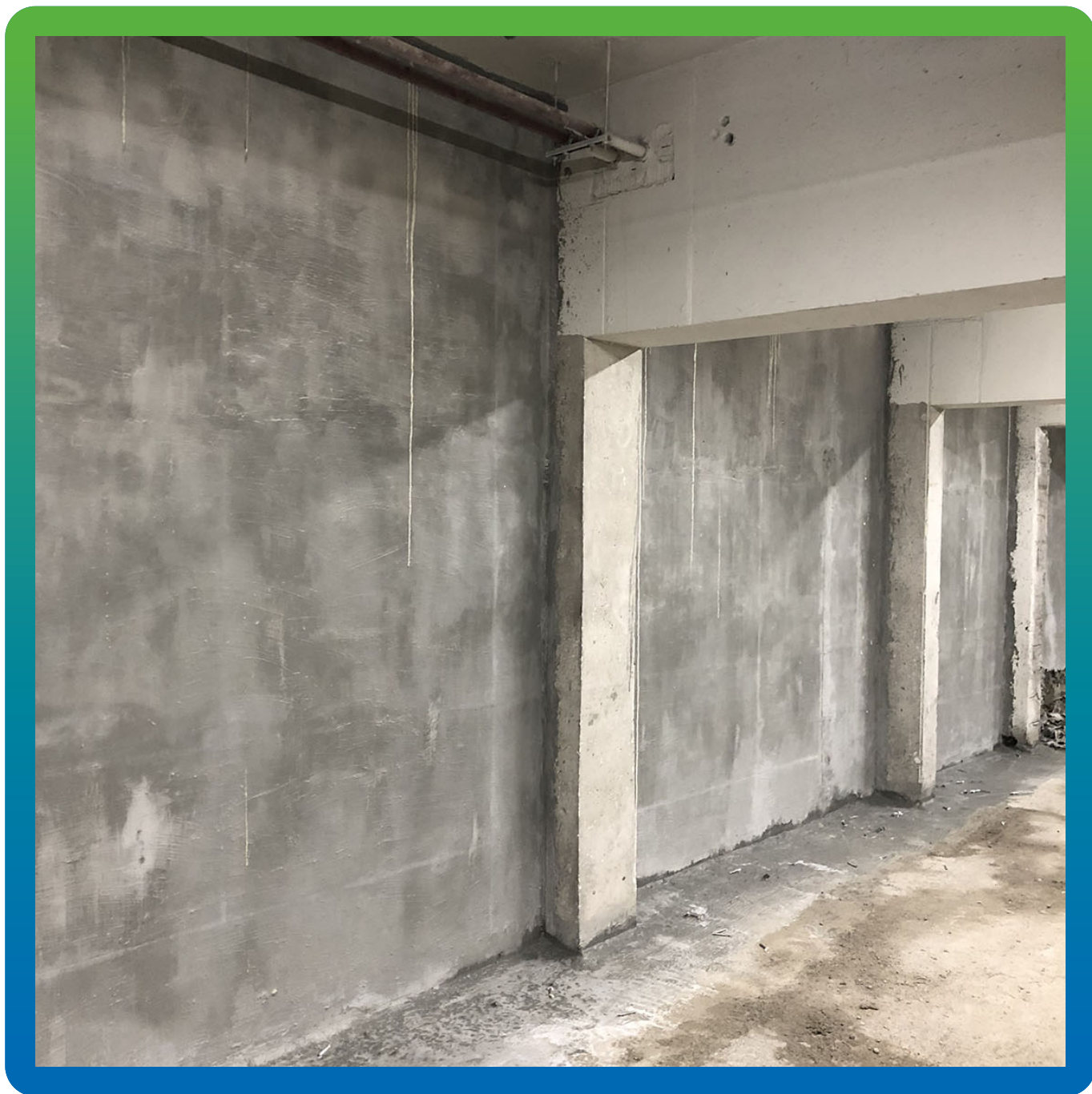
Площадная гидроизоляция стен
