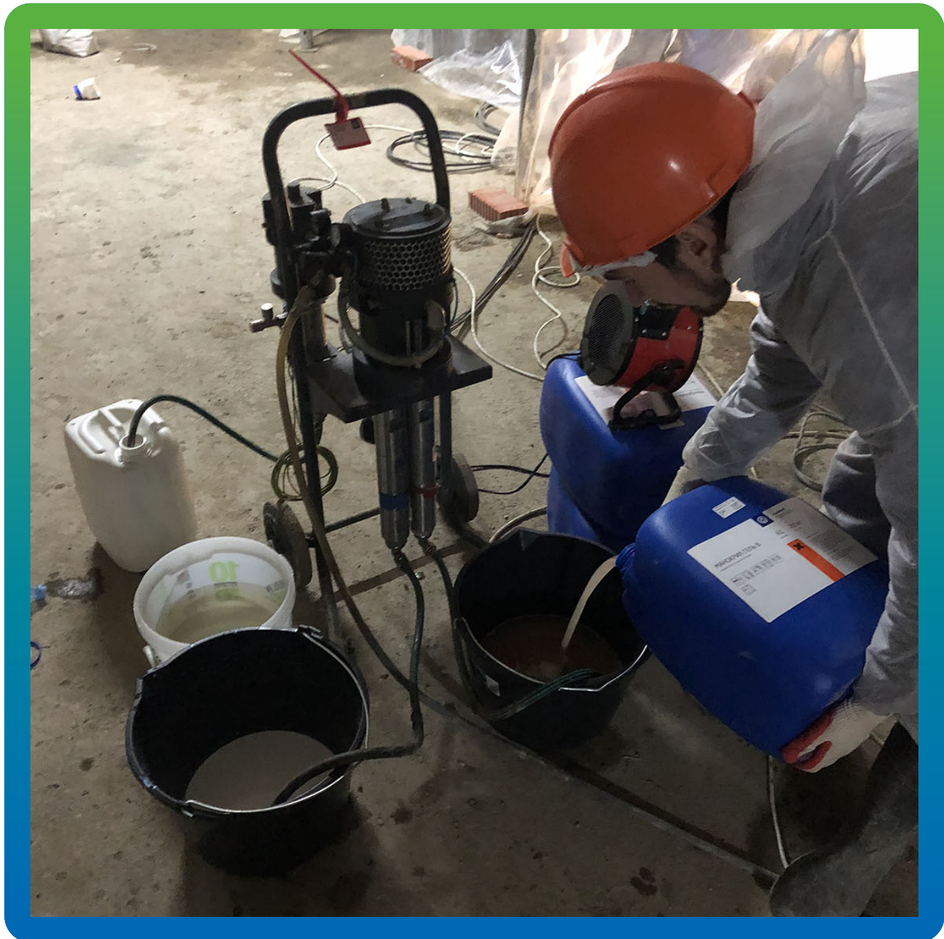
Подготовка материалов для инъектирования деформационного шва
