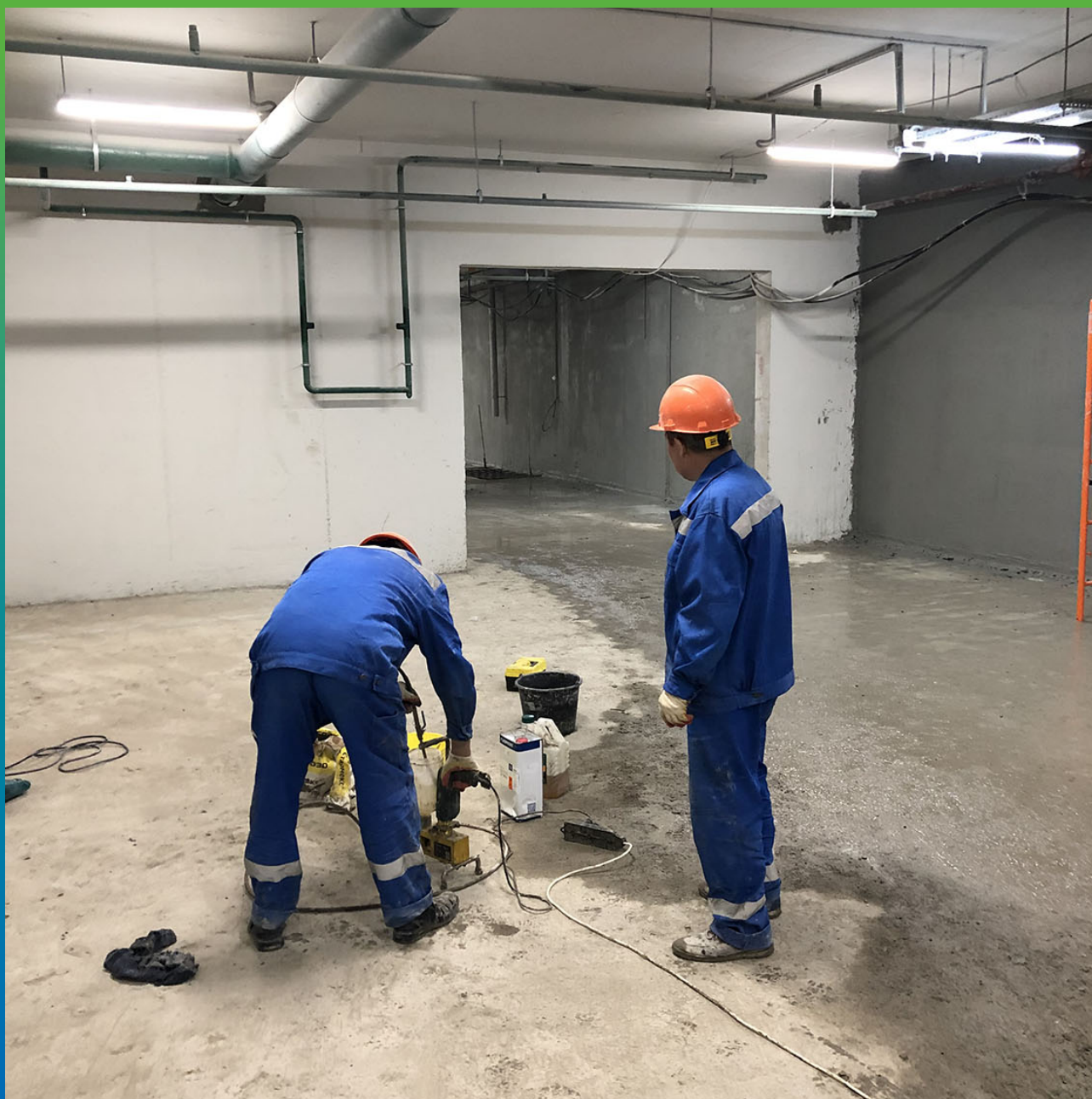
Гидроизоляция технических отверстий
