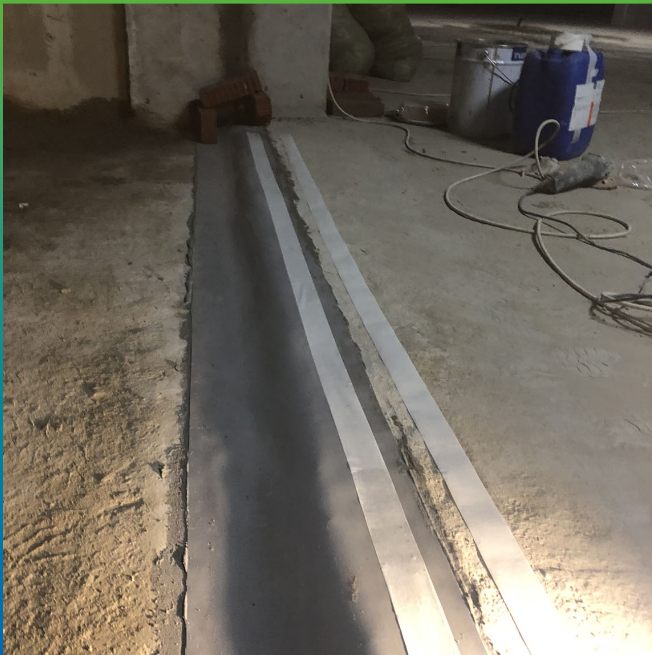
Монтаж пакеров в деформационный шов после инъецирования
