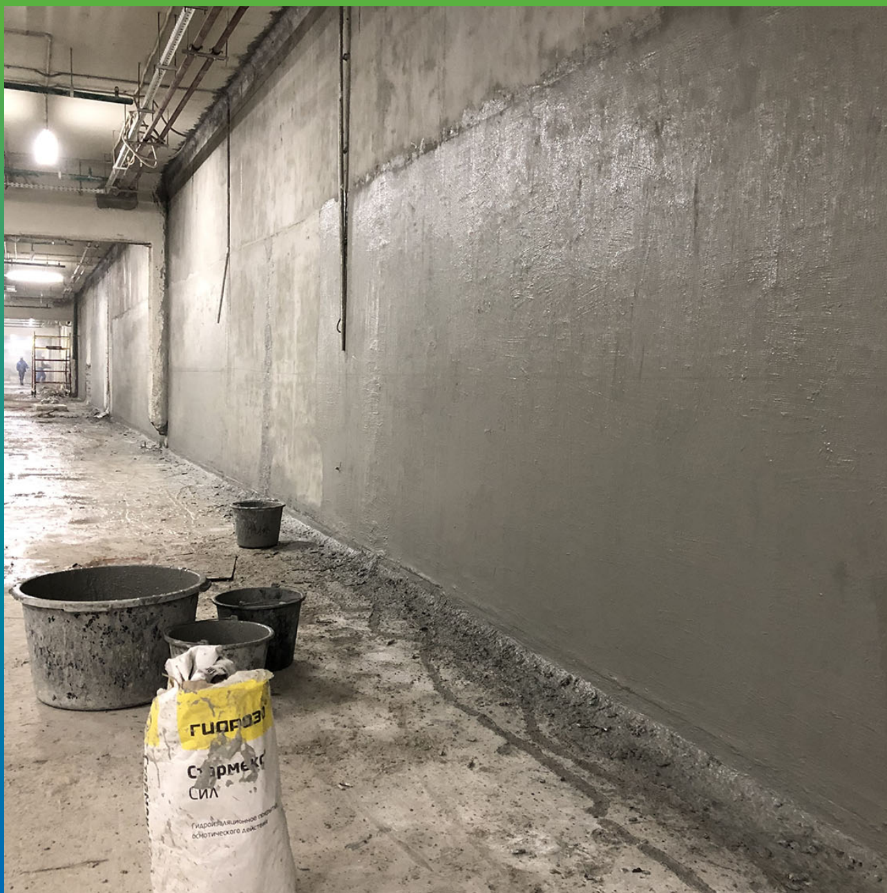
Площадная гидроизоляция стен
