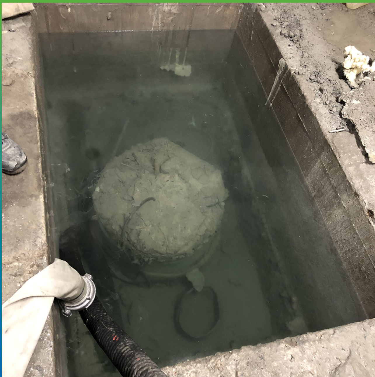
Объект до выполнения работ по гидроизоляции
