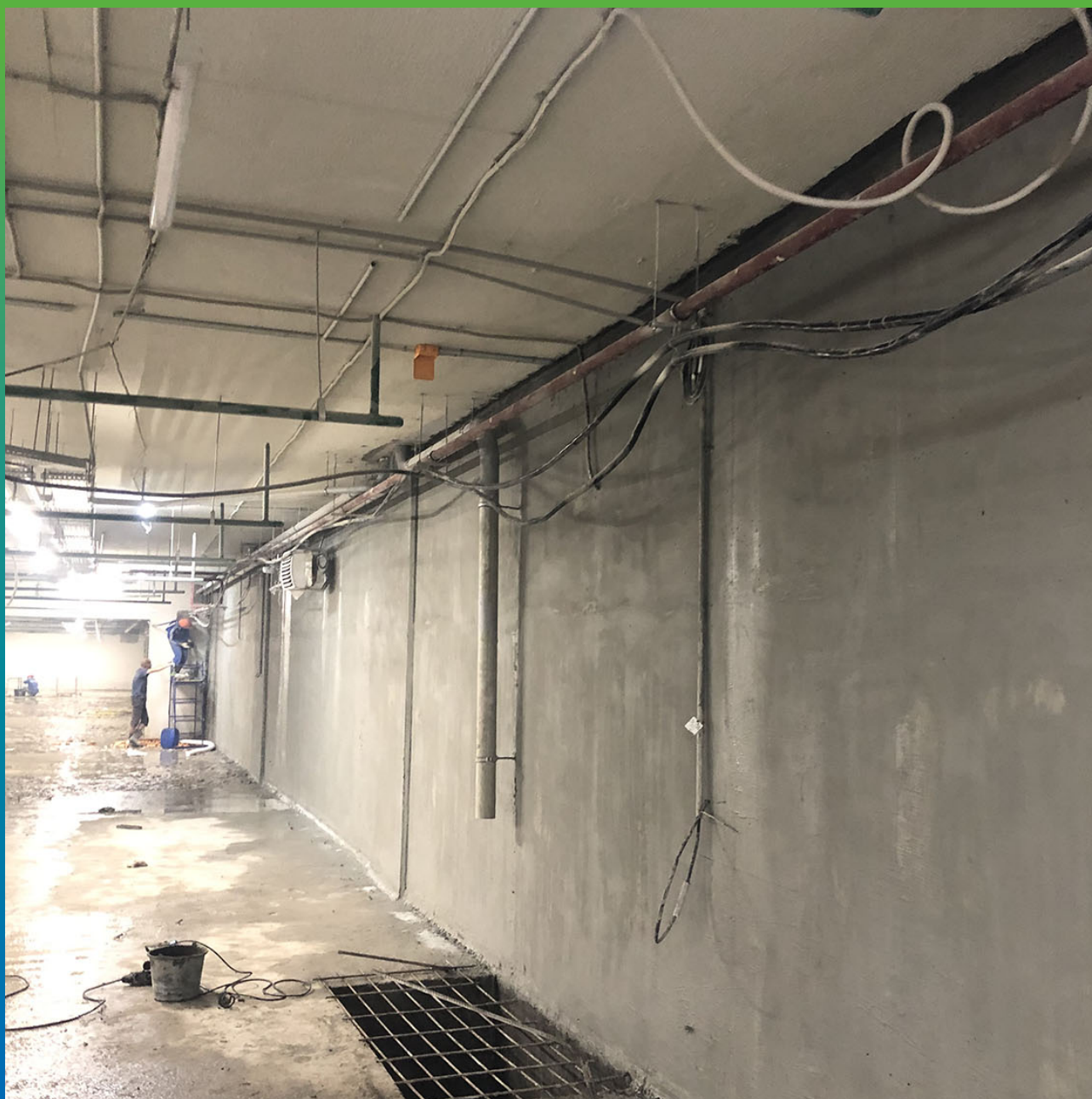
Площадная гидроизоляция стен
