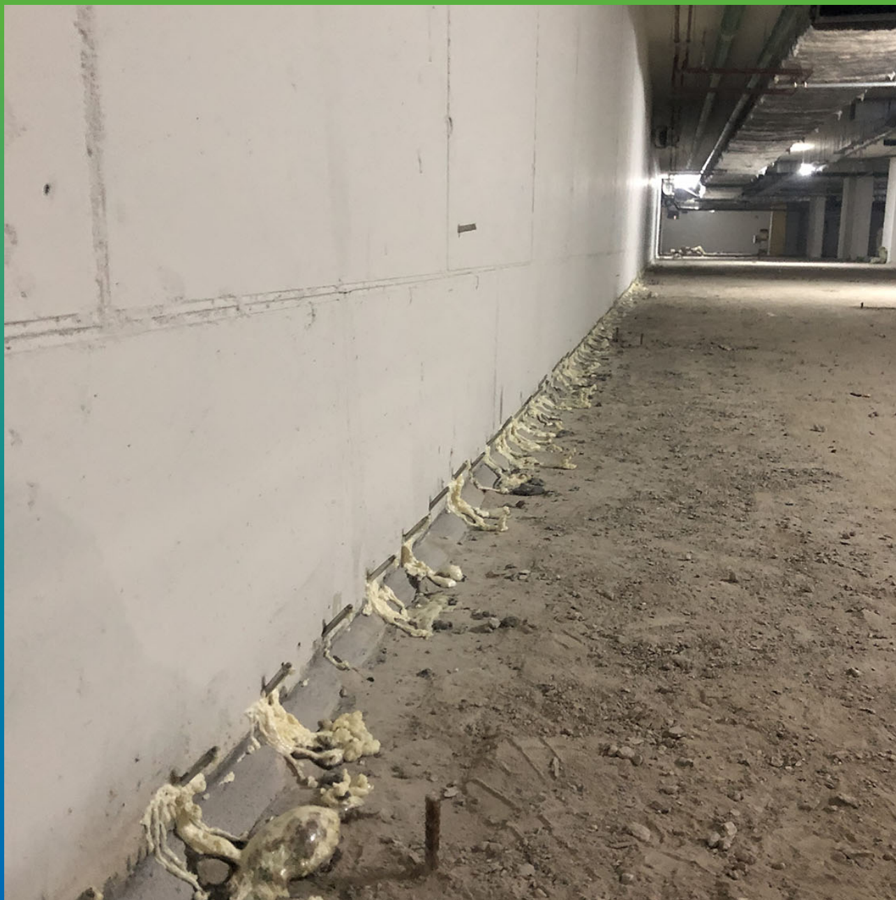
Инъектирование шва
