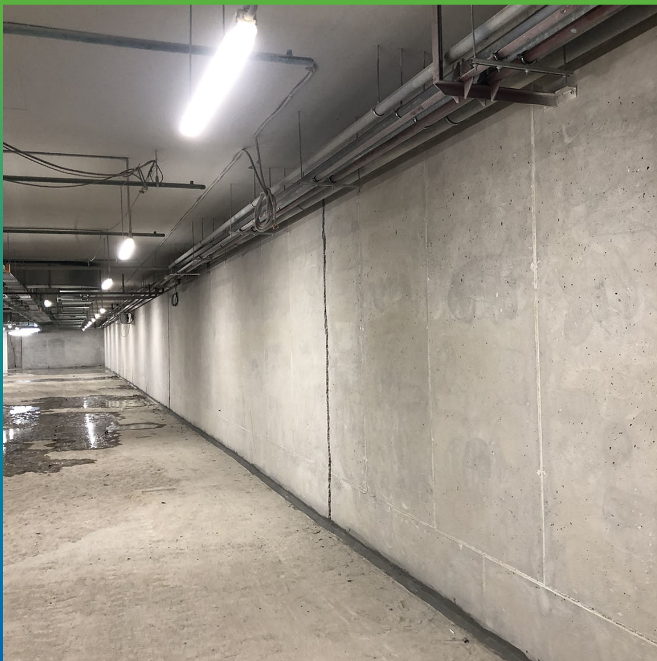
Выполненная гидроизоляция рабочего шва
