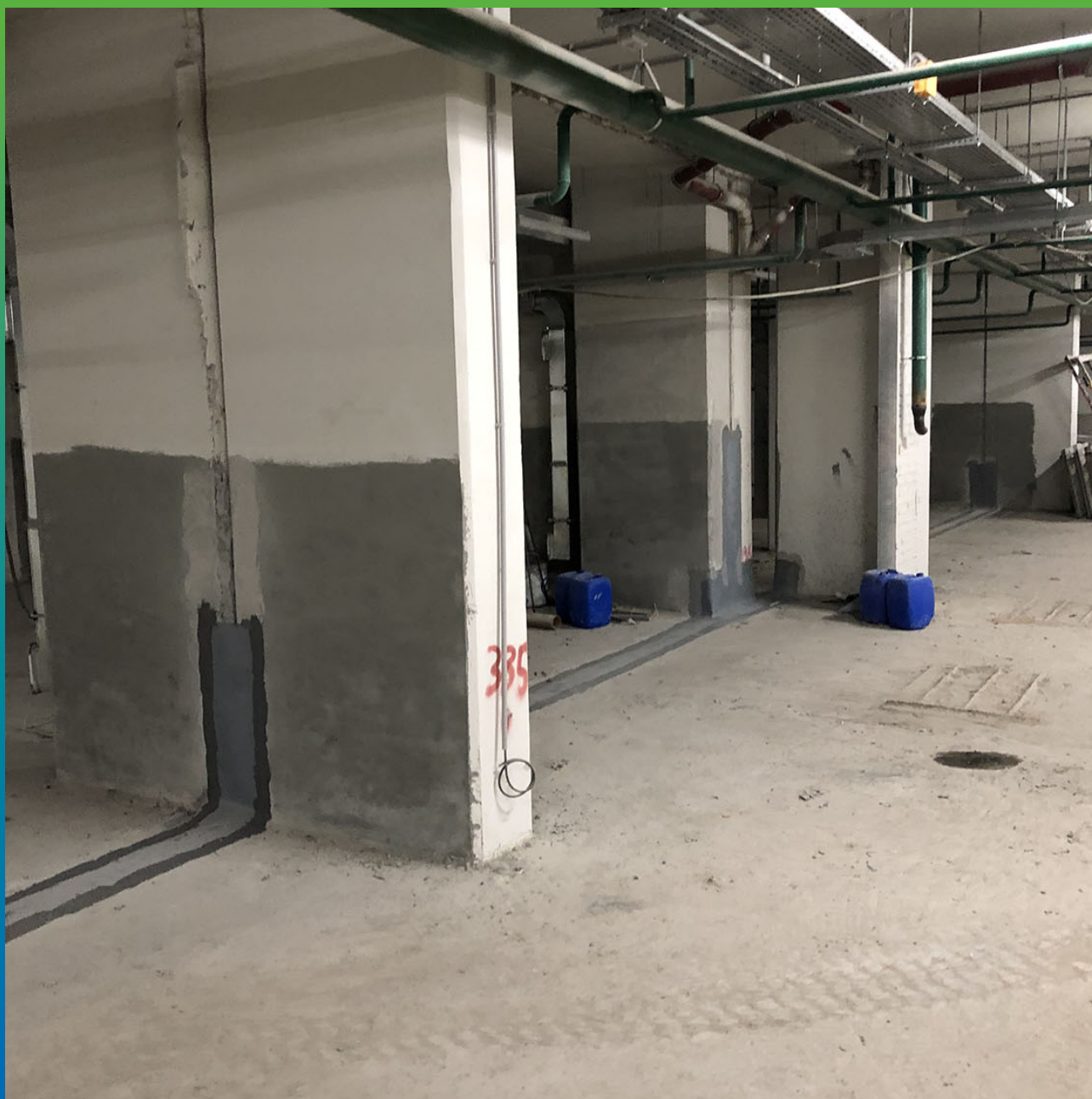
Монтаж системы Манопрокс 331/ Манодил Про
