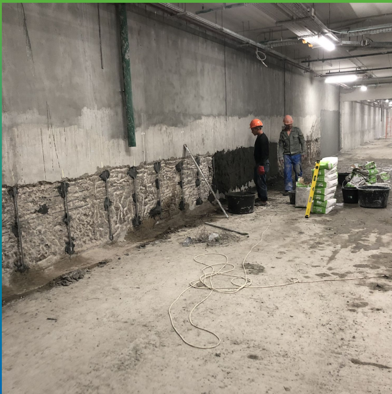
Подготовка поверхности под площадный ремонт бетона высокопрочным ремонтным составом Стармекс РМЗ
