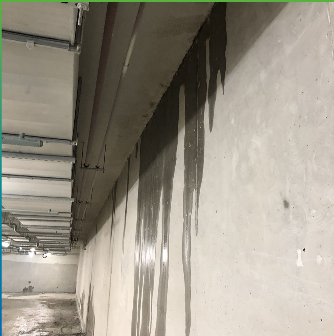
Объект до выполнения работ по гидроизоляции
