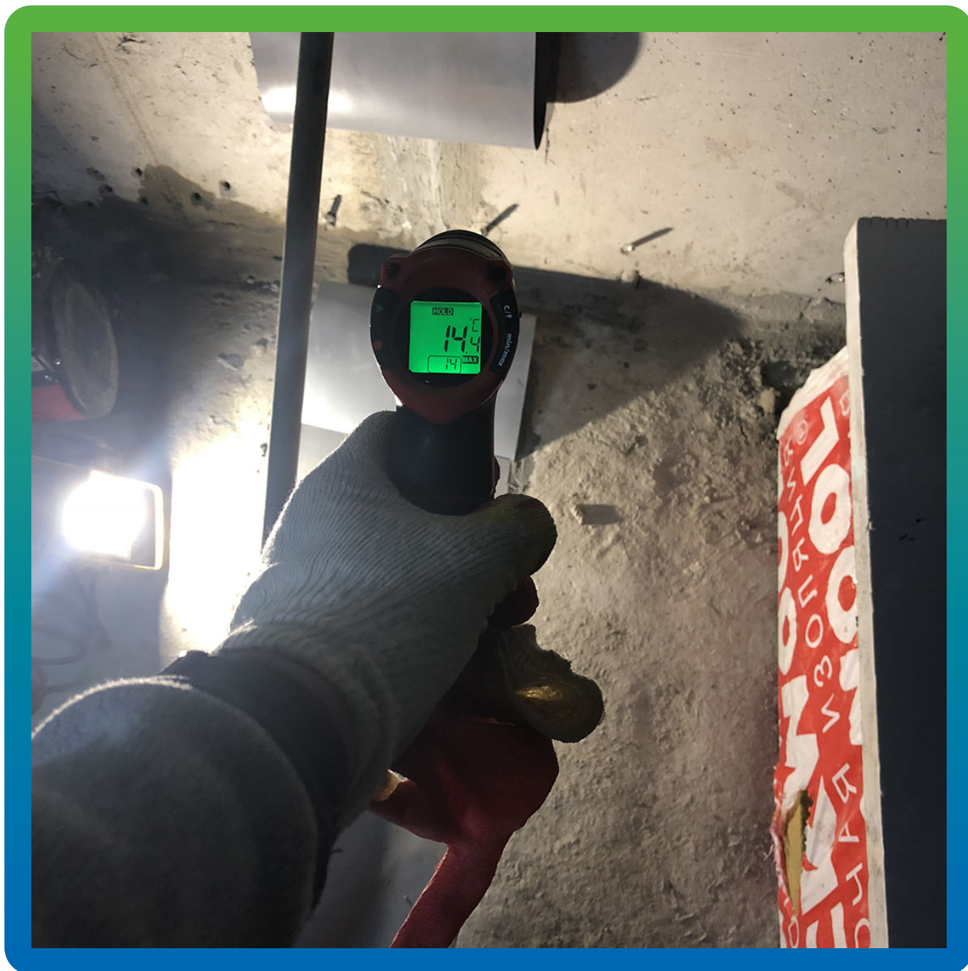
Монтаж системы Манопрокс 331/ Манодил Про
