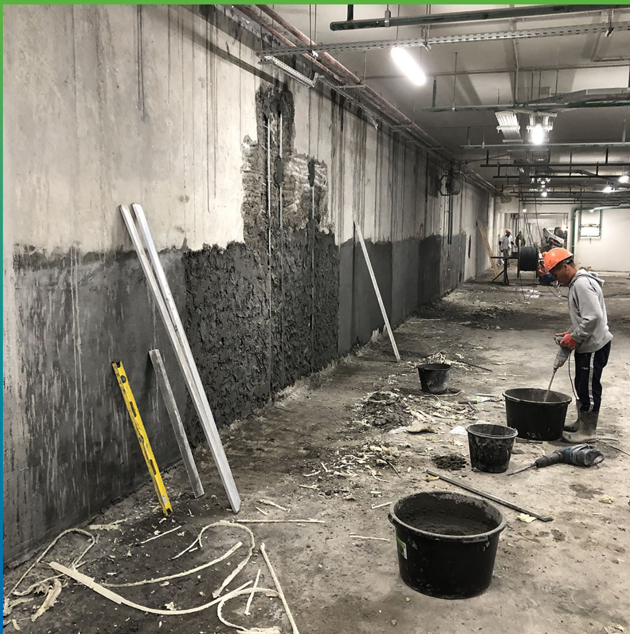
Ремонт бетона
