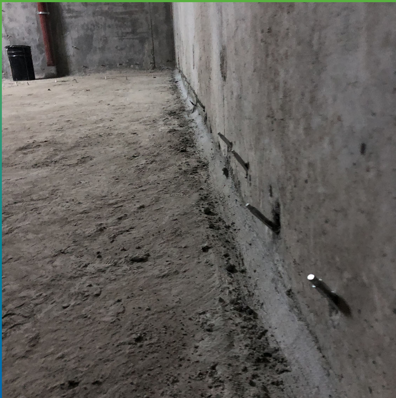
Монтаж пакеров для проведения двухстадийного инъецирования
