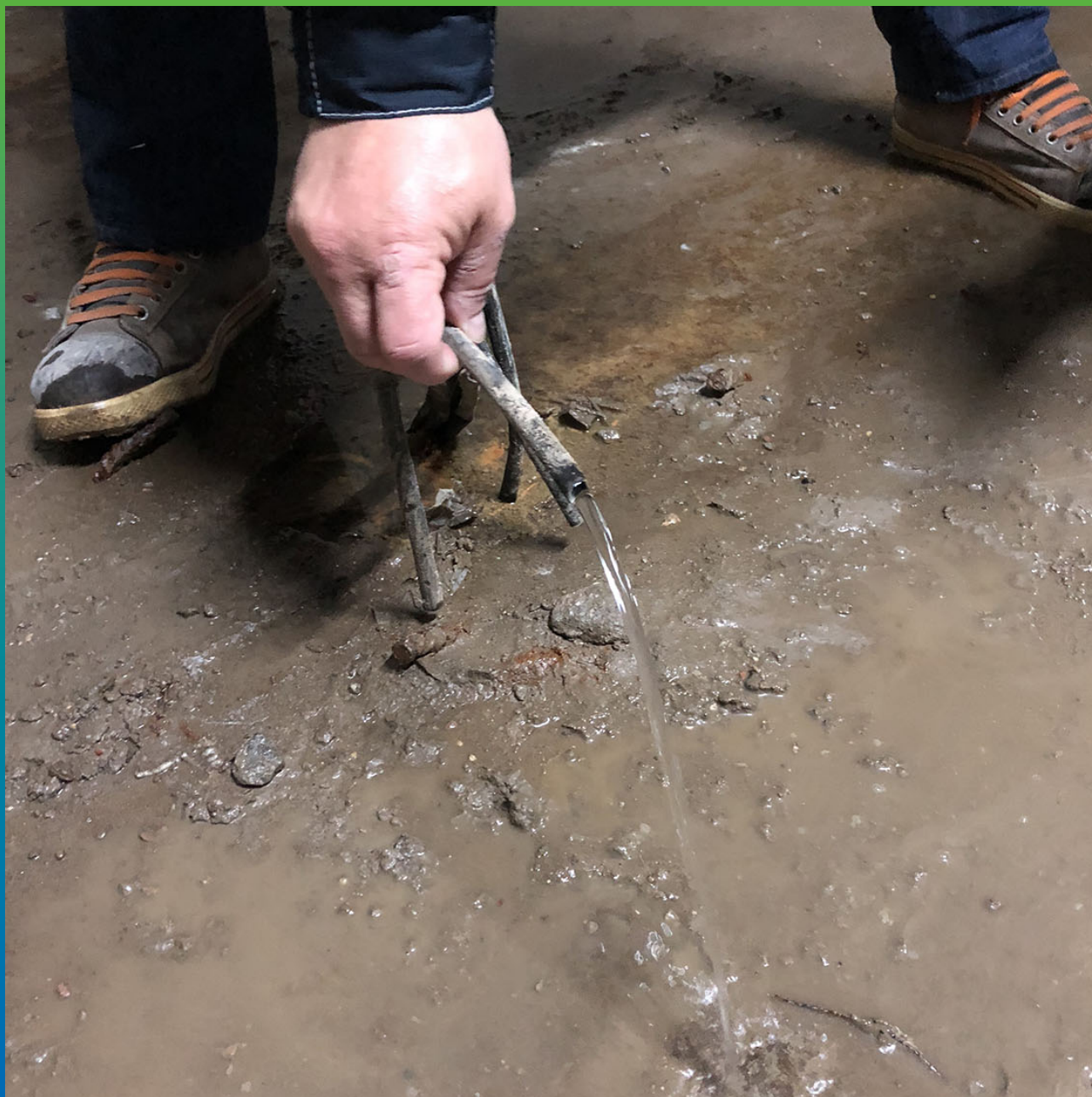
Объект до выполнения работ по гидроизоляции
