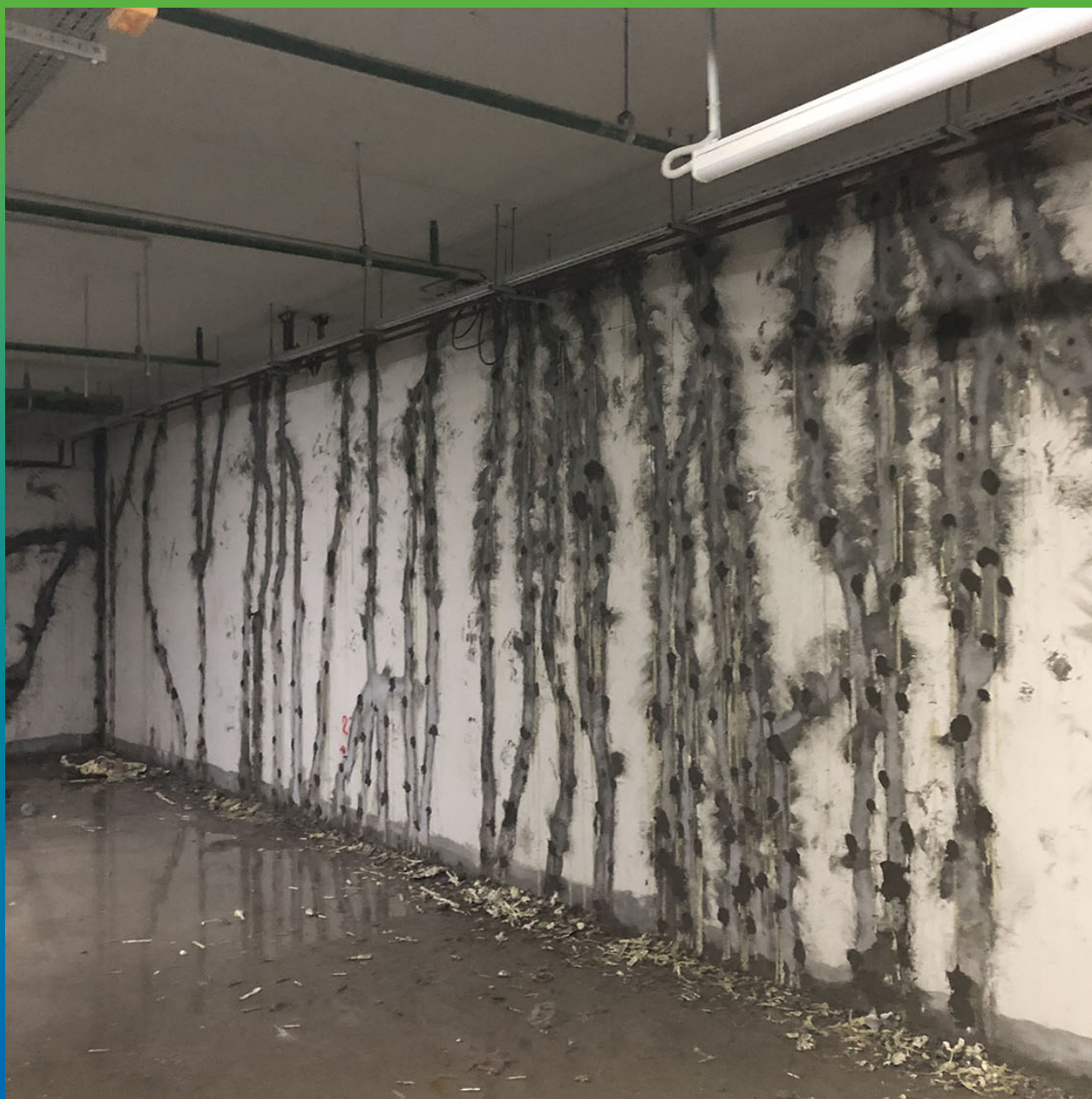
Ремонт и инъектирование трещин
