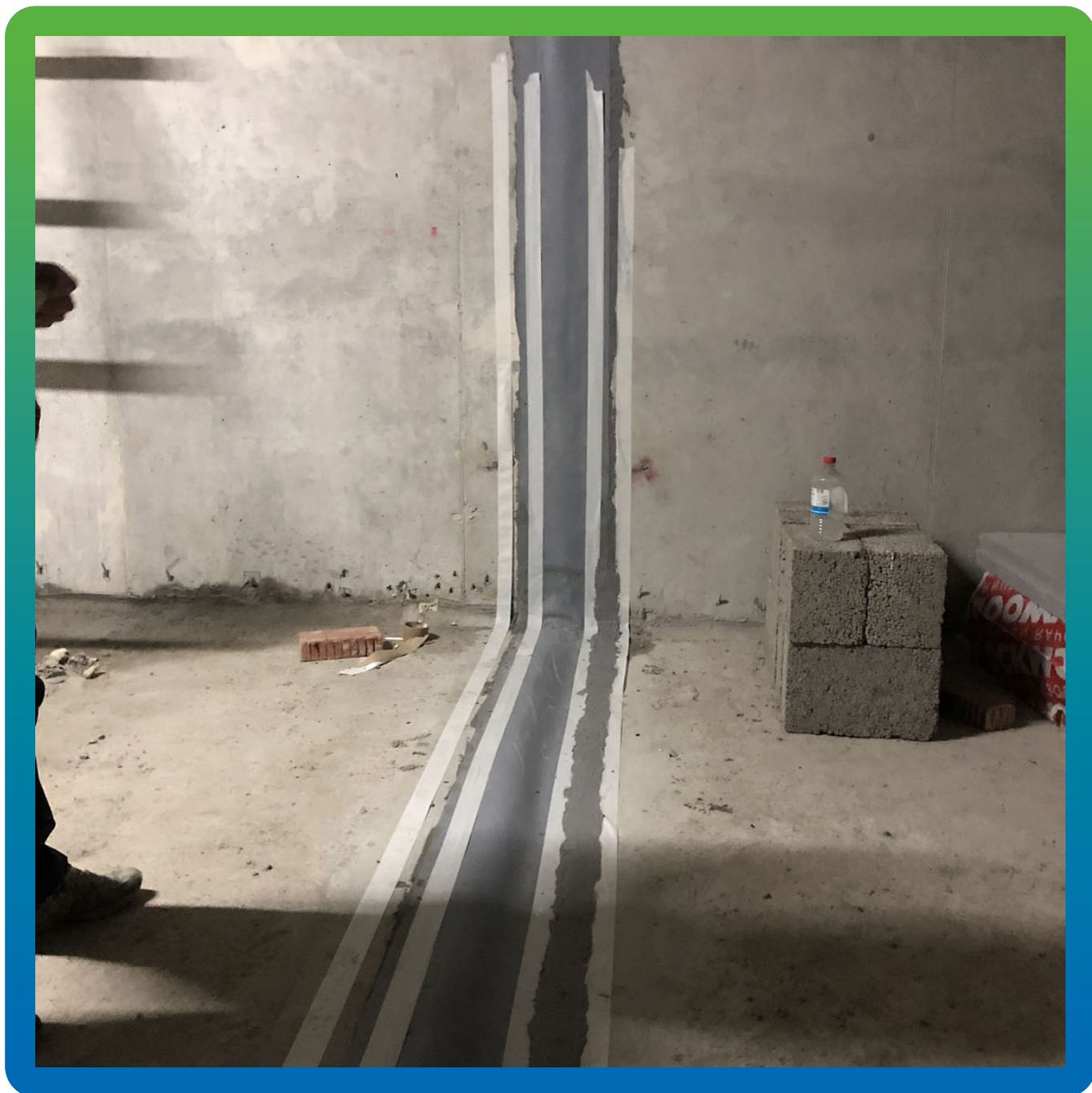
Монтаж системы Манопрокс 331/ Манодил Про
