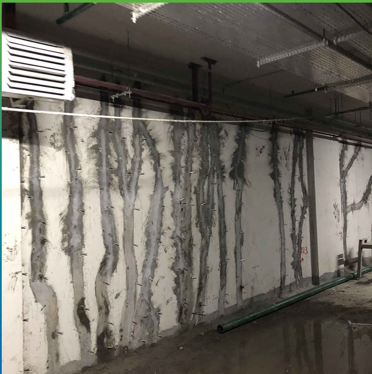
Ремонт и инъектирование трещин
