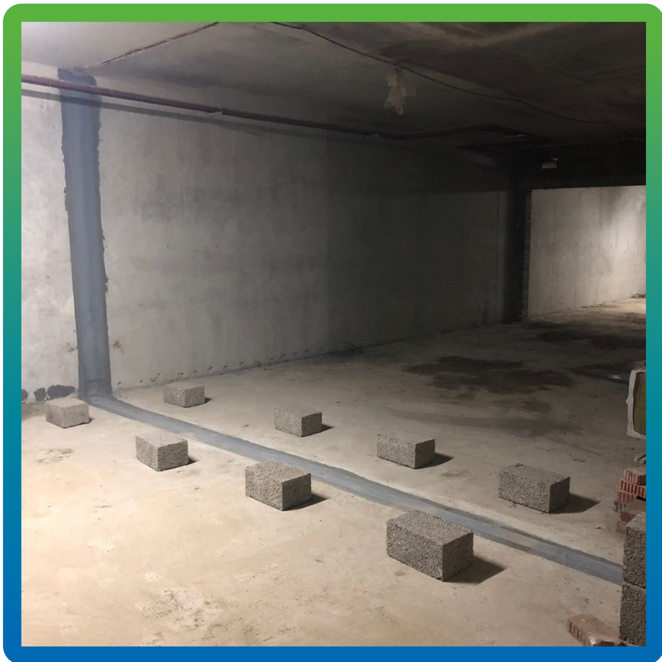
Деформационный шов после проведения гидроизоляционных работ
