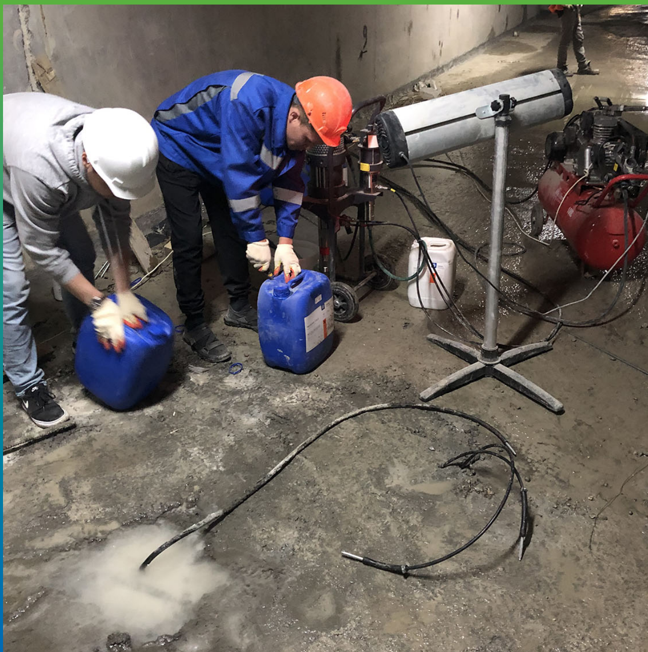
Гидроизоляция технических отверстий
