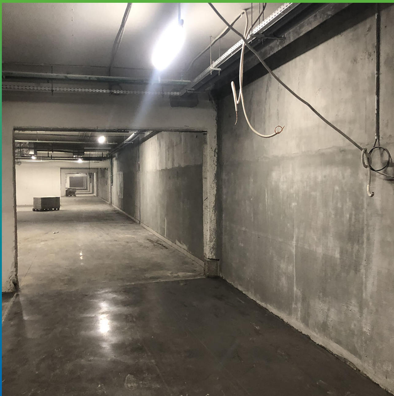
Выполненная комплексная гидроизоляция 3-х уровневой подземной парковки
