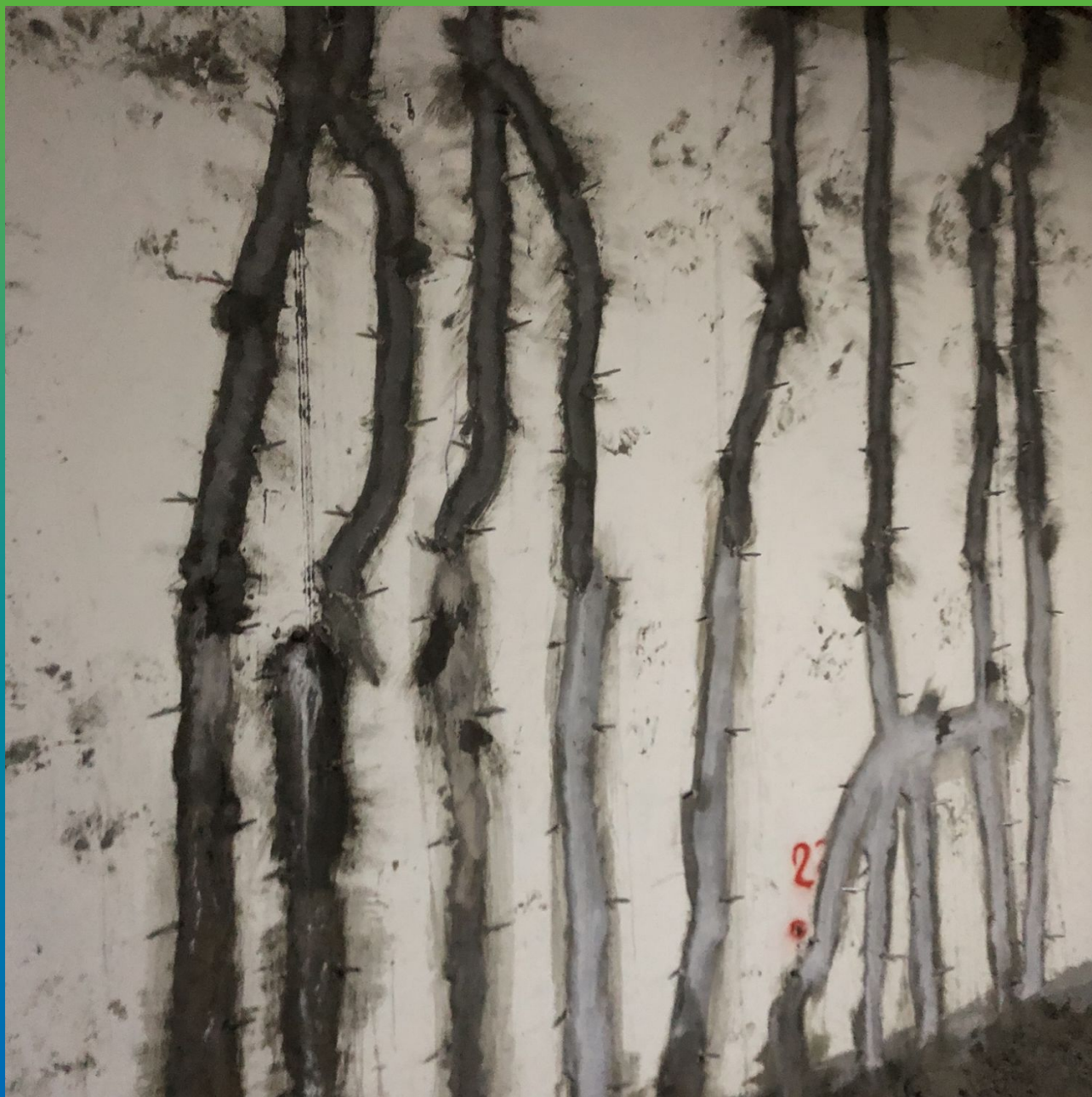
Ремонт и инъектирование трещин
