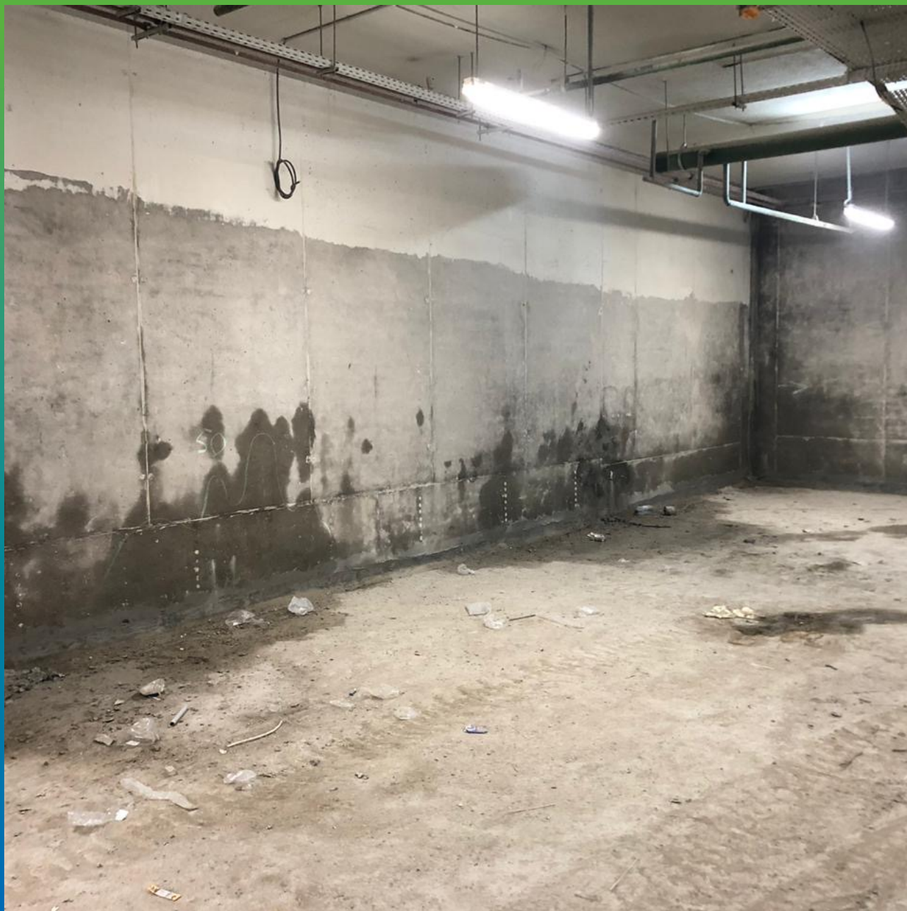
Объект до выполнения работ по гидроизоляции
