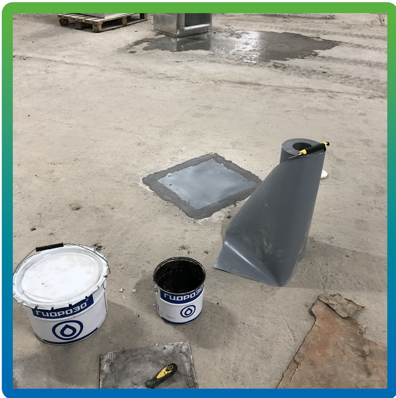
Выполненная гидроизоляция технических отверстий
