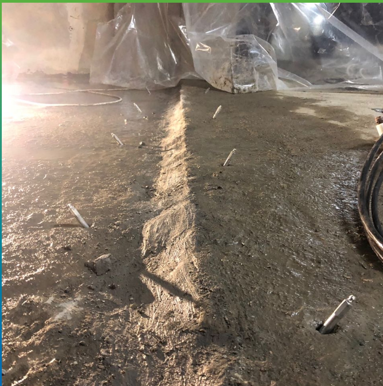
Монтаж пакеров в деформационный шов
