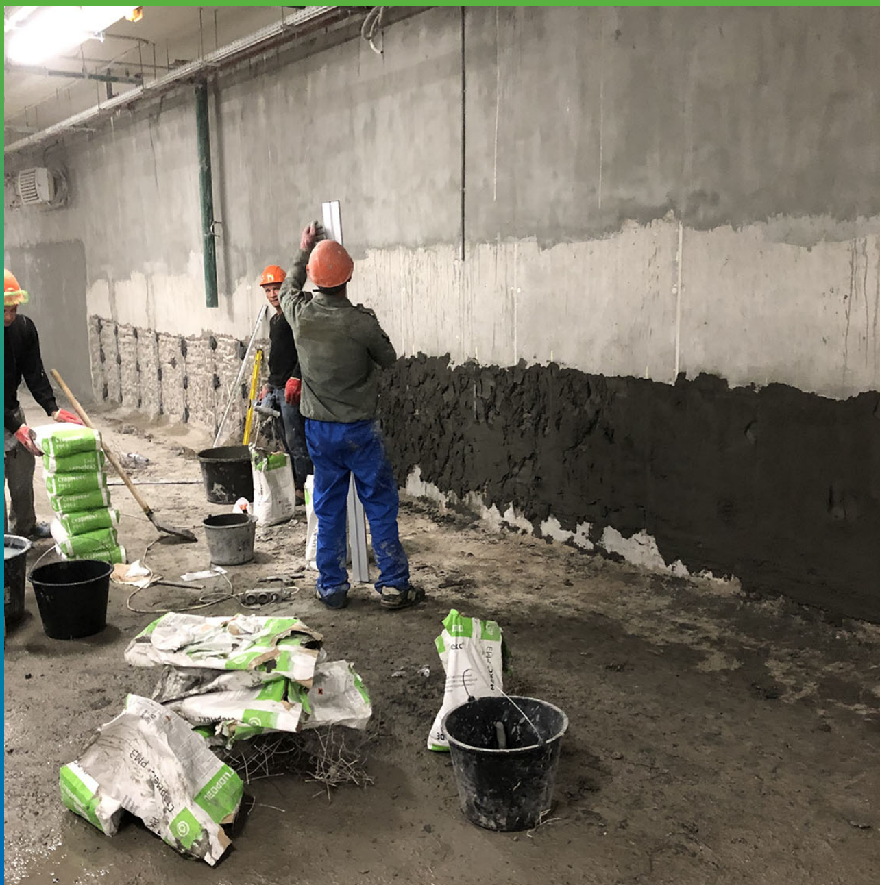
Ремонт бетона
