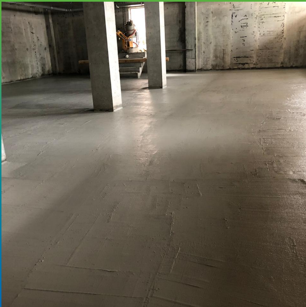
Стармекс Сил, нанесенный на поверхность плиты основания
