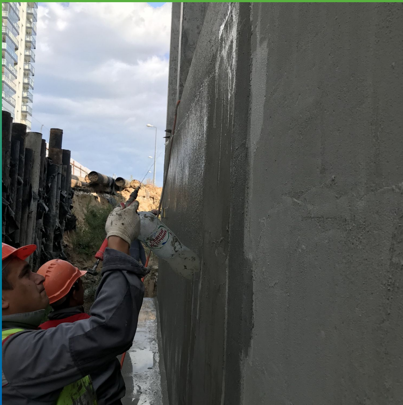
Нанесение состава Стармакс Сил Флекс на места с возможными деформациями
