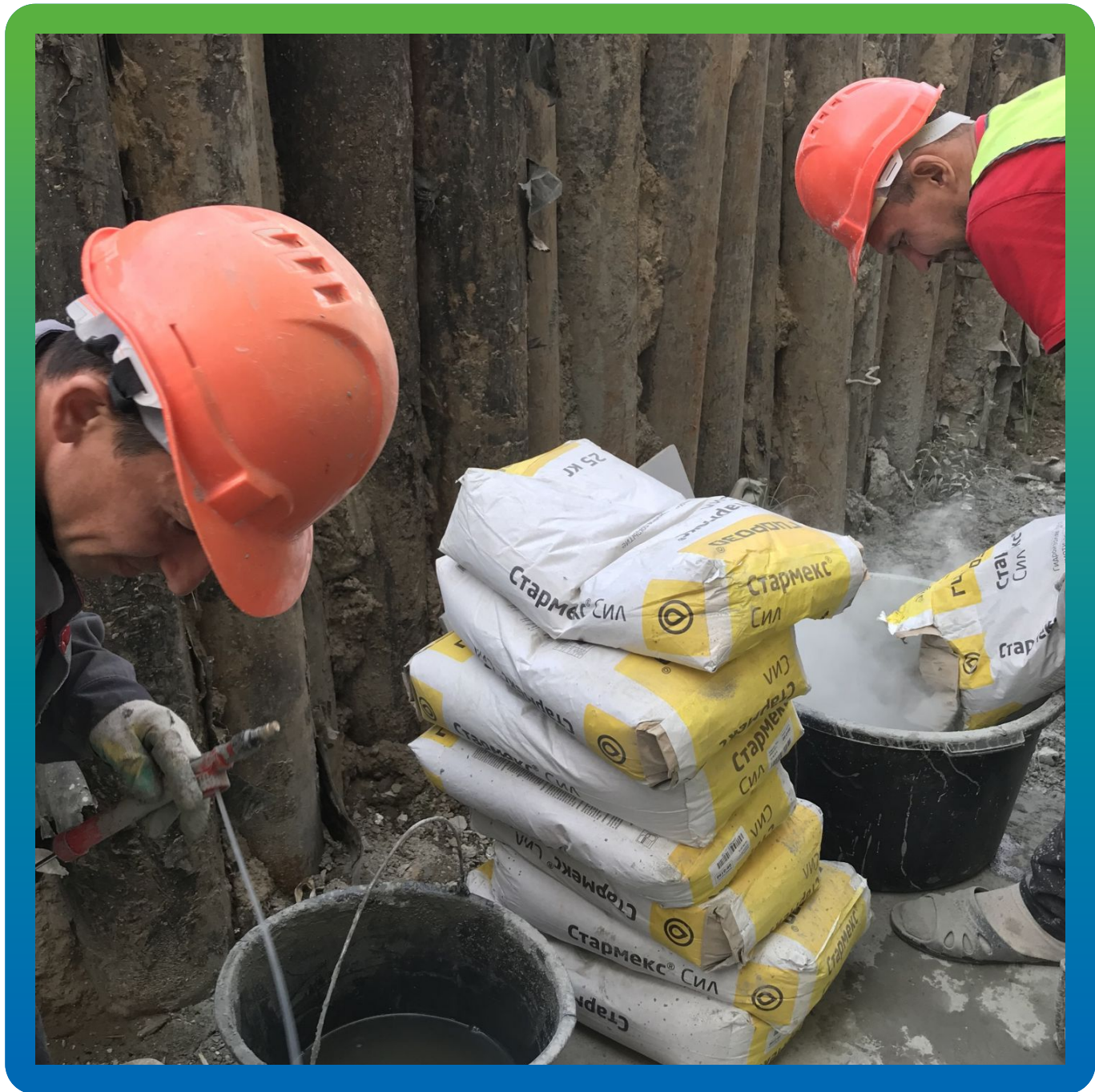
Приготовление состава Стармекс Сил для нанесения на стены
