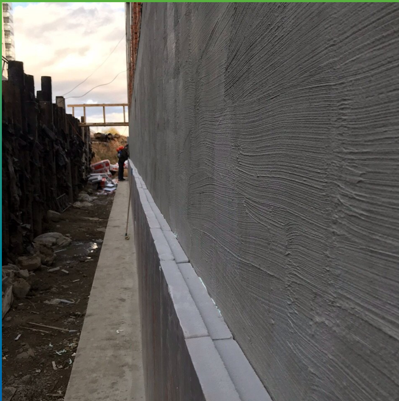
Монтаж утеплителя
