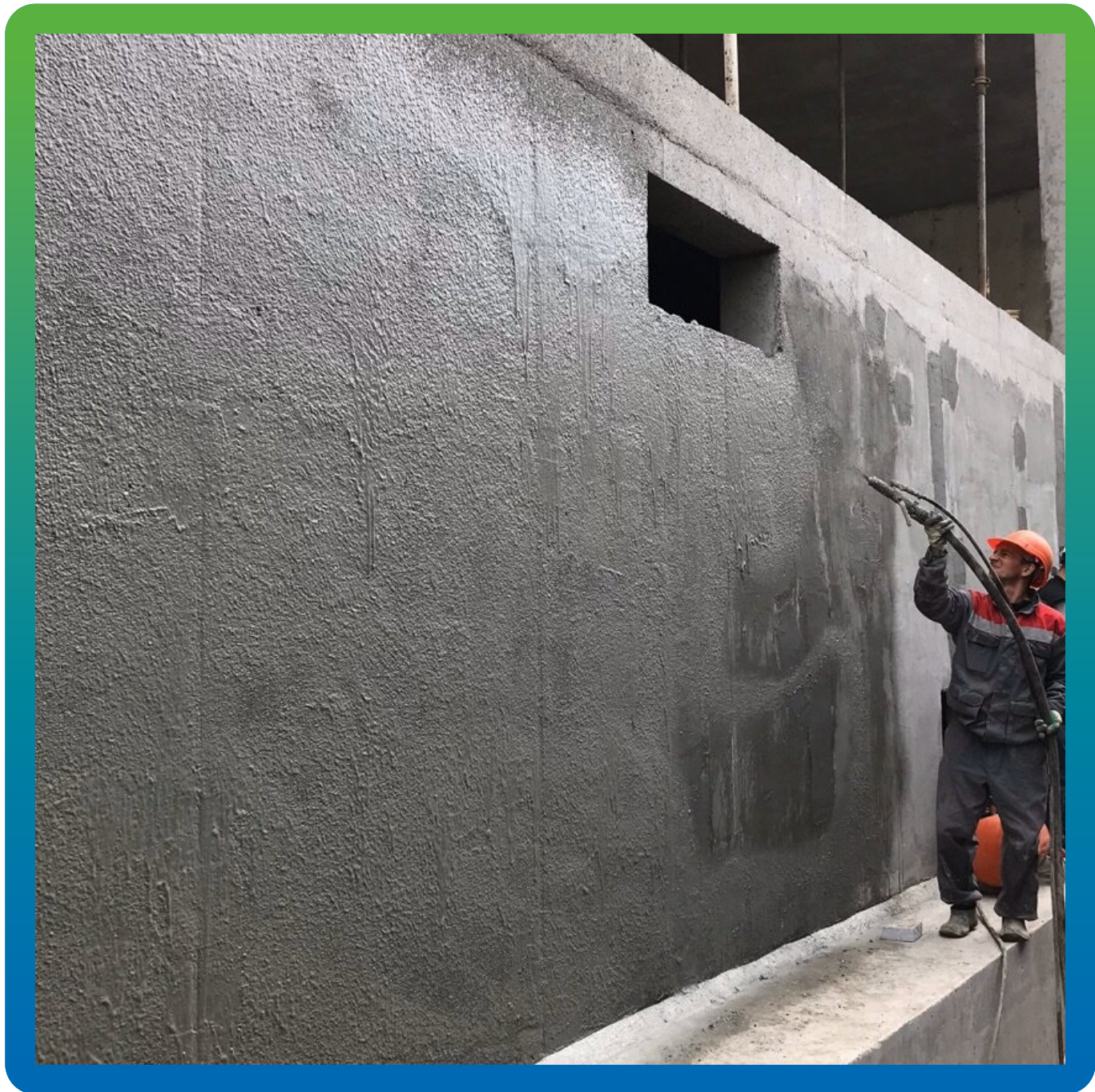
Нанесение состава Стармекс Сил
