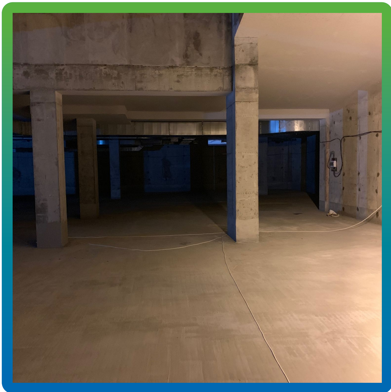
Стармекс Сил, нанесенный на поверхность плиты основания
