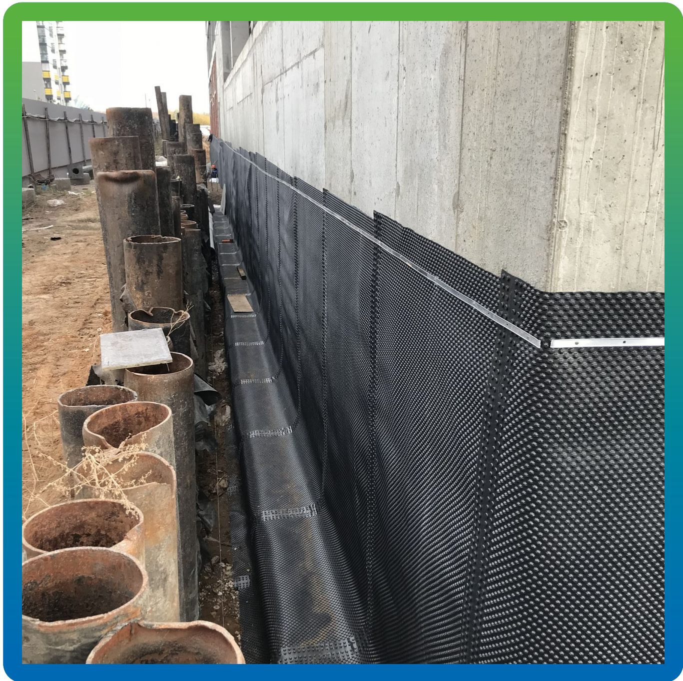
Общий вид конструкции перед обратной засыпкой
