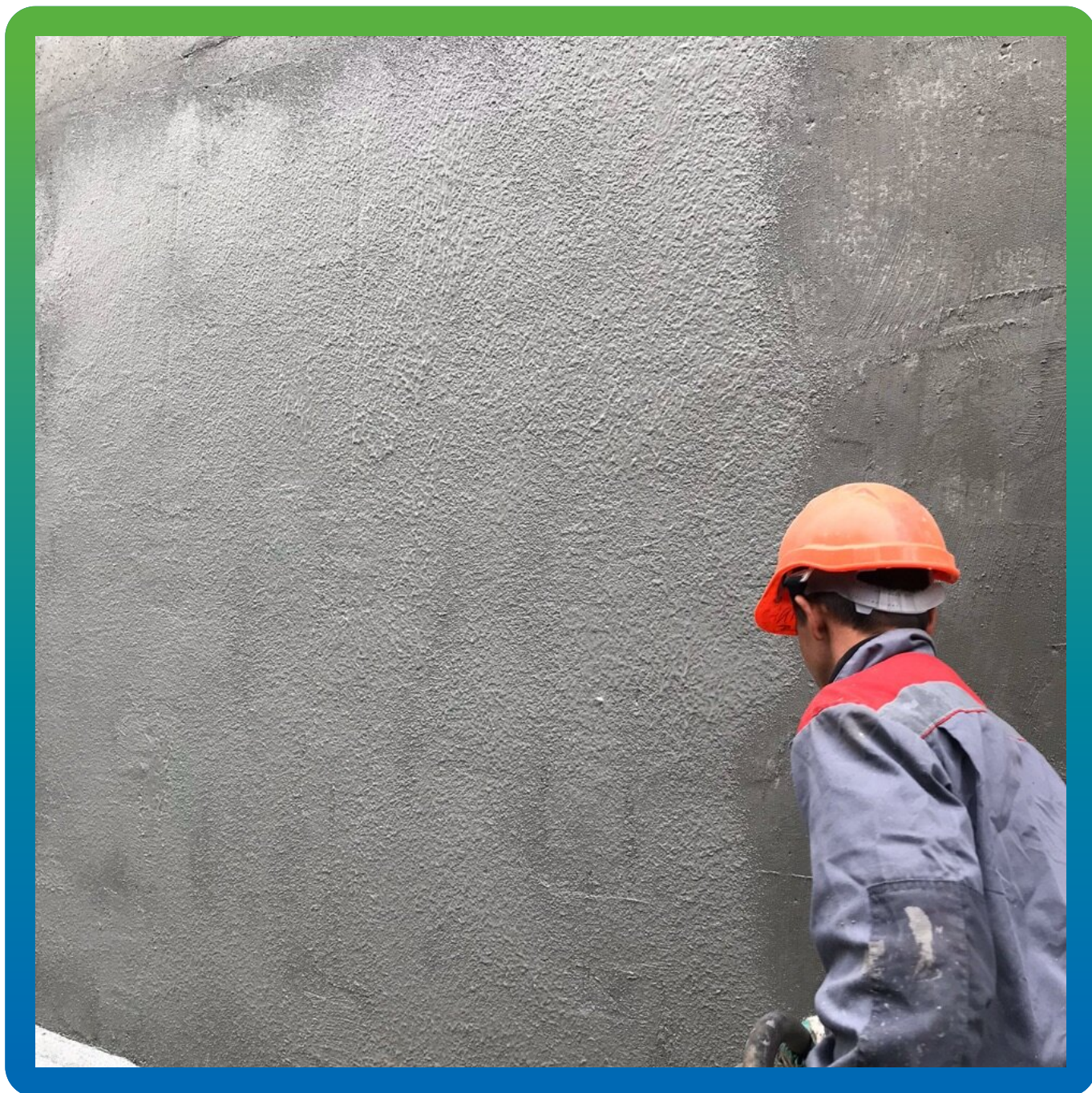
Нанесение состава Стармекс Сил
