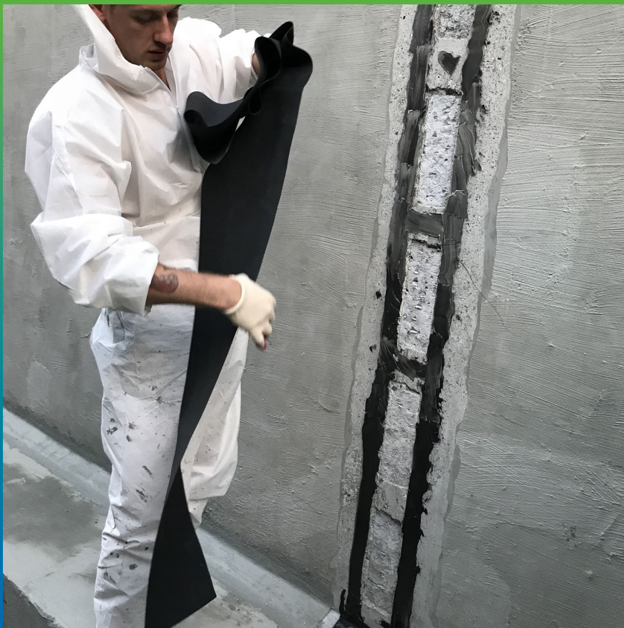
Гидроизоляция теплового контура при помощи ЭПДМ- мембраны Преласты СТ и Витрафин Бонд Ф
