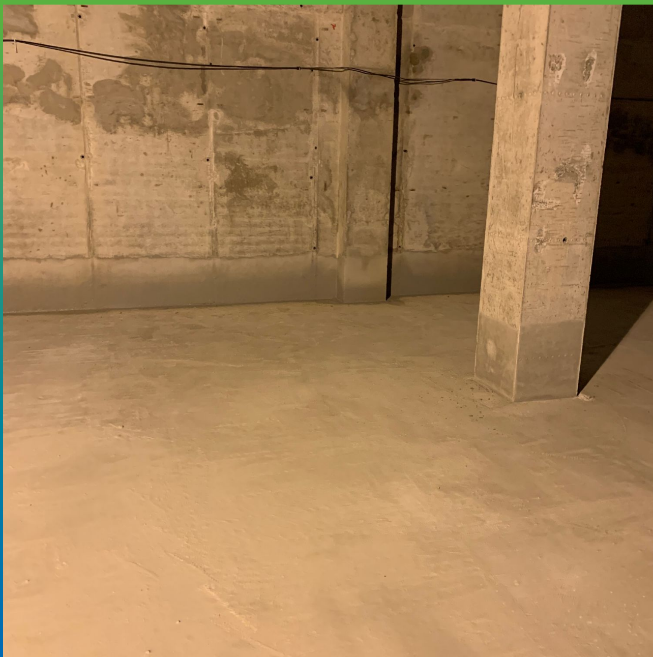
Стармекс Сил, нанесенный на поверхность плиты основания
