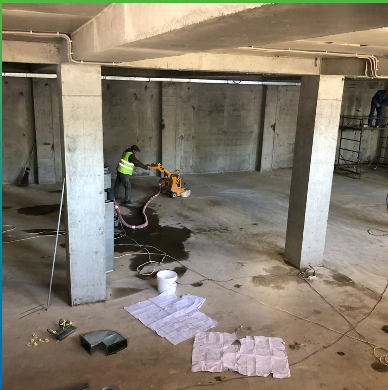
Начало этапа гидроизоляционных работ по плите основания внутри здания. Шлифовка и подготовка основания
