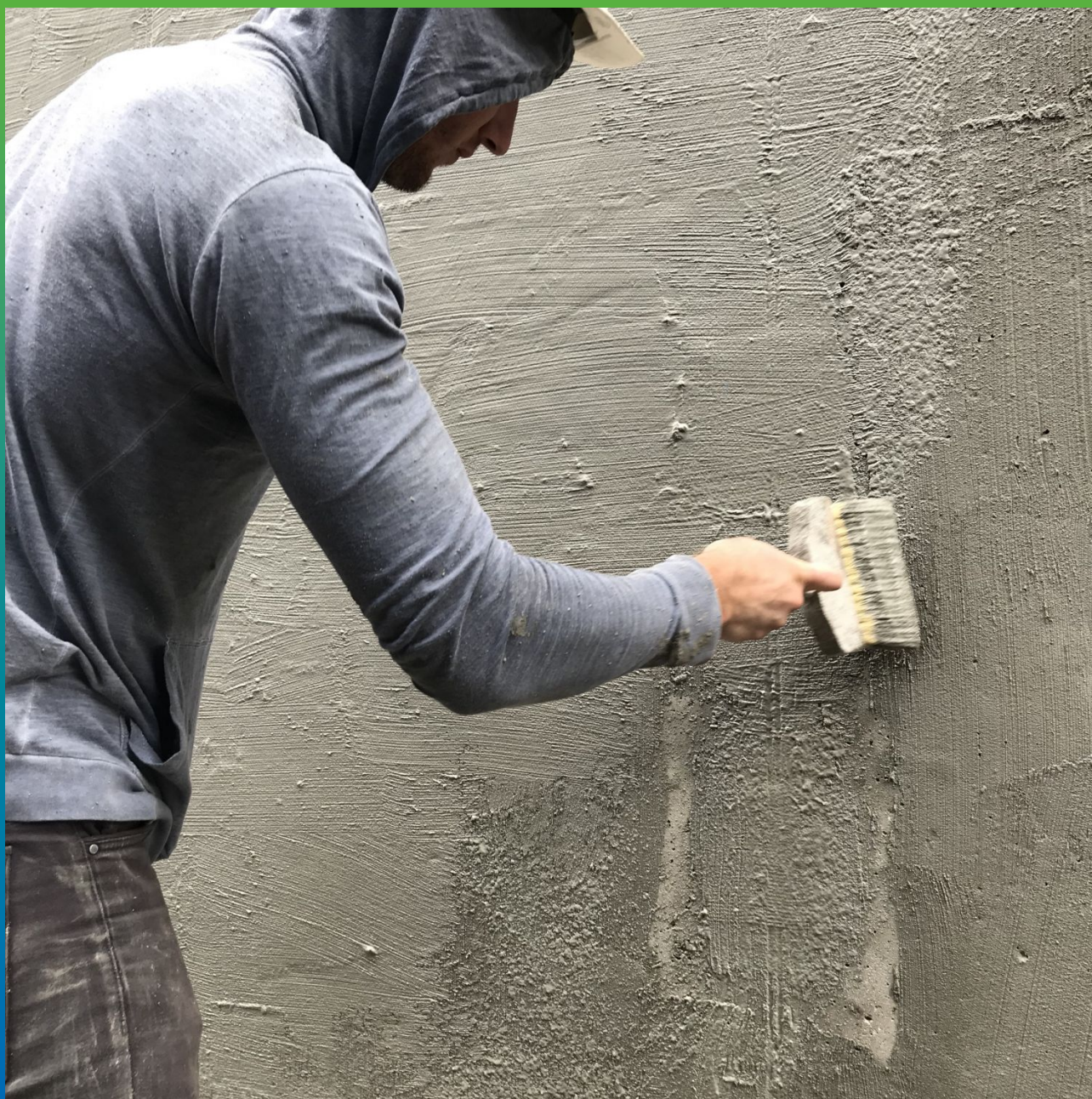
"Растягивание" состава Стармекс Сил кистью после набрызга насосом
