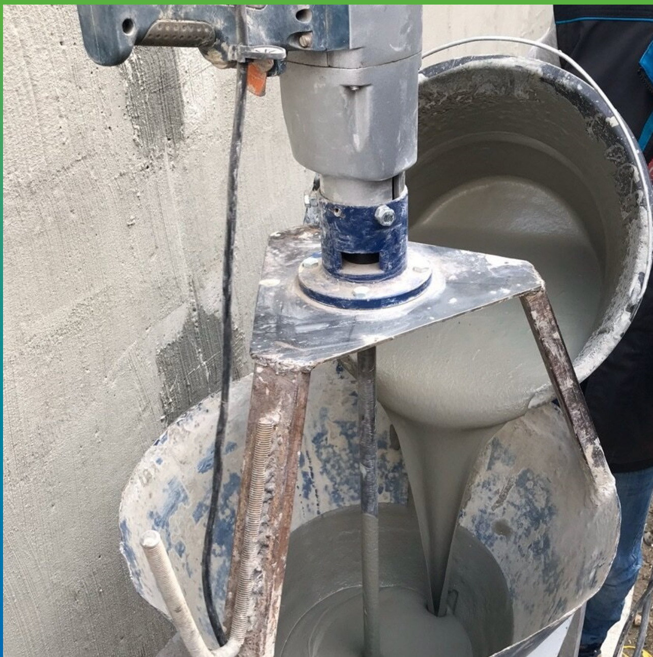
Подготовка к нанесению состава Стармекс Сил
