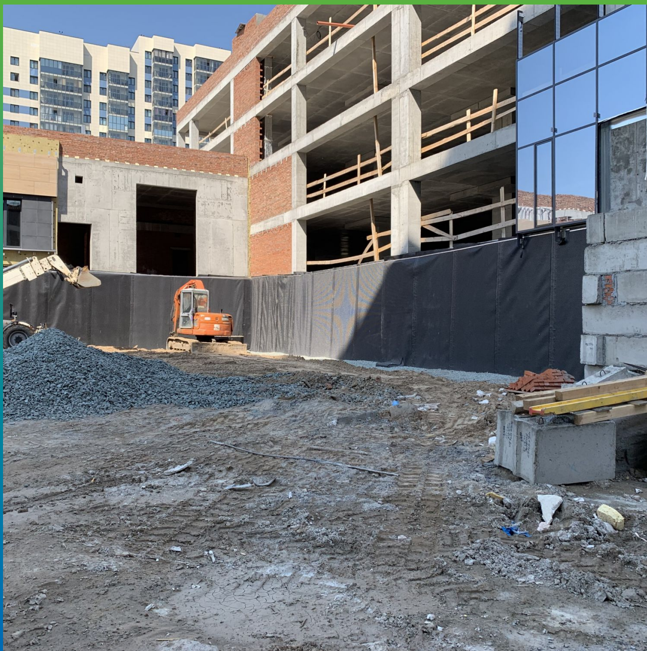
Общий периметр перед обратной засыпкой
