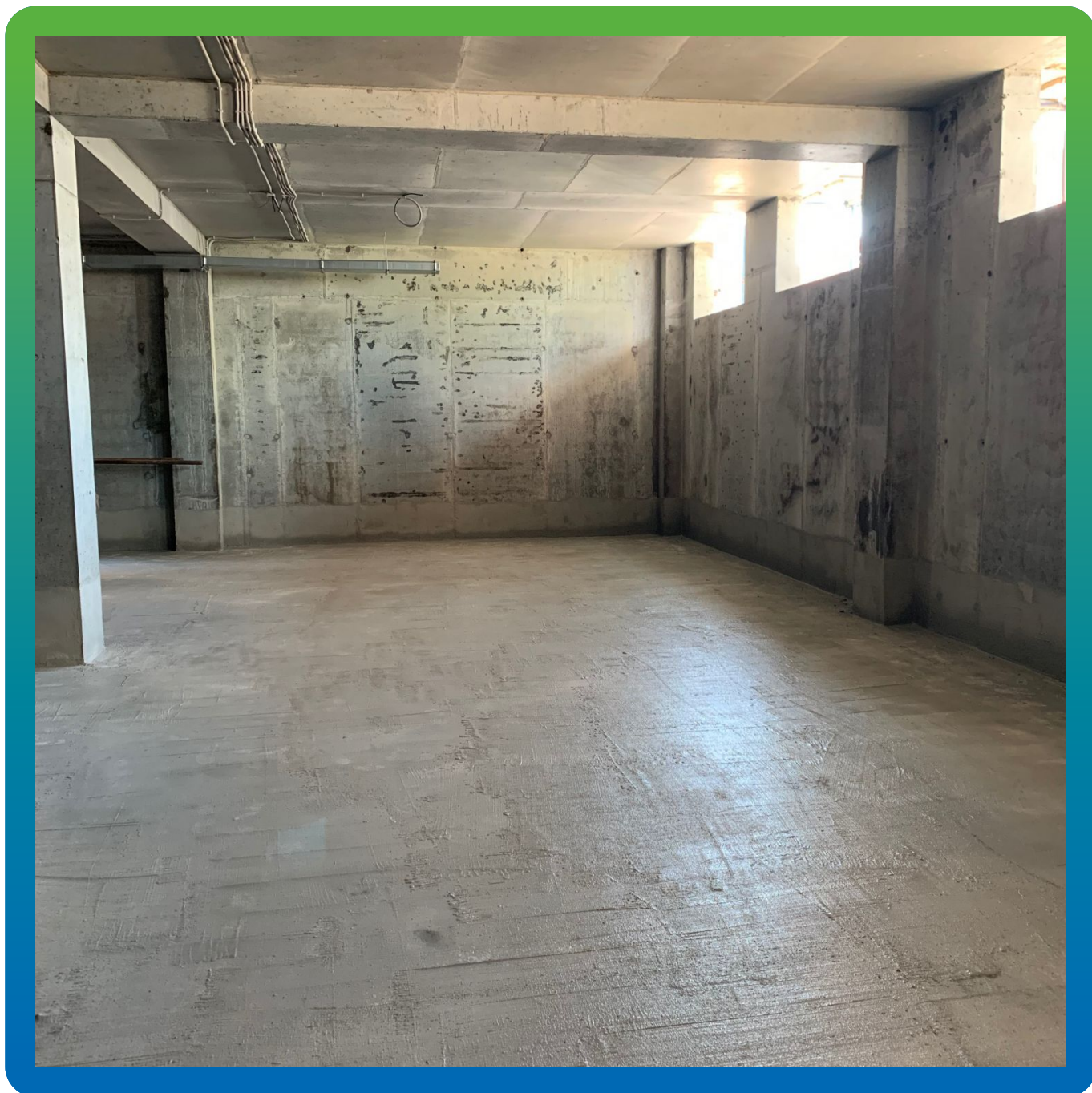
Стармекс Сил, нанесенный на поверхность плиты основания
