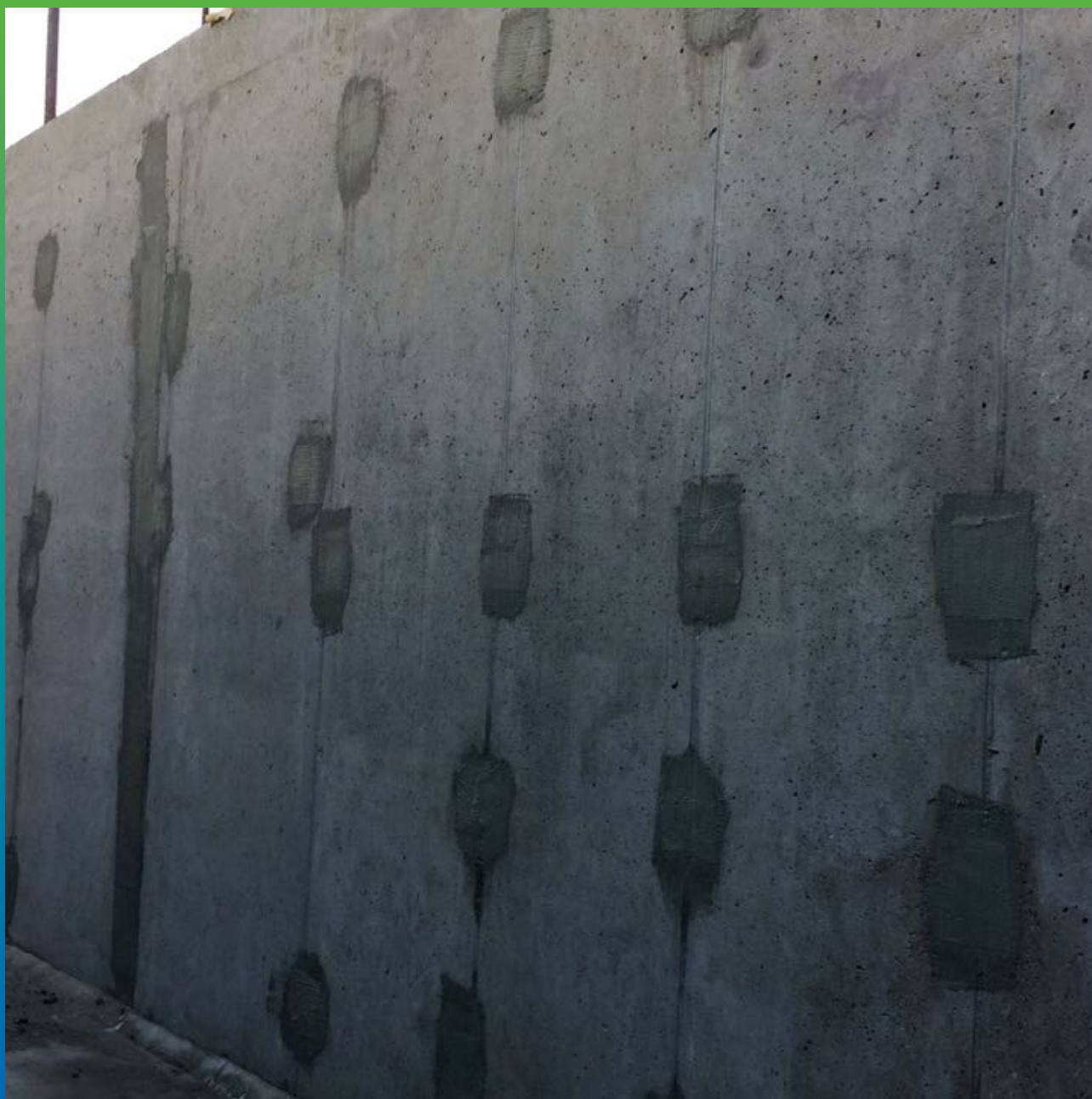
Стармекс Сил Флекс на местах с возможными деформациями
