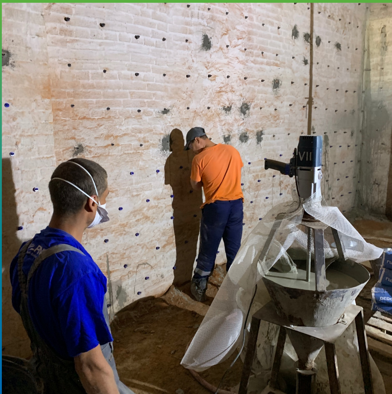
Проведение инъектирования
