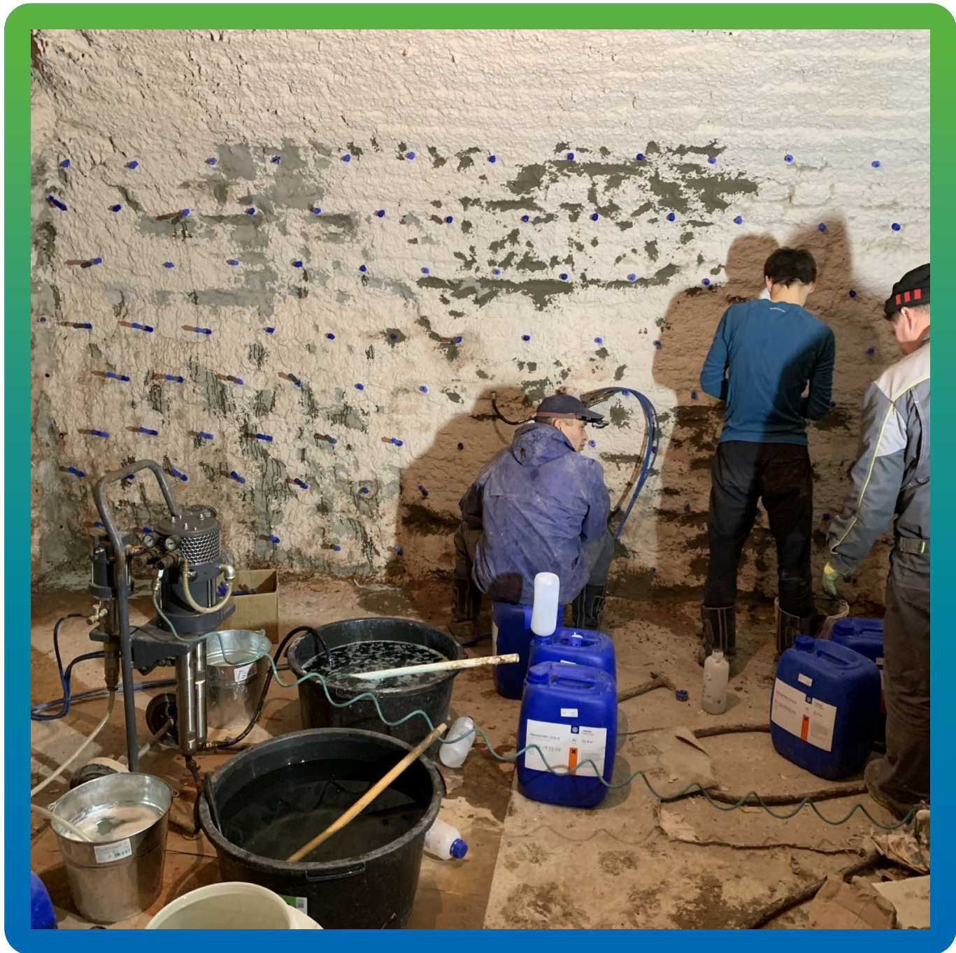
Проведение инъекционных работ в соседнем помещении
