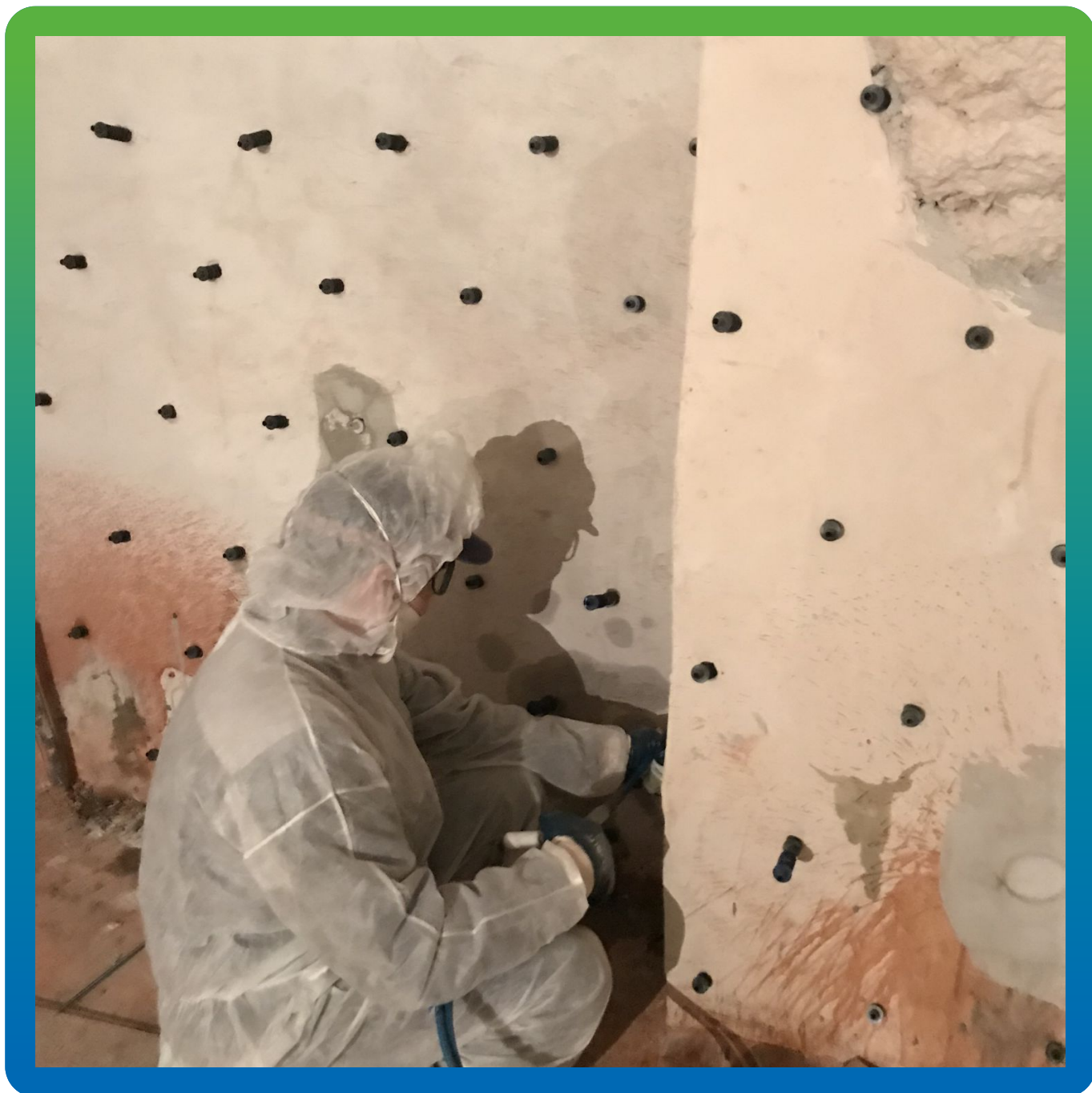
Проведение инъекционных работ
