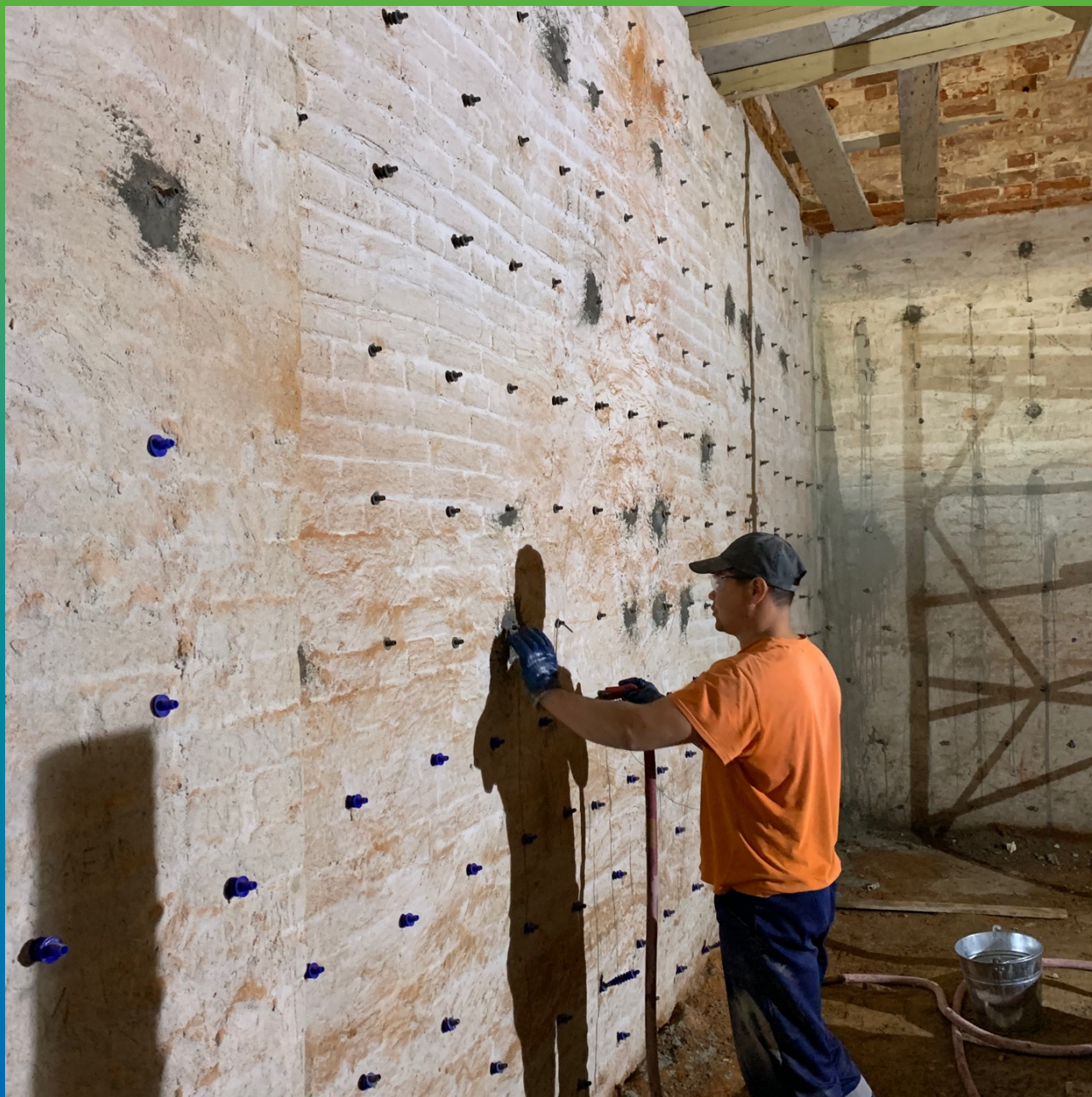
Проведение инъектирования
