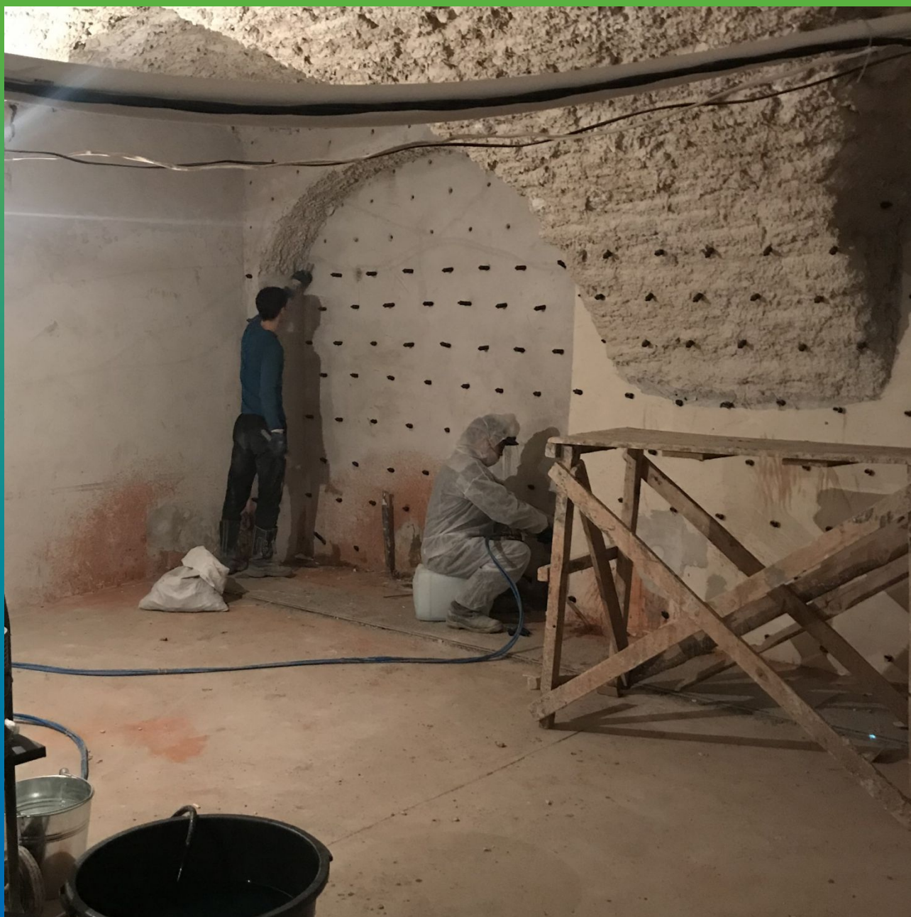
Монтаж пакеров для инъектирования Маноерил Гель В
