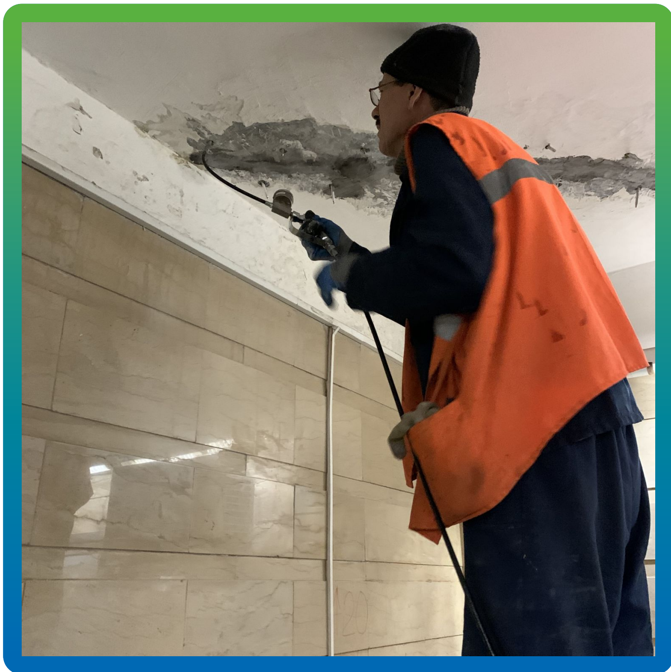
Инъектирование трещины
