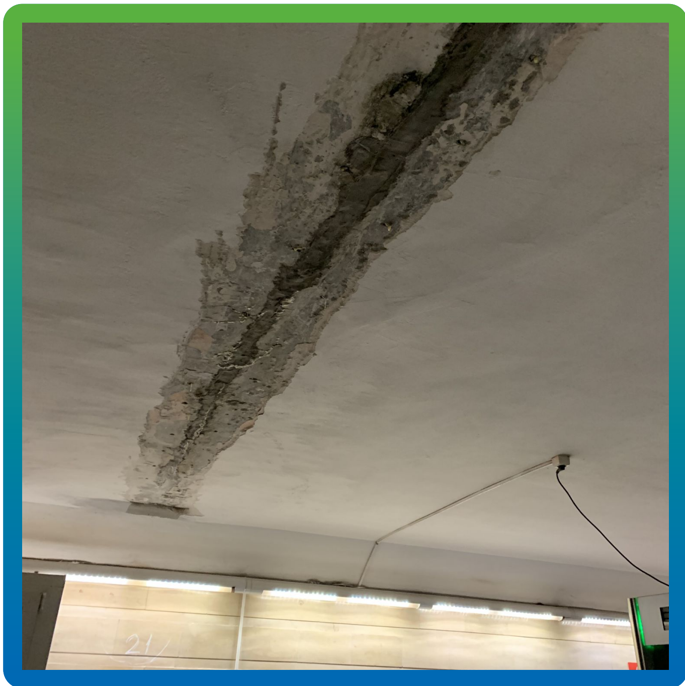
Вид шва после инъектирования
