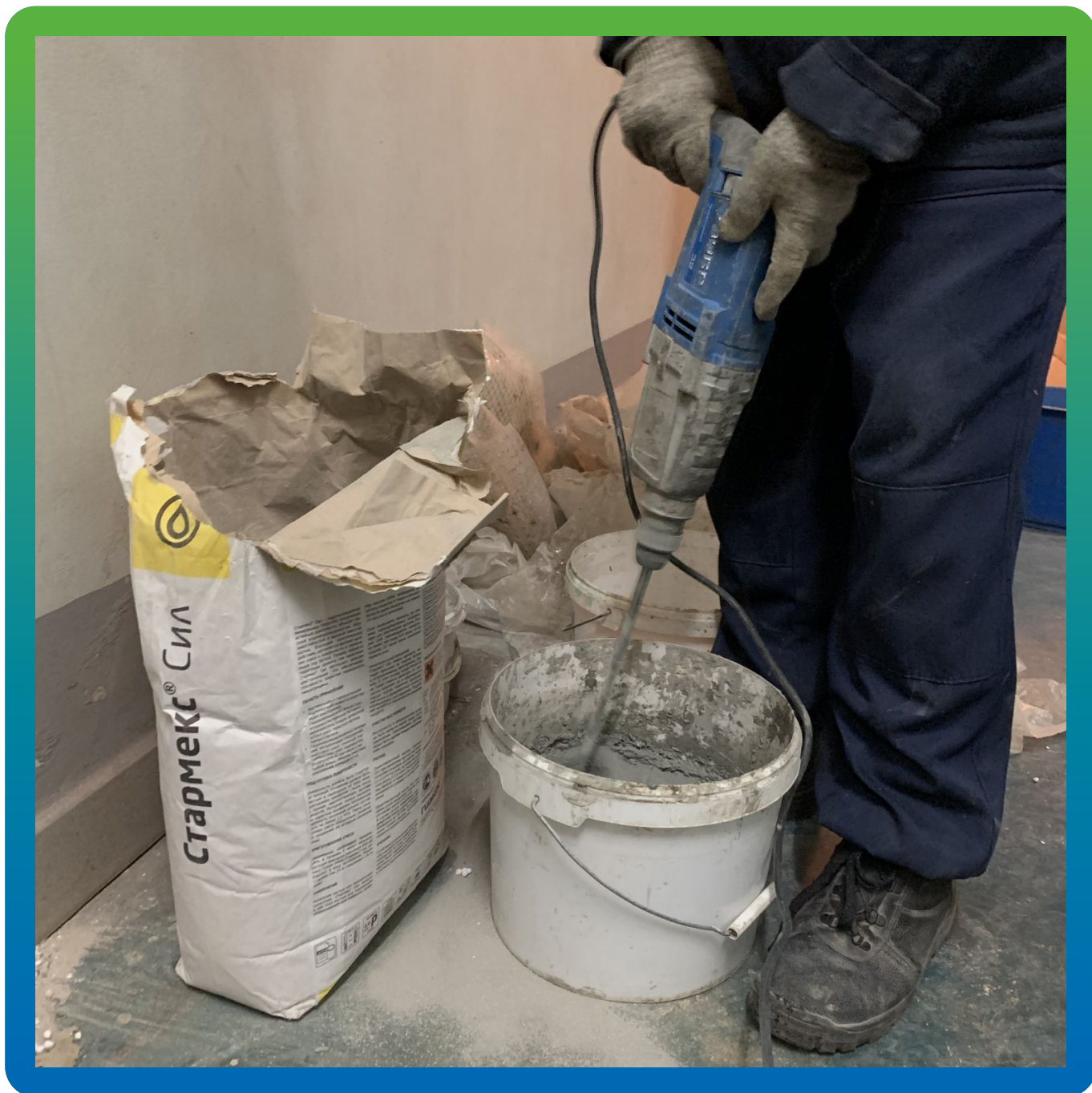
Приготовление состава Стармекс Сил для нанесения на трещину и шов
