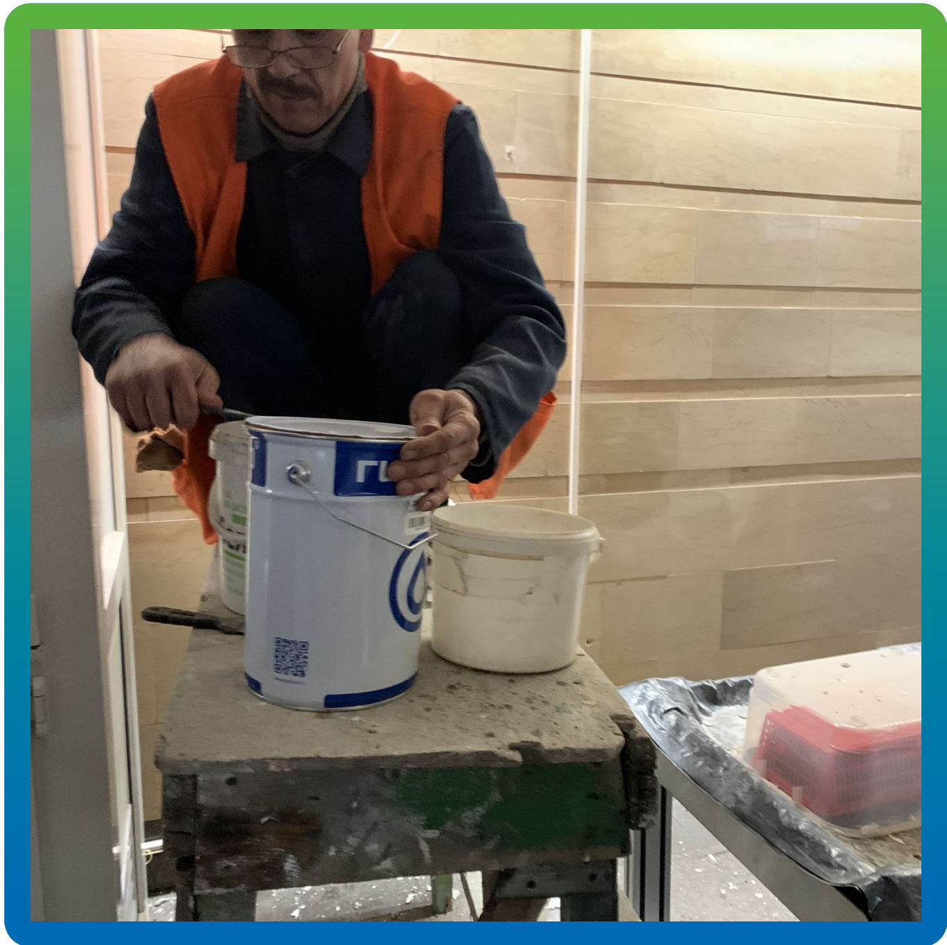
Подготовка материала Стармакс Плаг к использованию на объекте
