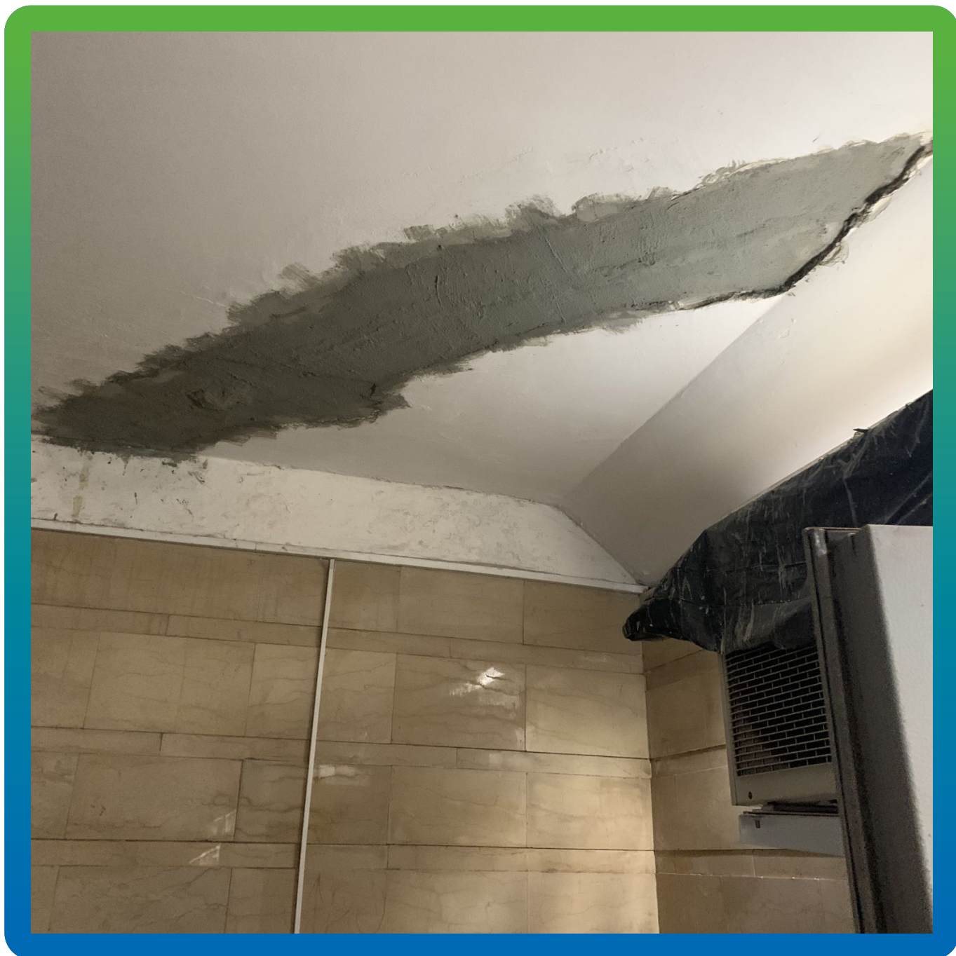
Стармекс Сил, нанесенный на поверхность трещины
