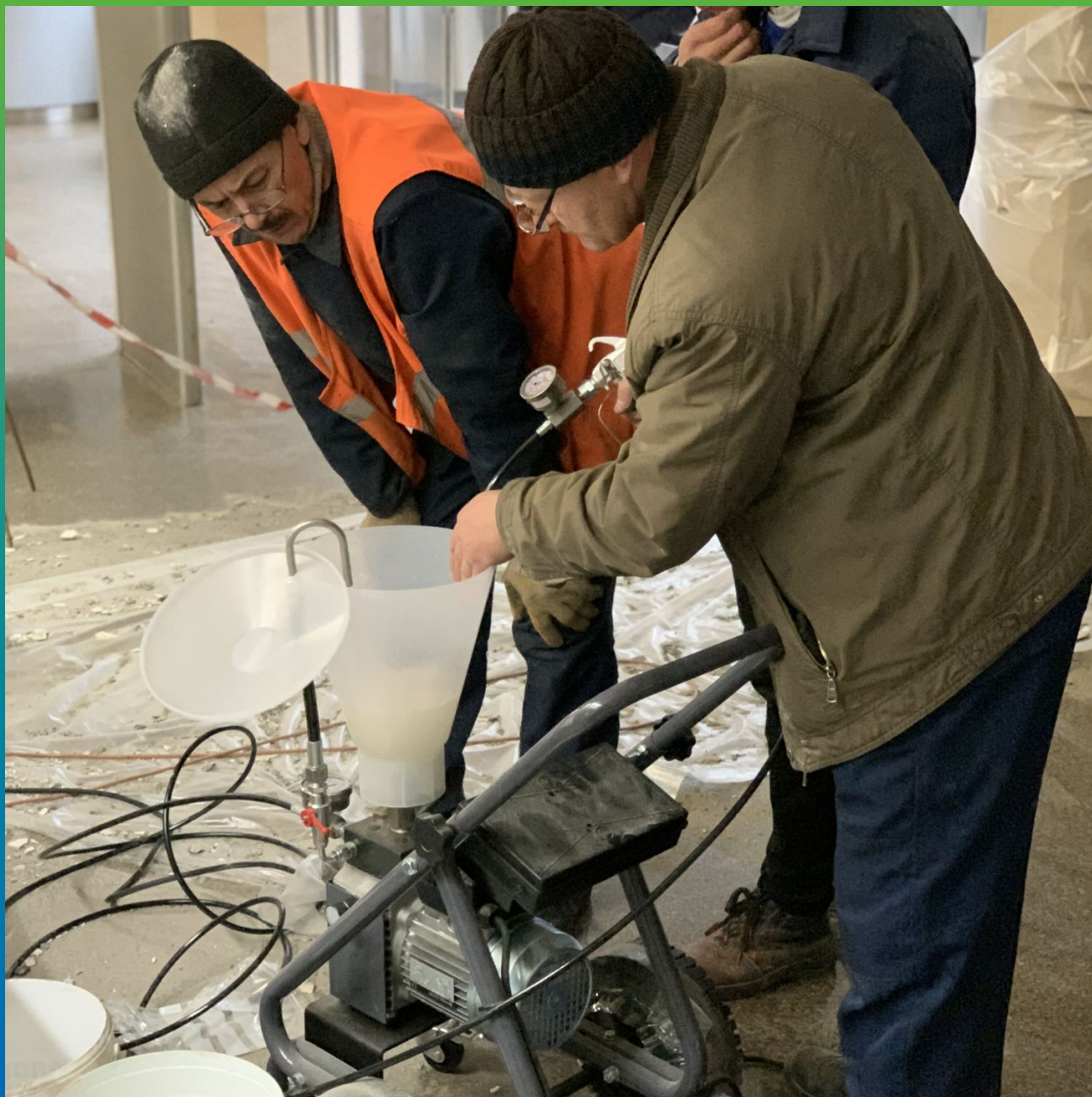
Подготовка насоса БМ 1200 к инъектированию
