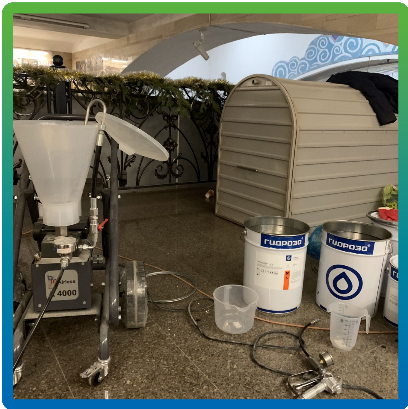
Материалы и насос БМ 1200 на объекте
