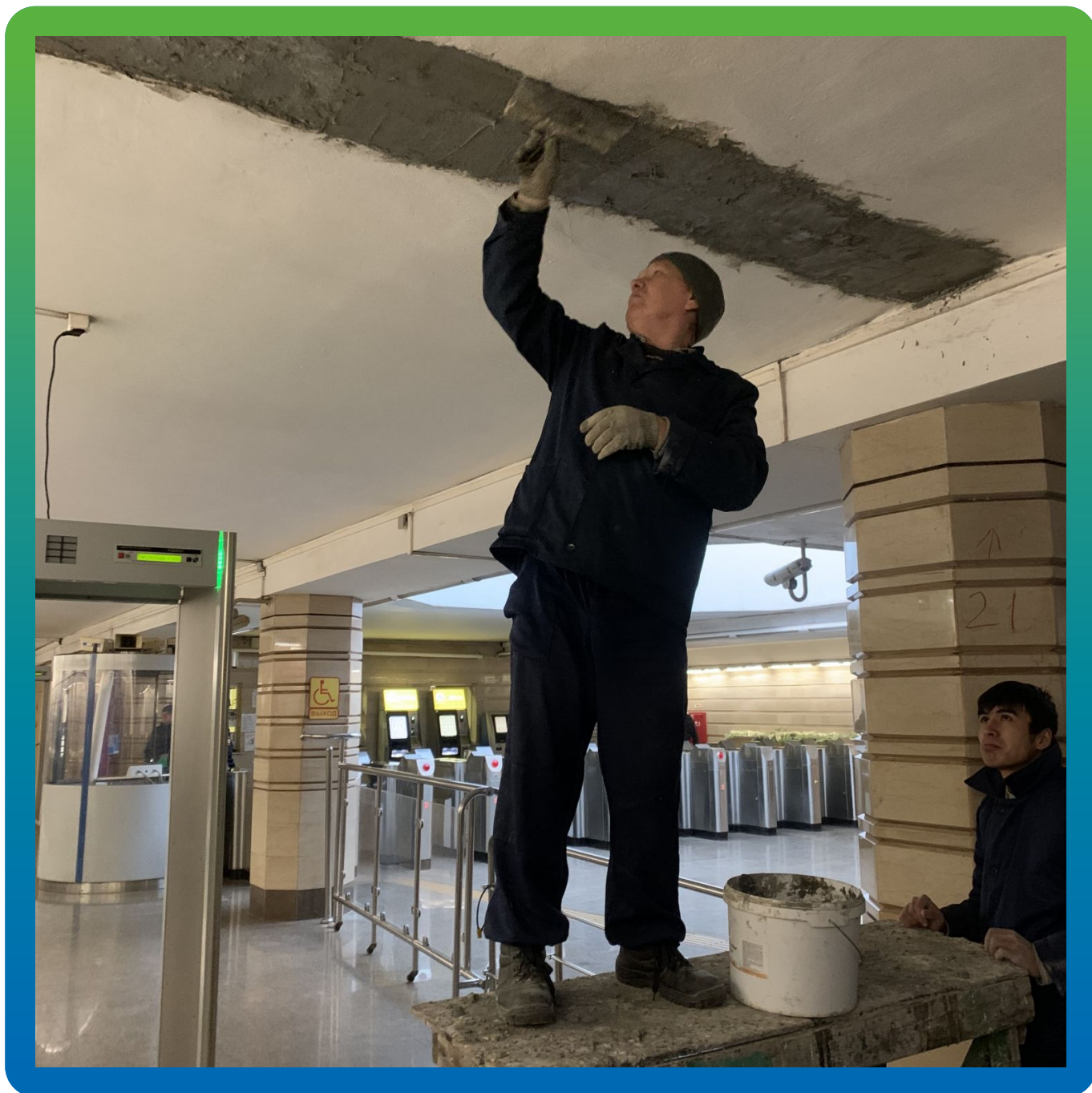
Нанесение состава Стармекс Сил
