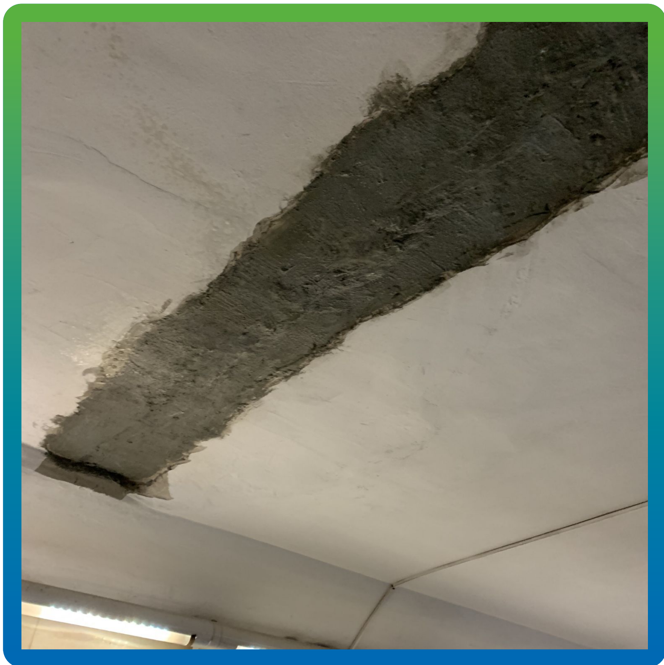
Стармекс Сил, нанесенный на поверхность шва
