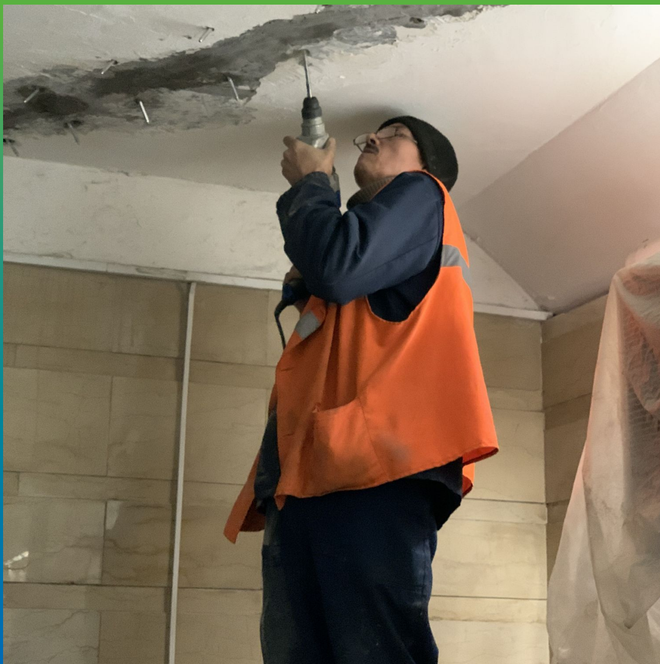
Бурение каналов для пакеров
