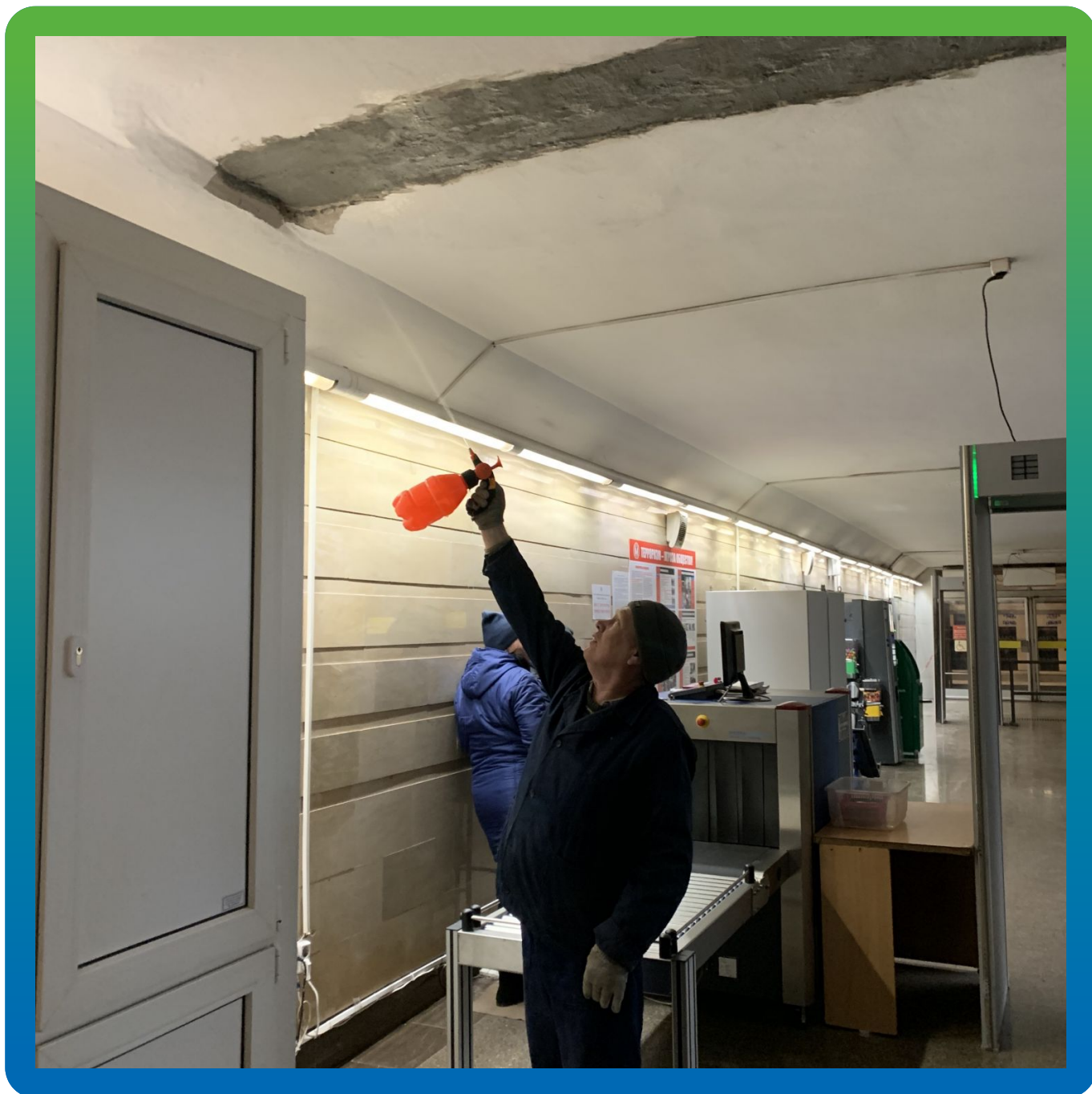
Увлажнение поверхности для нанесения Стармекс Сил
