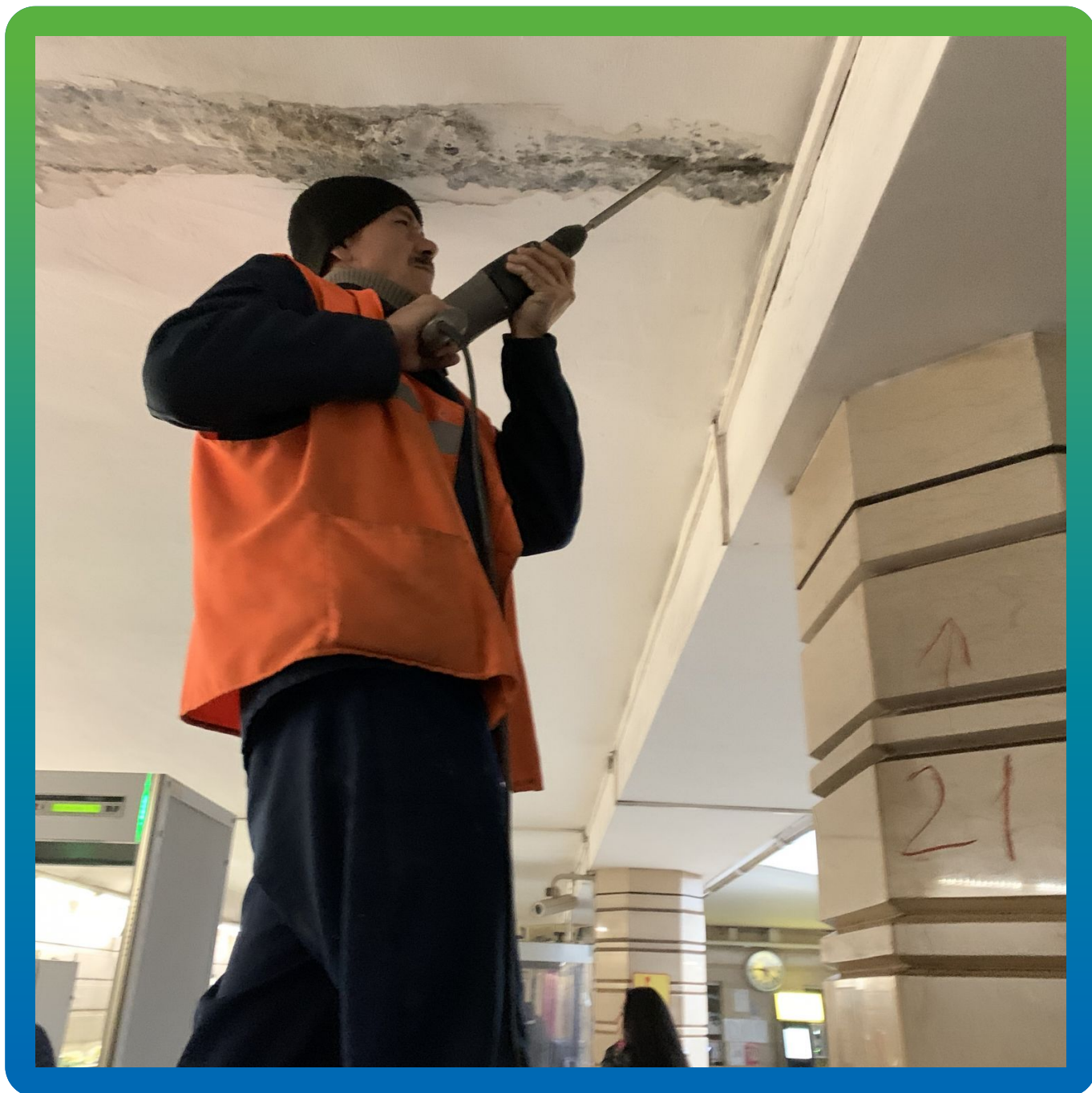
Расшивка "холодного шва" бетонирования
