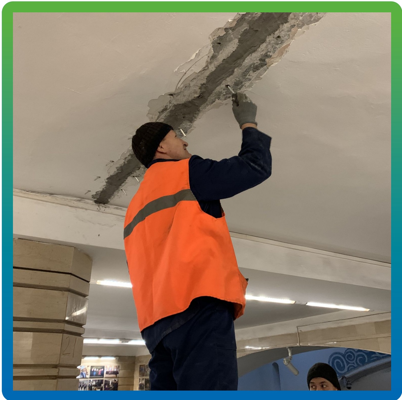
Монтаж инъекционных пакеров
