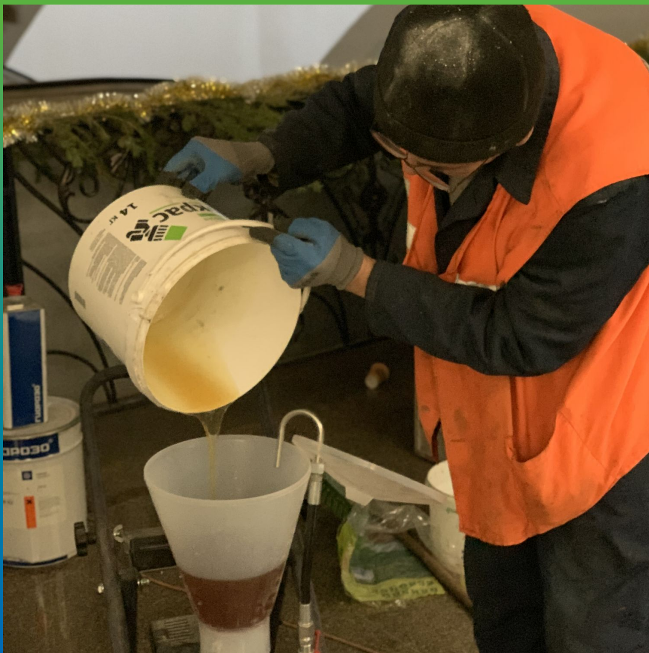
Заполнение бункера насоса инъекционным материалом Манопур 143
