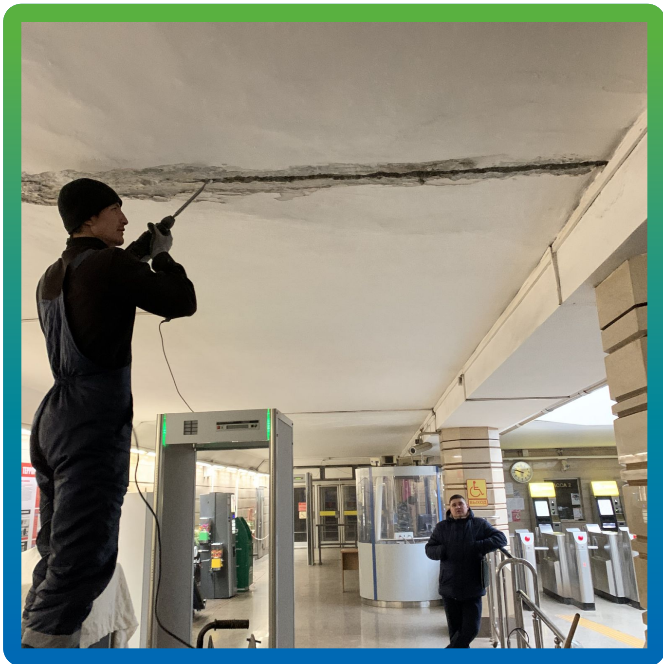
Расшивка "холодного шва" бетонирования
