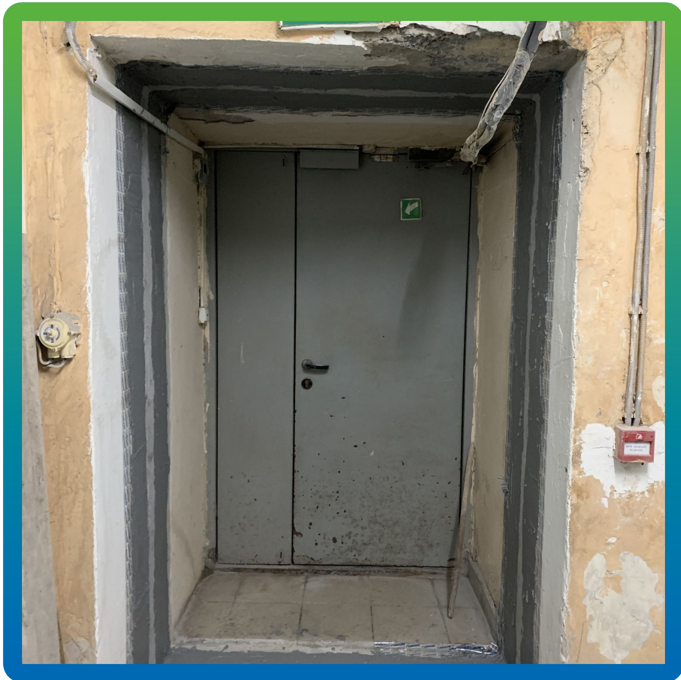
Манопокс 331 на поверхности шва
