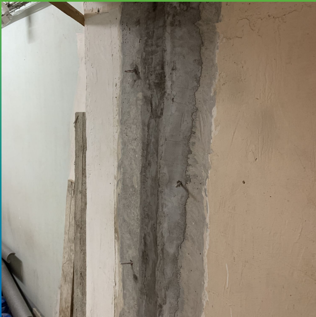
Шов, зачеканенный составом Стармекс Плаг
