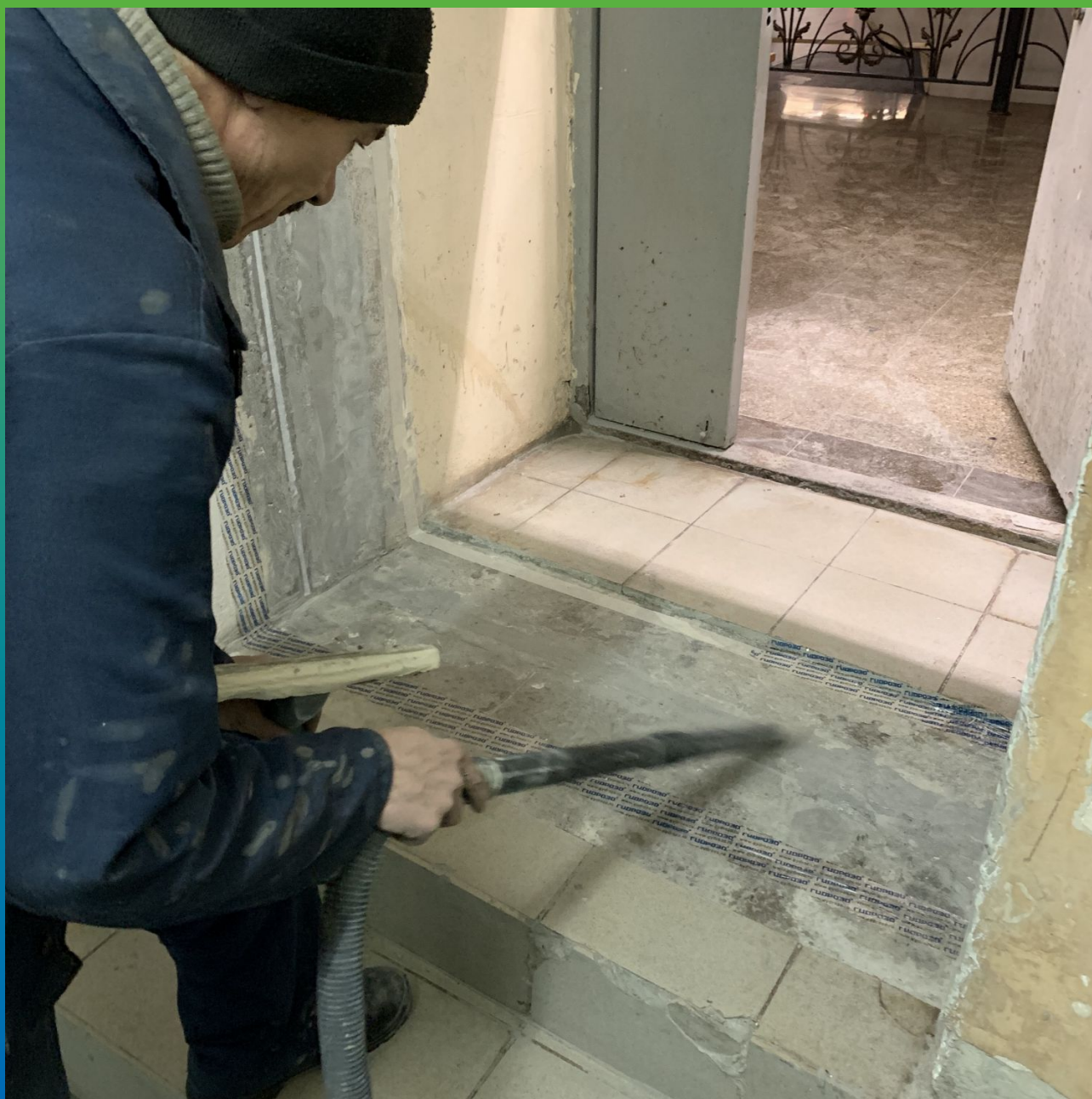
Очистка шва для последующего монтажа Манодил Про
