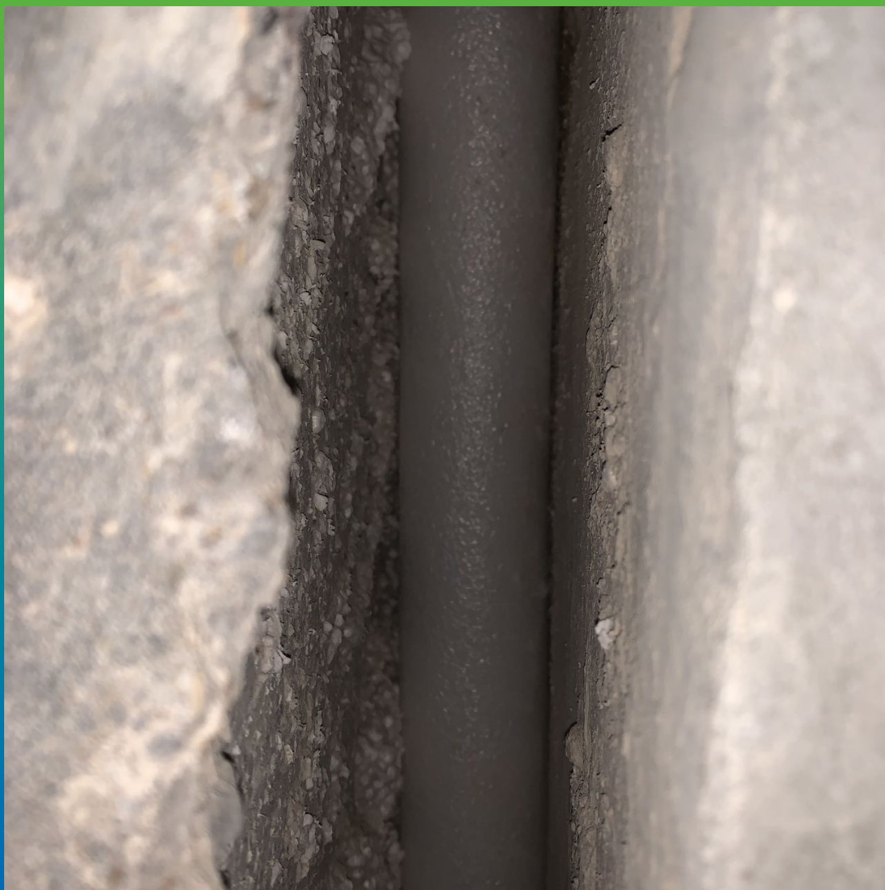
Монтаж вилатерма в полость шва
