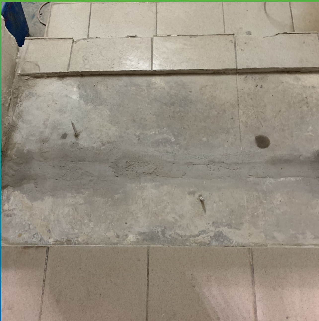
Шов, зачеканенный составом Стармекс Плаг
