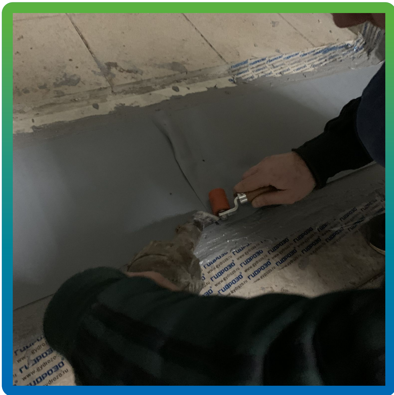
Сварка ленты и замыкание контура
