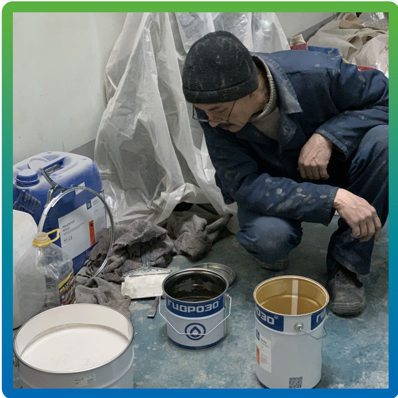
Подготовка Манопокс 331 для крепления ленты Манодил Про
