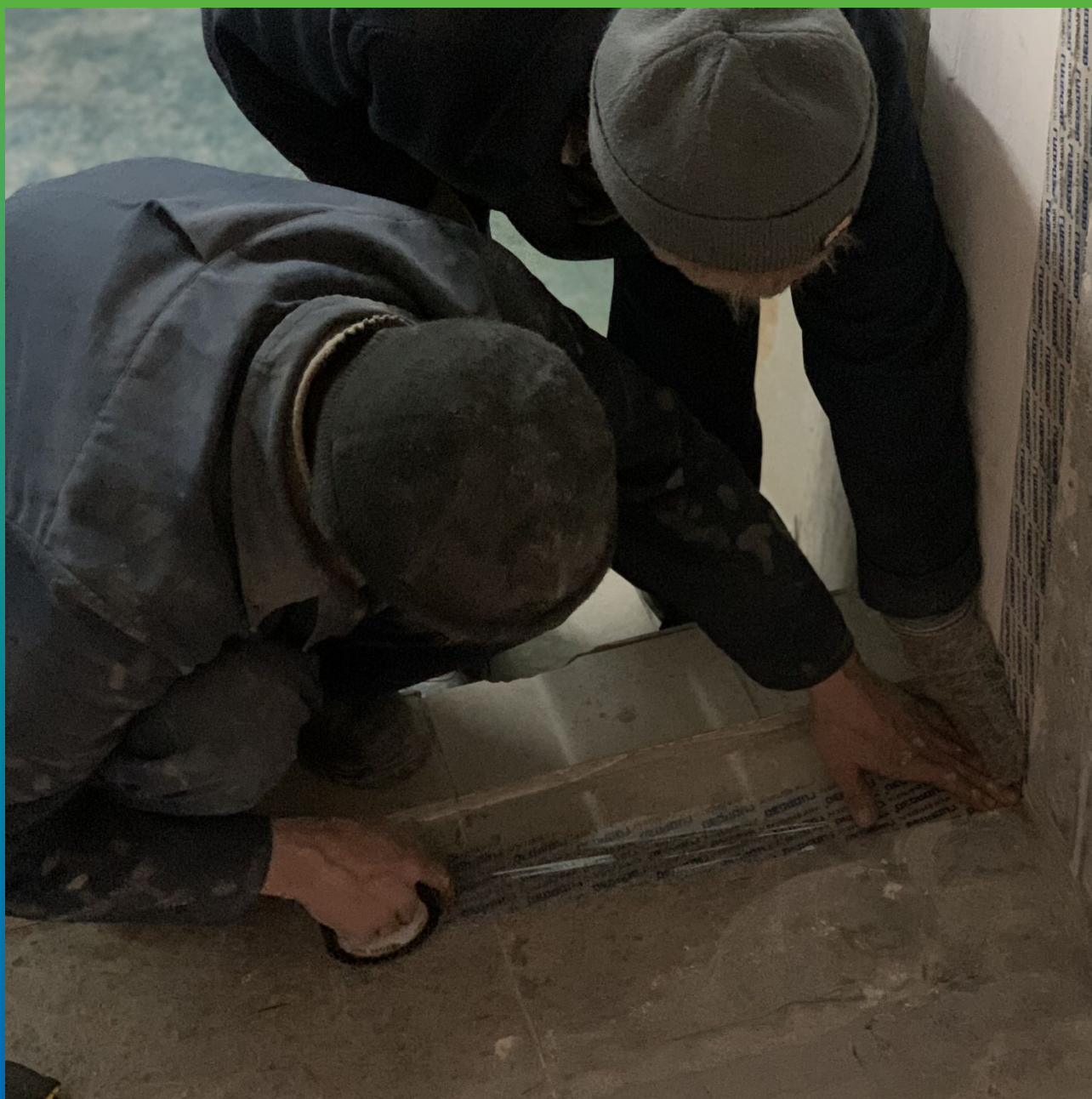
Приклеивание скотча для последующего монтажа Манодил Про
