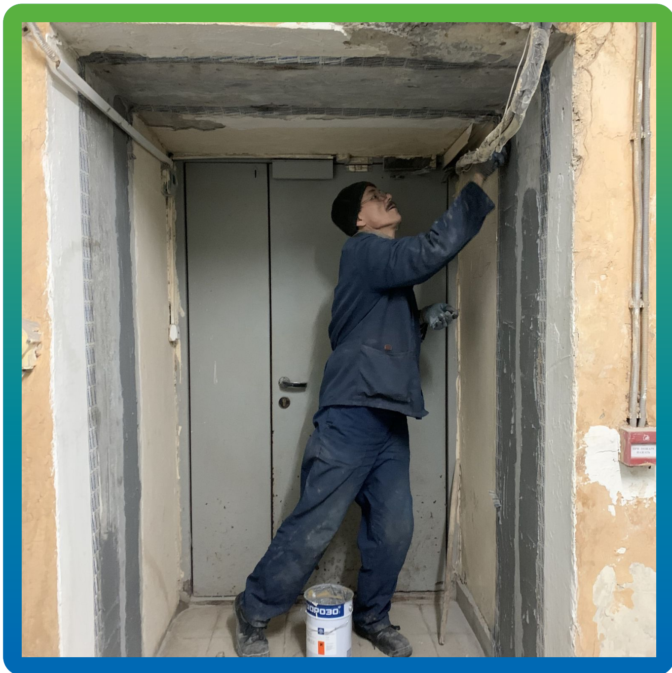
Нанесение Манопокс 331
