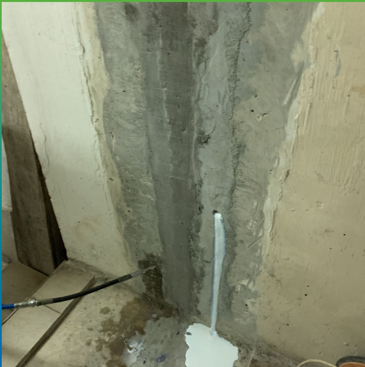
Инъектирование Манокрил Гель В+Манокрил Флекс Тикс
