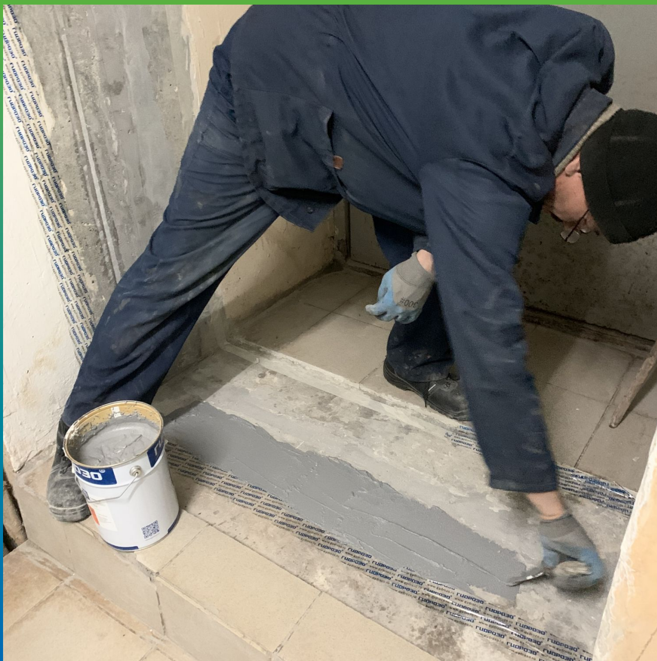
Нанесение Манопокс 331
