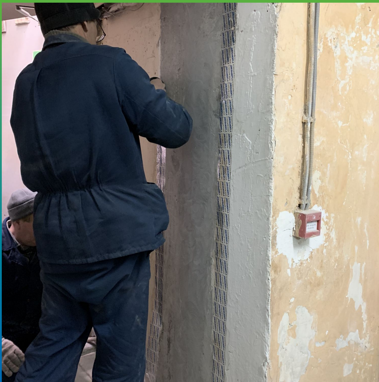
Приклеивание скотча для последующего монтажа Манодил Про
