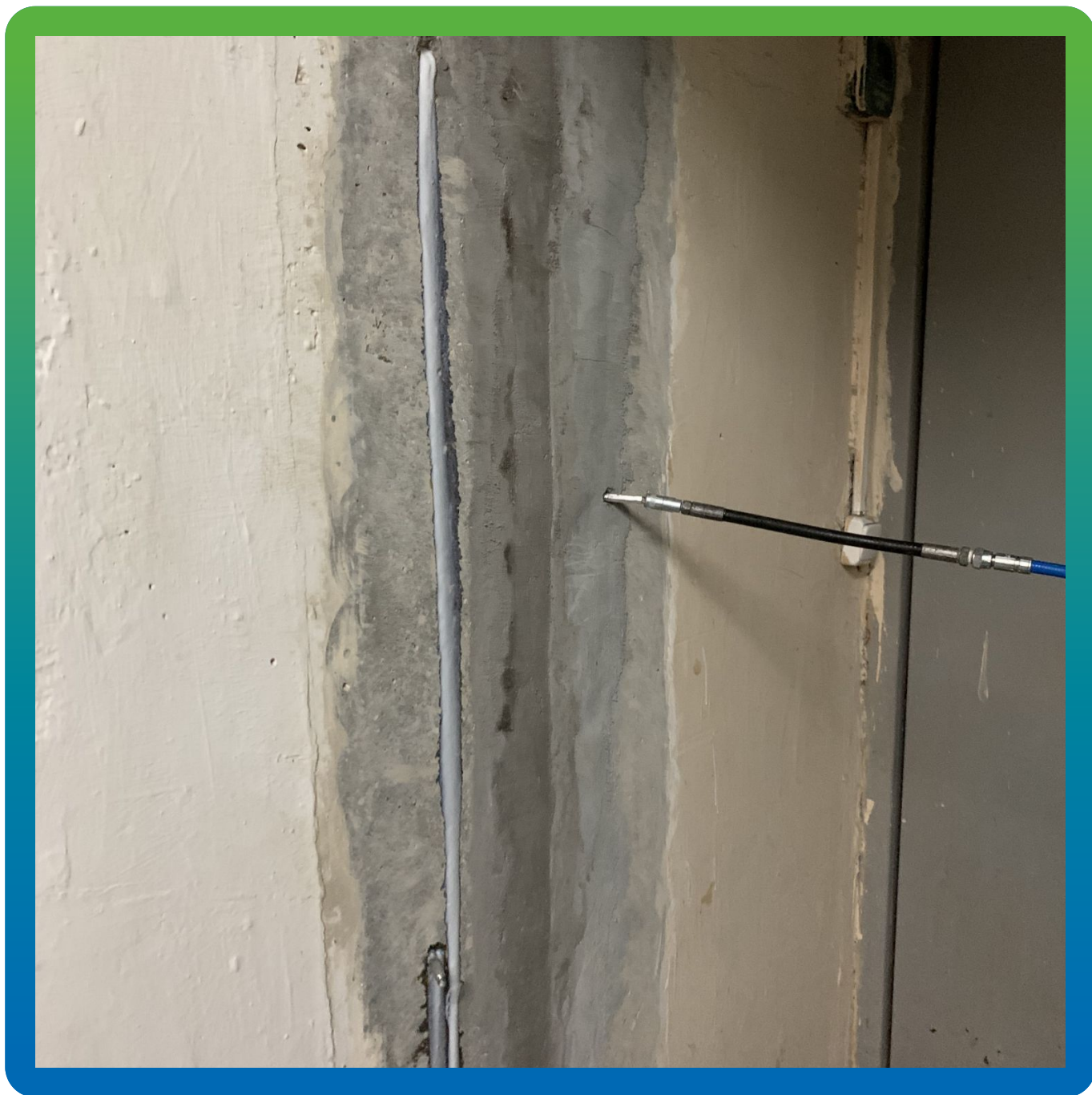
Инъектирование Манокрил Гель В+Манокрил Флекс Тикс
