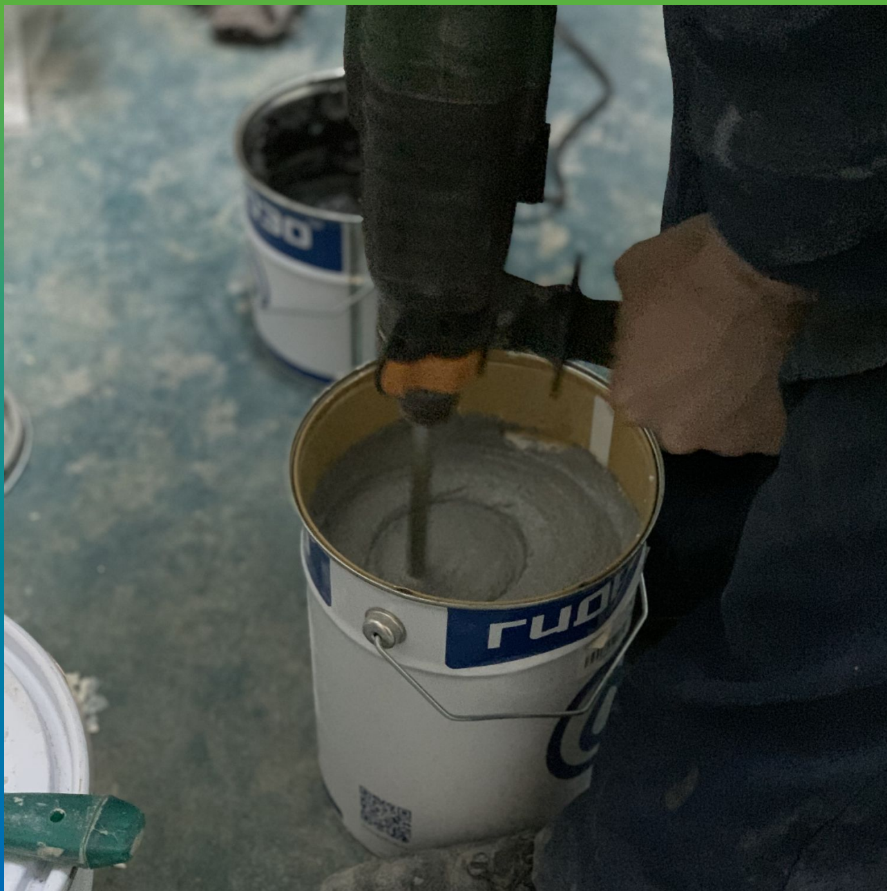
Подготовка Манопокс 331 для крепления ленты Манодил Про
