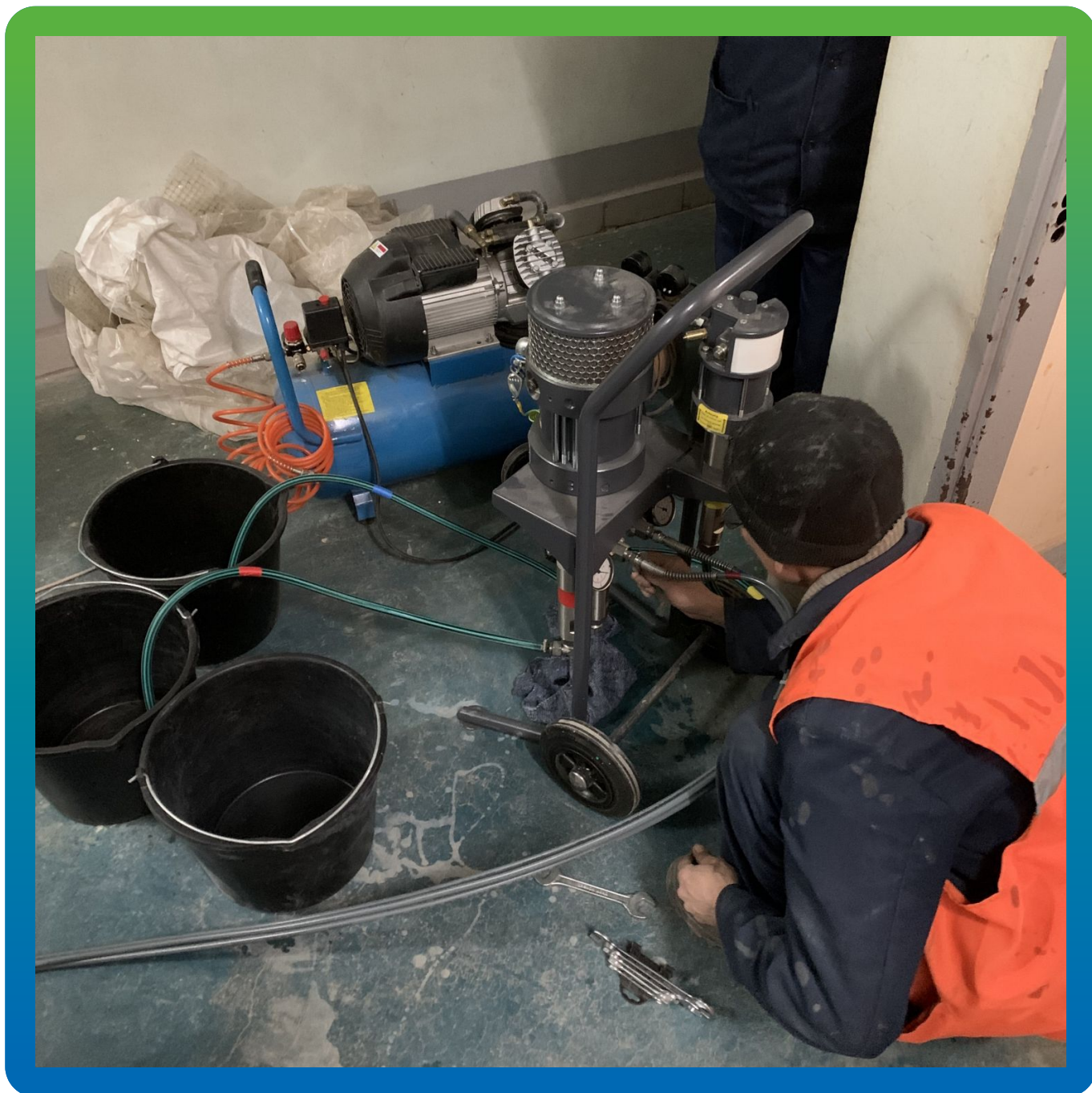
Подготовка насоса для инъектирования
