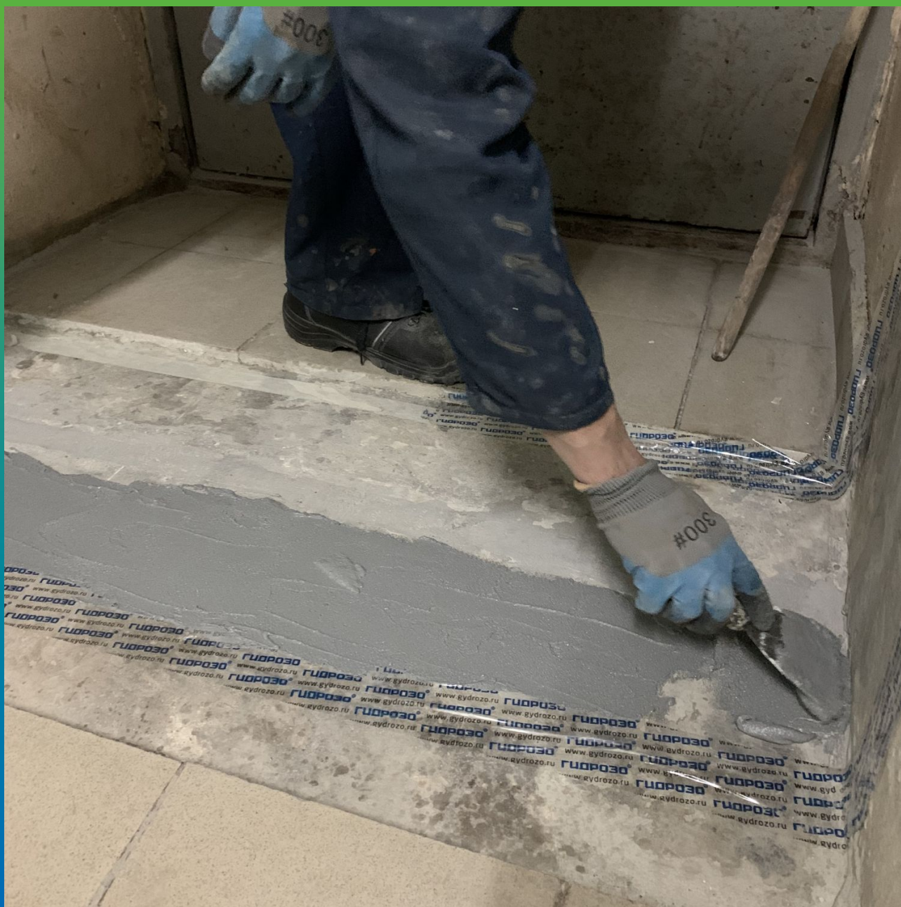
Нанесение Манопокс 331
