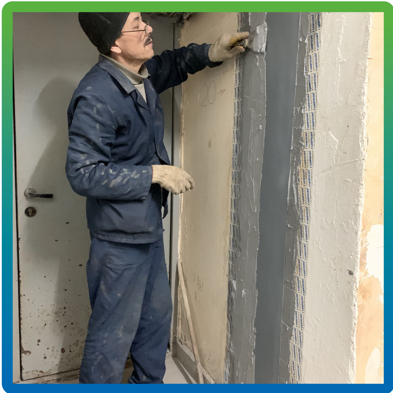
Нанесение запечатающего слоя Манопокс 331
