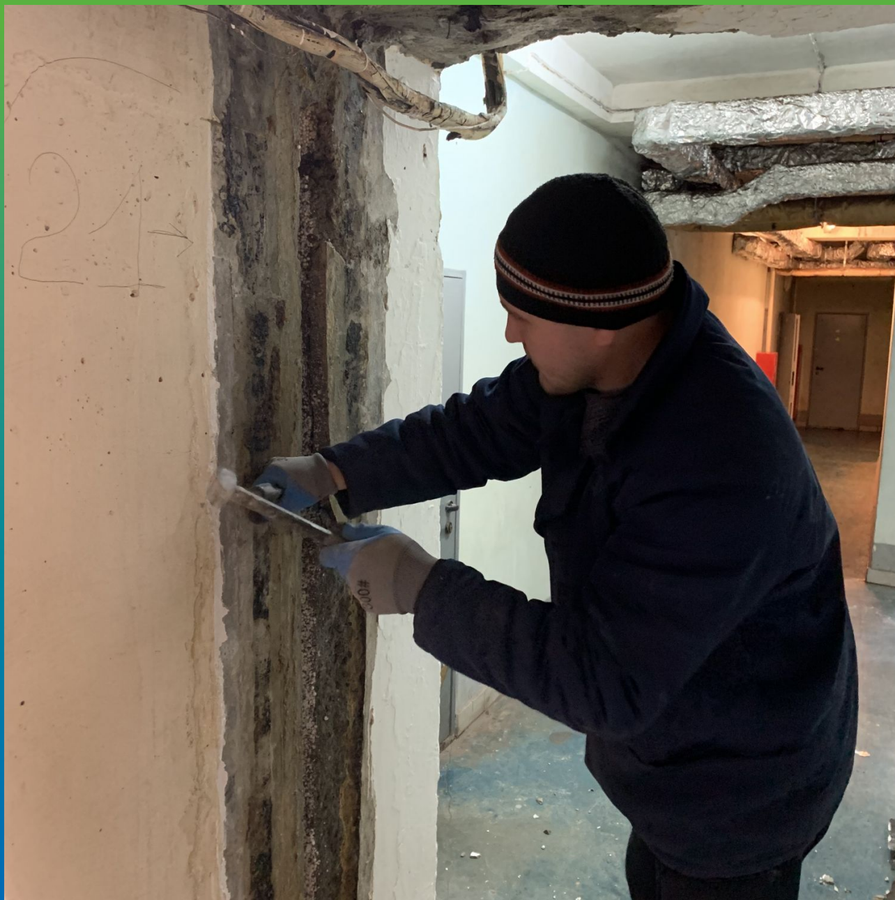
Демонтаж дефектных участков шва
