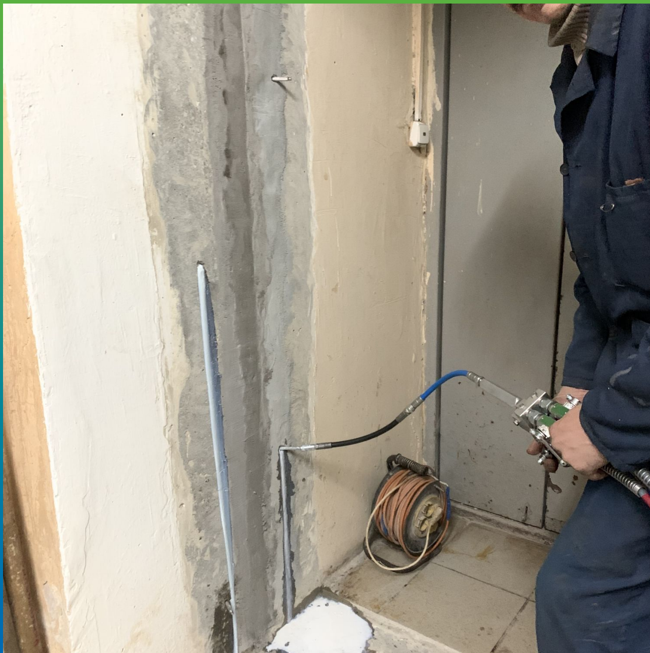
Инъектирование Манокрил Гель В+Манокрил Флекс Тикс
