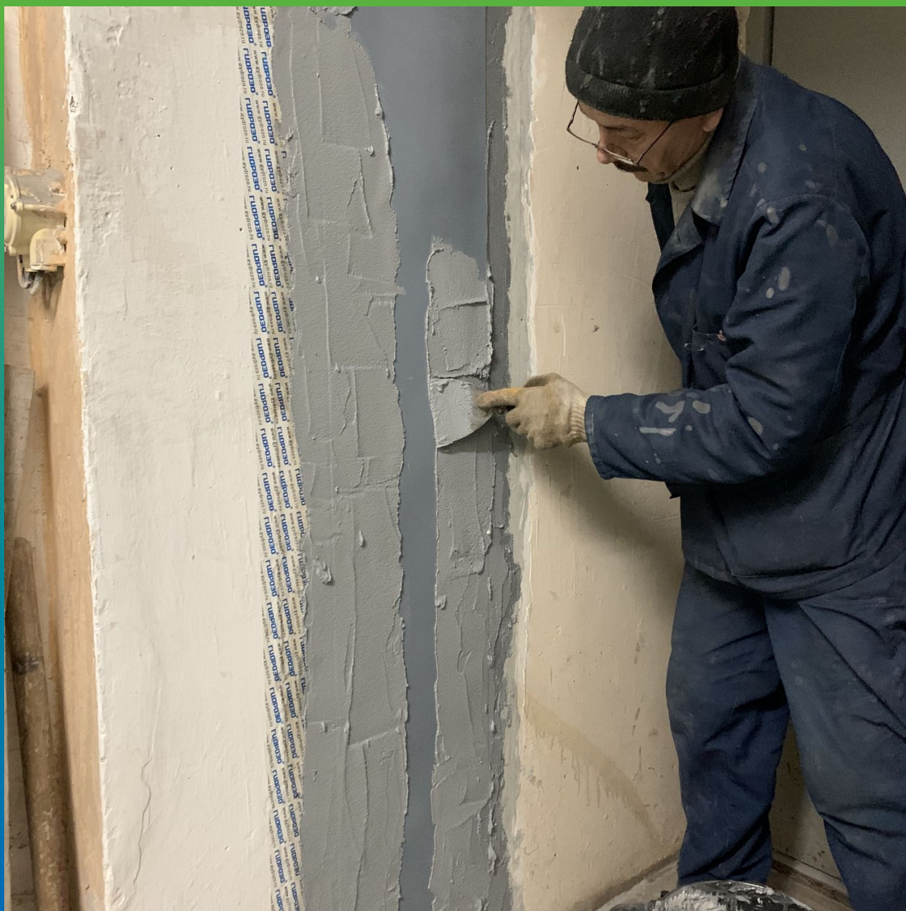
Нанесение запечатающего слоя Манопкс 331
