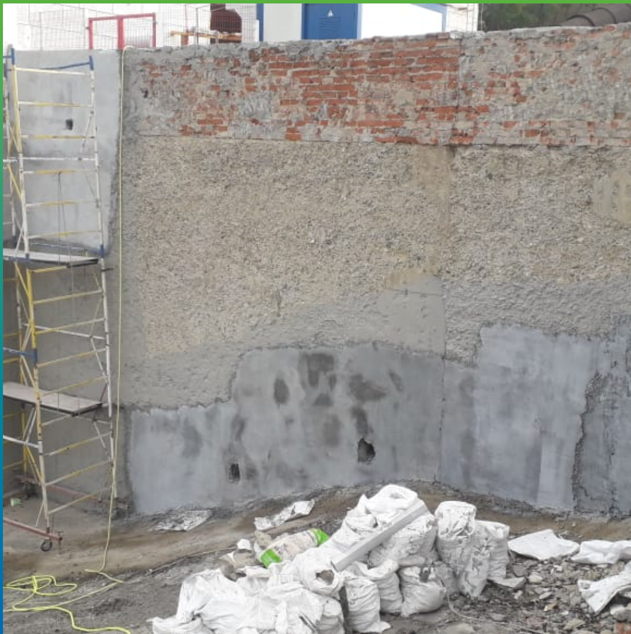
В процессе оштукатуривания стены ремонтным составом Стармекс РмЗ
