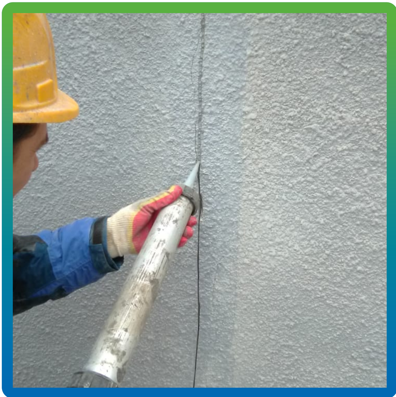
Герметизация шва составом Витрафин Бонд Х
