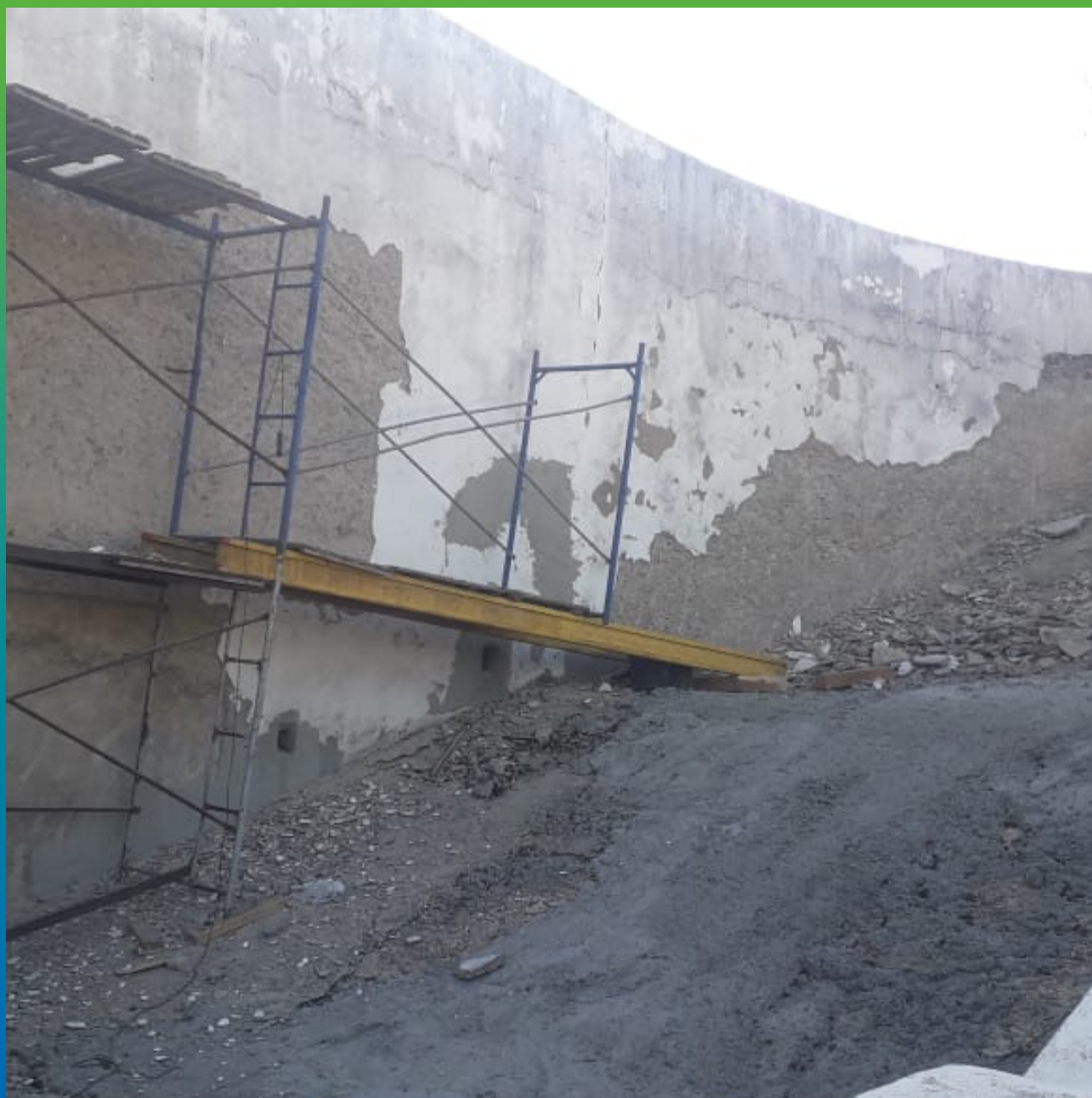
Вид подпорной стены до начала работ
