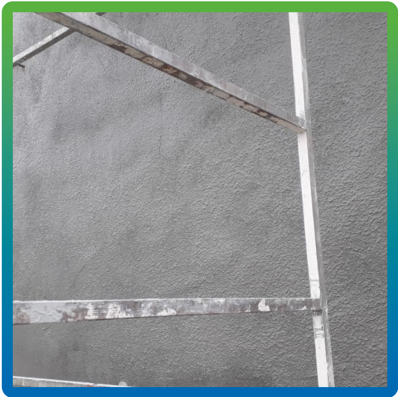
Отремонтированный участок подпорной стены
