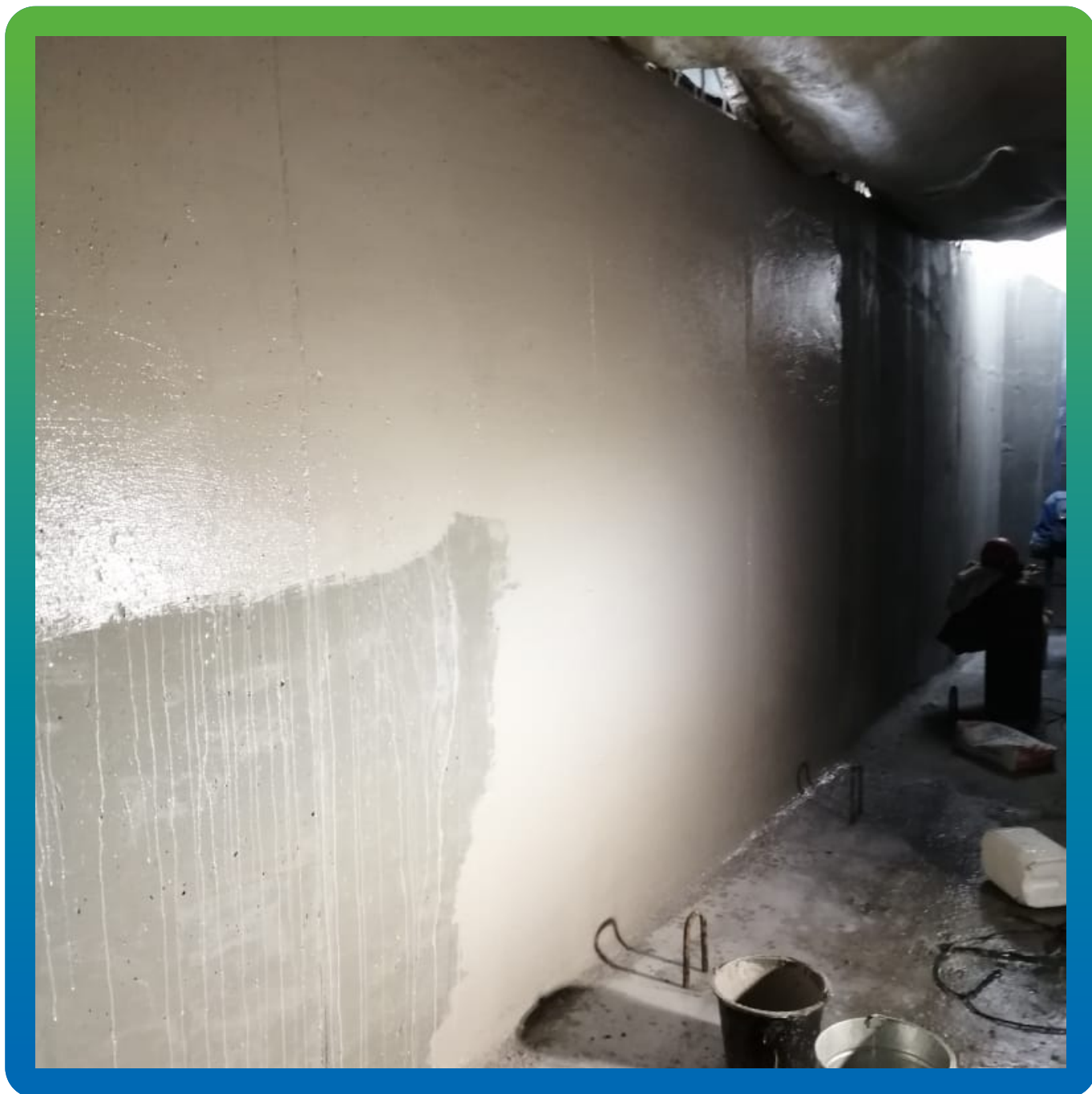
Стены резервуара с нанесенным покрытием Стармекс Сил Флекс
