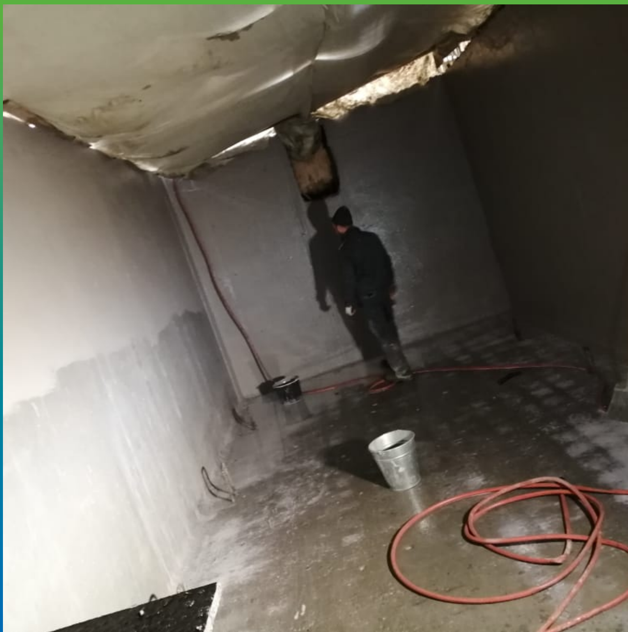
Замывка кислотой плиты пола с целью снятия бетонного молочка
