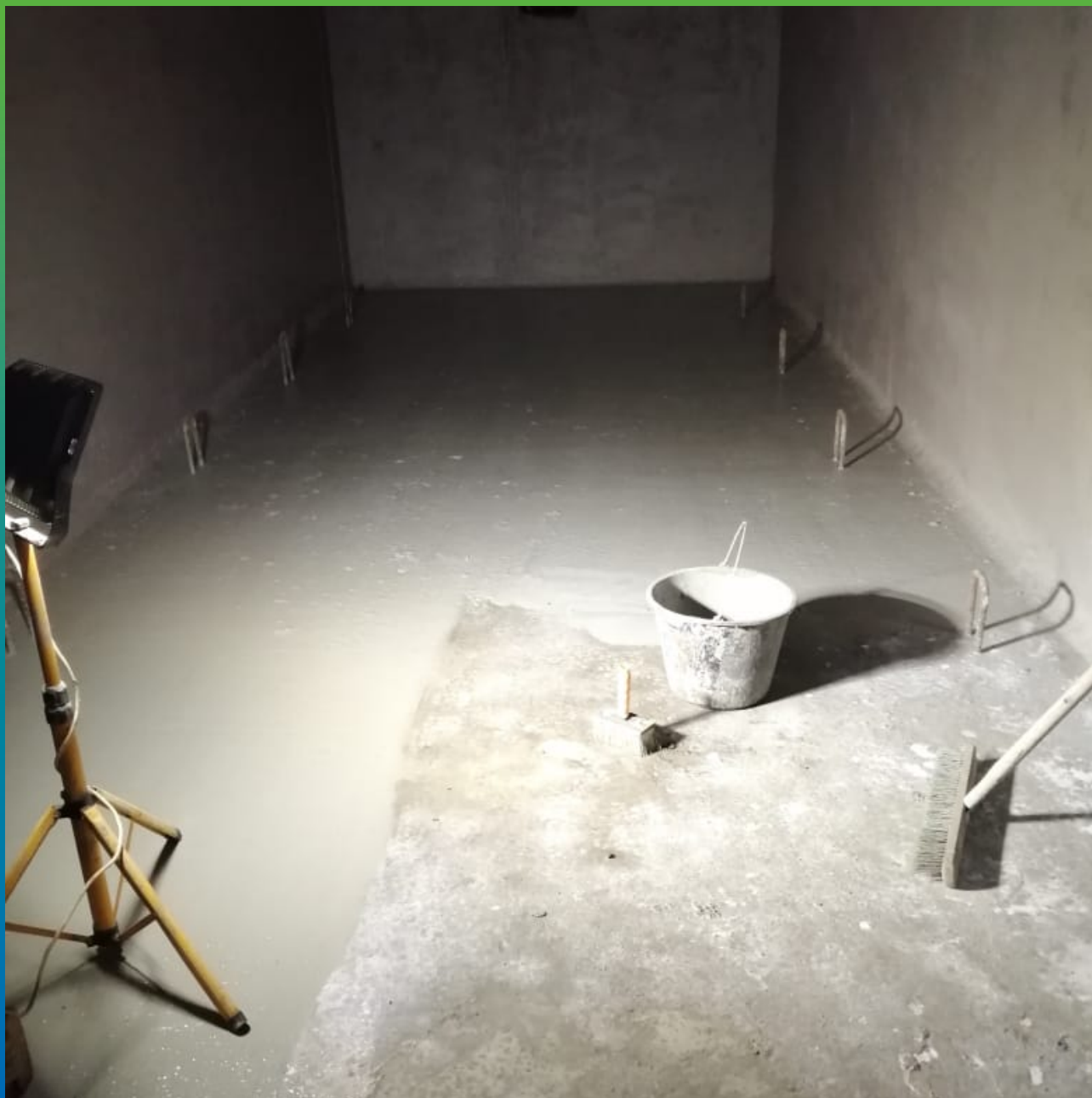
Покрытие плиты эластичной гидроизоляцией Стармекс Сил Флекс
