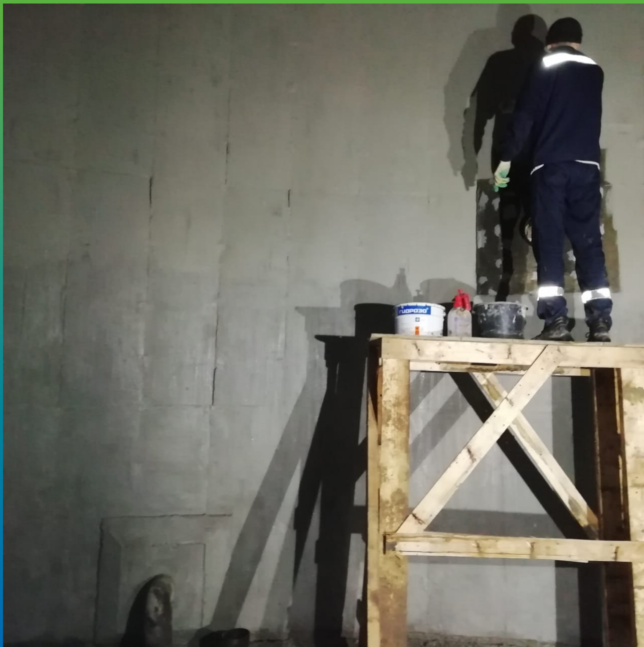
Завершение покрытия стен гидроизоляцией осмотического действия Стармекс Сил
