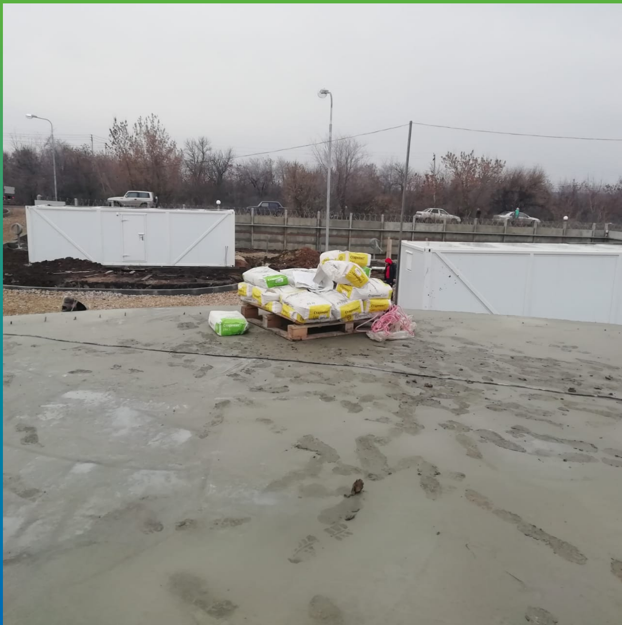
Материалы Гидрозо на объекте
