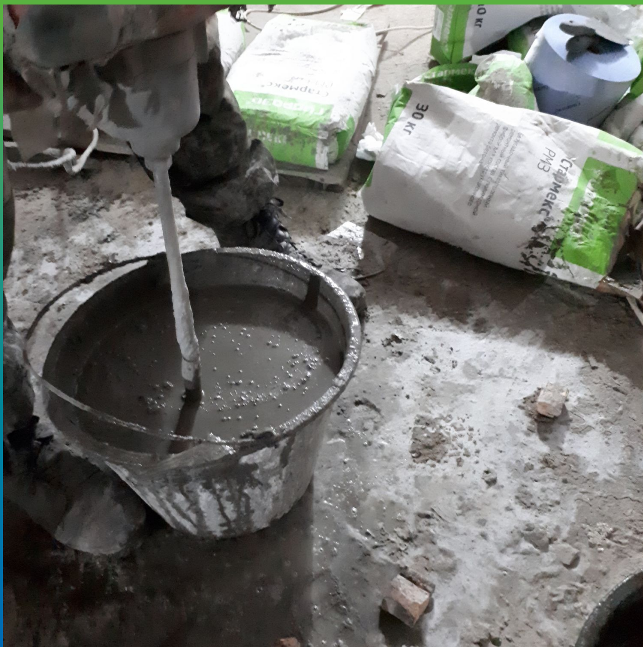
Приготовление ремонтного состава Стармекс РМЗ
