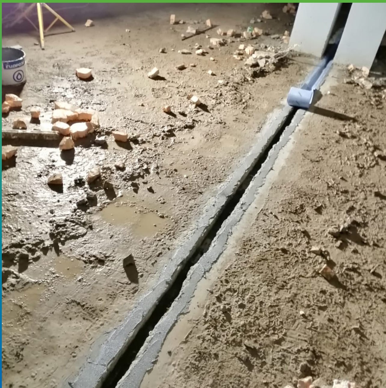
Процесс монтажа ленты Манодил Гео на клей Манопокс 331
