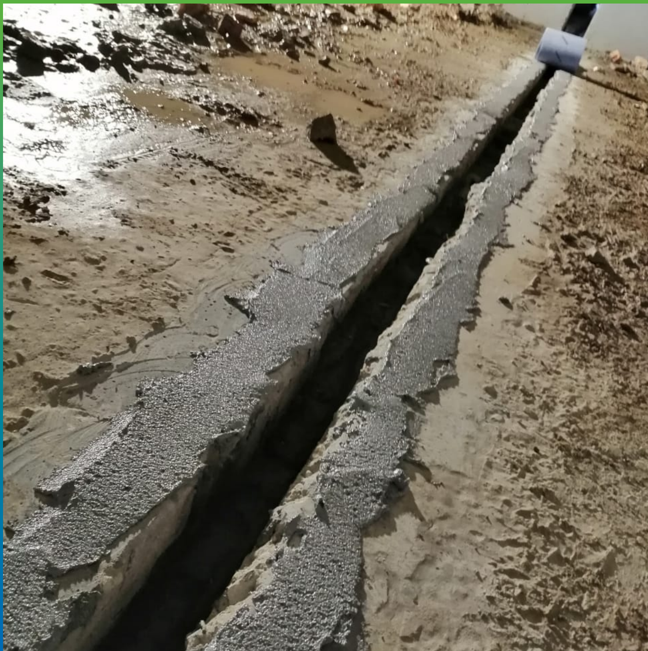
Нанесенный слой клея Манопокс 331 перед приклеиванием ленты
