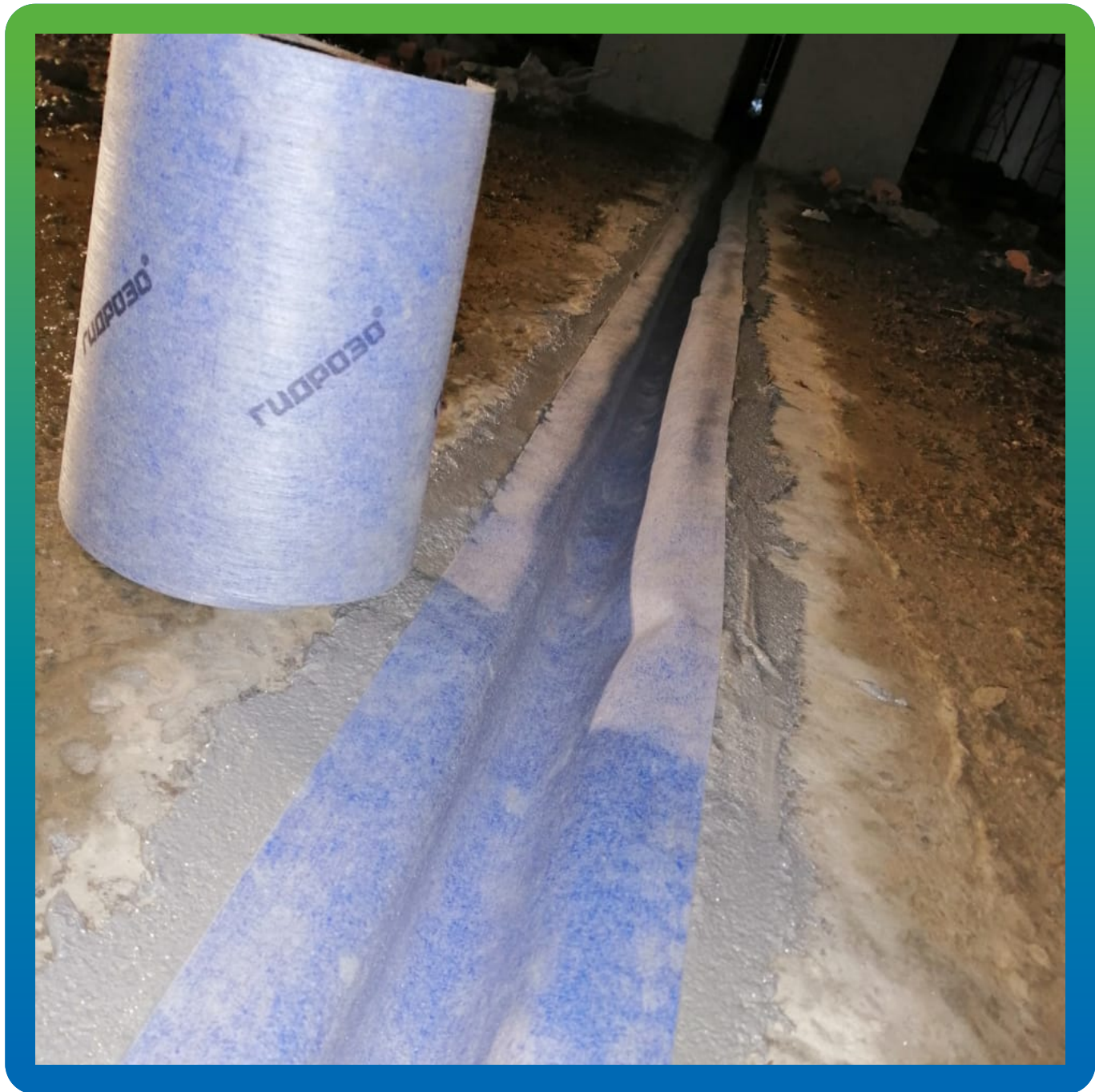
Деформационный шов, выполненный лентой Манодил Гео
