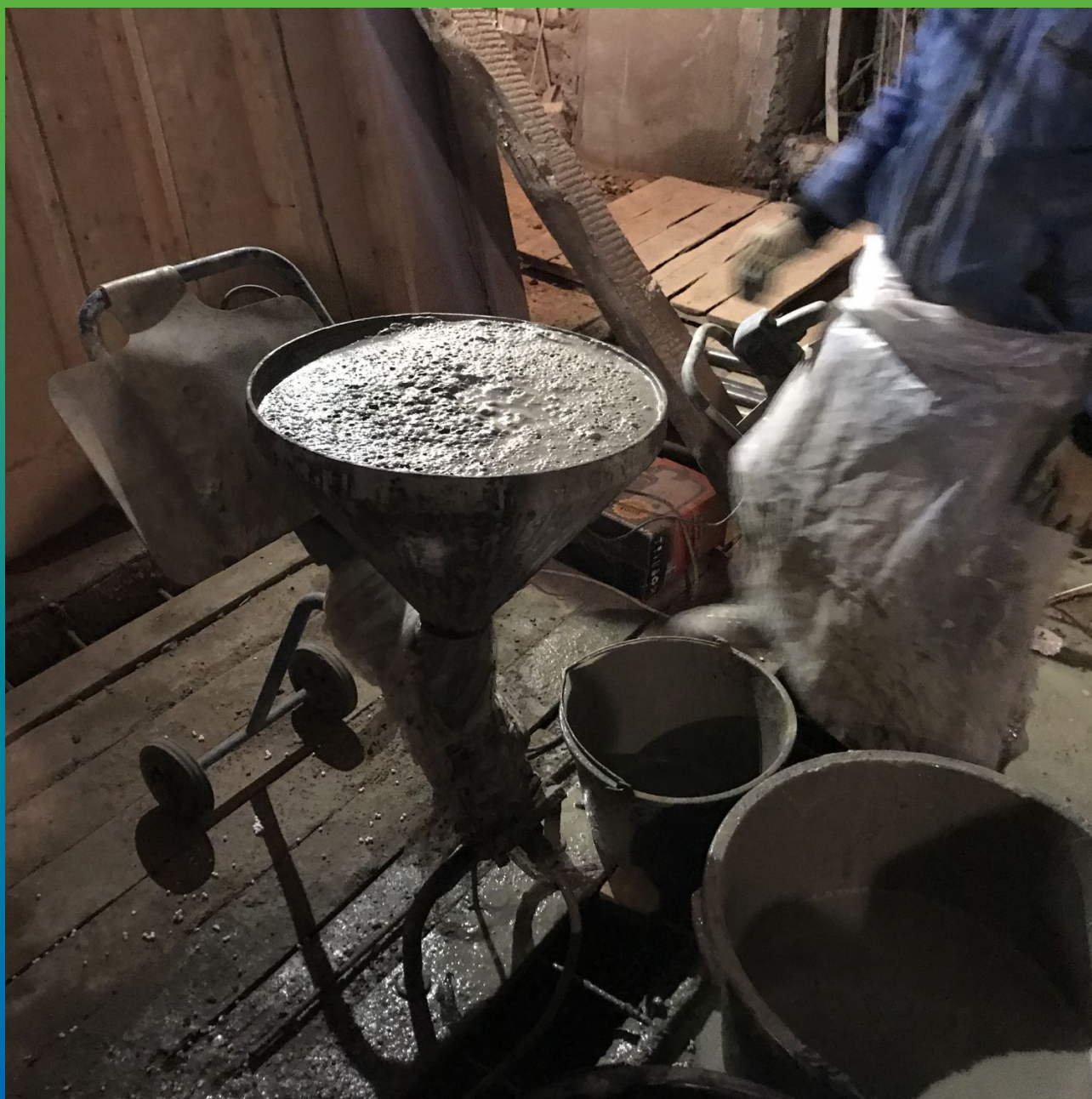
Подача состава Маноцем Файн через шнековый насос
