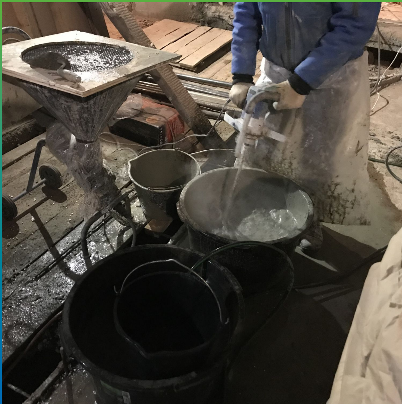
Замешивание микроцементного инъекционного состава Маноцем Файн
