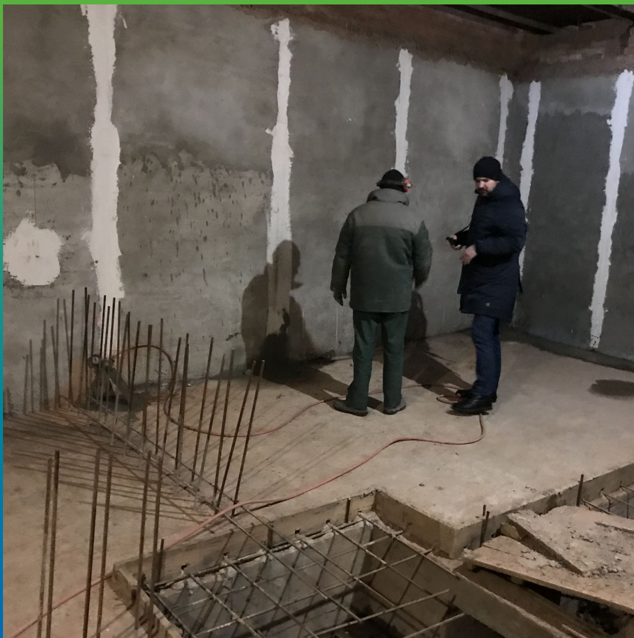
Подача состава Маноцем Файн в конструкцию
