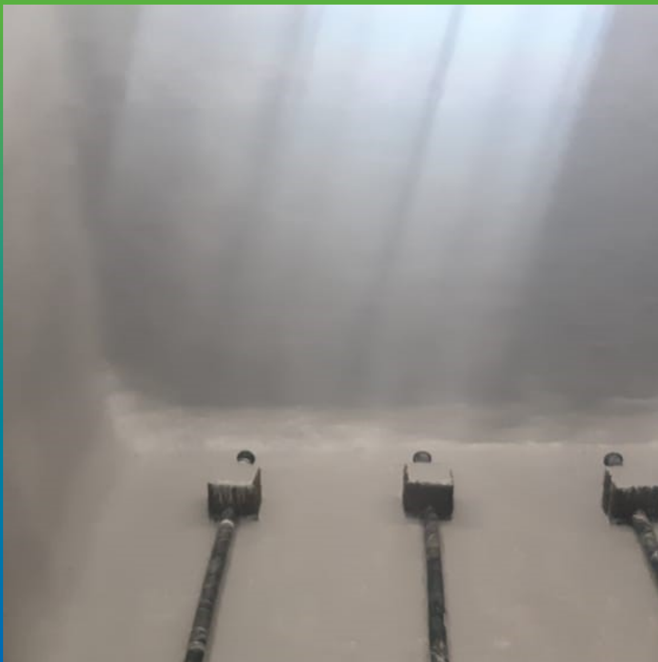
Резервуар, покрытый составом ДенсТоп ЭП 201 в 2 слоя.
