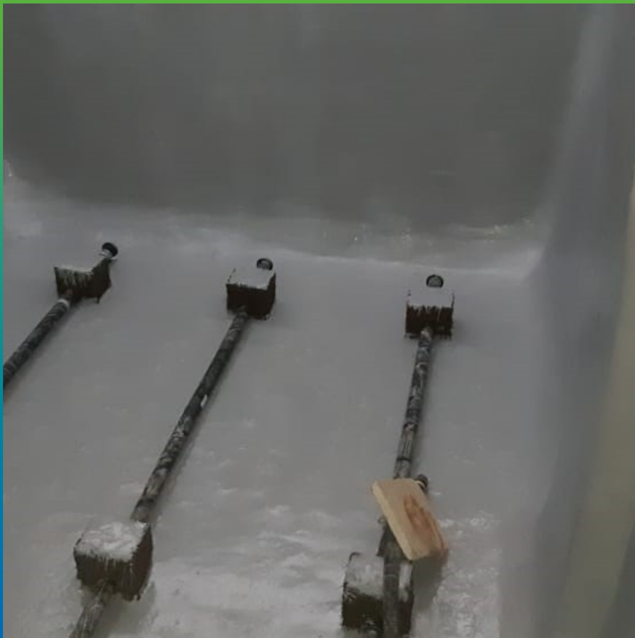
Покрытие резервуара 1 слой.
