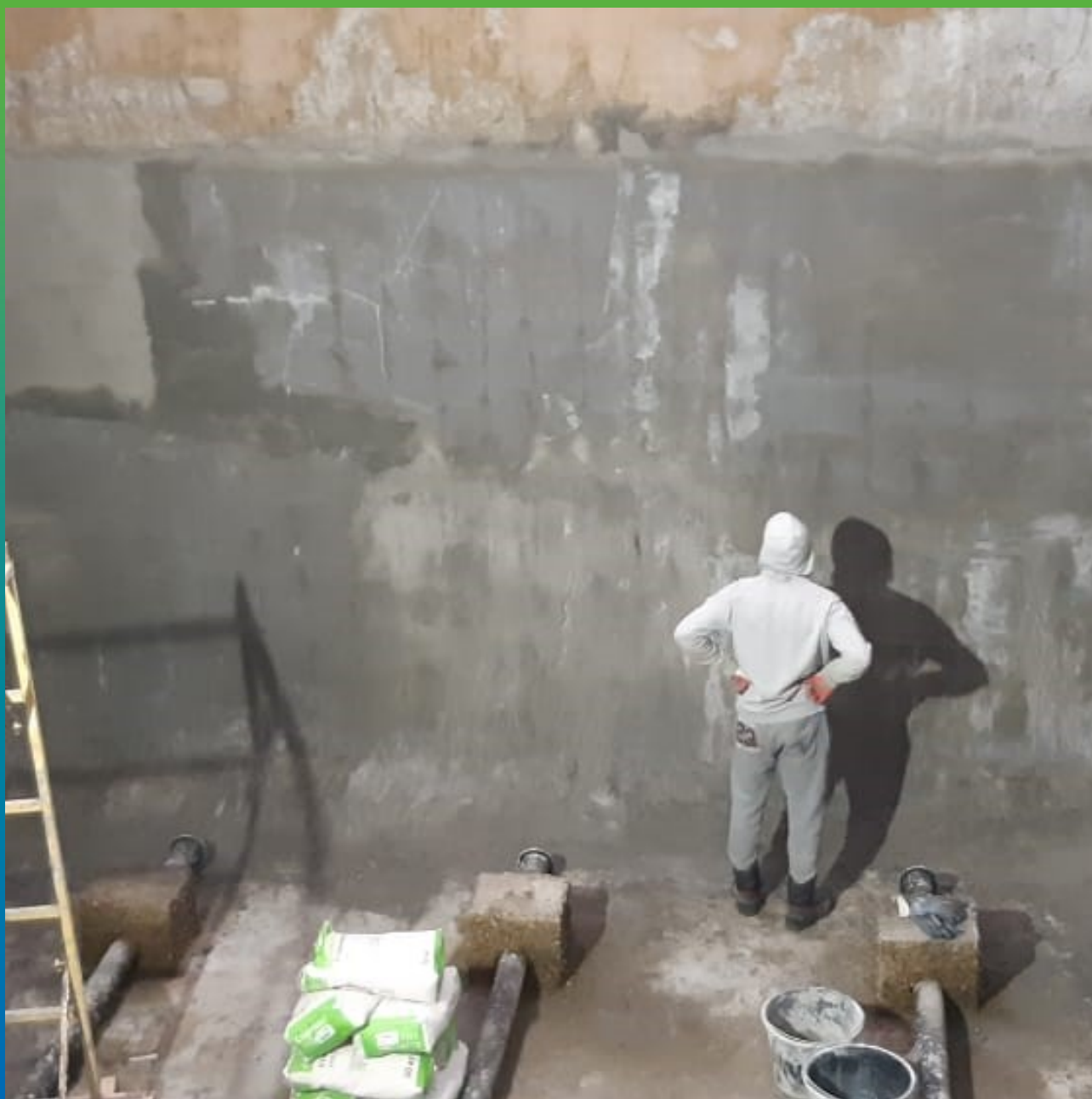
Подготовка основания, ремонт бетона тиксотропным составом Стармекс РМЗ
