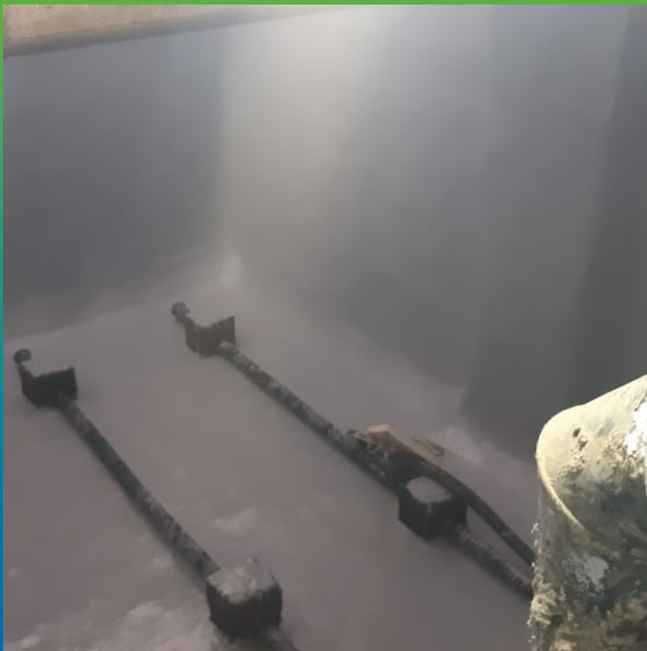
Покрытие резервуара 1 слой.
