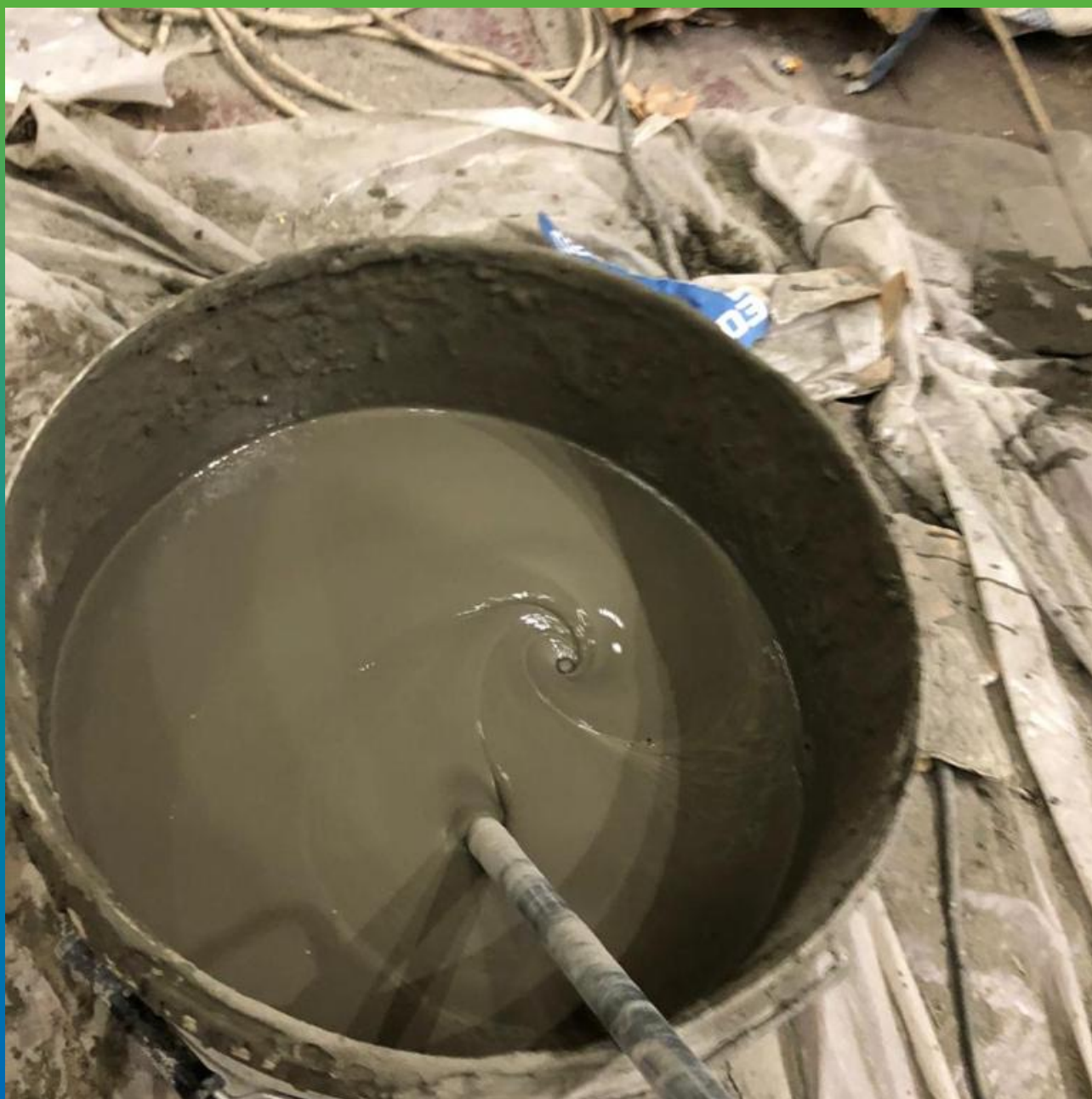
Замешивание состава для инъектирования Маноцем Гроут.
