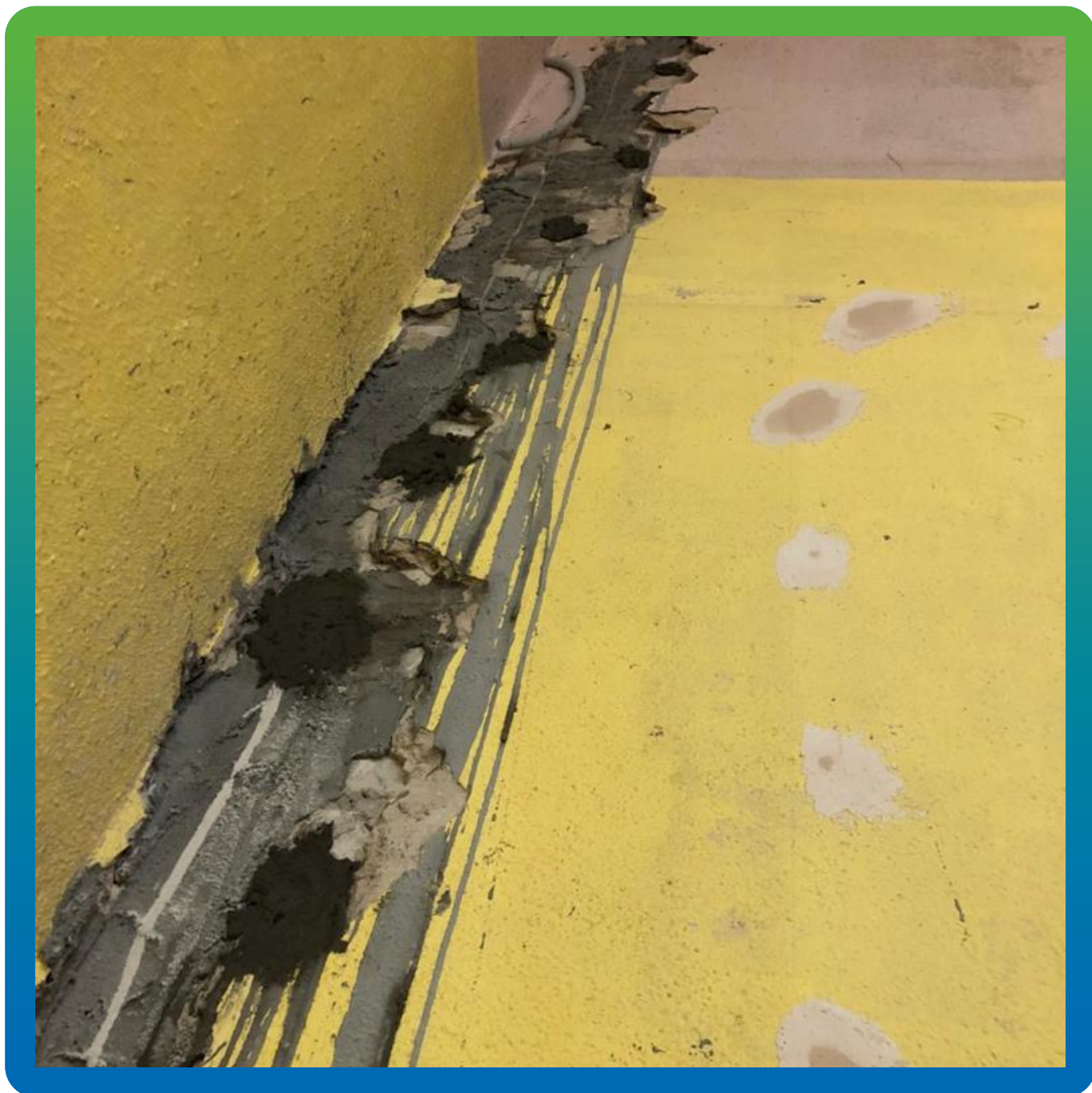
Процесс заполнения пустот в стене здания.
