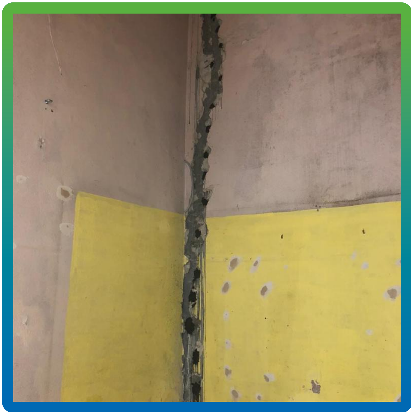
Стена, готовая к дальнейшим отделочным работам.
