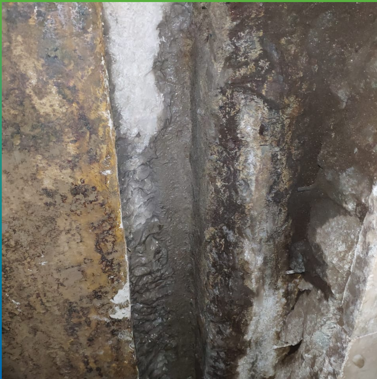
Шов готовый к зачеканке перед прокачкой.
