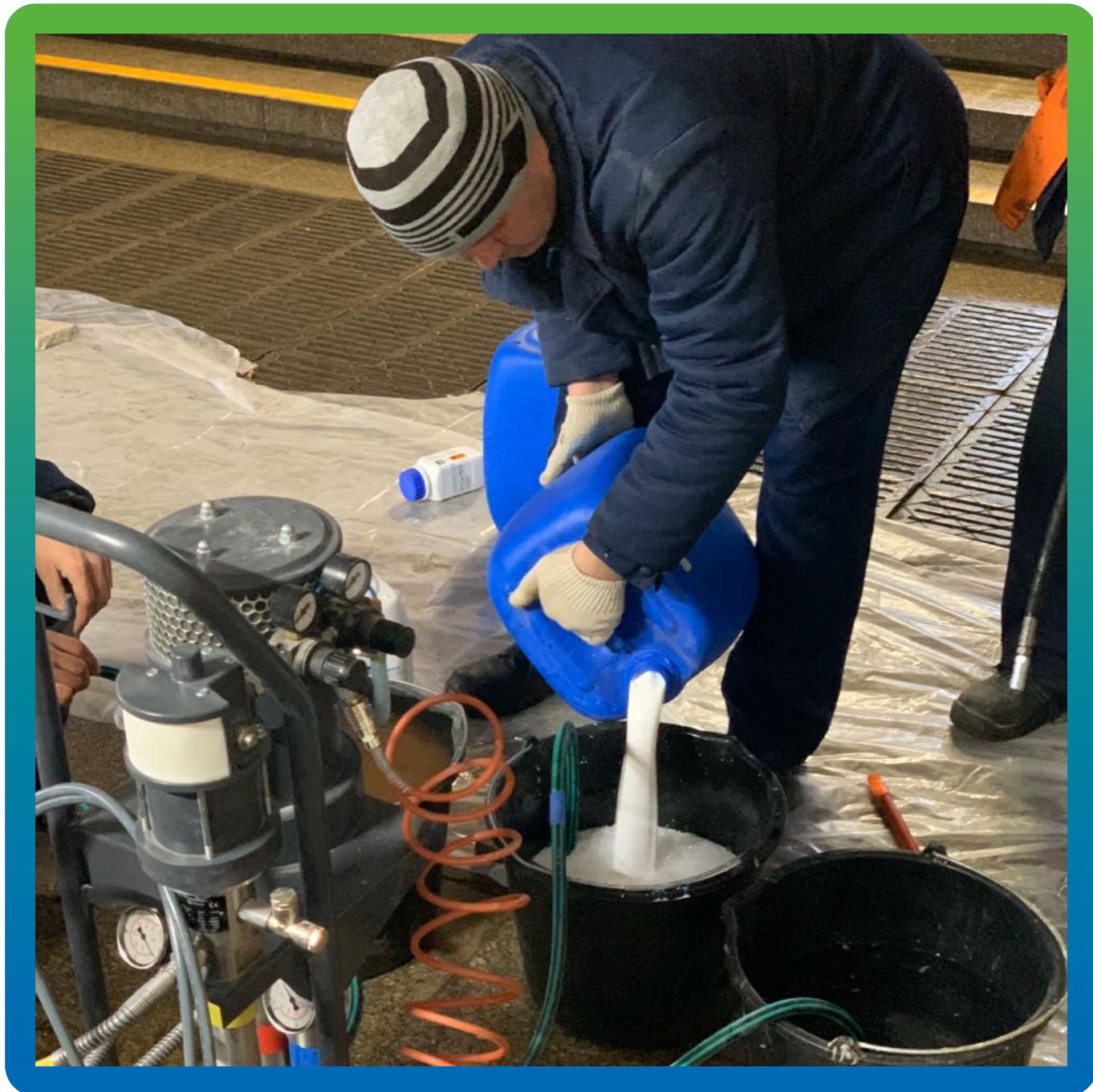
Подготовка материалов и оборудования к проведению инъекционных работ.
