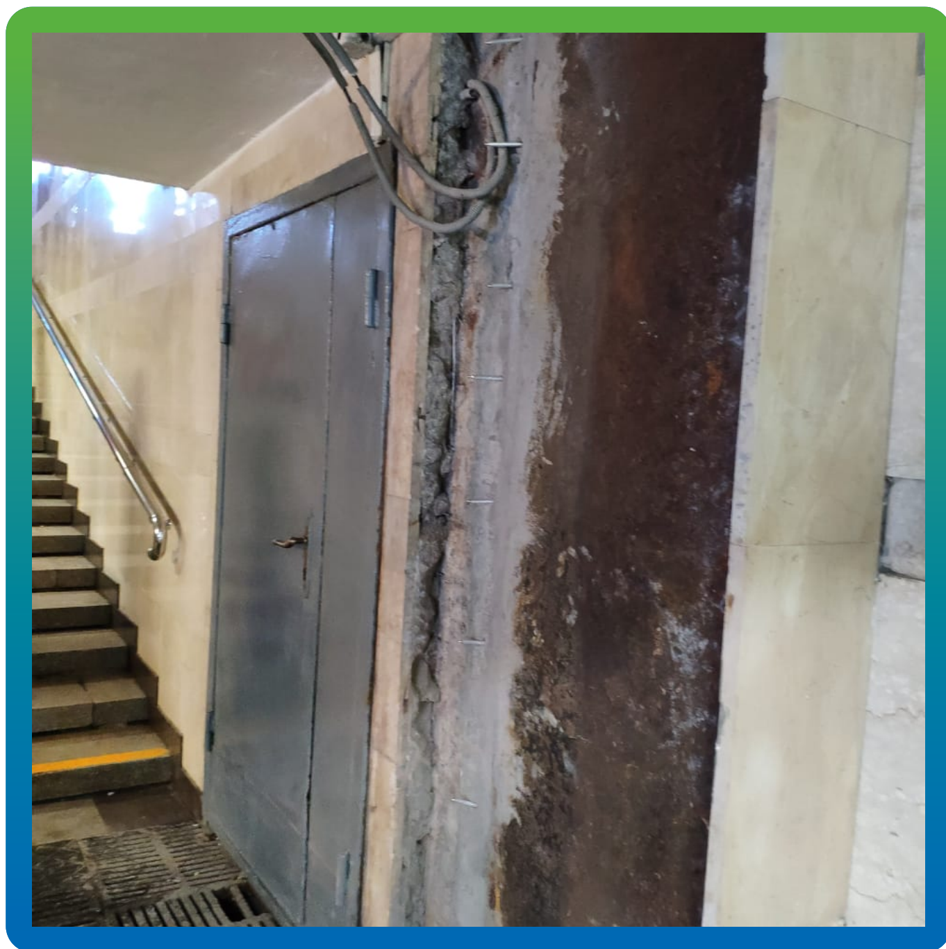
Установка инъекционных пакеров.
