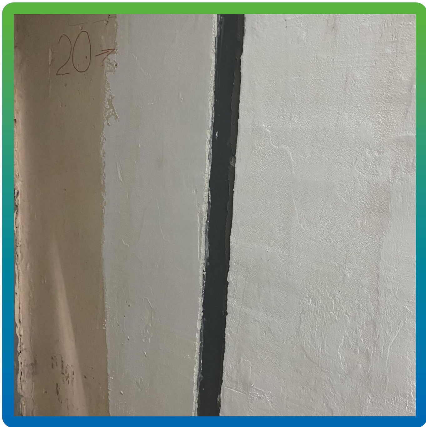
Гидроизолированный шов, со штукатурной отделкой по ленте Манодил Про.
