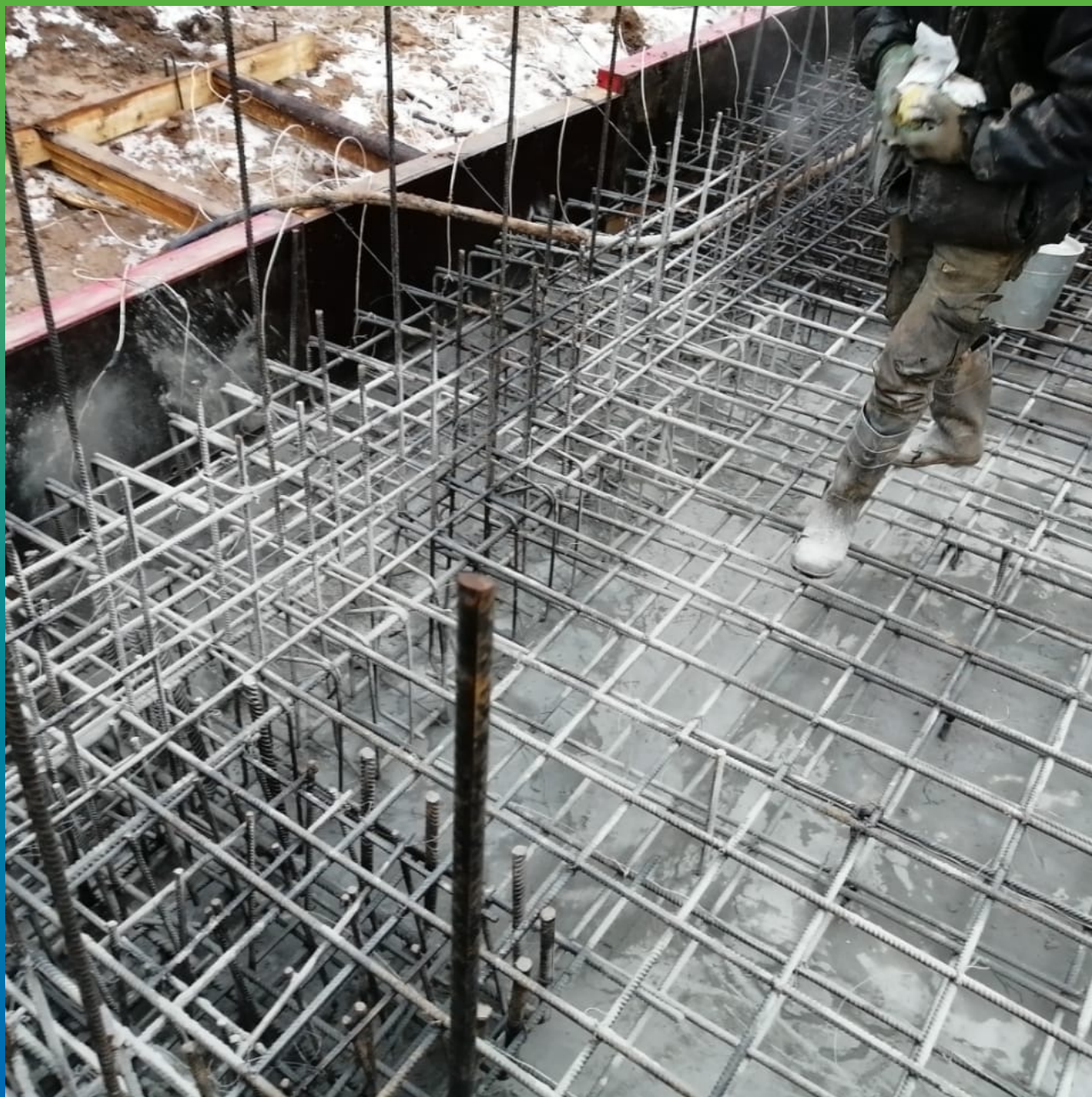
Распределение материала по фундаментной плите
