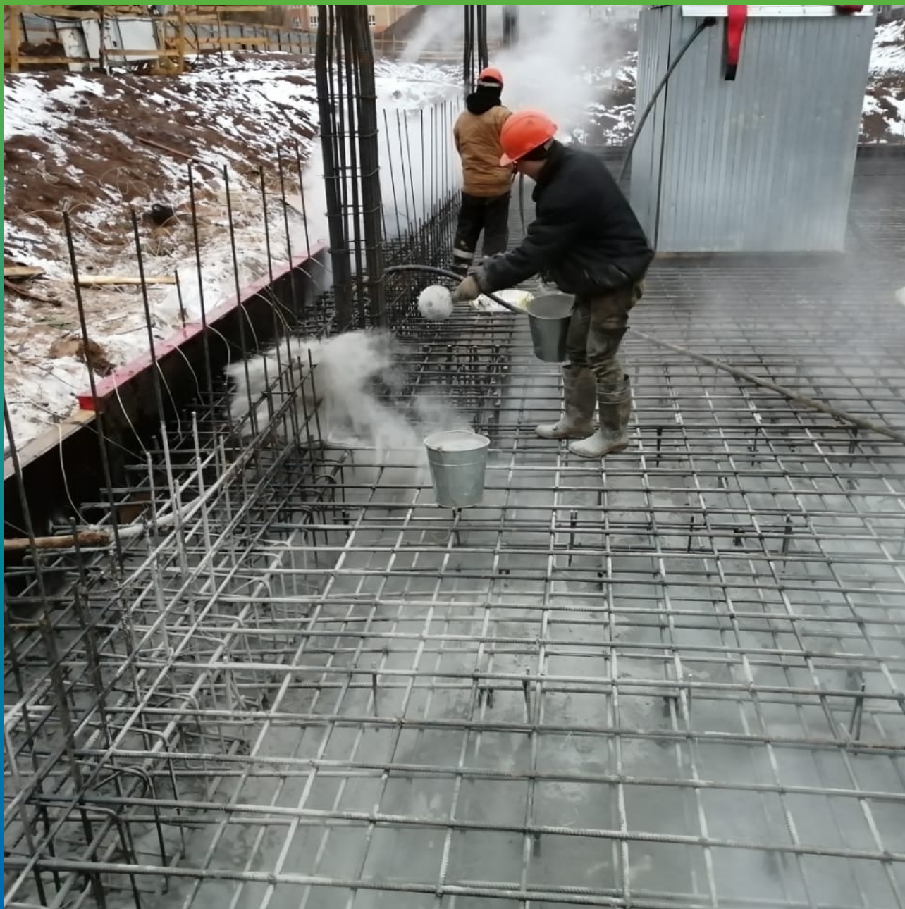
Распределение материала по фундаментной плите
