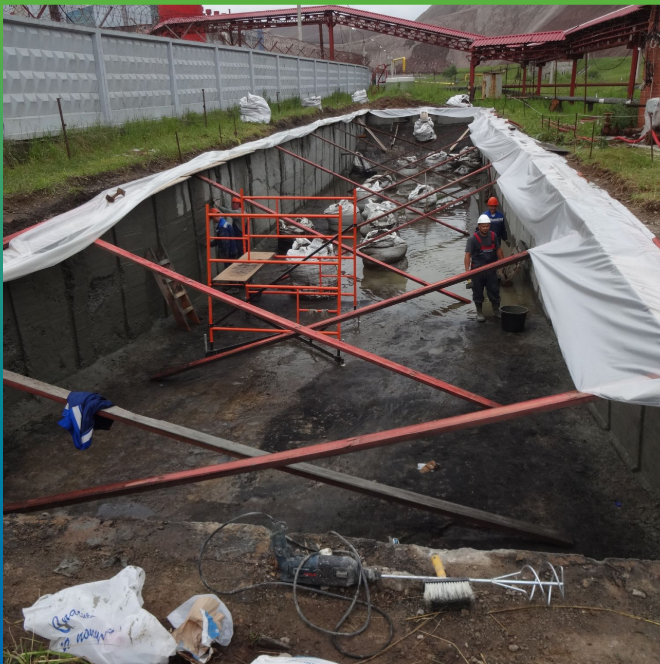
Резервуар сточных вод, гидроструйная очистка
