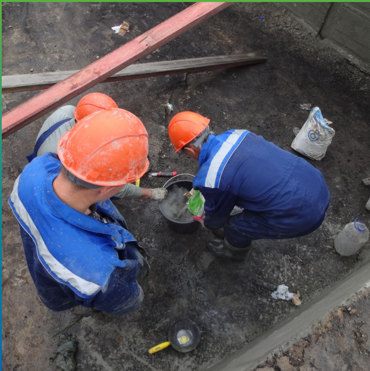
Затворение с водой ремонтного состава Стармекс РМЗ
