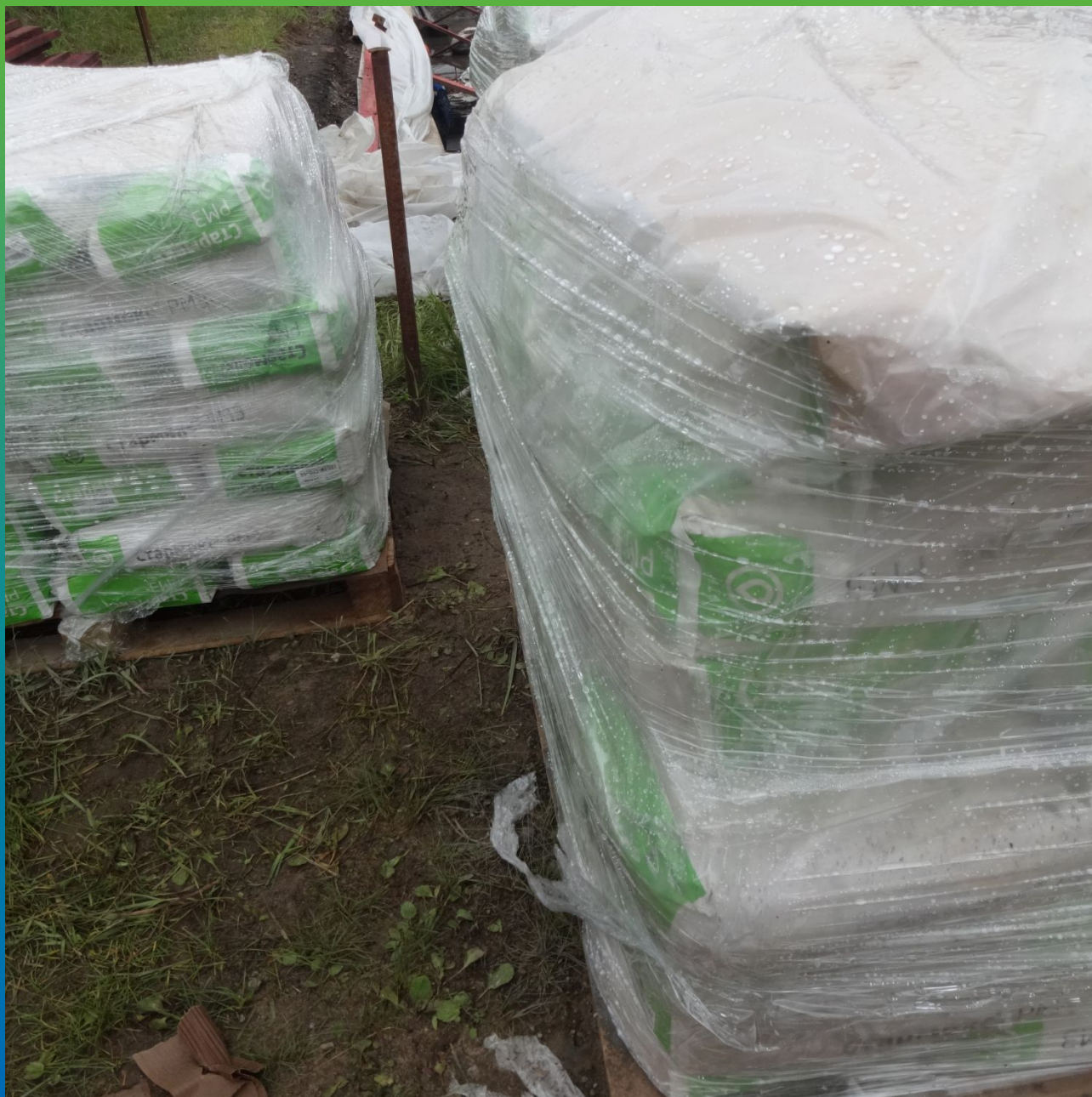
Материалы Гидрозо на объекте
