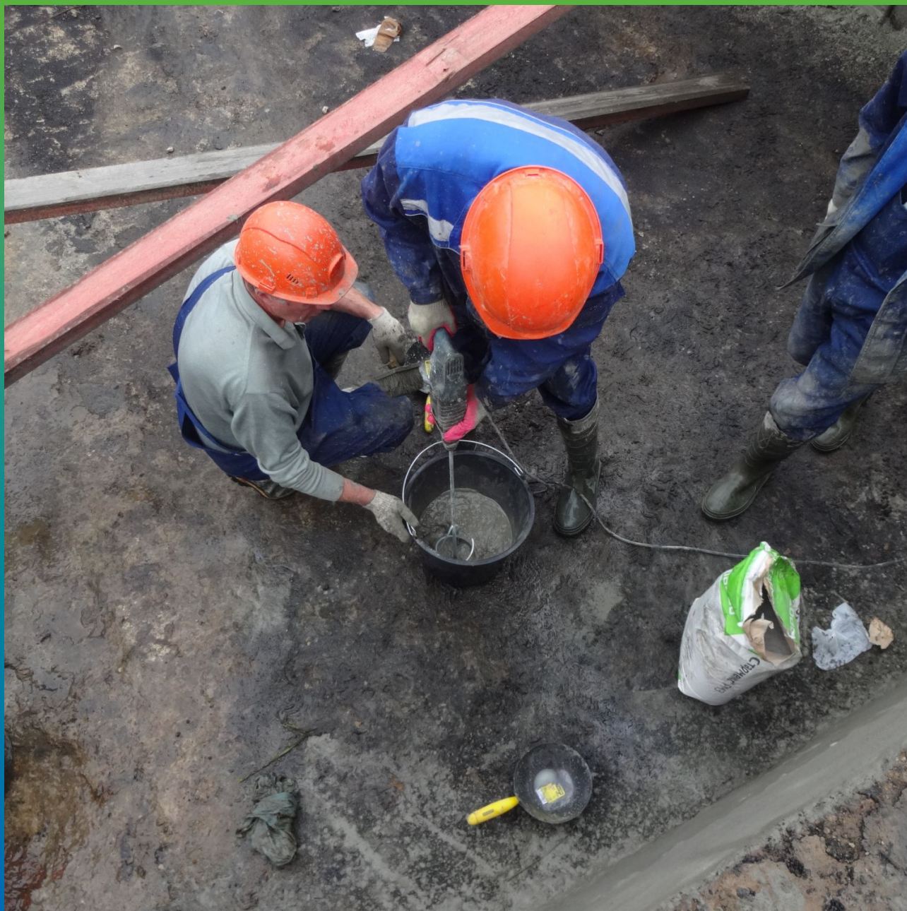
Затворение с водой ремонтного состава Стармекс РМЗ
