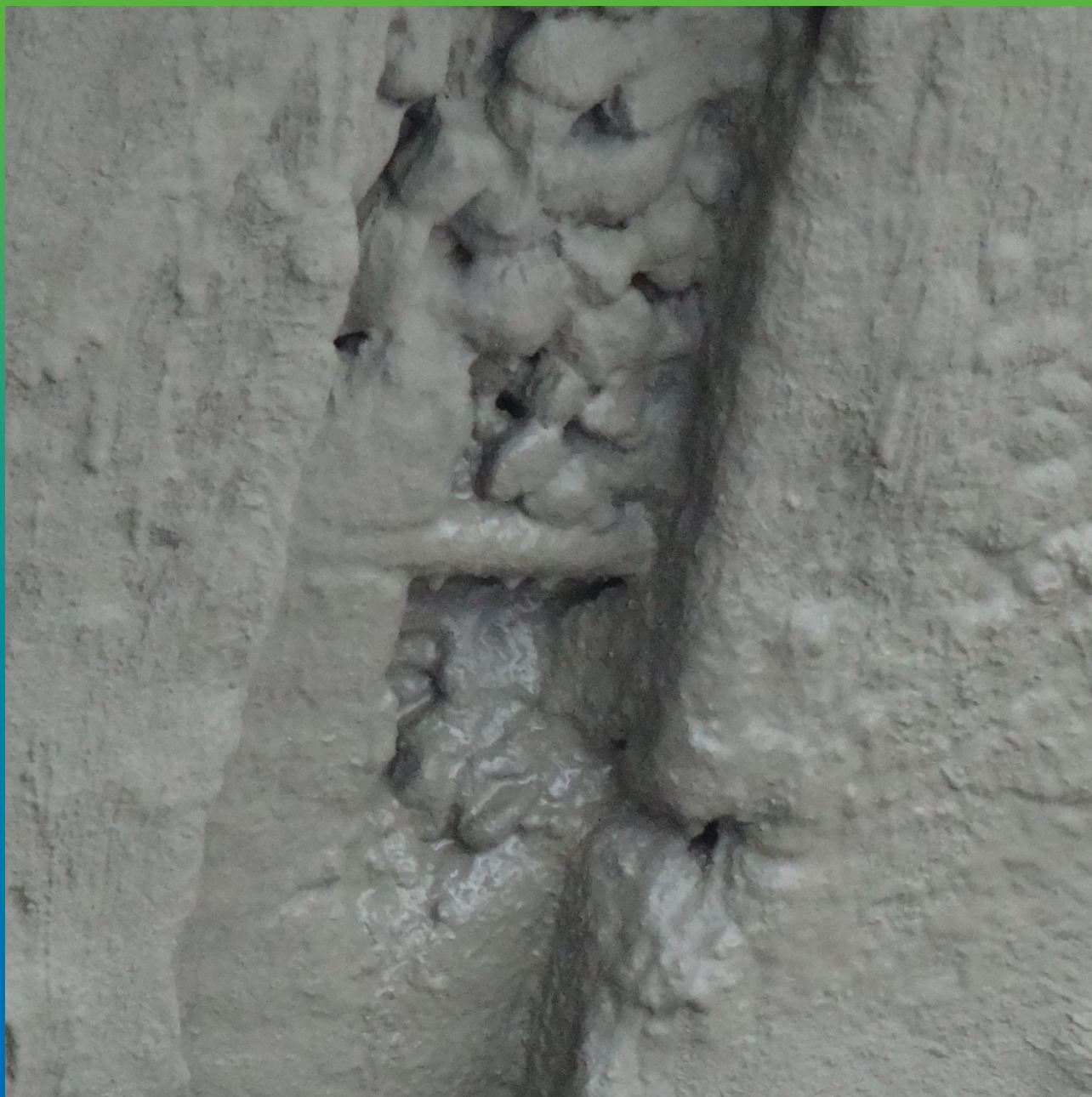
Нанесение Стармекс МКП на металлические элементы резервуара
