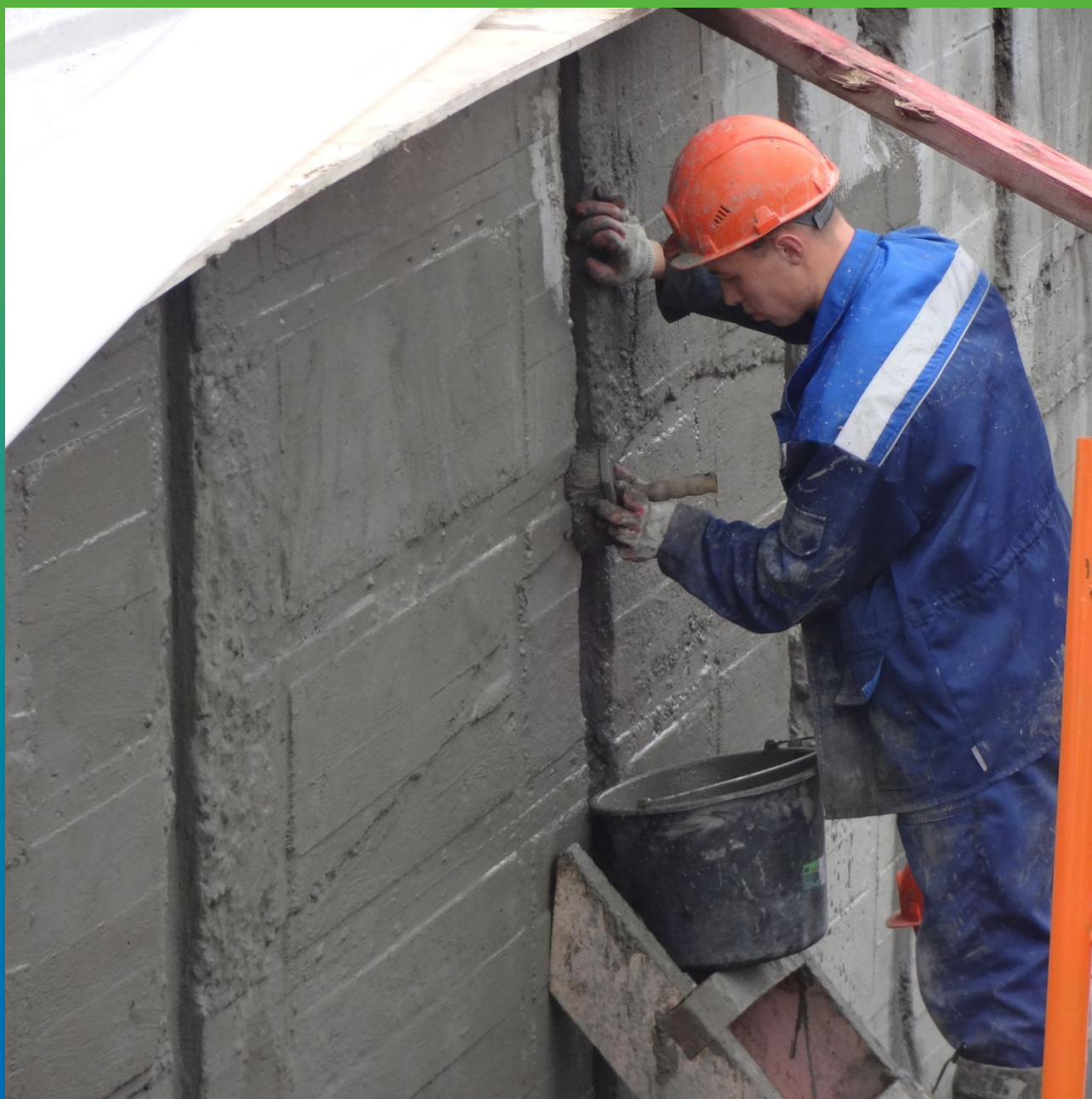
Нанесение Стармекс МКП на всю площадь резервуара
