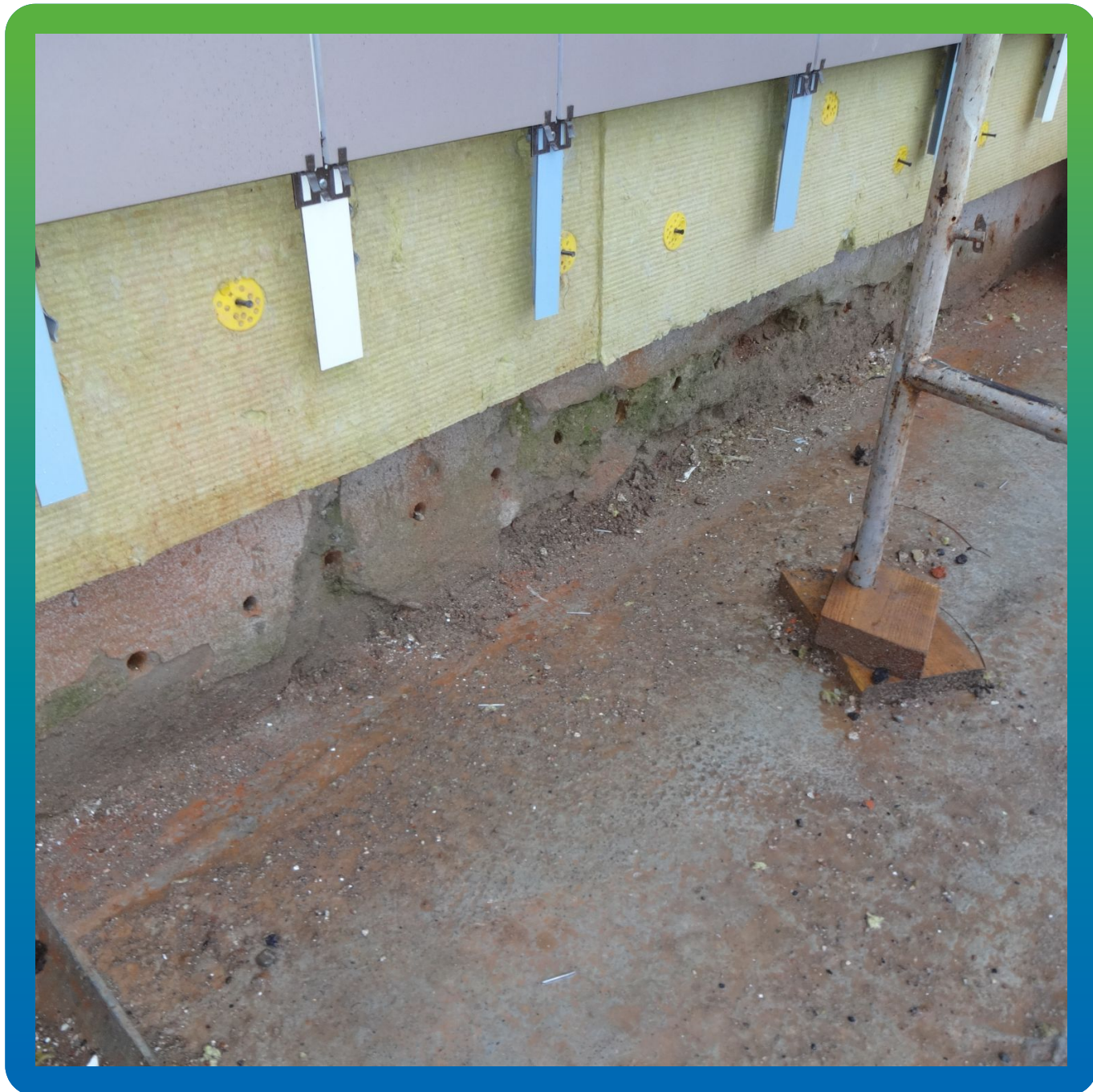
Бурение шпуров для установки пакеров БМ 2839
