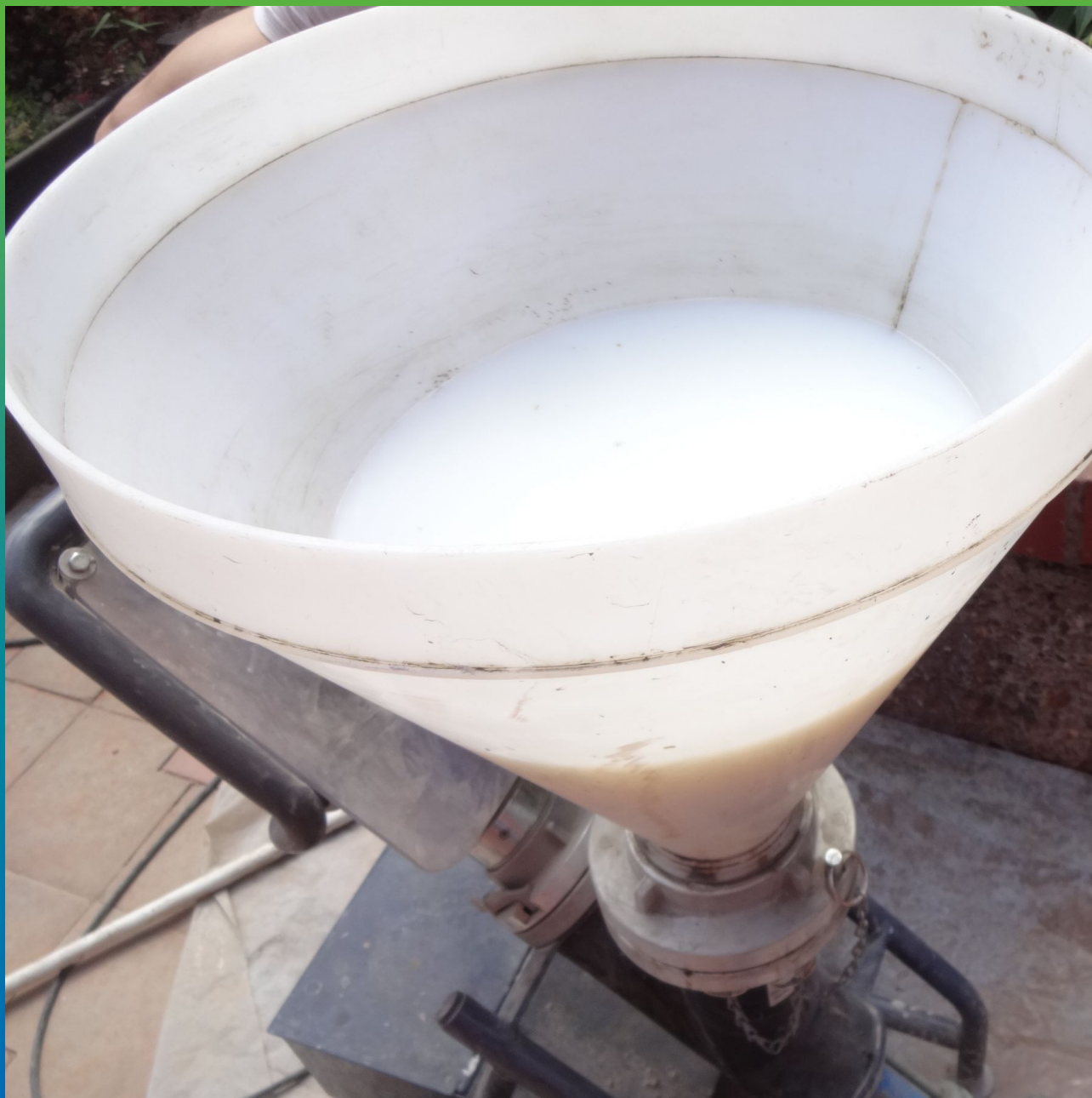
Создание отсечной гидроизоляции составом Маноксан 155
