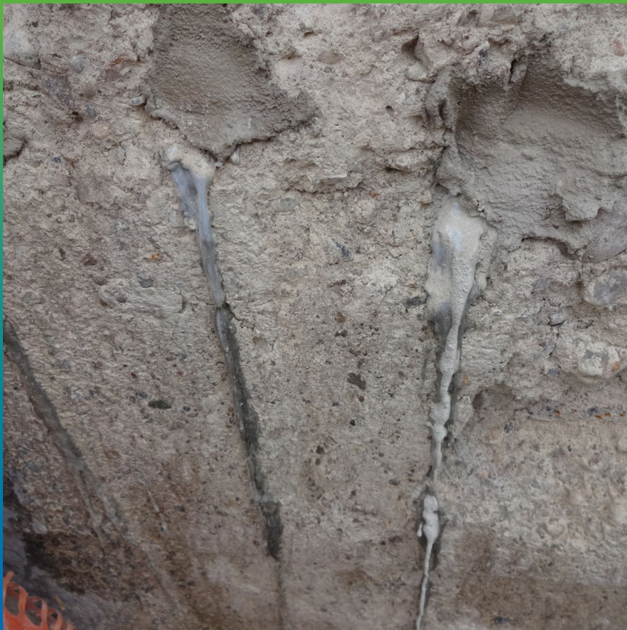
Вид объекта после проведения работ по отсечной гидроизоляции
