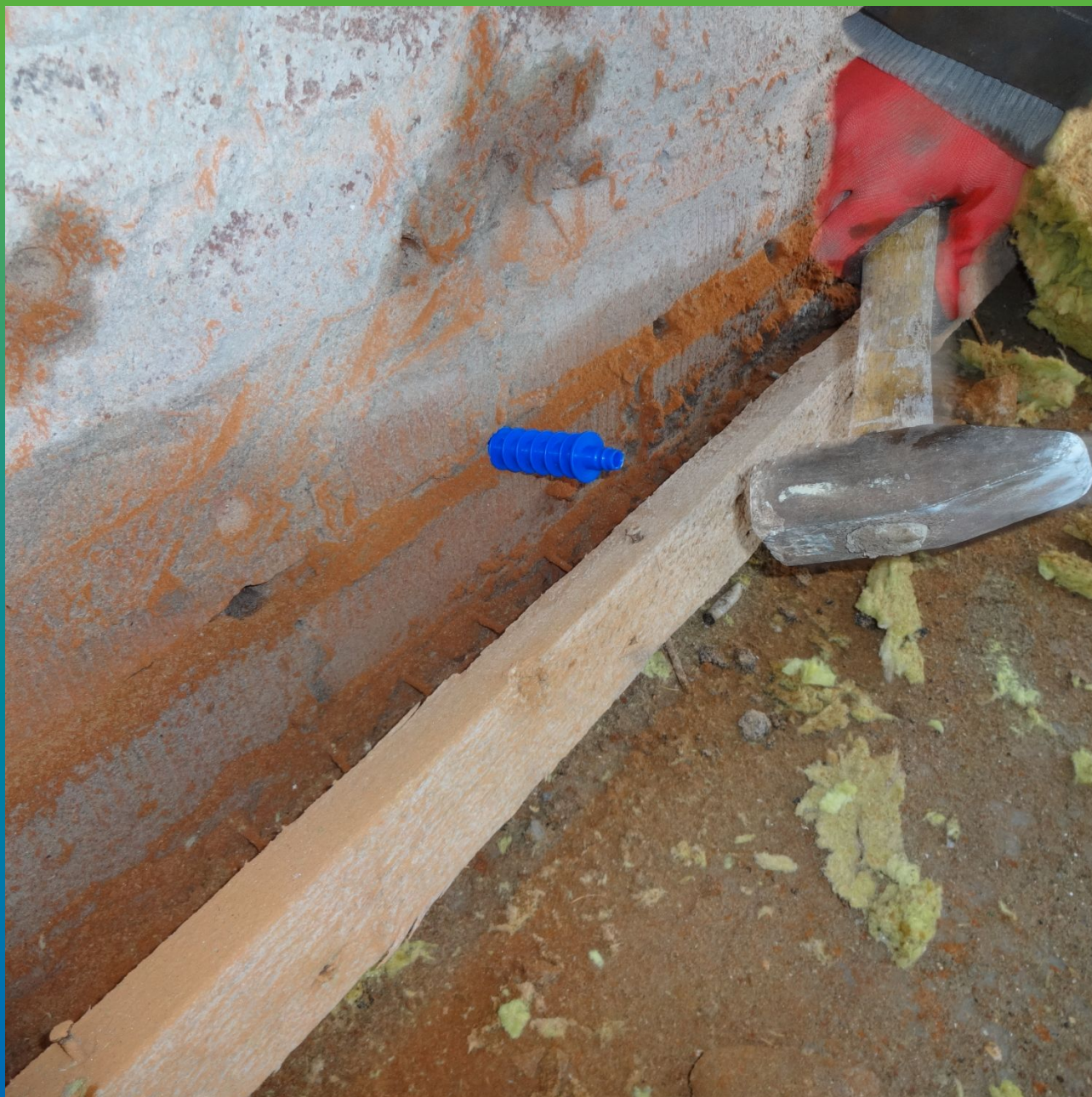
Монтаж пакеров БМ 2839
