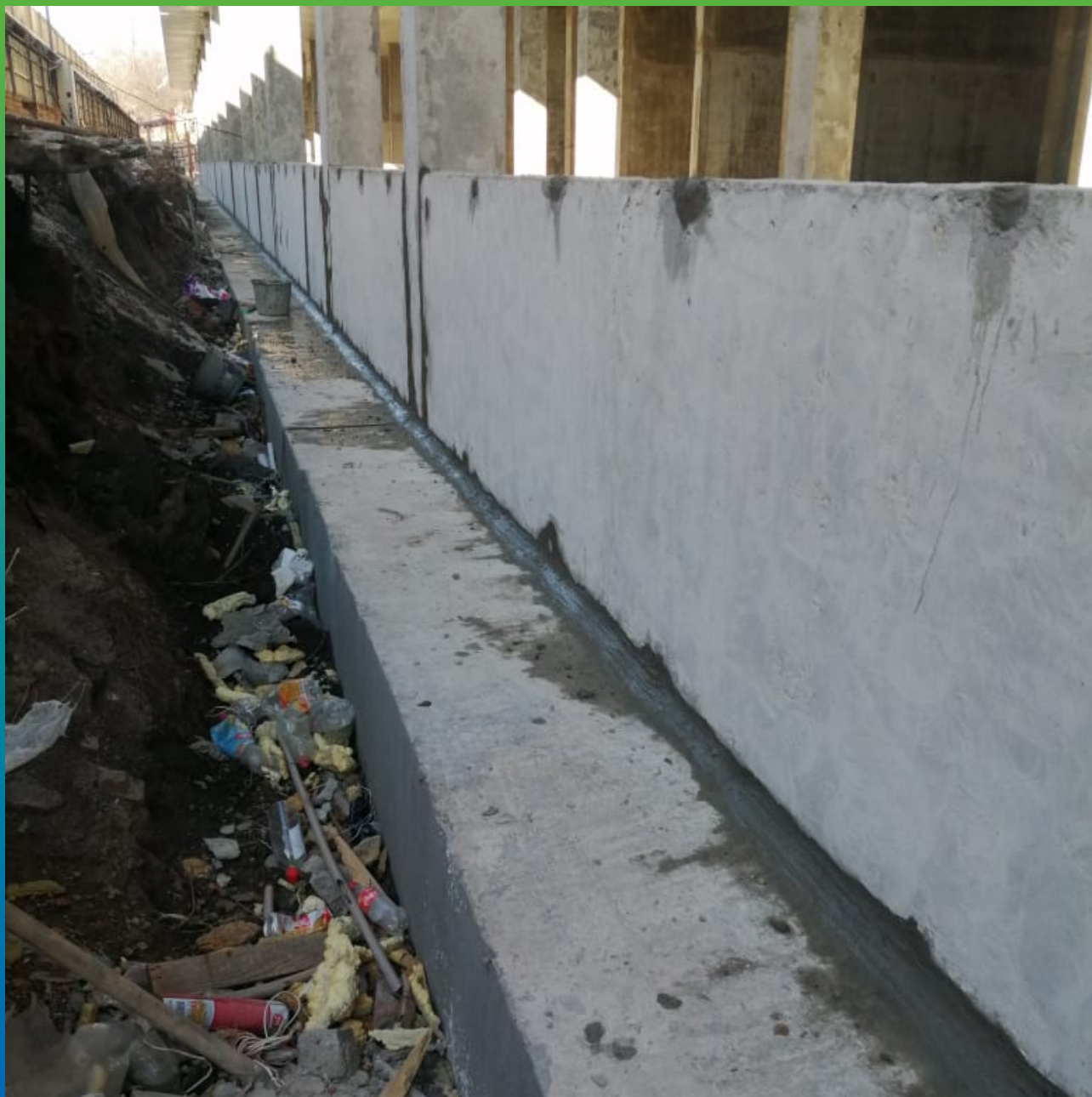
Чеканка холодного шва рем. составом Стармекс РМЗ
