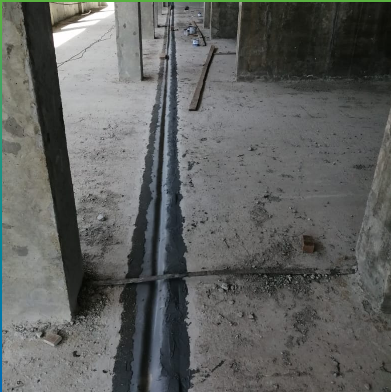
Вид деф. шва, выполненного лентой Манодил Про
