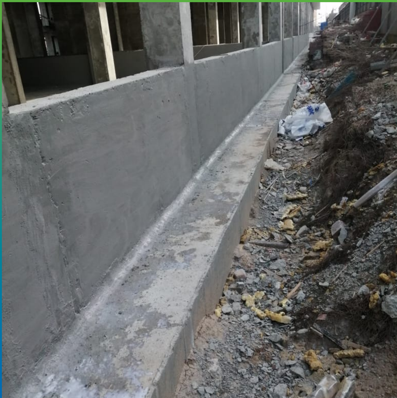
Нанесение первого слоя Стармекс Сил Флекс
