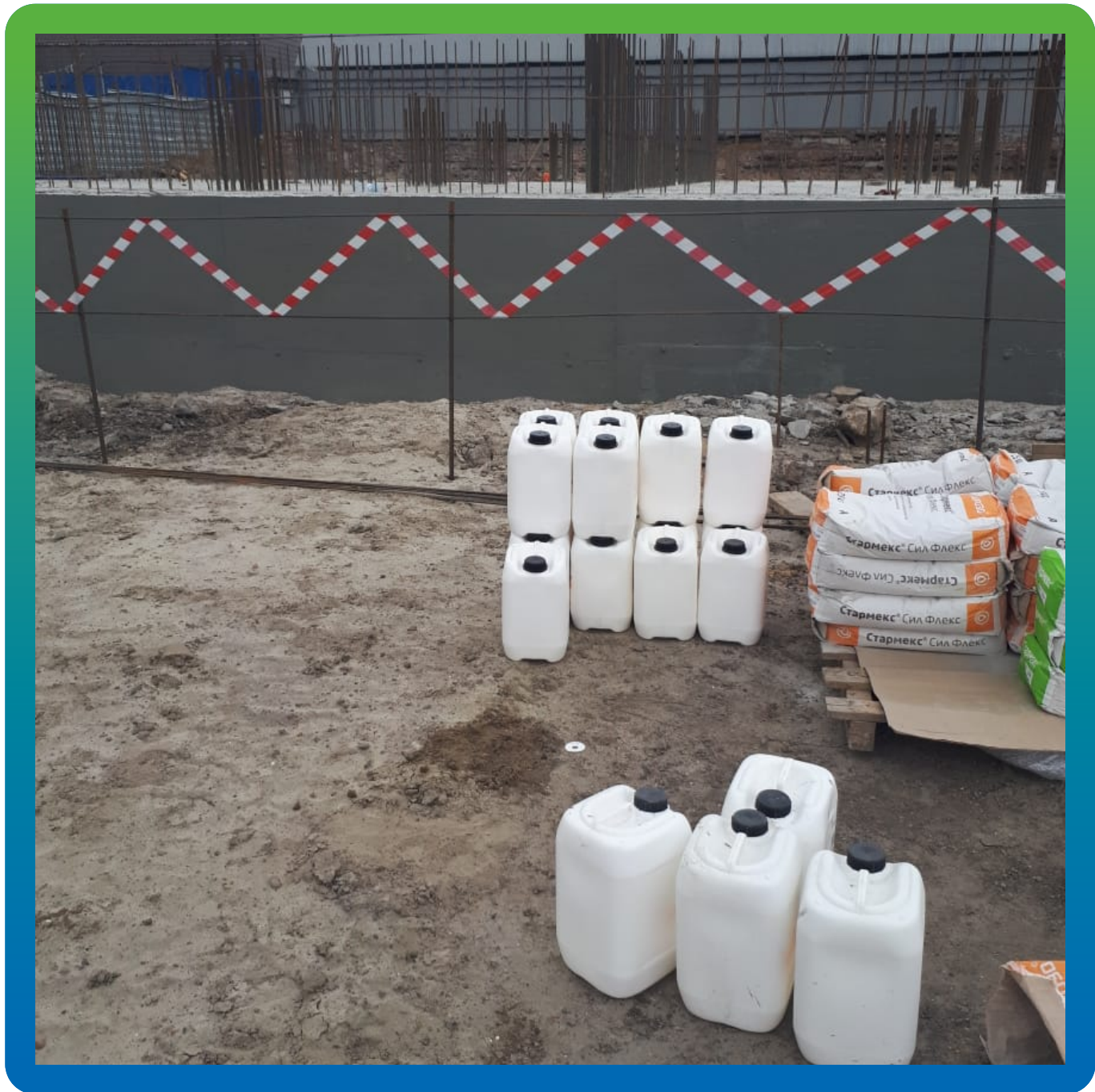
Материалы Гидрозо на объекте
