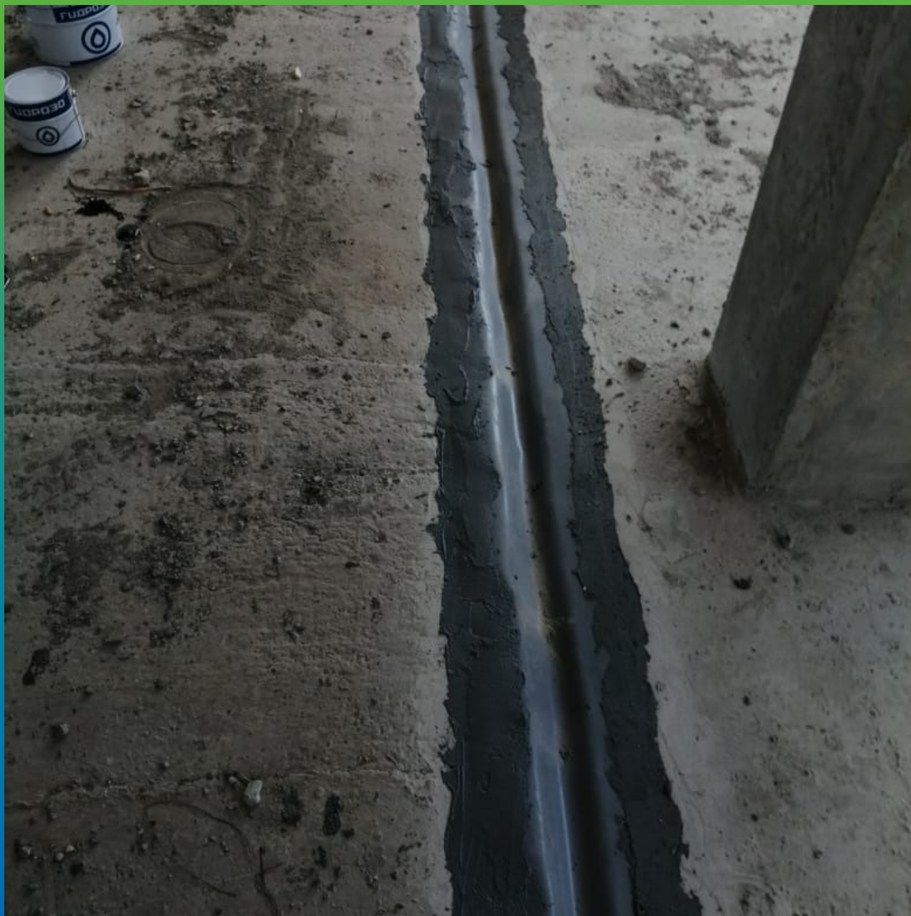
Выполненный деф. шов лентой Манодил Про на клей Манопокс 331
