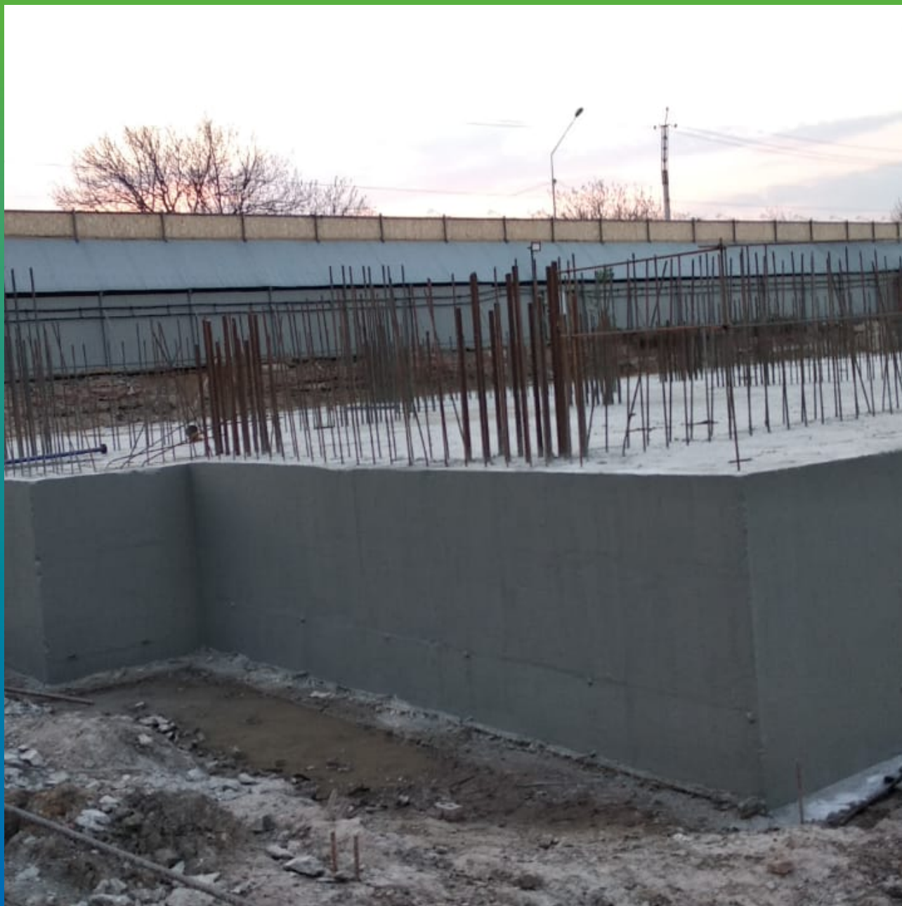
Фундаментная плита, покрытая Стармекс Сил Флекс
