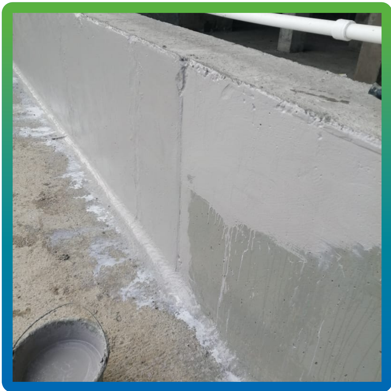
В процессе покрытия эластичной гидроизоляцией Стармекс Сил Флекс
