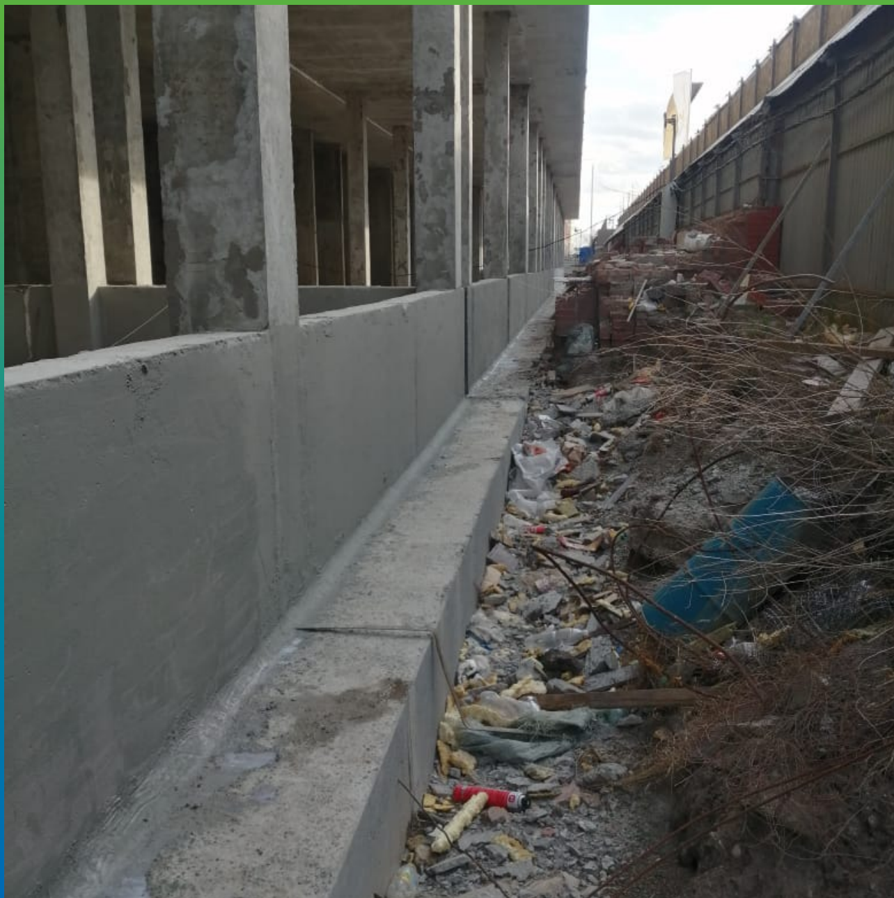
Нанесение второго слоя Стармекс Сил Флекс
