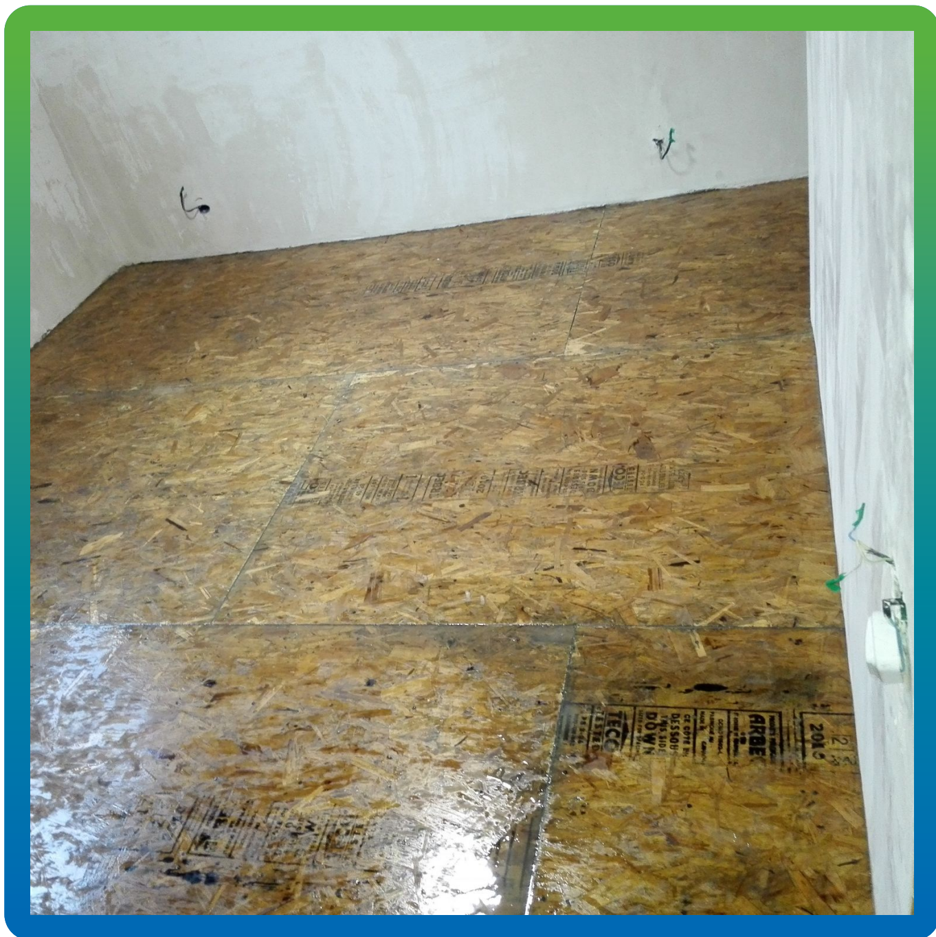
Вид после грунтования ДенТоп ЭП 104
