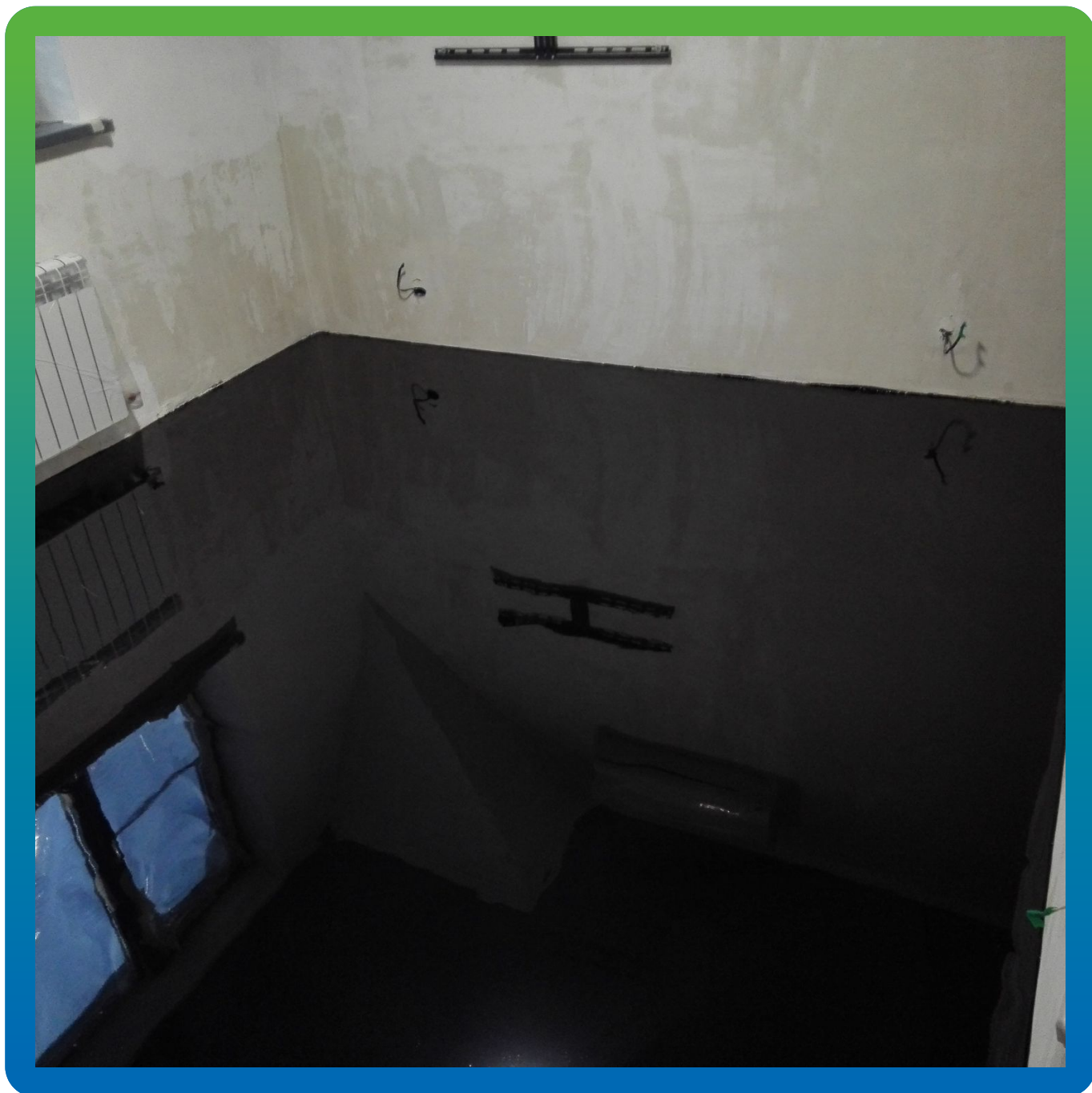
Нанесенный базовый слой
