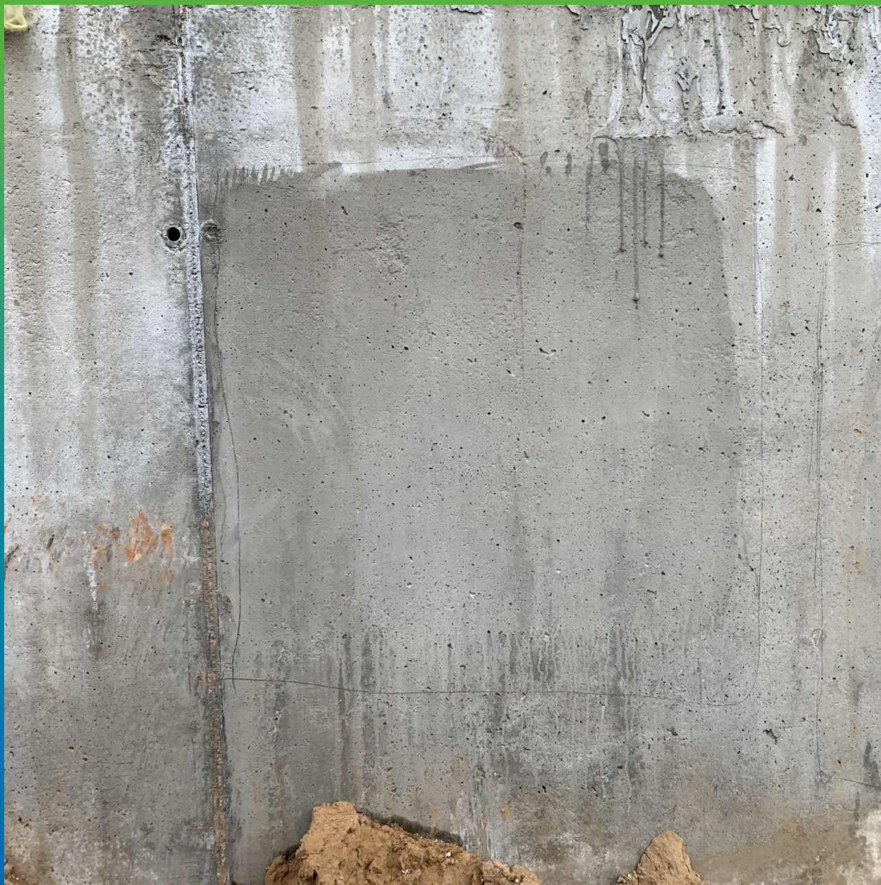
Поверхность стены после нанесения Маногард ФР
