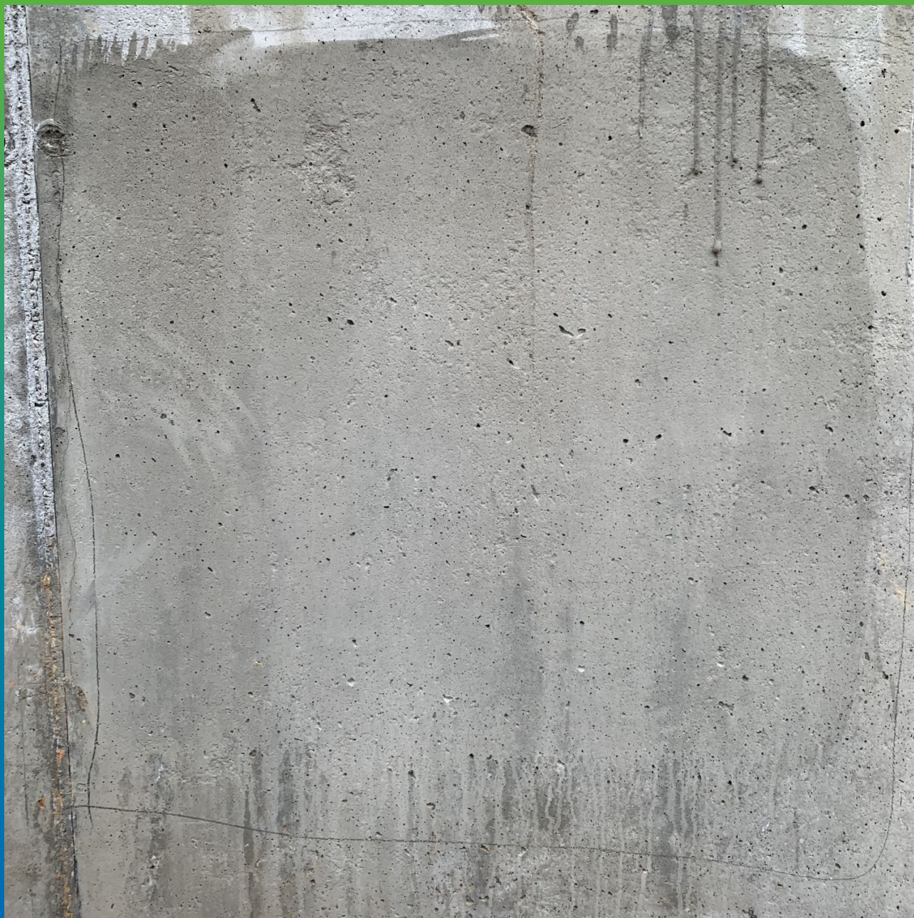
Поверхность стены после нанесения Маногард ФР
