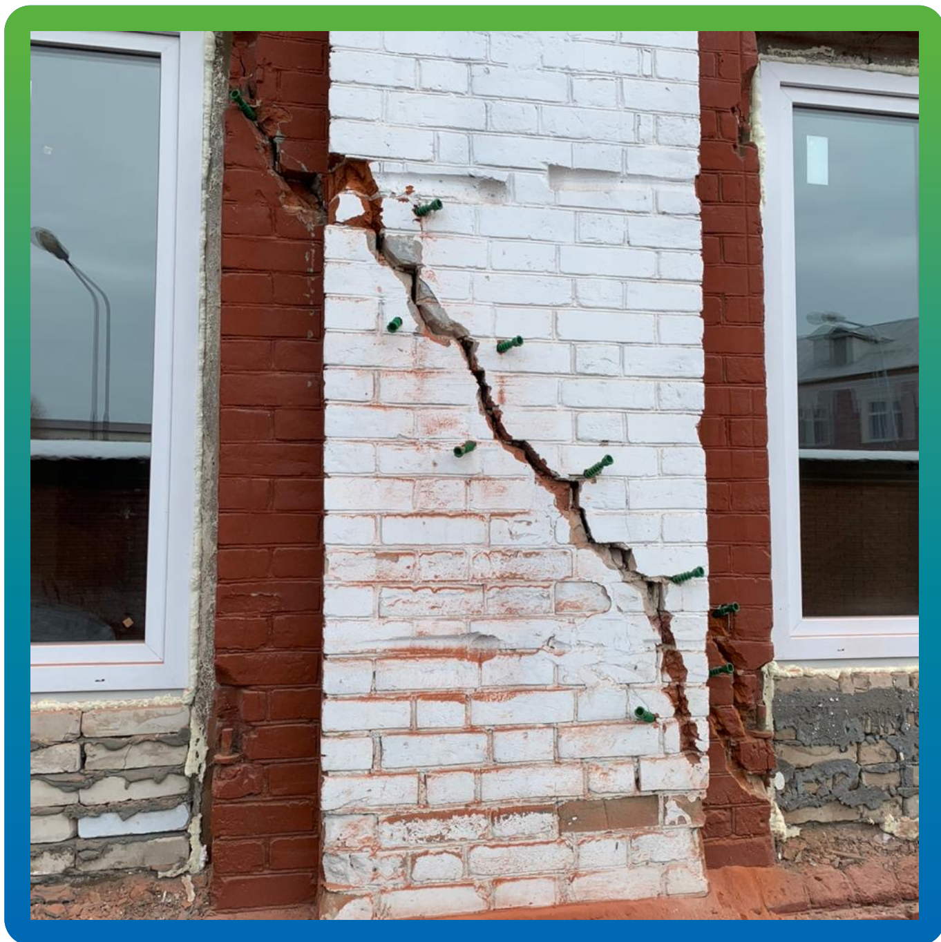
Расширенная трещина
