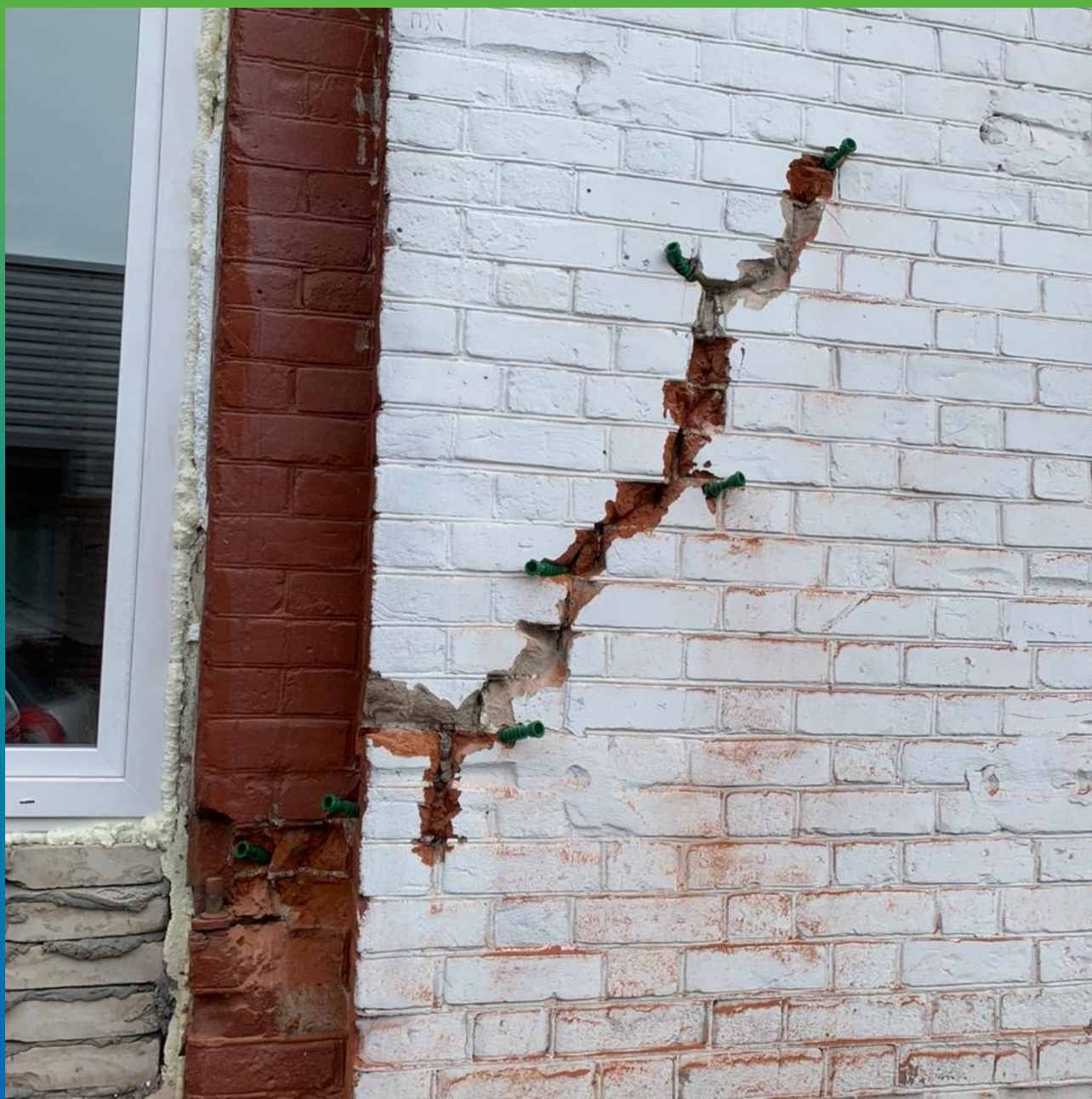
Расширяя трещина
