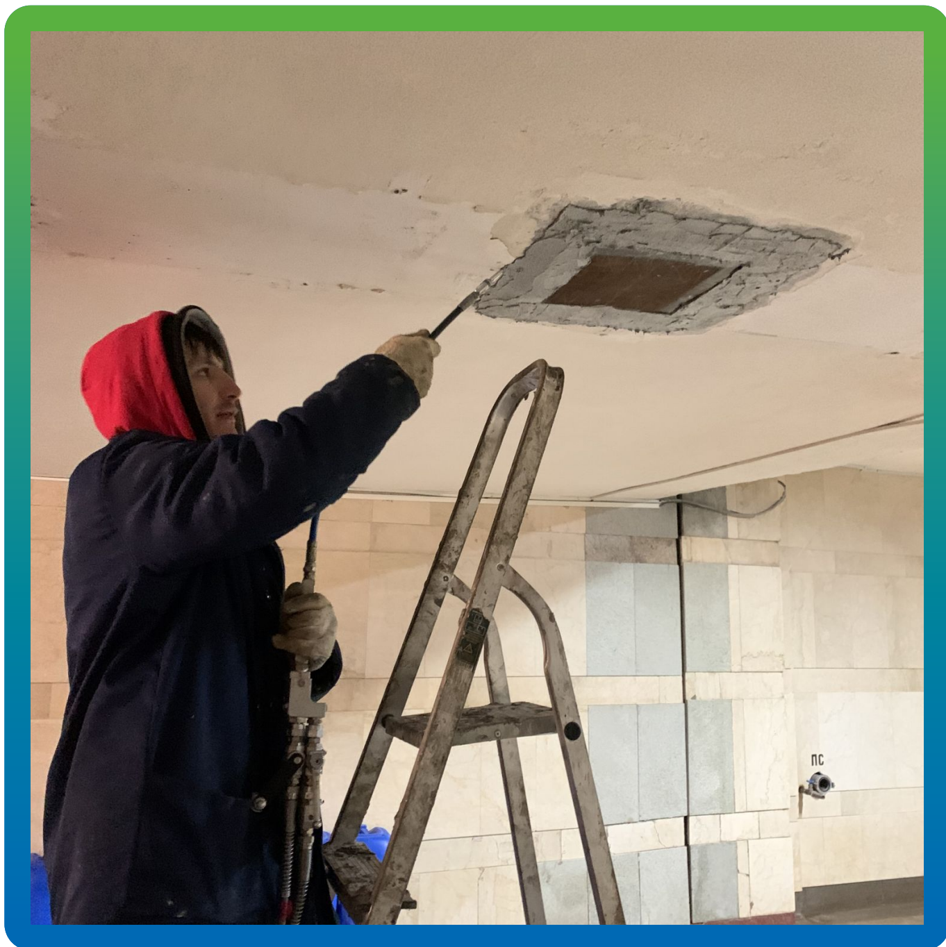
Инъектирование отверстий
