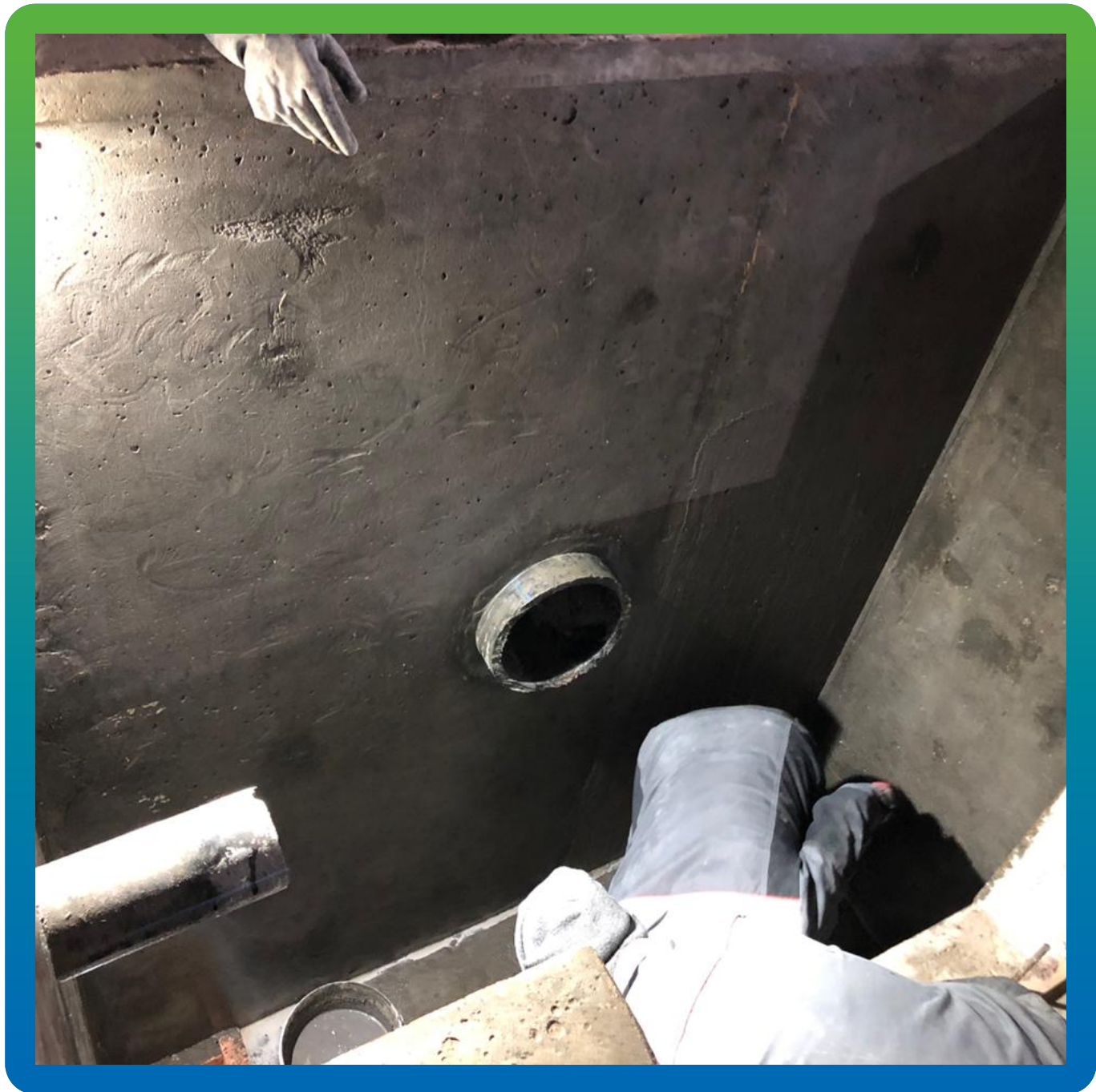
Зачеканка ввода коммуникаций ремонтным составом.
