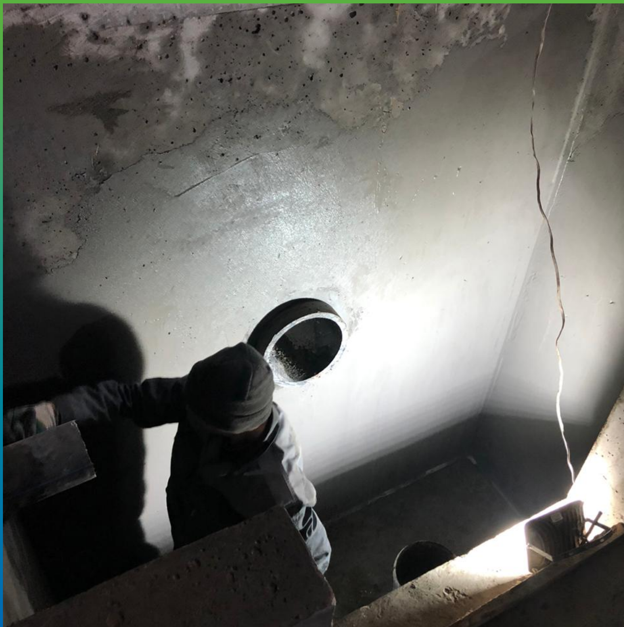
Нанесение обмазочной гидроизоляции на стены.
