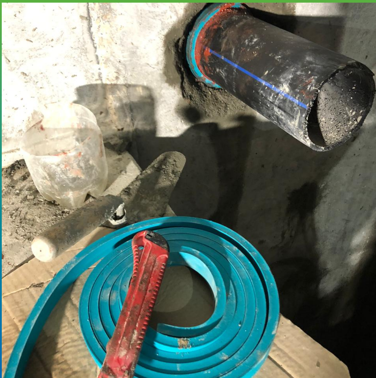
Укладка профиля в подготовленную полость.
