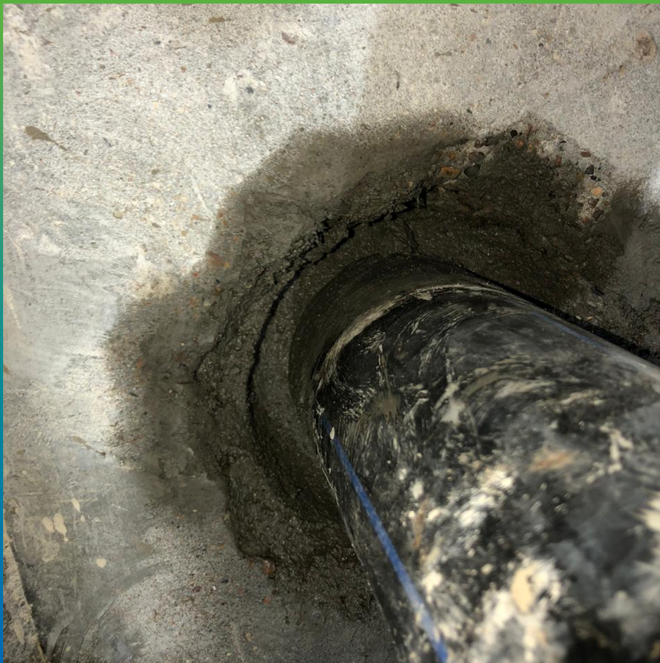
Подготовка основания для укладки гидрофильного профиля
