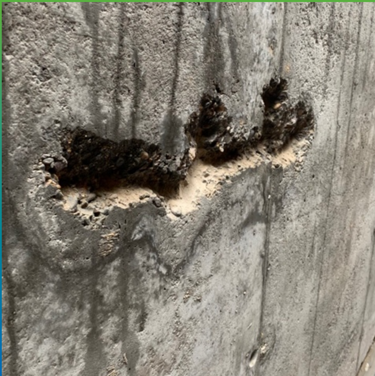
Подготовка и ремонт участков с дефектами бетонирования.
