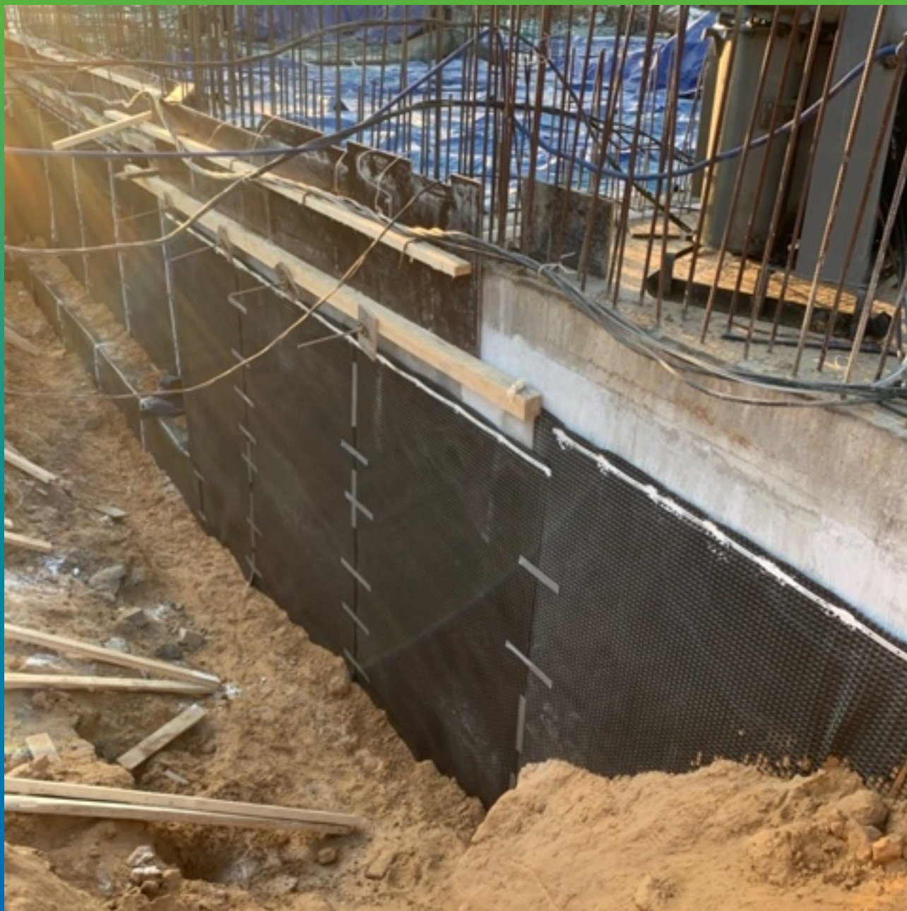
Защита гидроизоляционного покрытия при помощи дренажного полотна.
