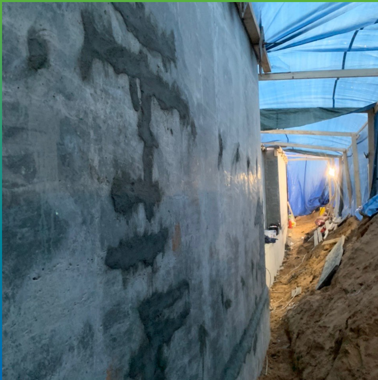
Подготовка и ремонт участков с дефектами бетонирования.
