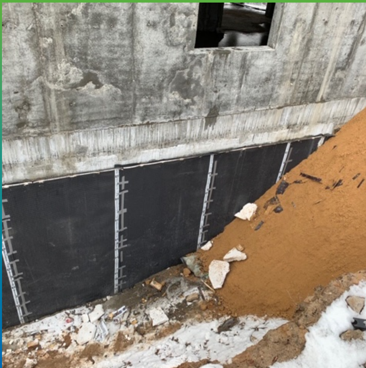
Защита гидроизоляционного покрытия при помощи дренажного полотна.
