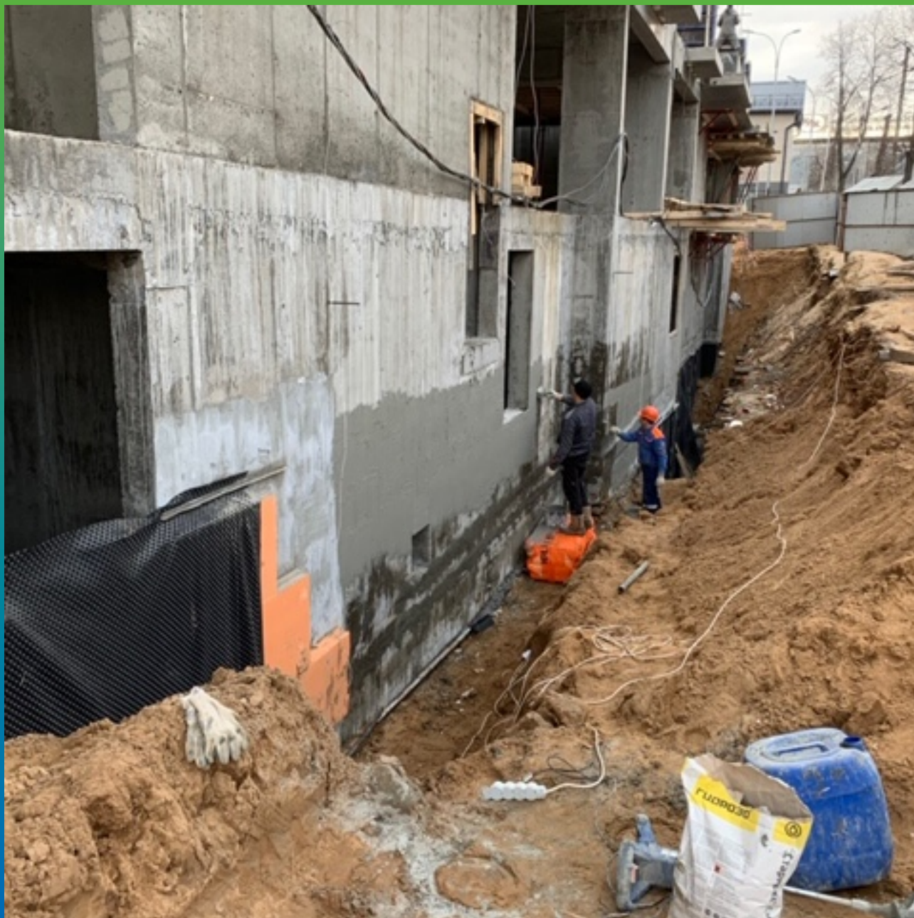
Нанесение гидроизоляционного состава осмотического и бронирующего действия Стармекс Сил.
