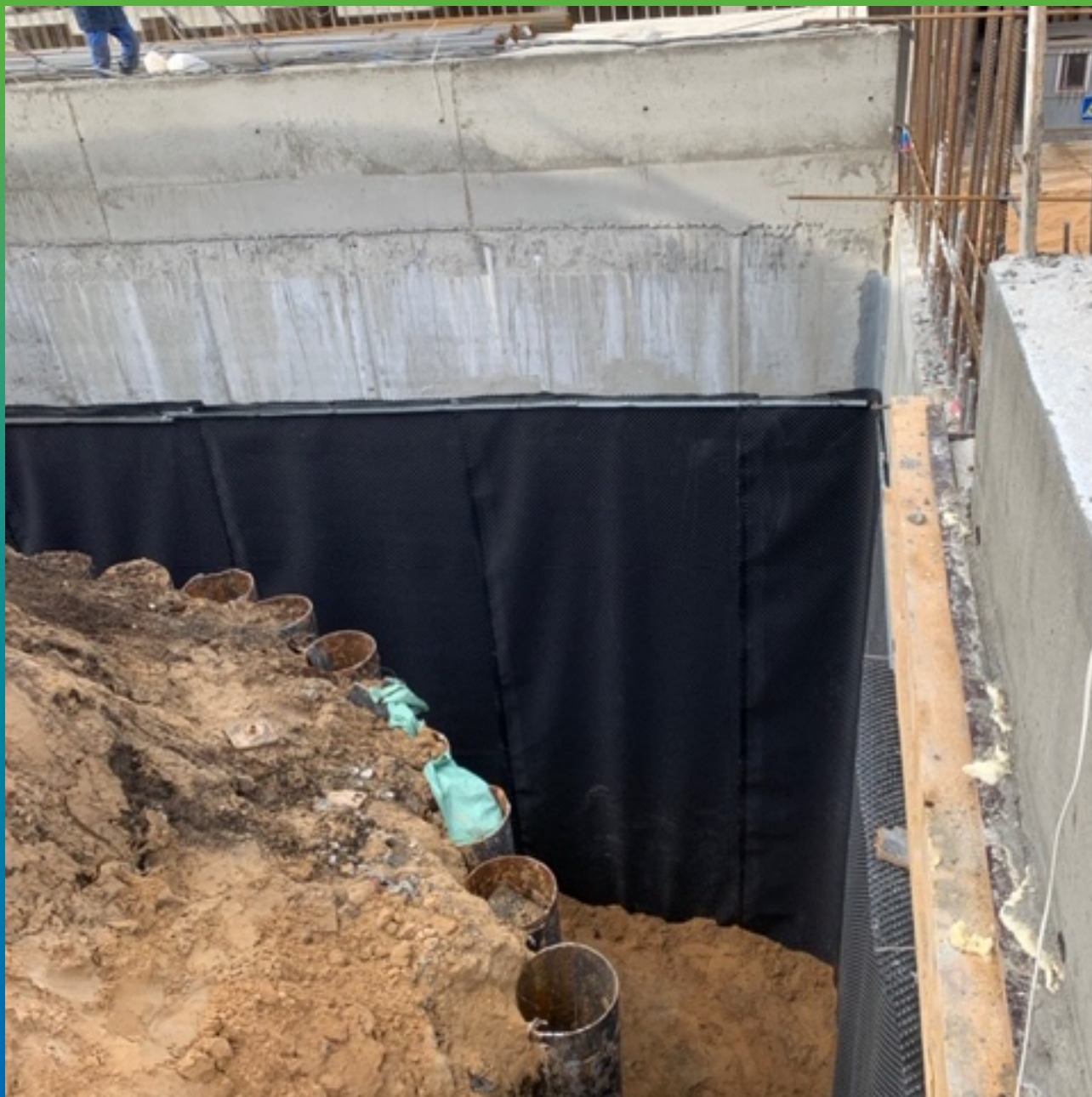
Защита гидроизоляционного покрытия при помощи дренажного полотна.
