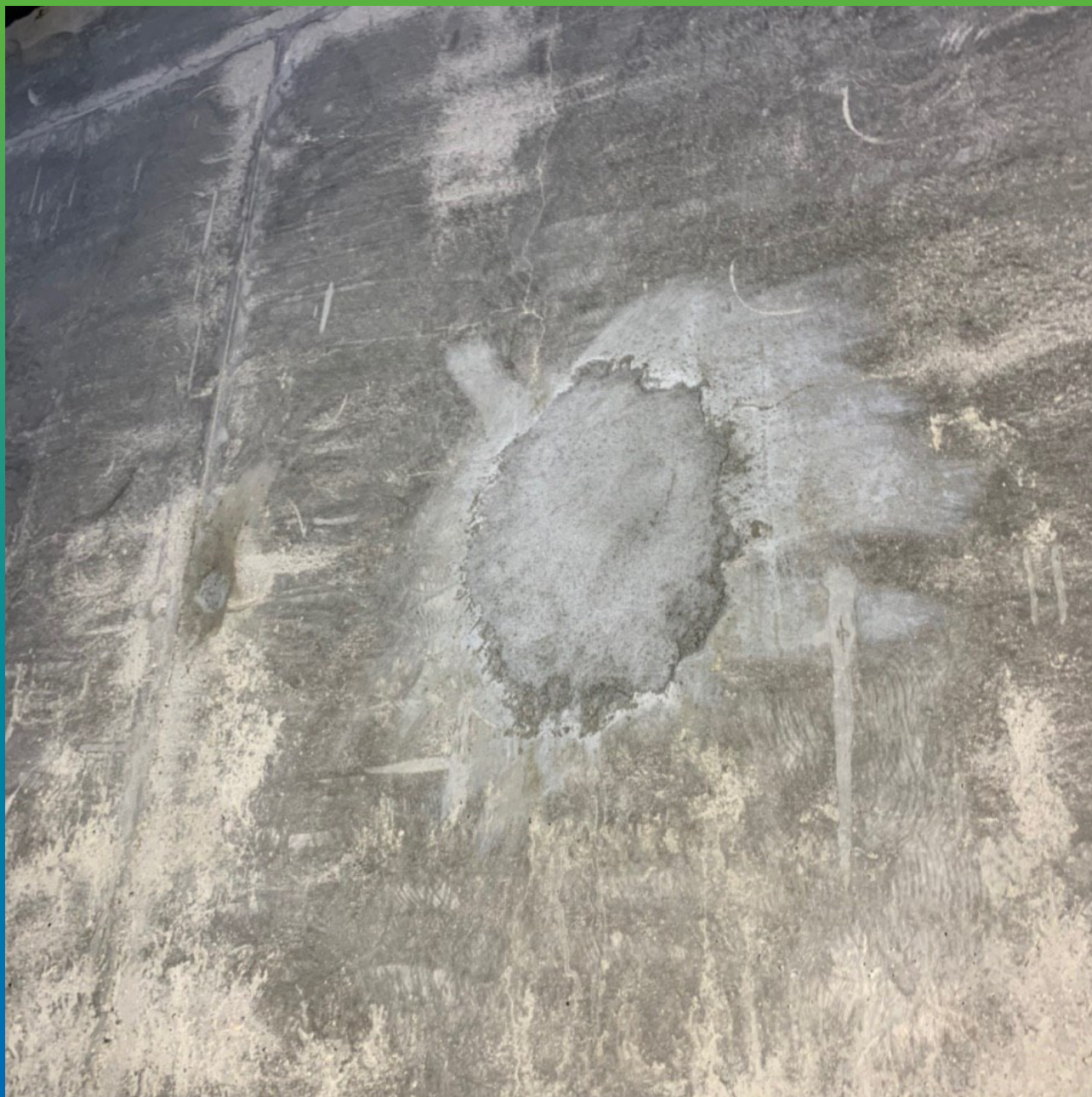
Отремонтированный участок бетонного основания
