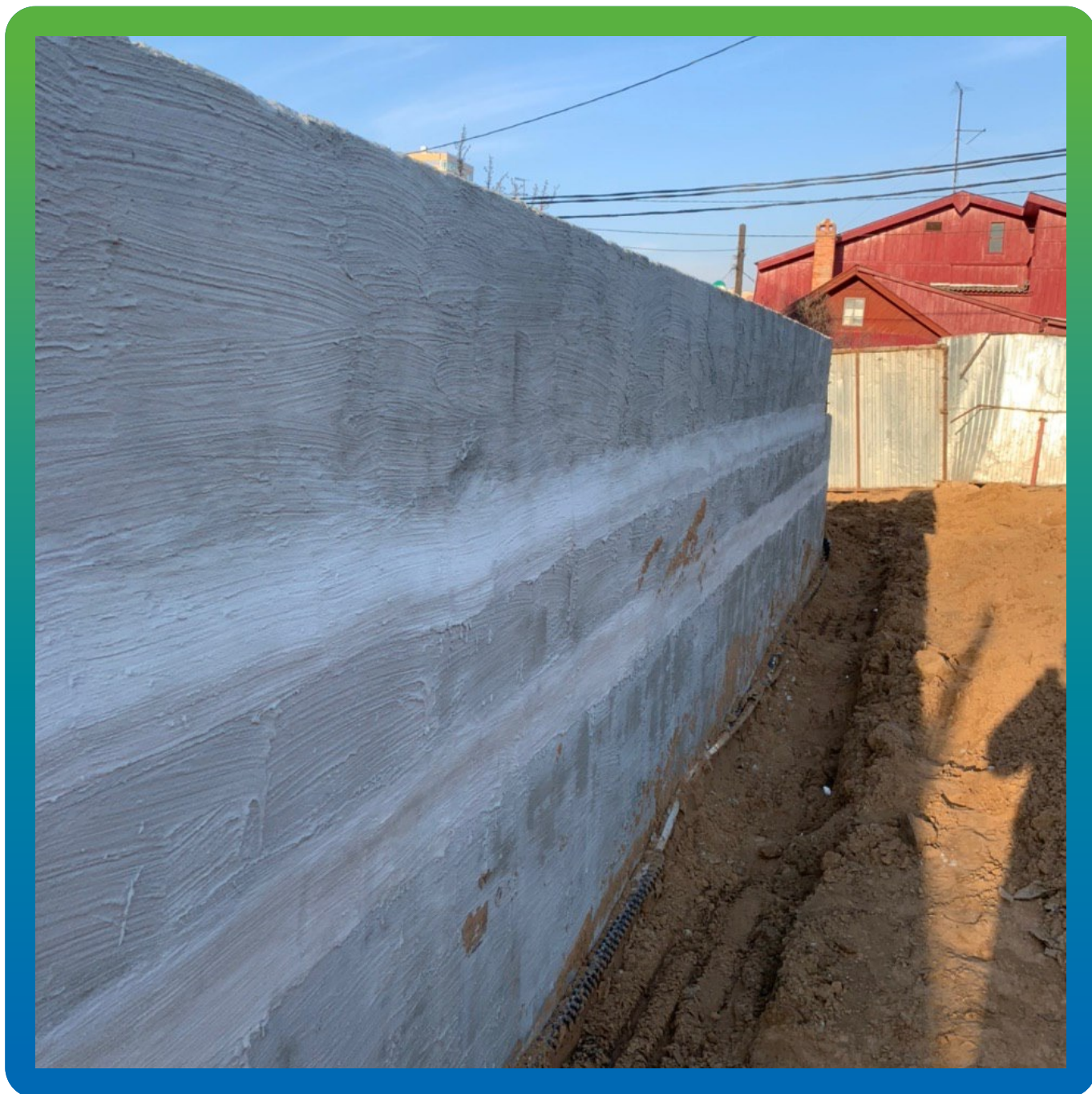
Подготовленный участок под дальнейшее нанесение гидроизоляции
