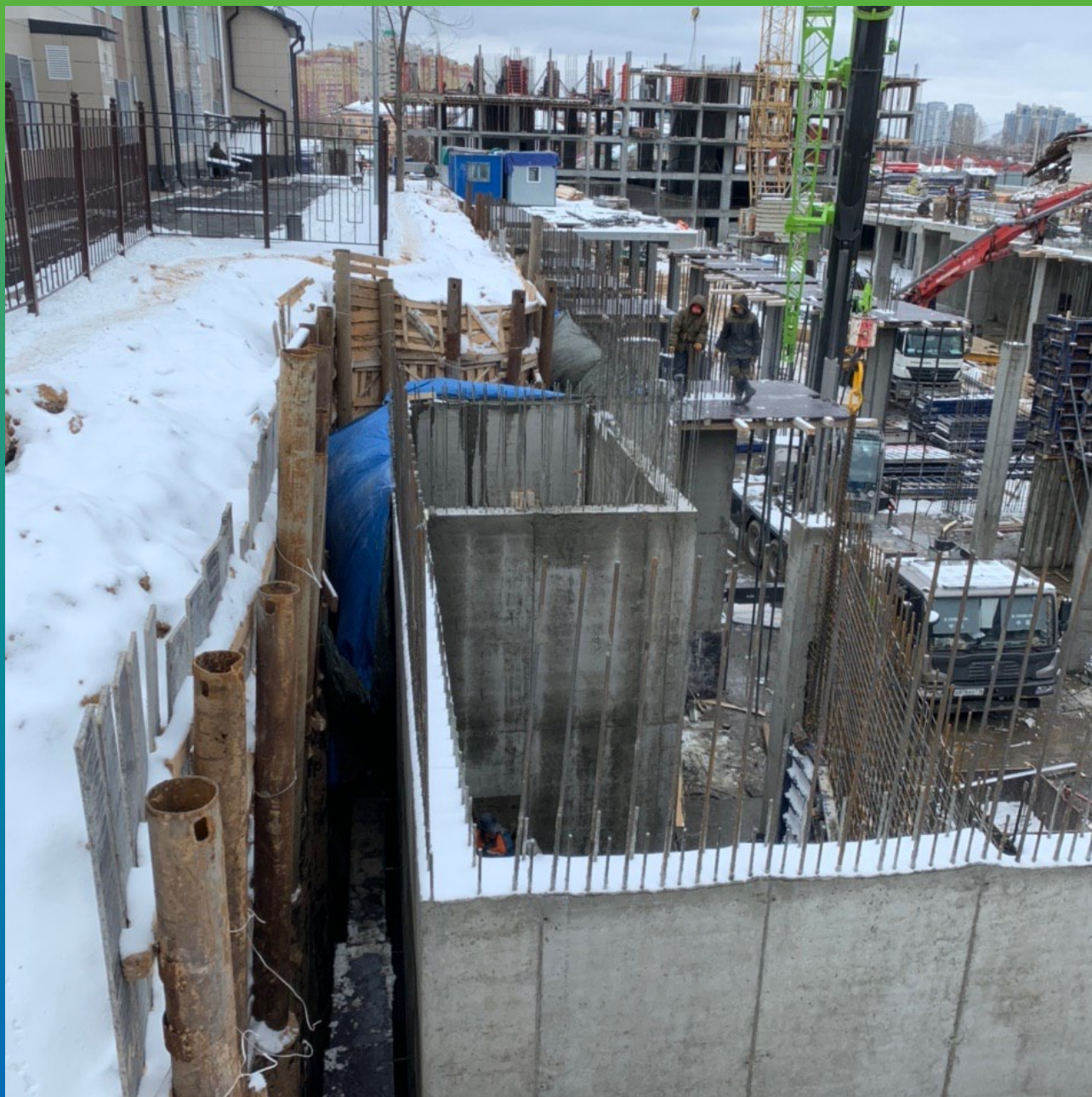
Гидроизоляция подземной парковки.
