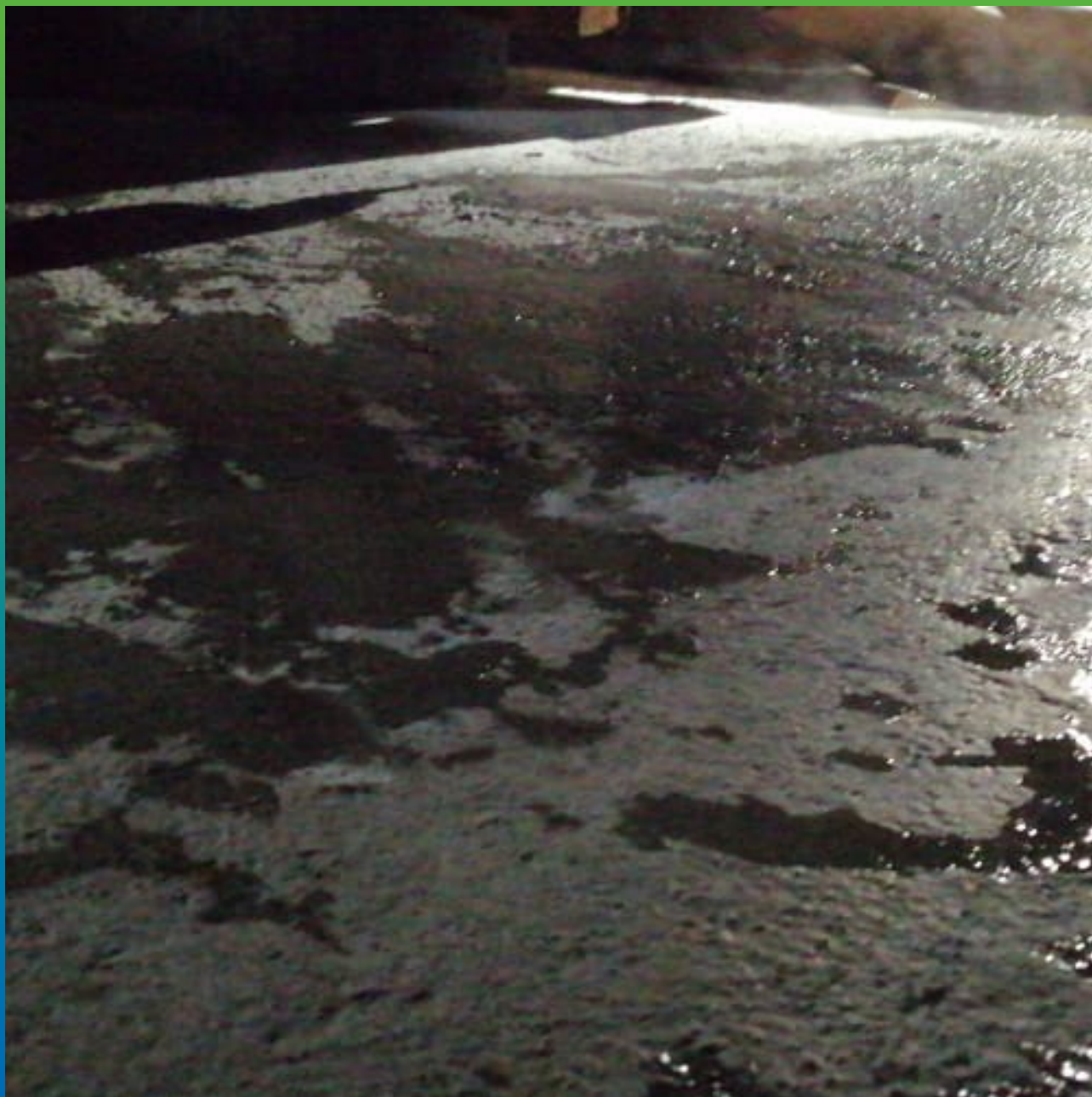
Затвердевший ремонтный состав наливного типа Стармекс ФМ7.
