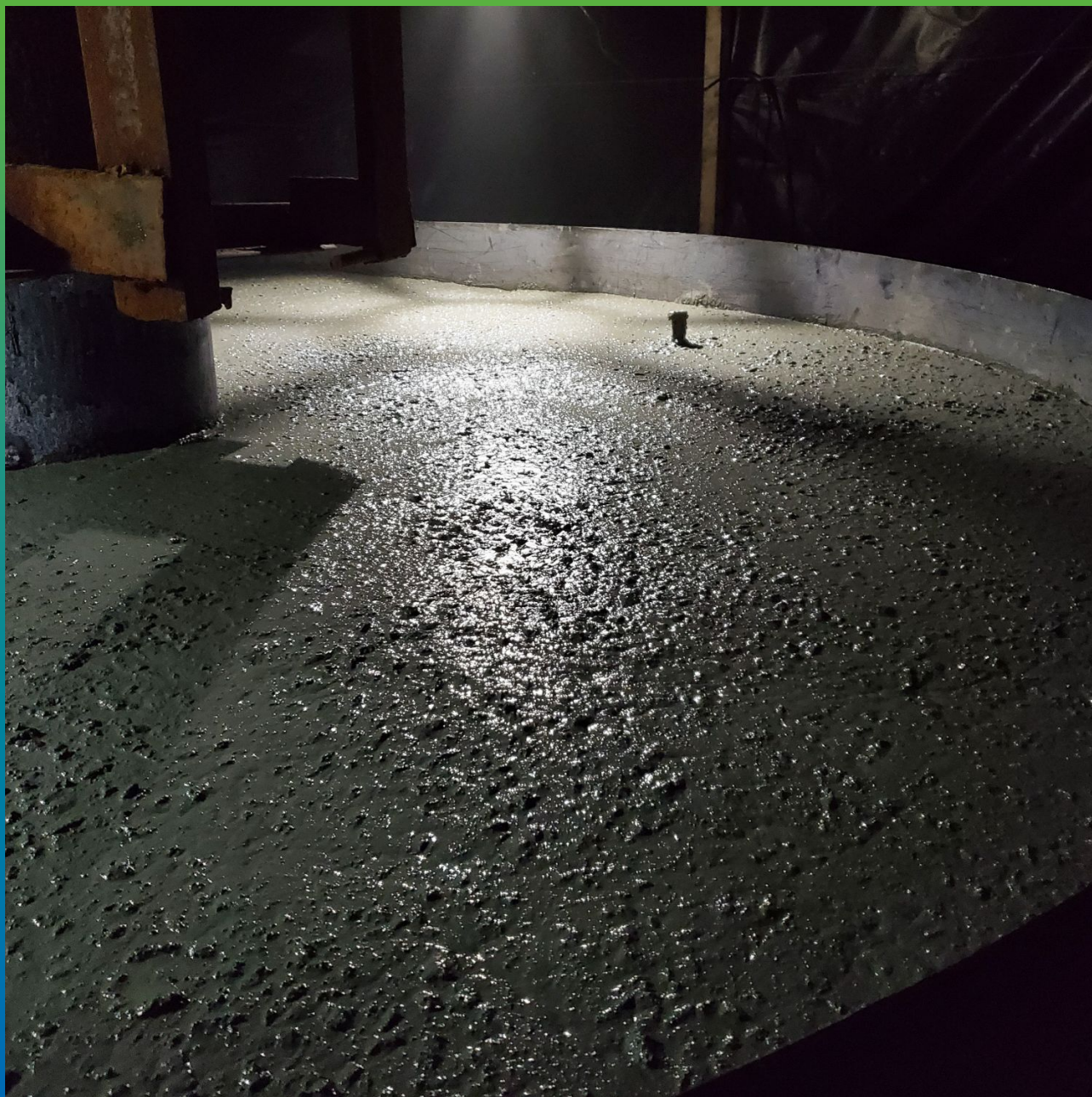
Заливка готового состава в ремонтируемый участок.
