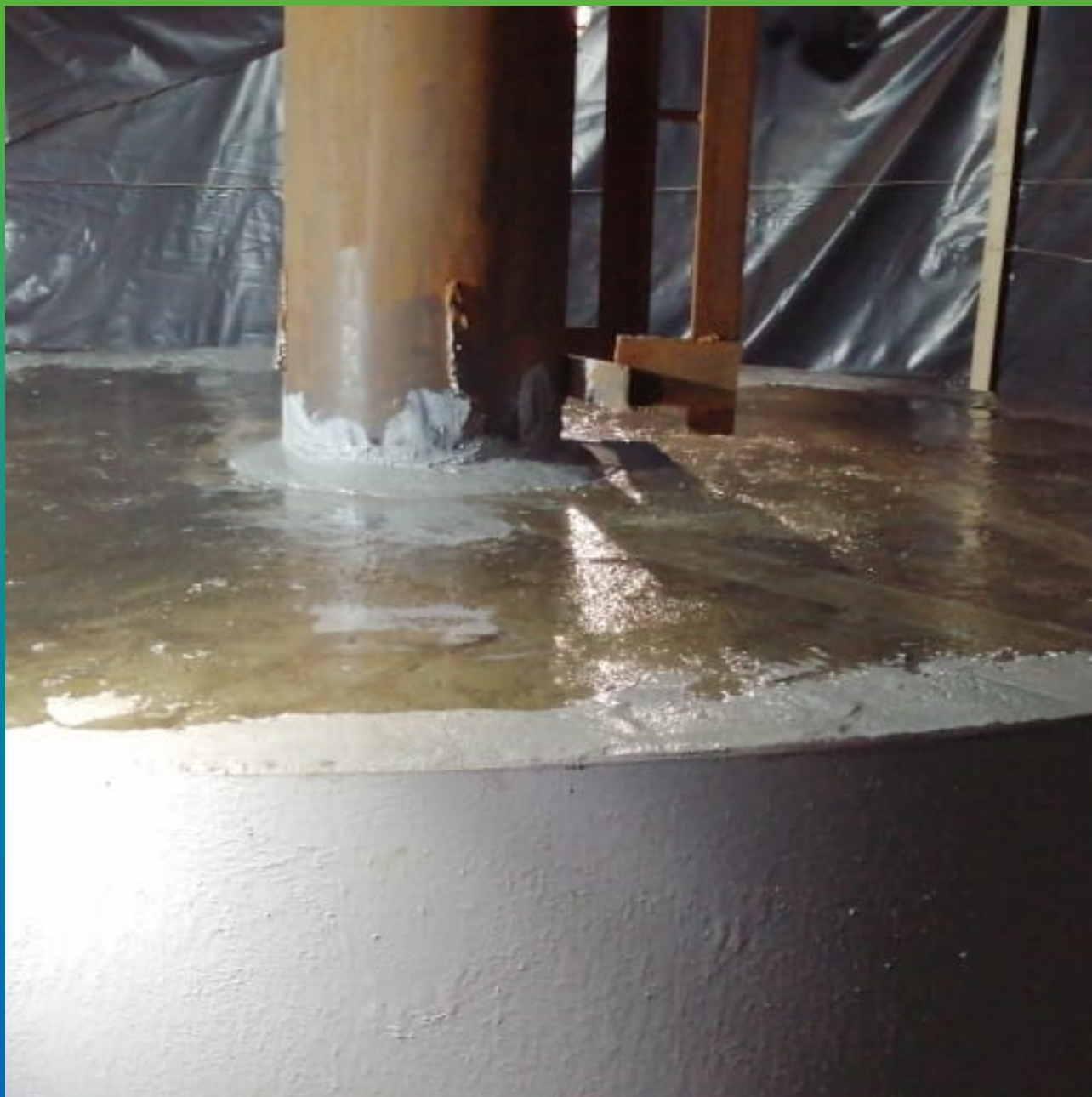
Грунтование бетонной поверхности эпоксидной грунтовкой ДенсТоп ЭП 100
