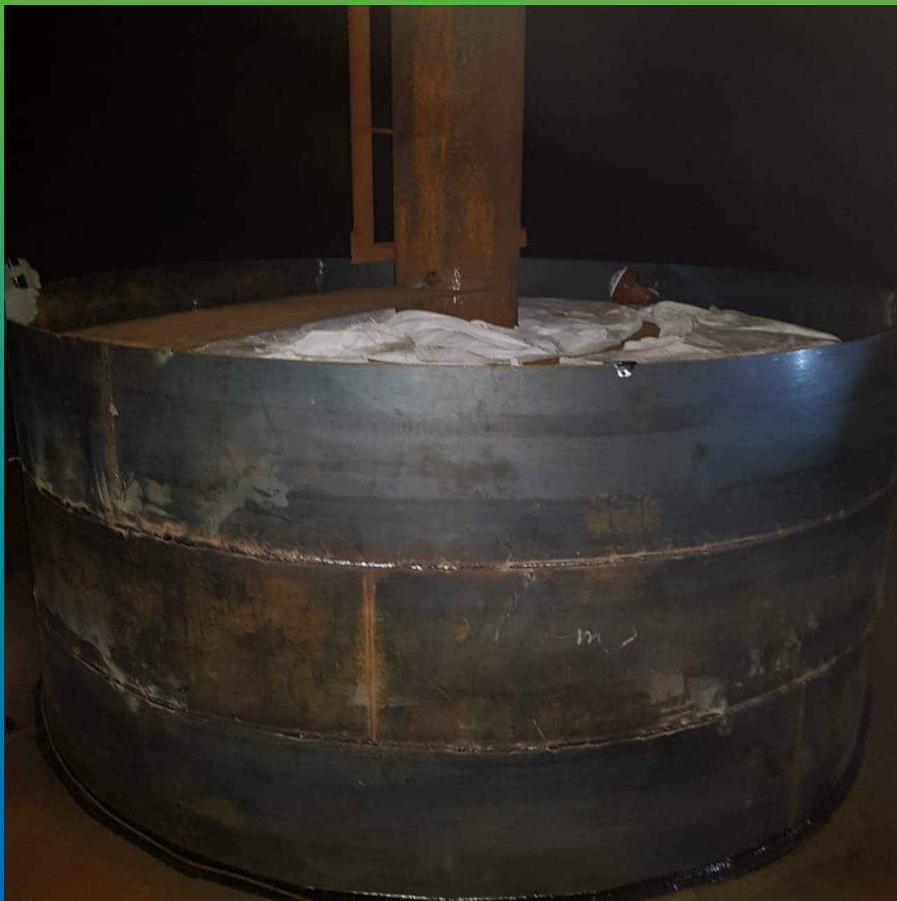
Изначальный вид узла.
