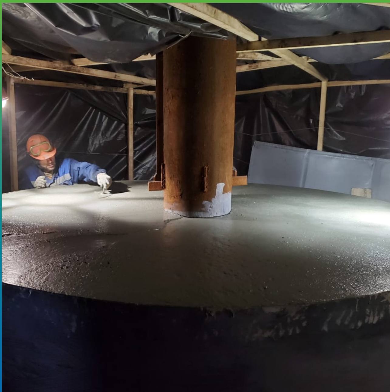
Заливка готового состава в ремонтируемый участок.
