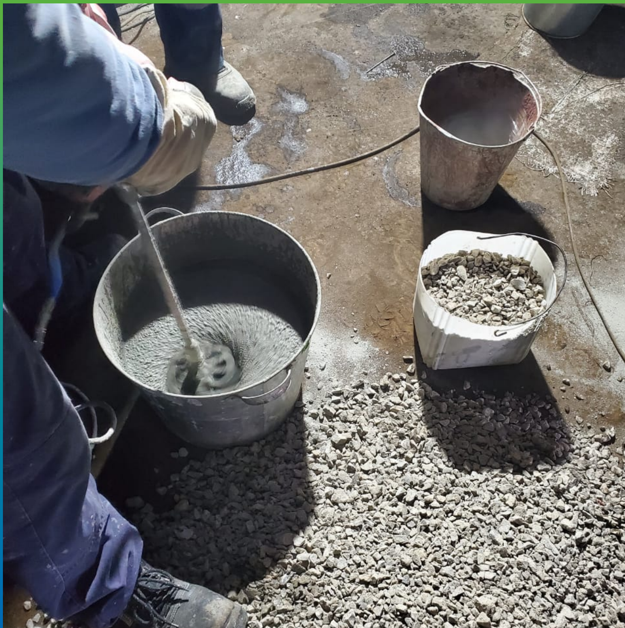
Замешивание материала наливного типа со щебнем.
