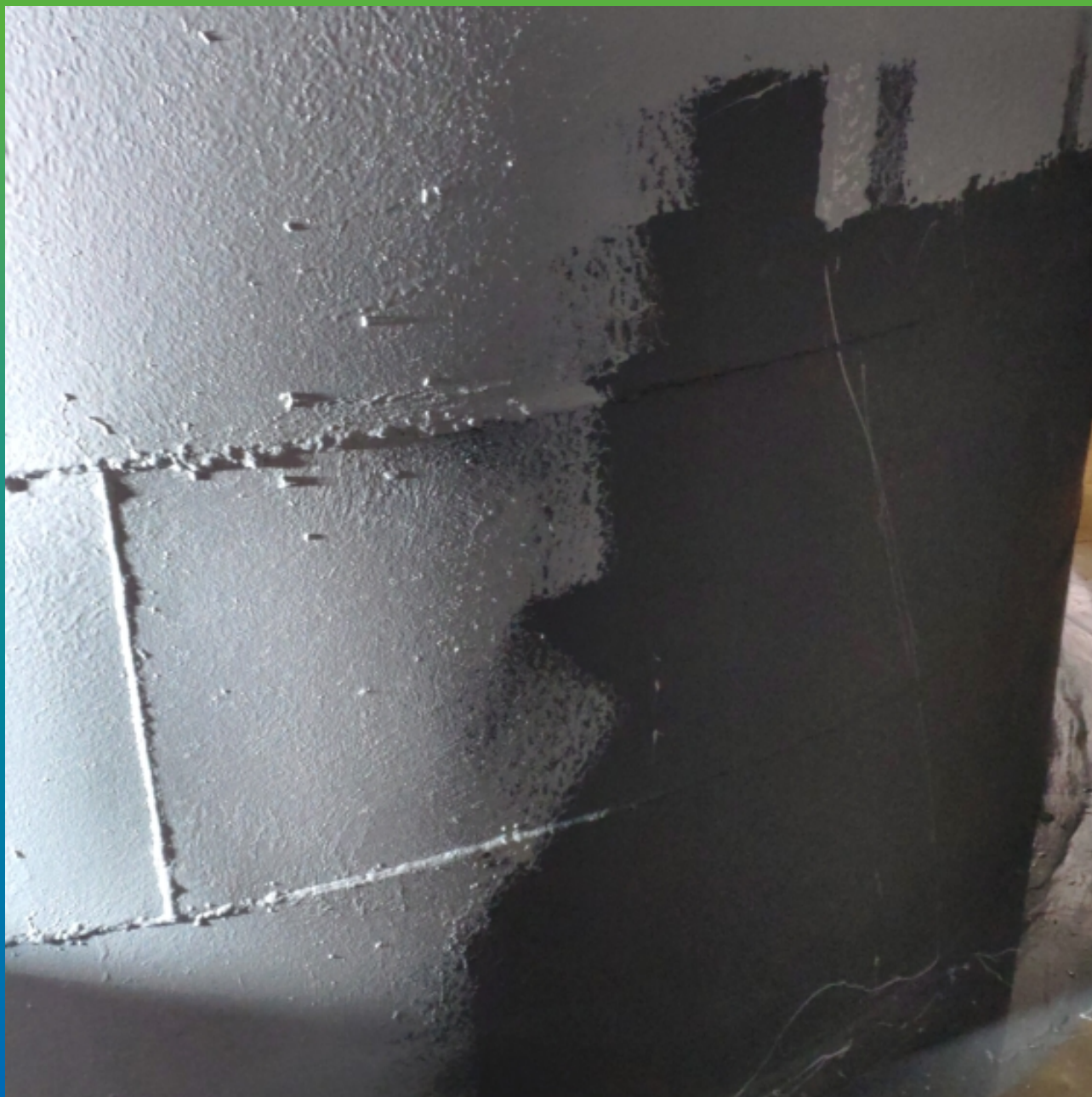
Нанесение химстойкого покрытия Денстоп МС 351
