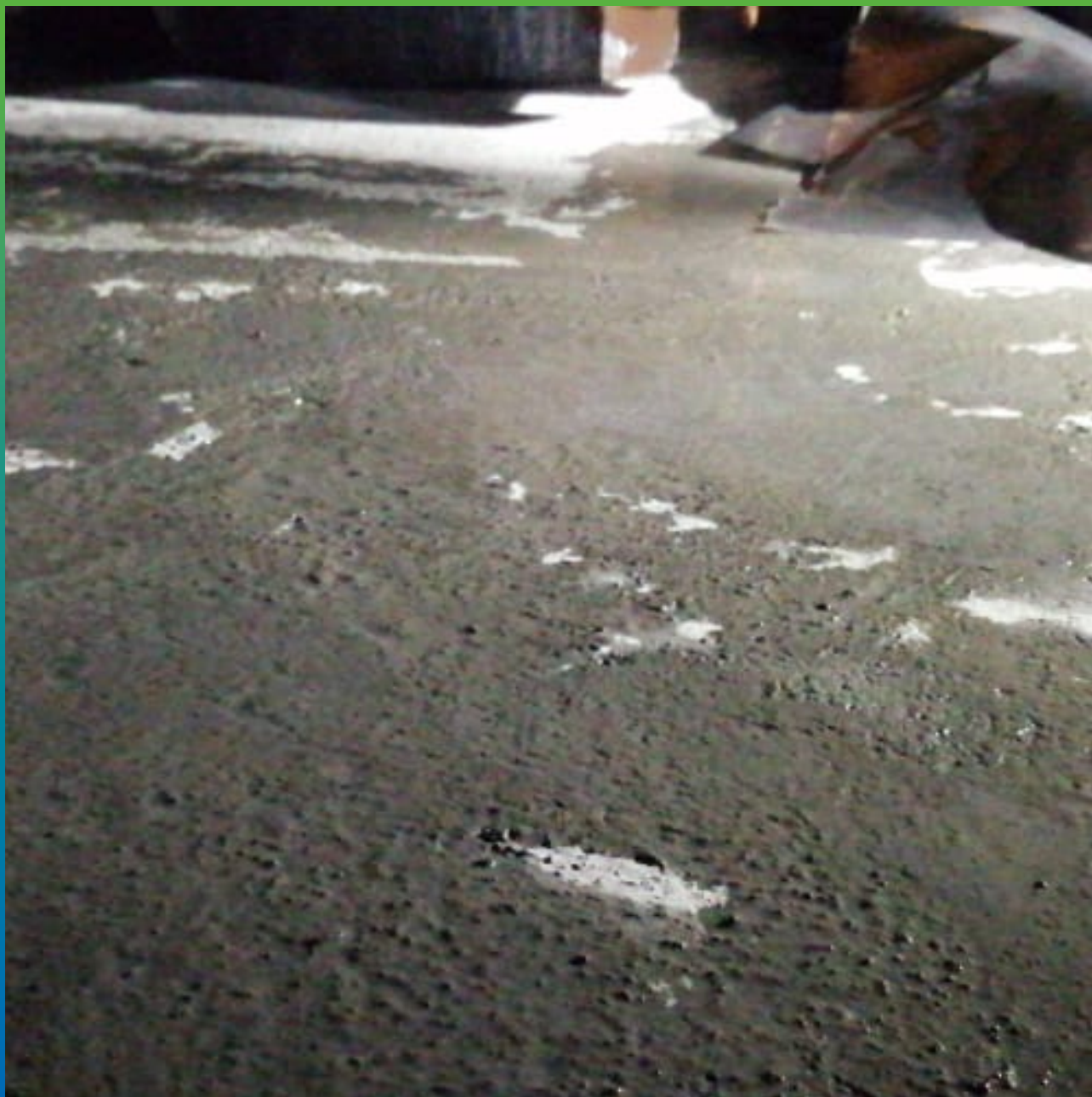
Затвердевший ремонтный состав наливного типа Стармекс ФМ7.
