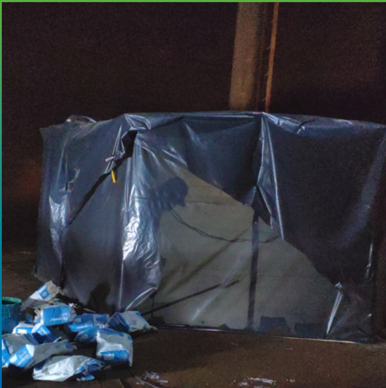
Устройство теплого контура для поддержания температурного режима.
