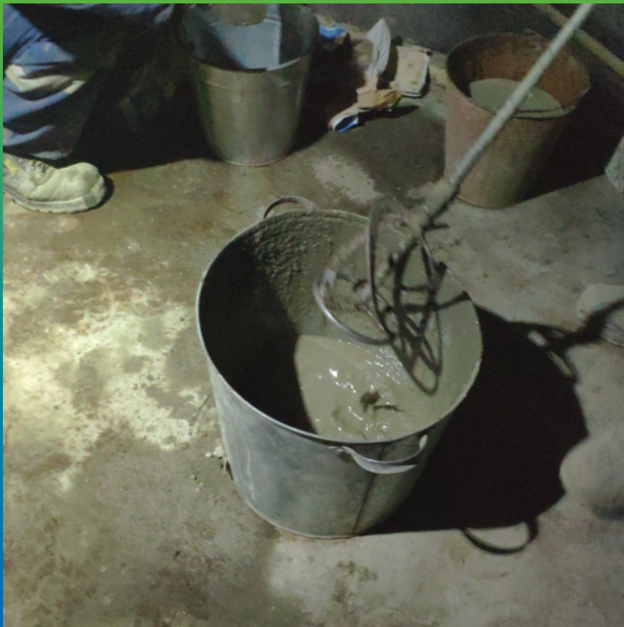
Замешивание материала наливного типа со щебнем.
