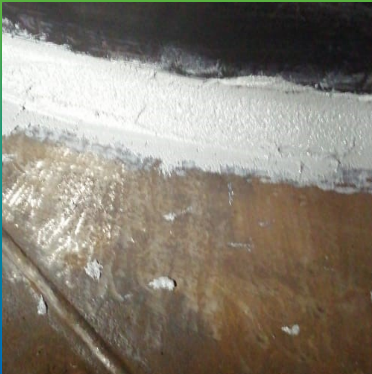
Устройство галтели из эпоксидного ремонтного состава Манопокс 331
