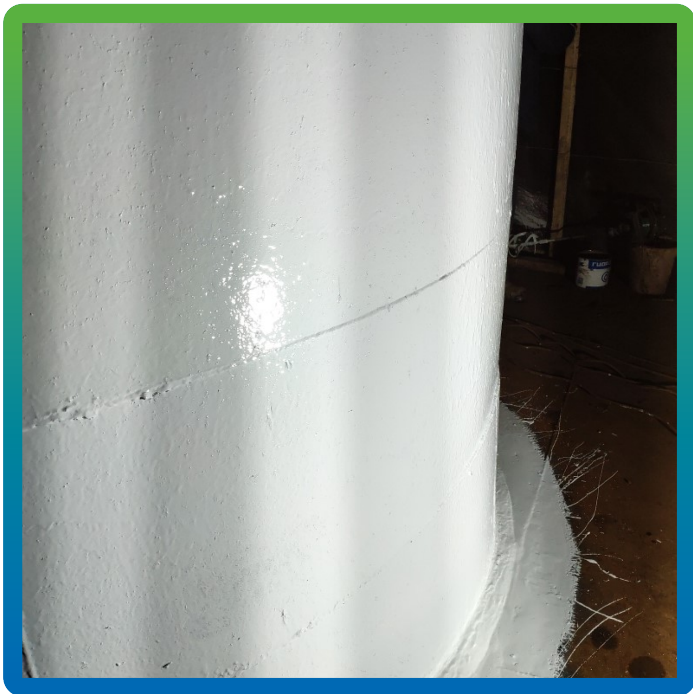
Финишное покрытие отремонтированного узла.
