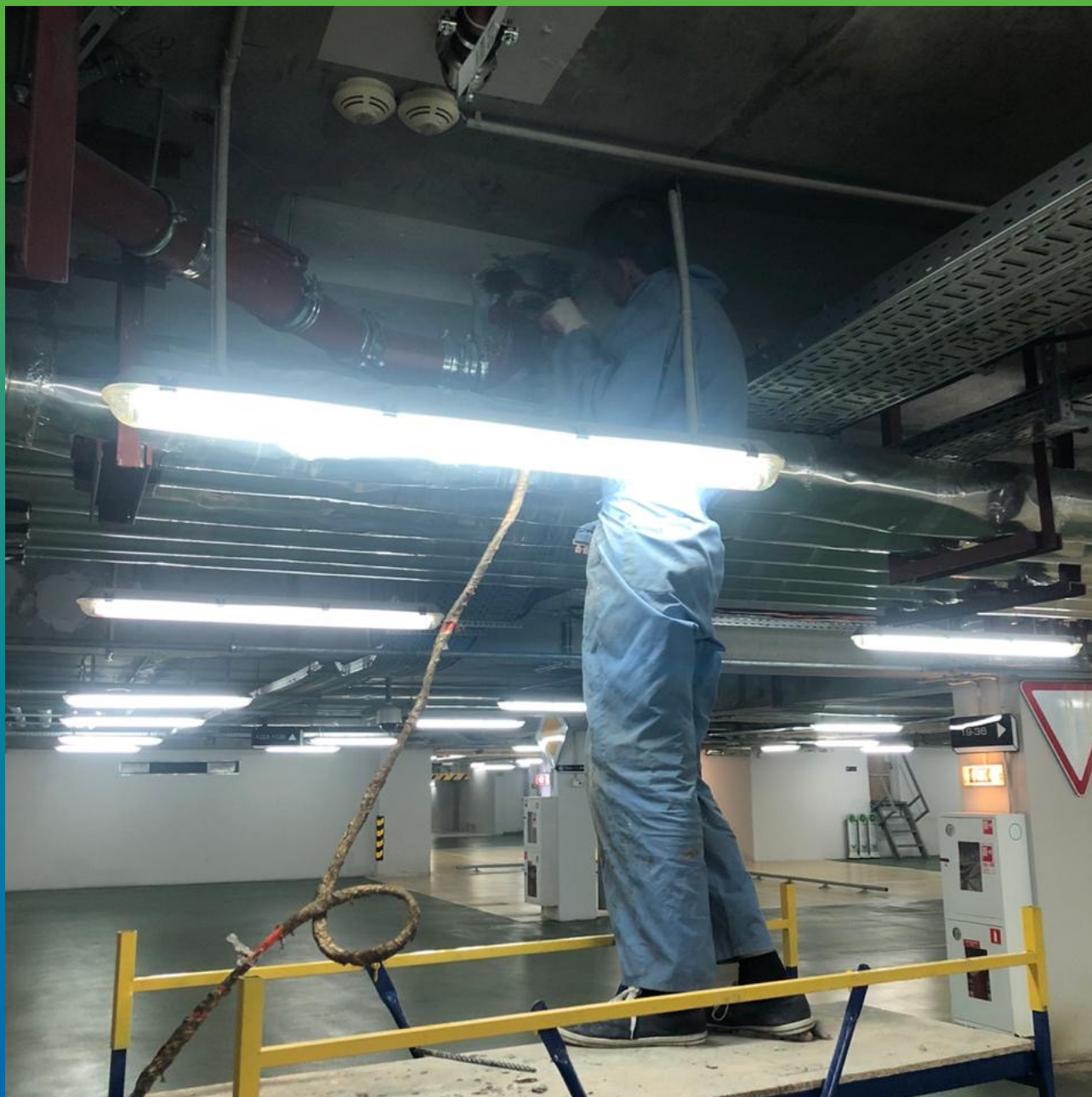
Инъектирование Манопур С с остановкой протечки Стармекс Плагом
