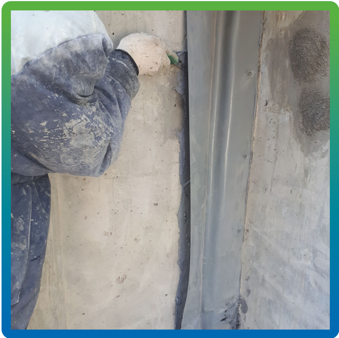
Нанесение клея Манопокс 331 для приклейки ленты в зоне деф. шва
