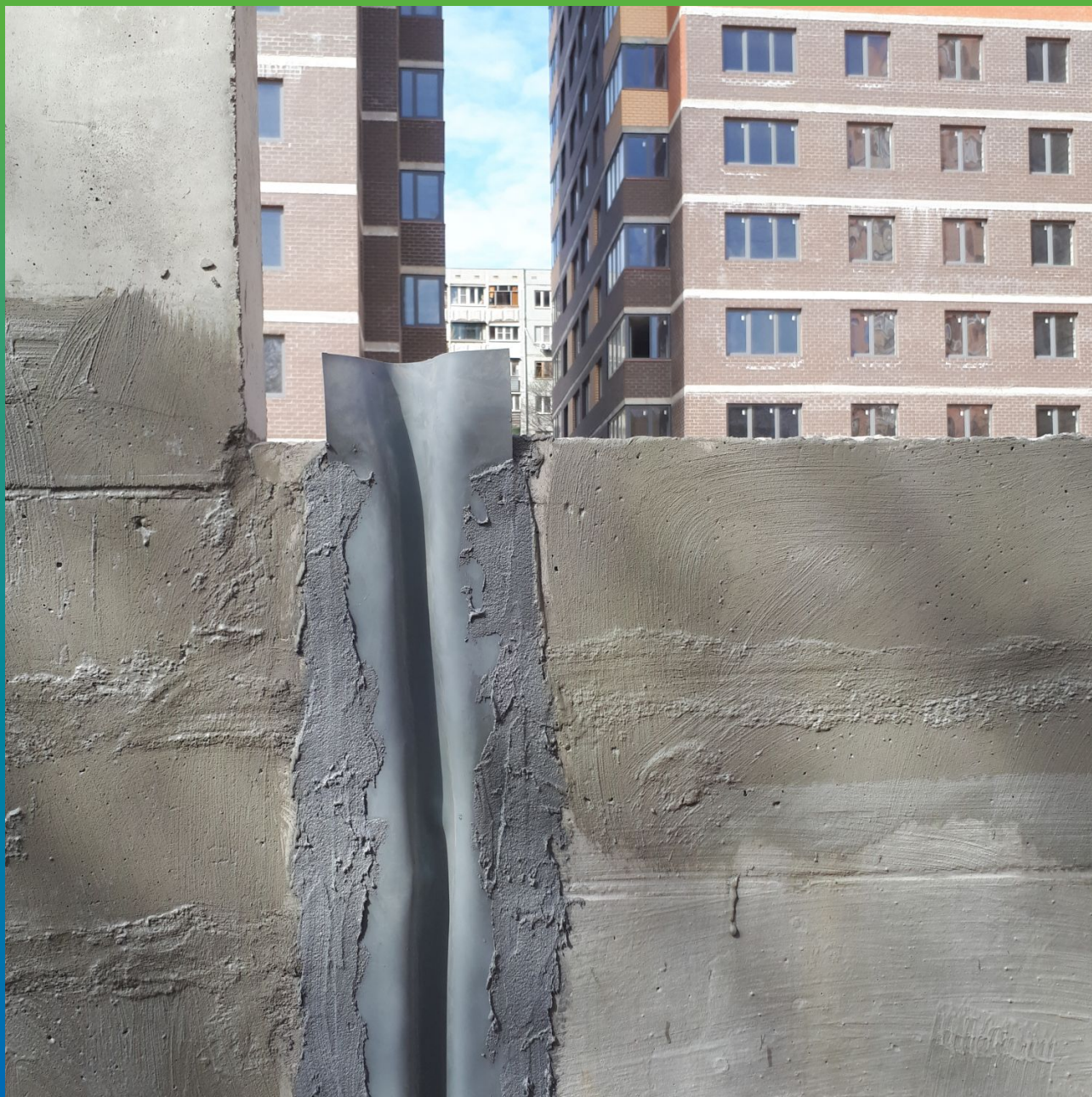
Выполненный участок деф. шва
