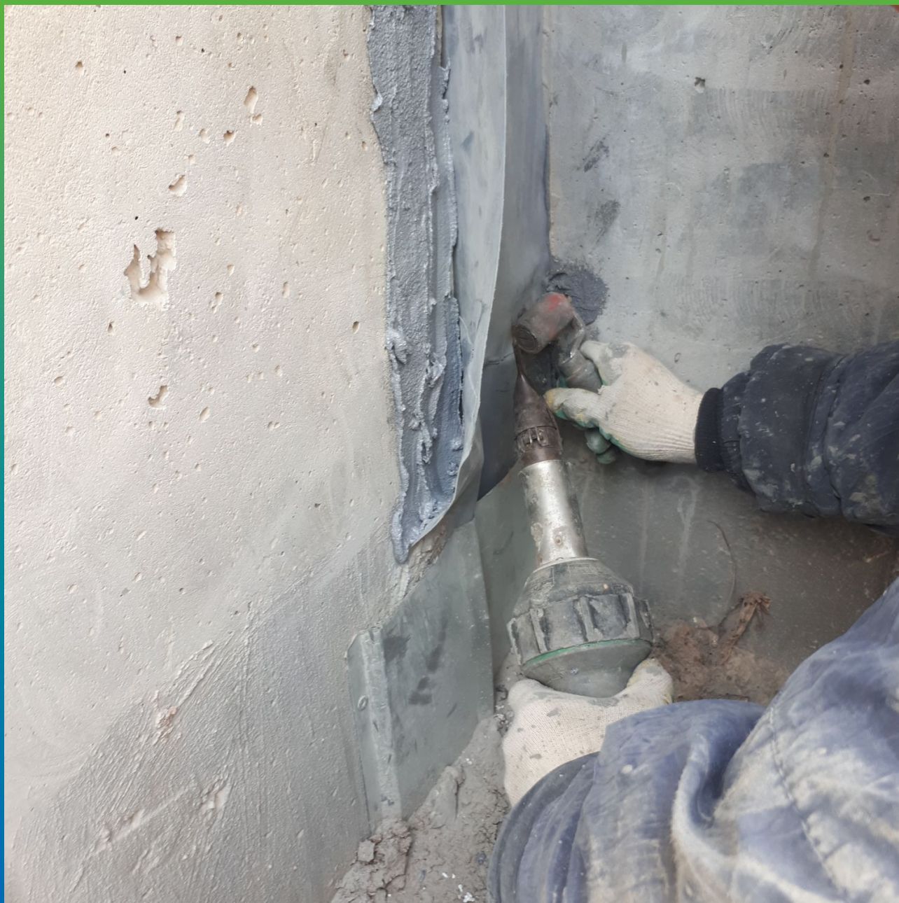
Сварка горячим воздухом двух лент Манодил Про между собой
