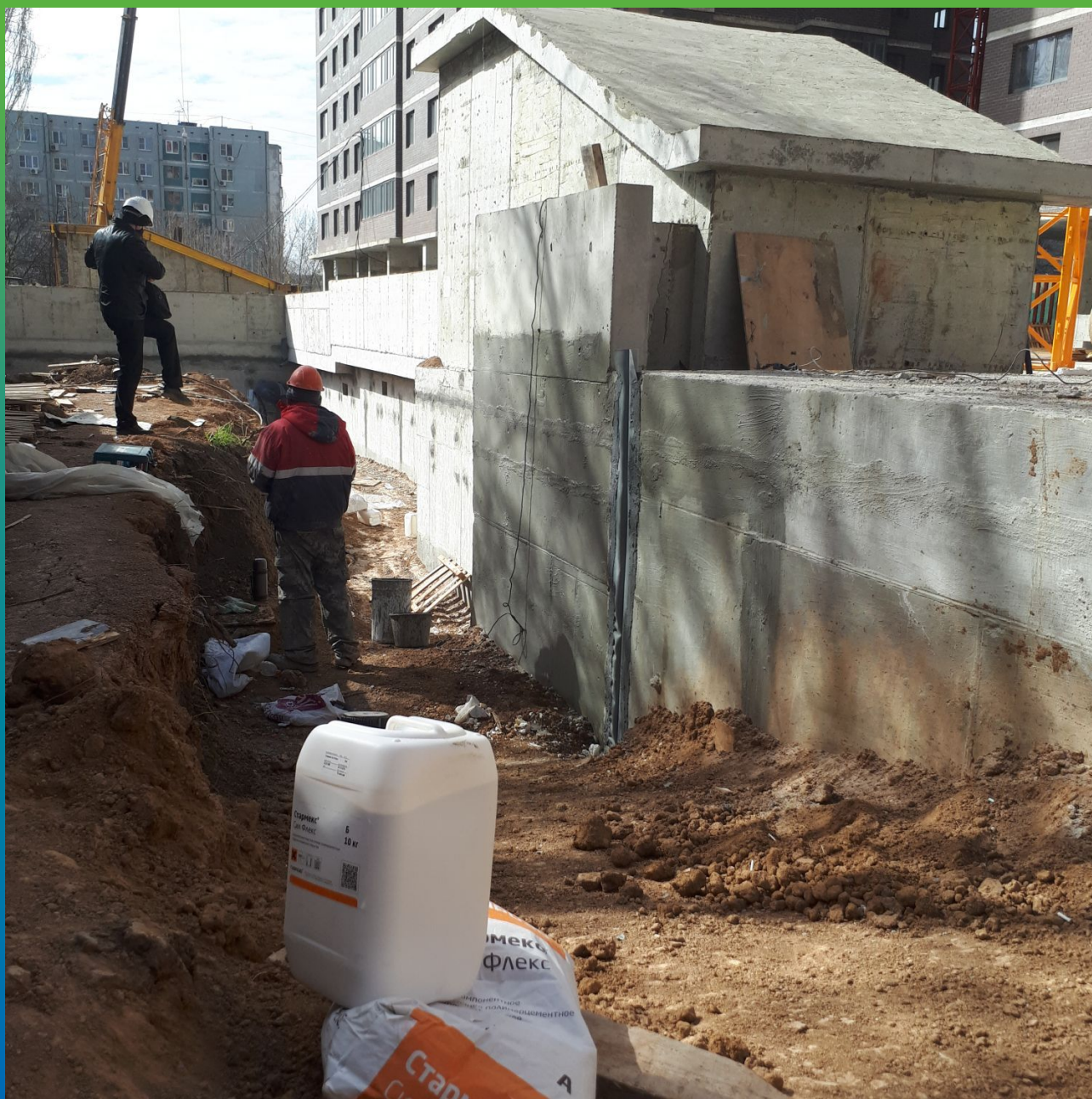
Эластичная гидроизоляция Стармекс Сил Флекс на объекте
