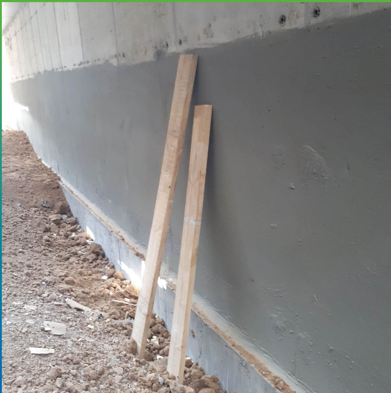
Выполненный участок стены составом Стармекс Сил Флекс
