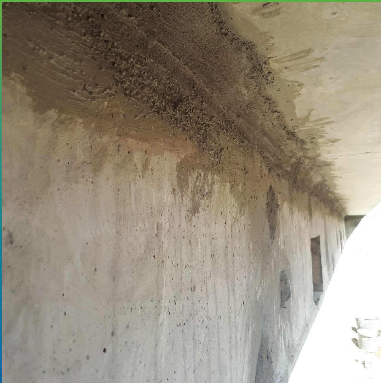
Зачеканенный холодный шов составом Стармекс РМЗ
