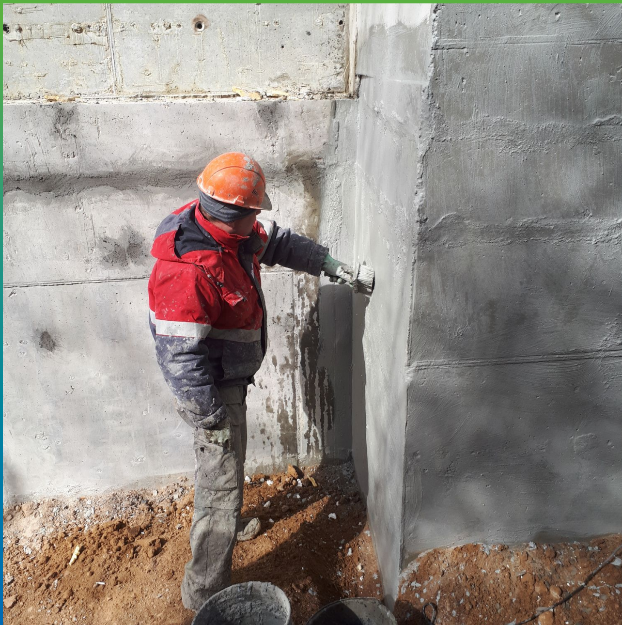
Покрытие стен трещиностойкой гидроизоляцией Стармекс Сил Флекс
