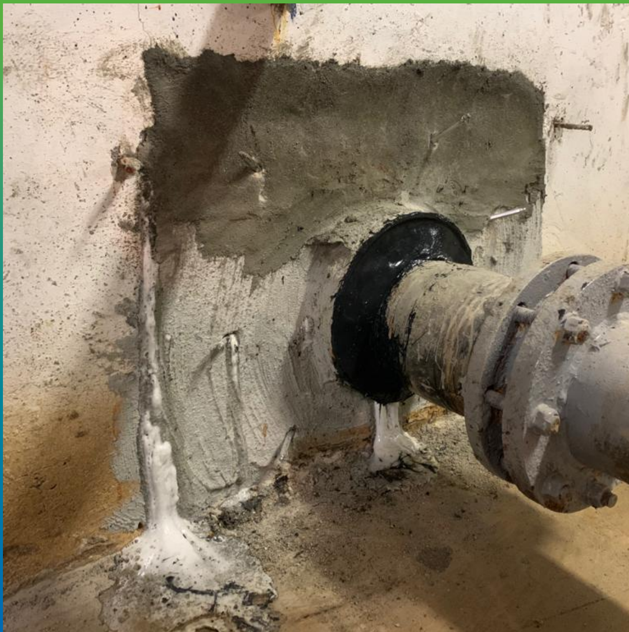
Монтаж пакеров для проведения работ по инъецированию.
