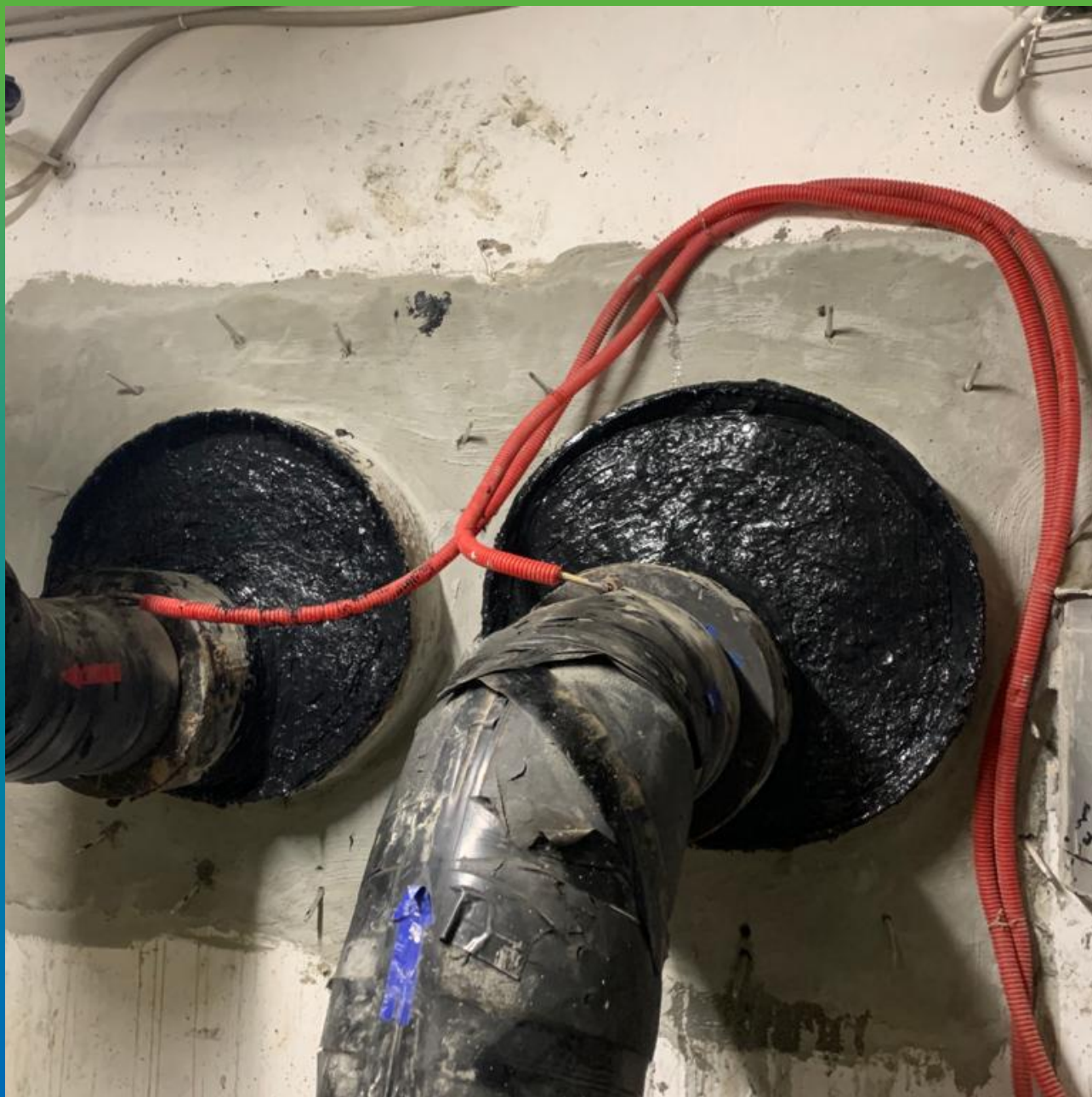
Герметизация ввода коммуникаций герметиком Манодил Бонд Ф
