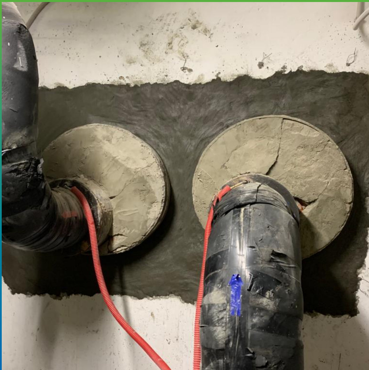
Восстановление защитного слоя бетона в зоне инъектирования.
