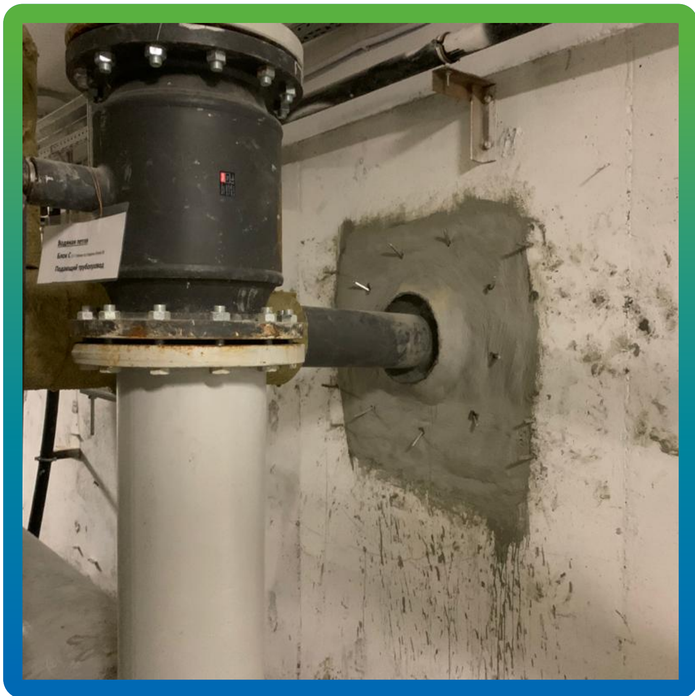
Инъектирование полиуретановым составом Манопур С
