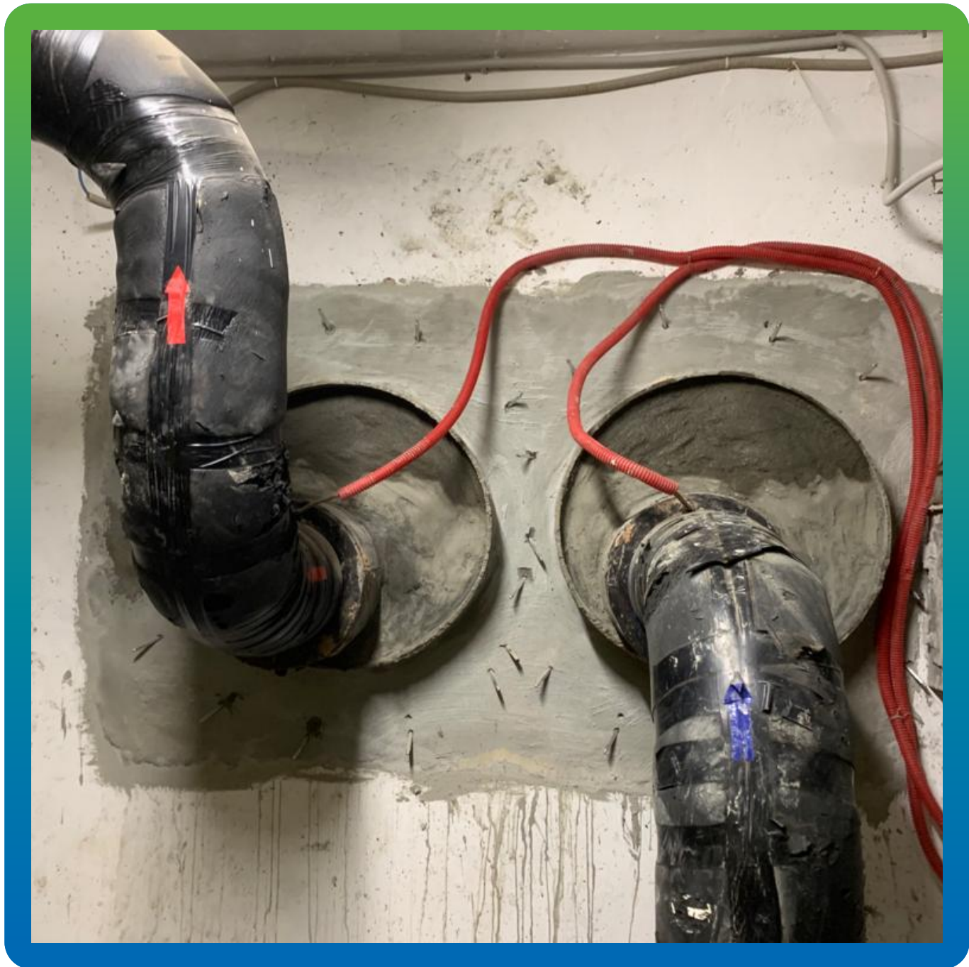
Инъектирование полиуретановым составом Манопур С
