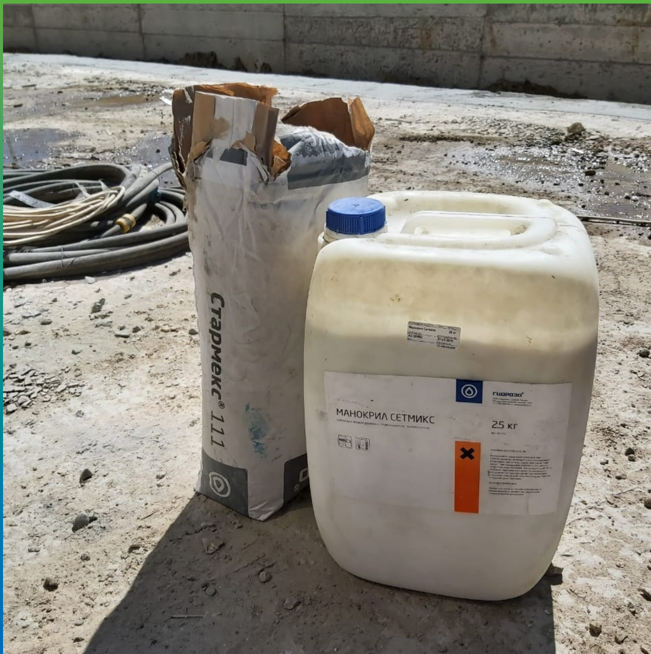
Материалы Гидрозо на объекте
