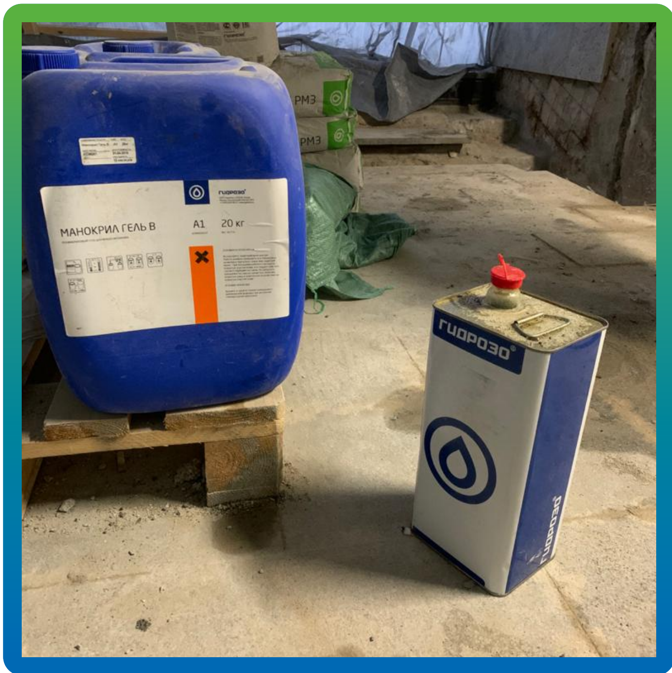
Инъекционные материалы на объекте
