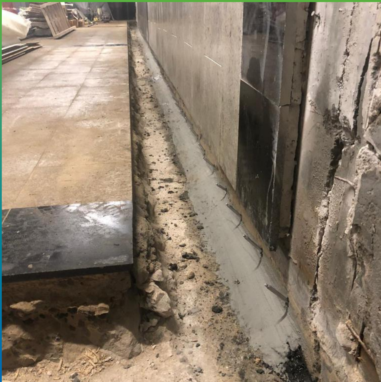
Устройство галтели, монтаж пакеров.
