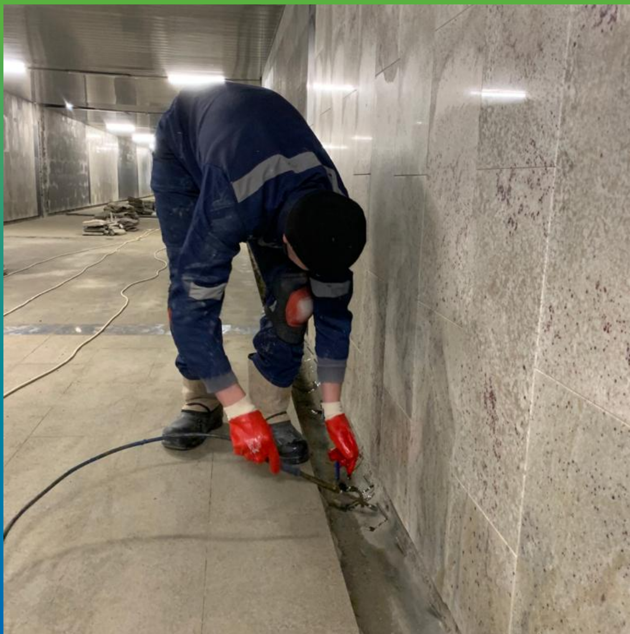
Выполнение работ по инъецированию холодных швов.
