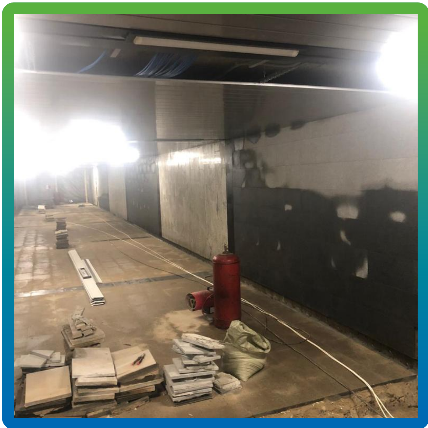
Устройство галтели, монтаж пакеров.
