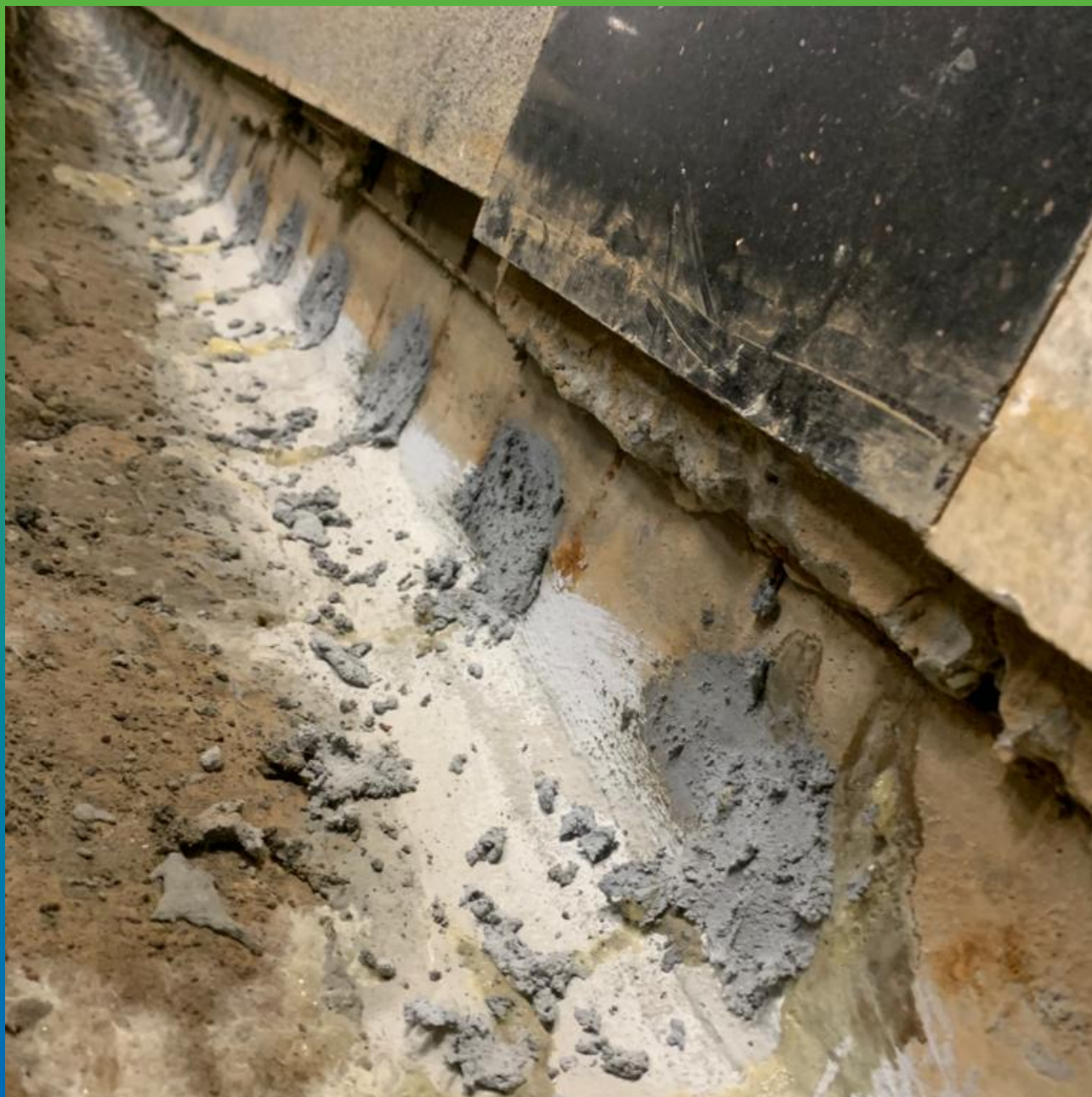
Демонтаж пакеров, зачеканка отверстий после демонтажа.
