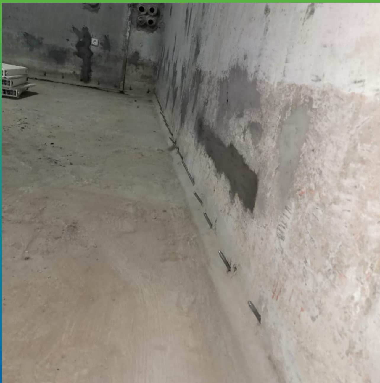
Устройство галтели, монтаж пакеров для инъектирования холодных швов.
