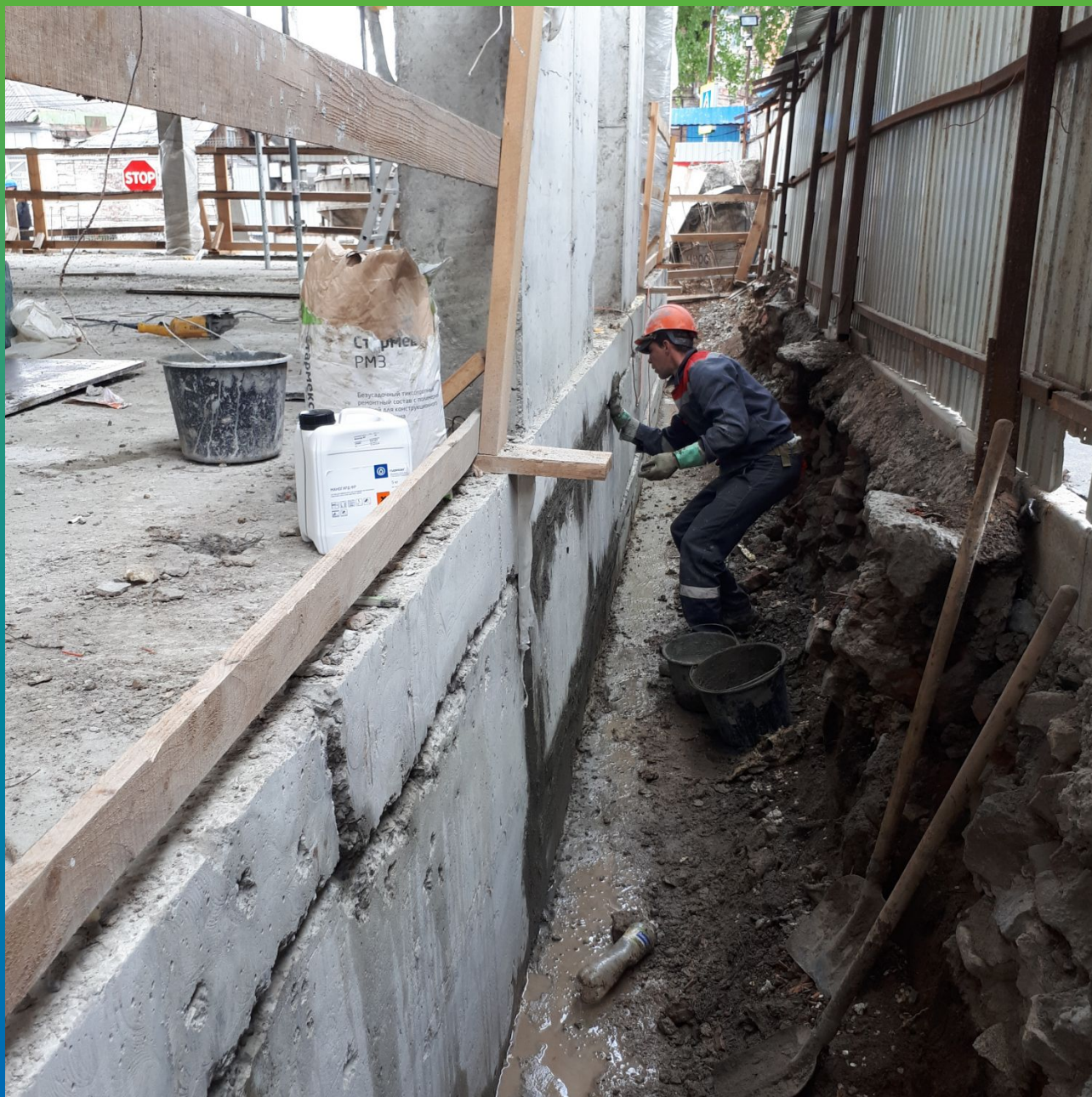
Чеканка холодных швов рем. составом Стармекс РМЗ
