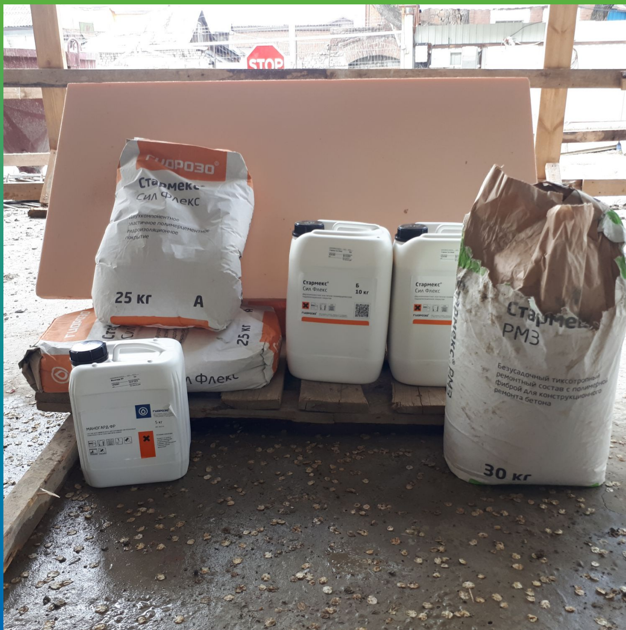
Материалы Гидрозо на объекте
