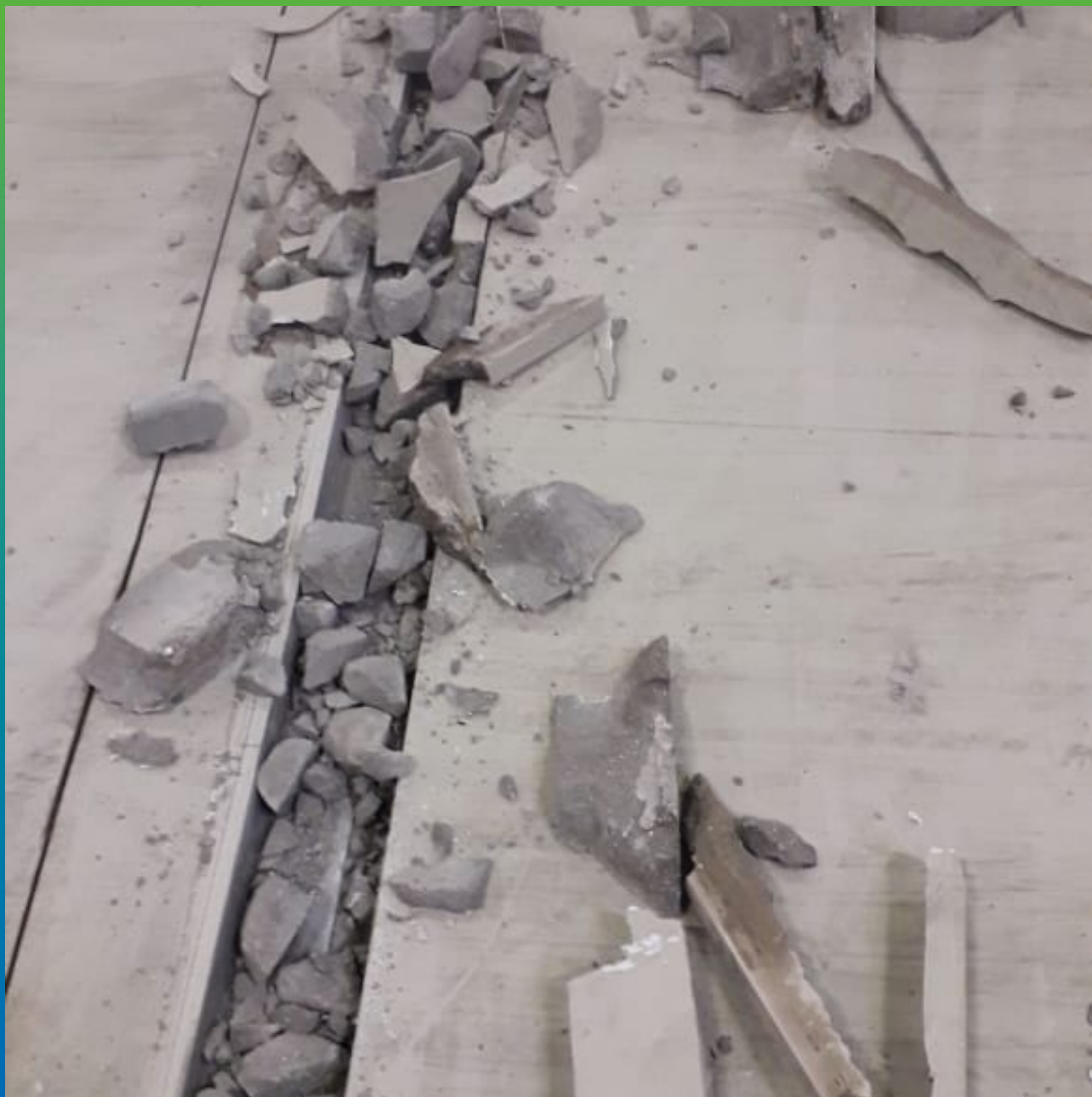
Демонтаж участков шва в зоне разрушения.
