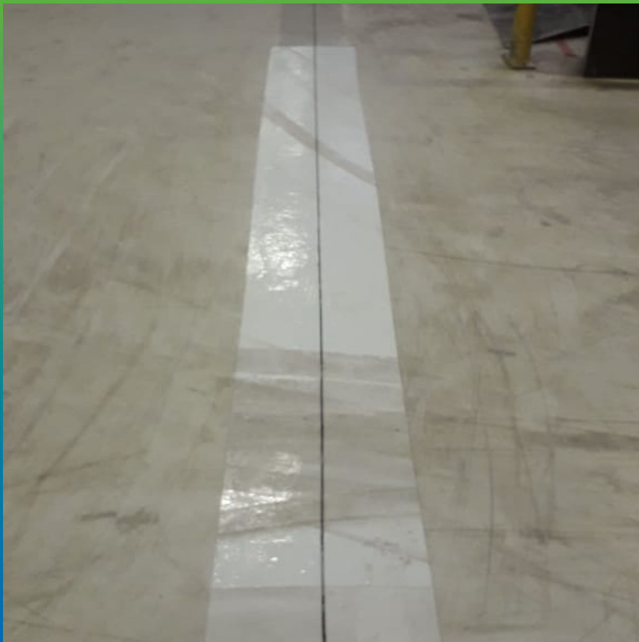
Отремонтированное покрытие пола в дальнейшей эксплуатации
