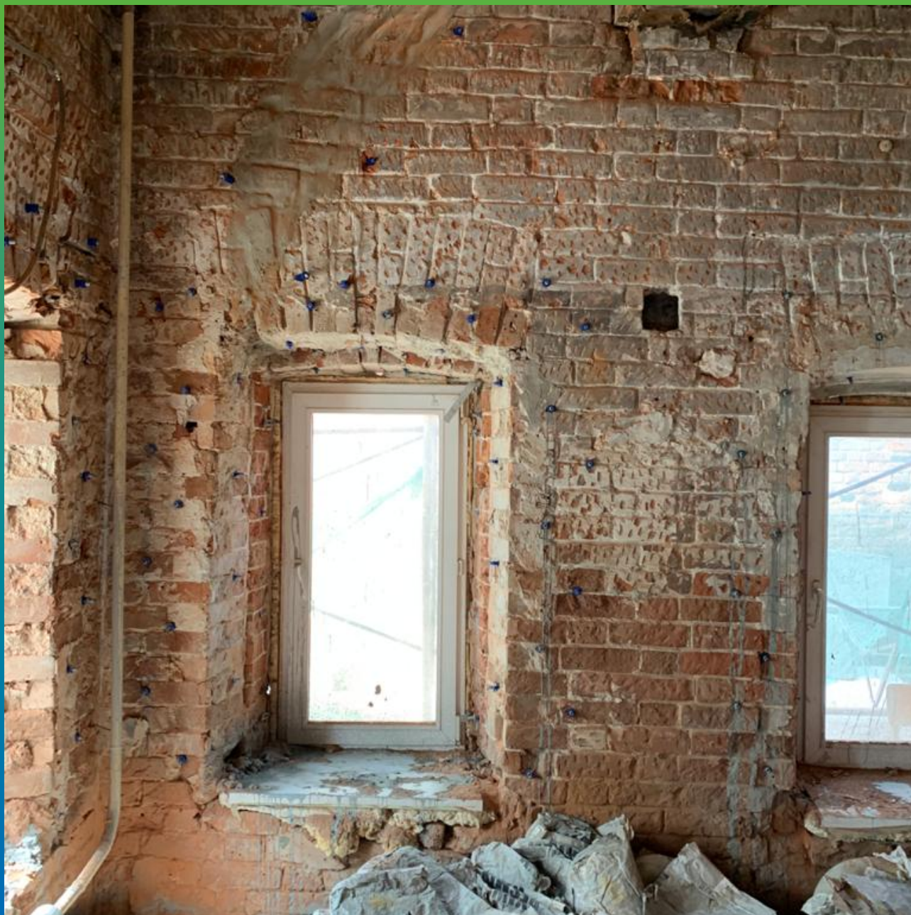
Монтаж пакеров для проведения работ по инъектированию.
