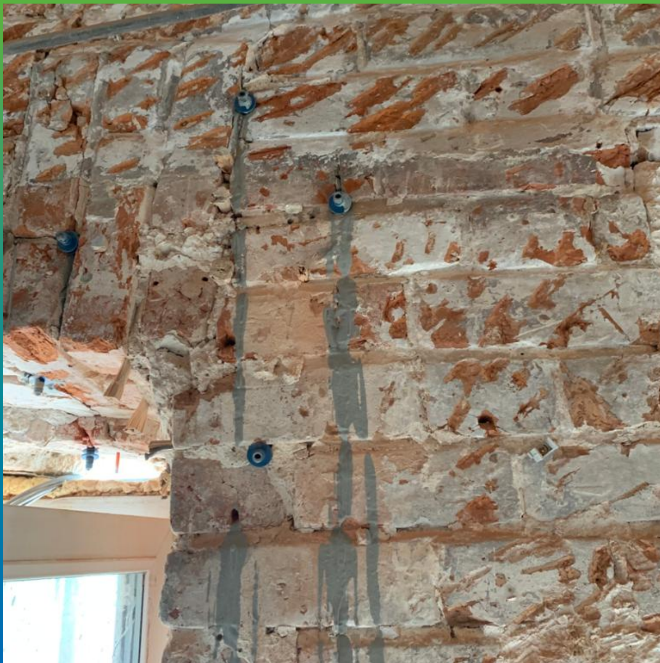
Монтаж пакеров для проведения работ по инъектированию.
