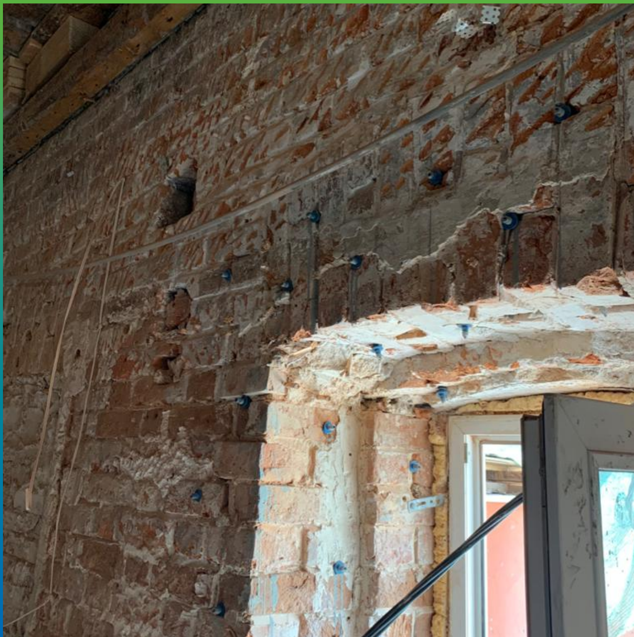
Монтаж пакеров для проведения работ по инъектированию.
