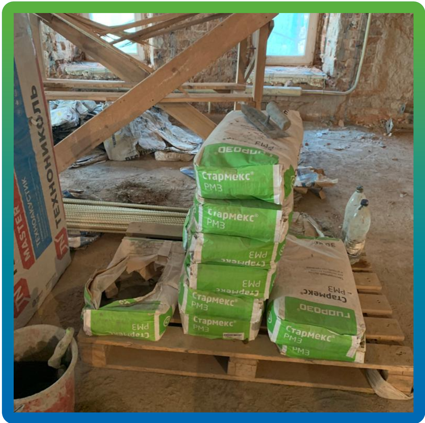
Применение состава Стармекс РМЗ для оштукатуривания стен.
