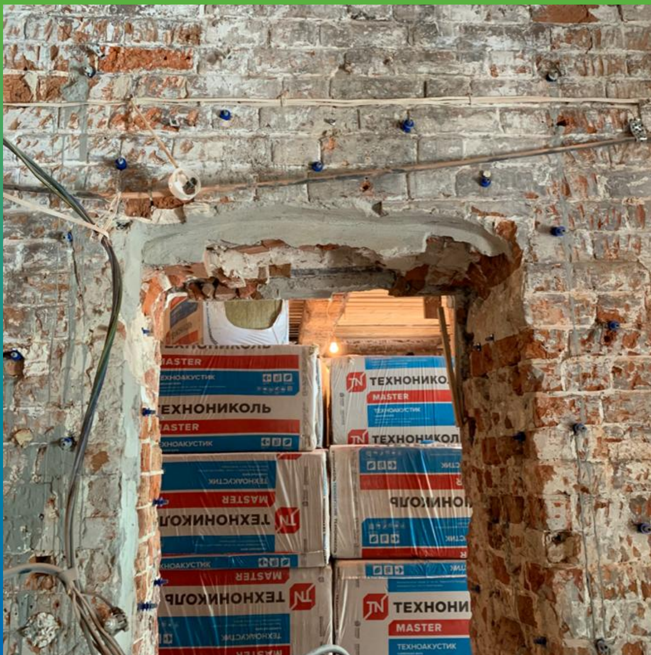
Монтаж пакеров для проведения работ по инъектированию.
