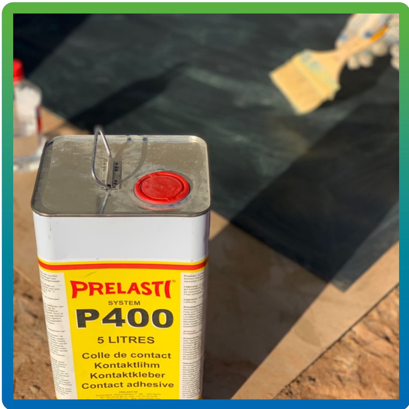
Нанесение Адгезива П400.
