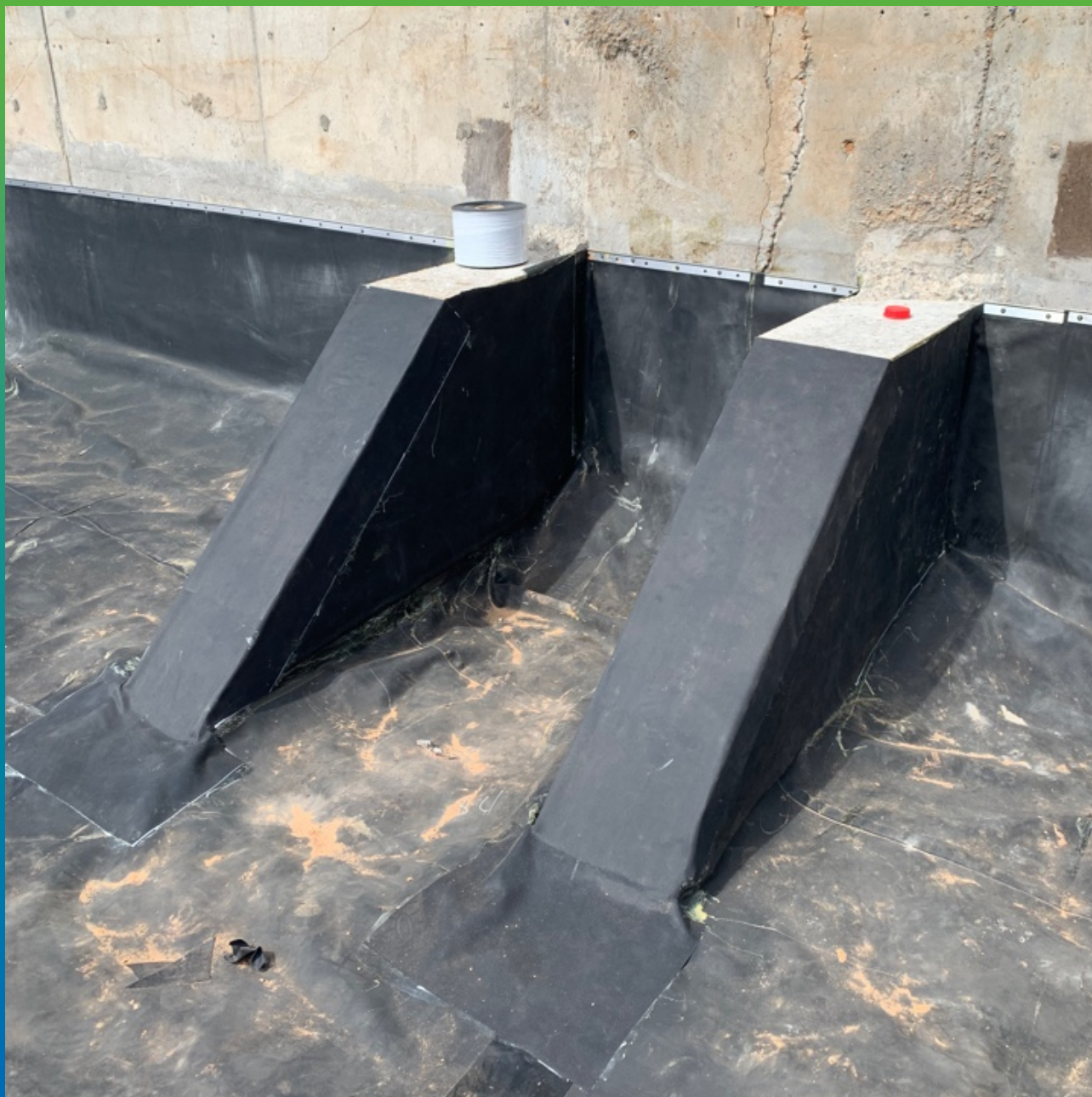
Контрфорсы с монтированной мембраной Прелести СТ.
