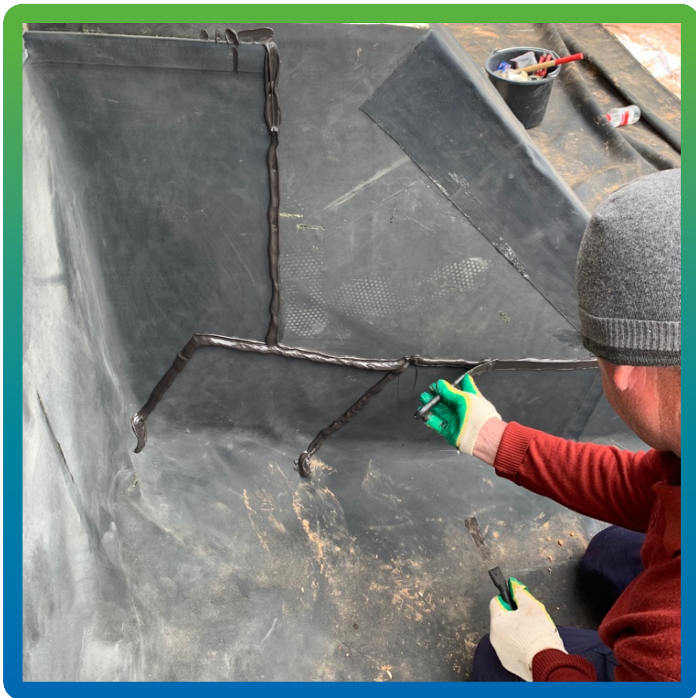
Нанесение Манодил Бонд Ф на стыковые швы.
