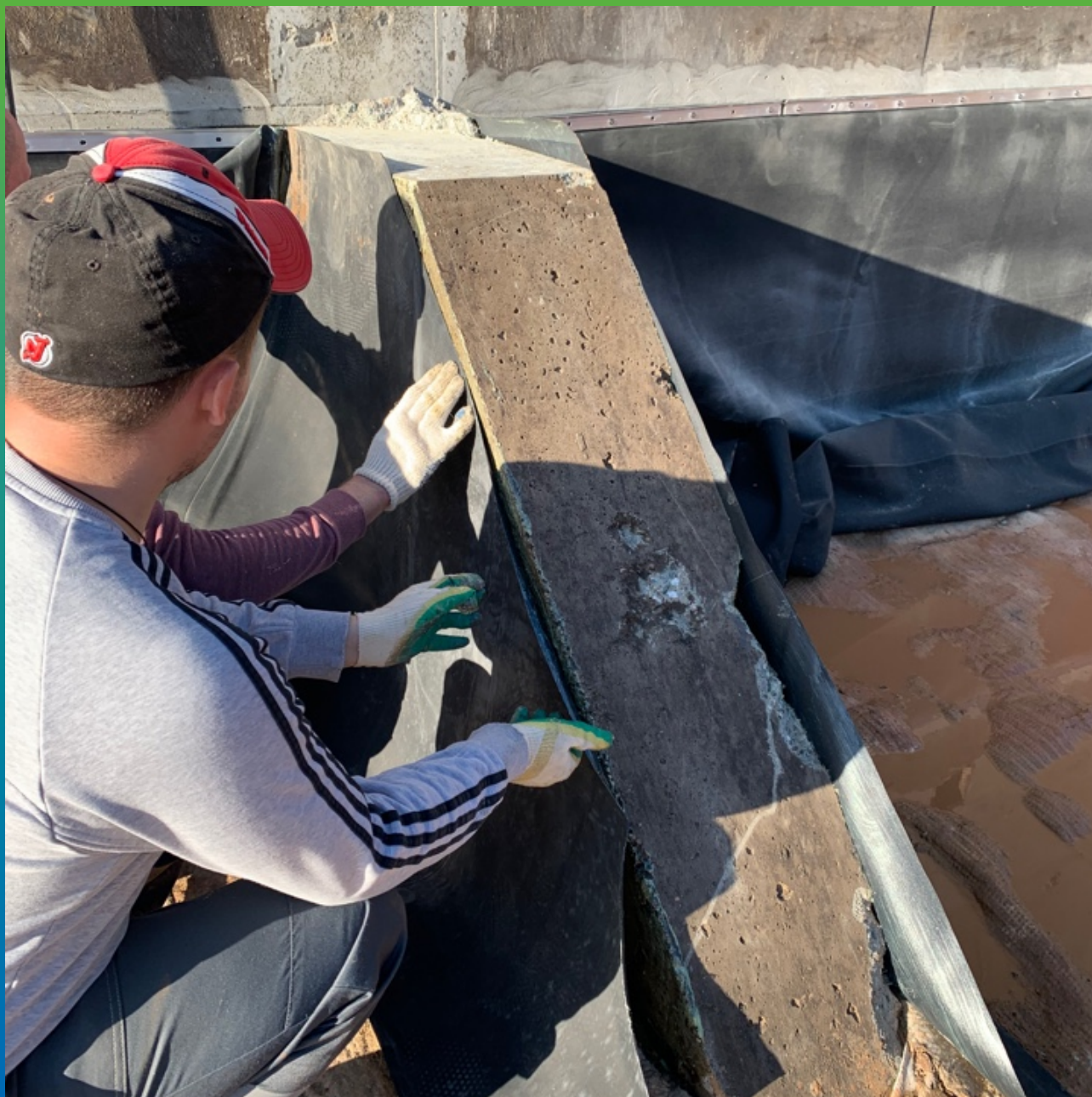
Приклеивание ЭПДМ мембраны Прелести СТ к контрфорсам.
