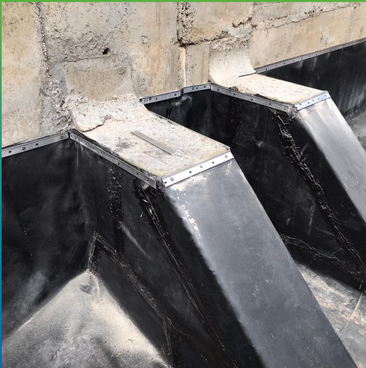
Контрфорсы с монтированной мембраной Преласта СТ.
