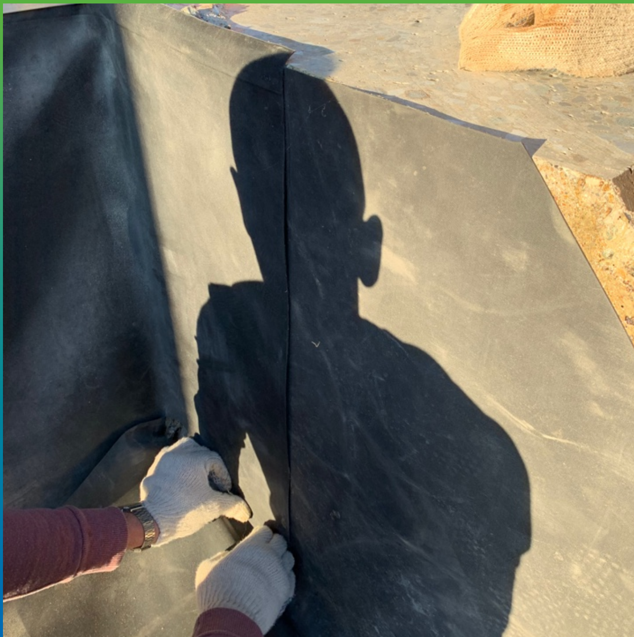
Приклеивание ЭПДМ мембраны Прелести СТ к контрфорсам.
