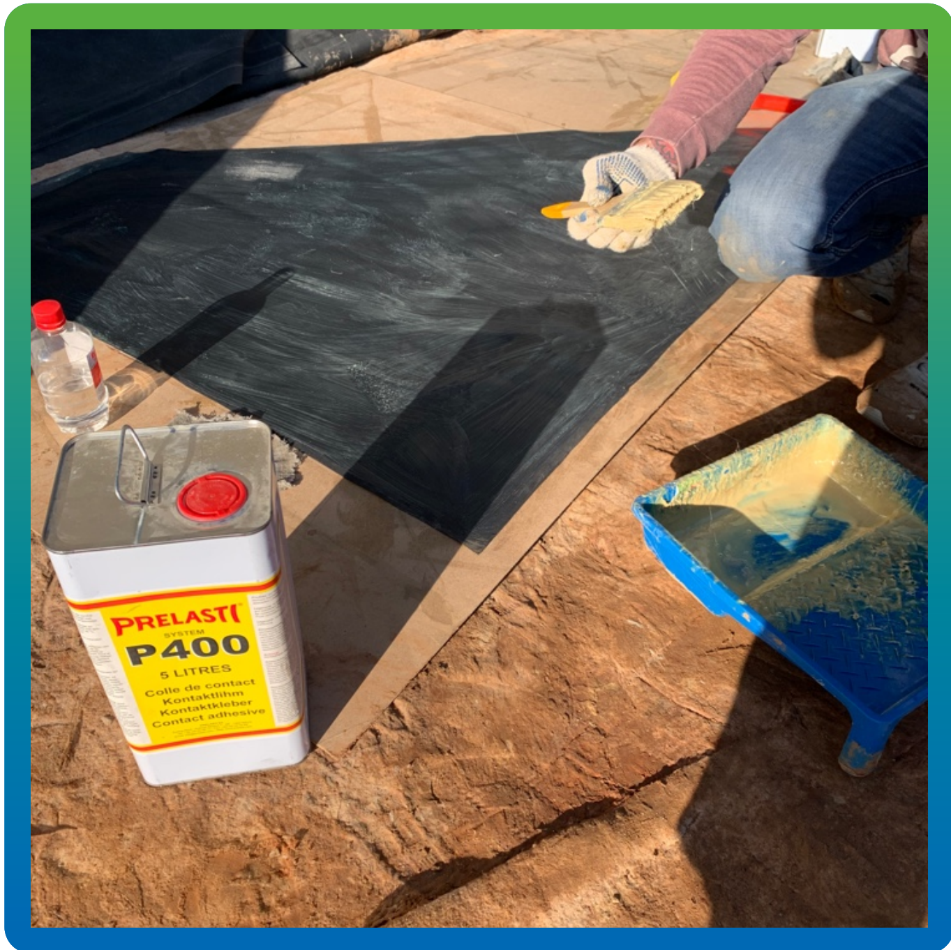
Нанесение Адгезива П400.
