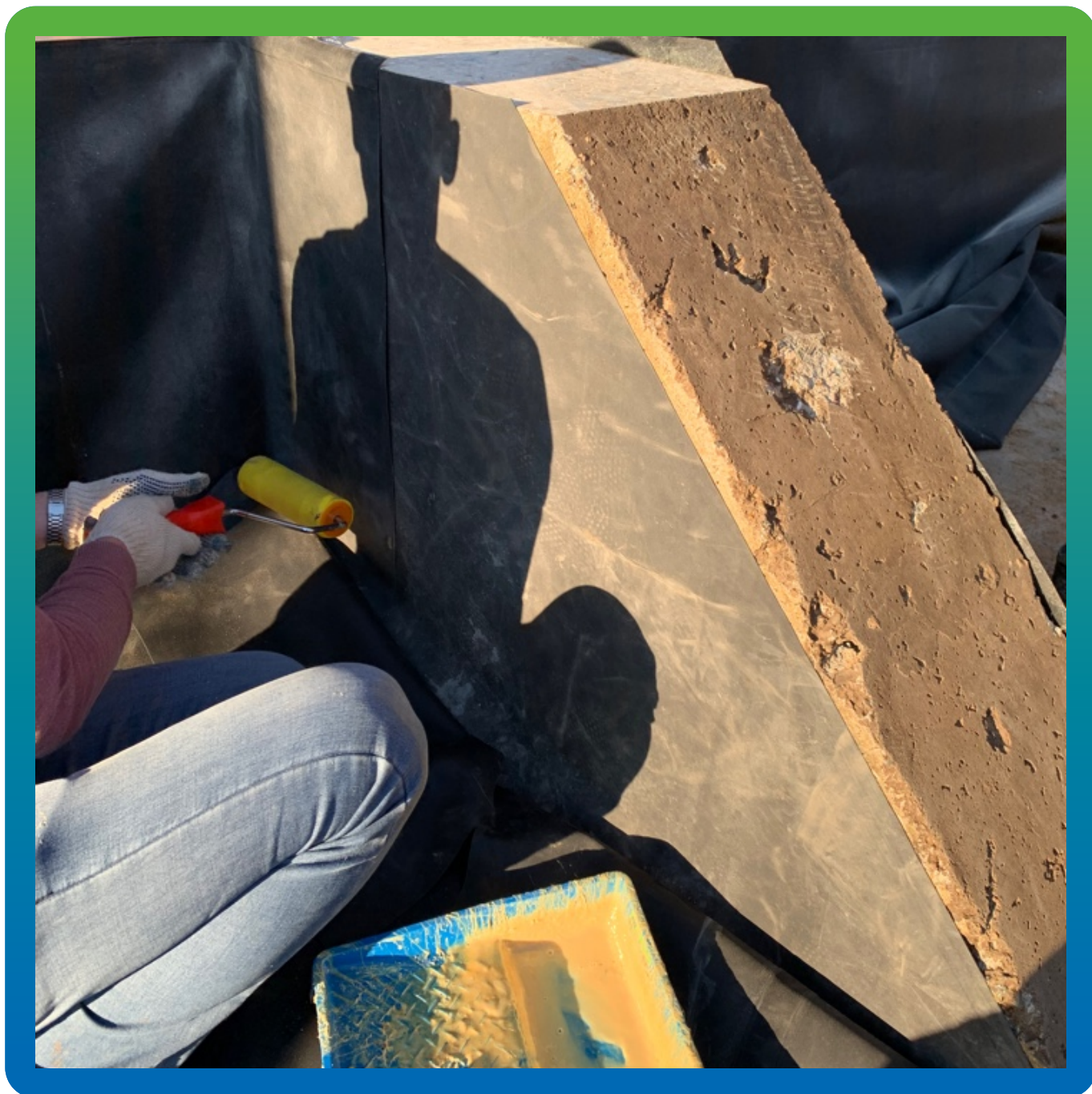
Приклеивание ЭПДМ мембраны Преласты СТ к контрфорсам.
