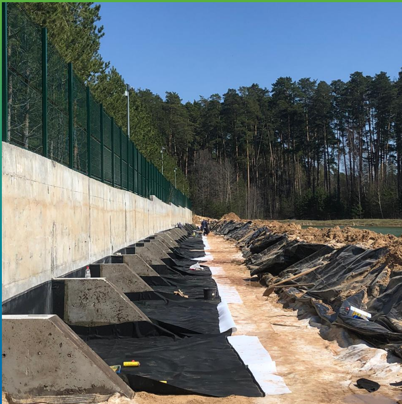
Монтаж полотен Прелести СТ на подпорную стену.
