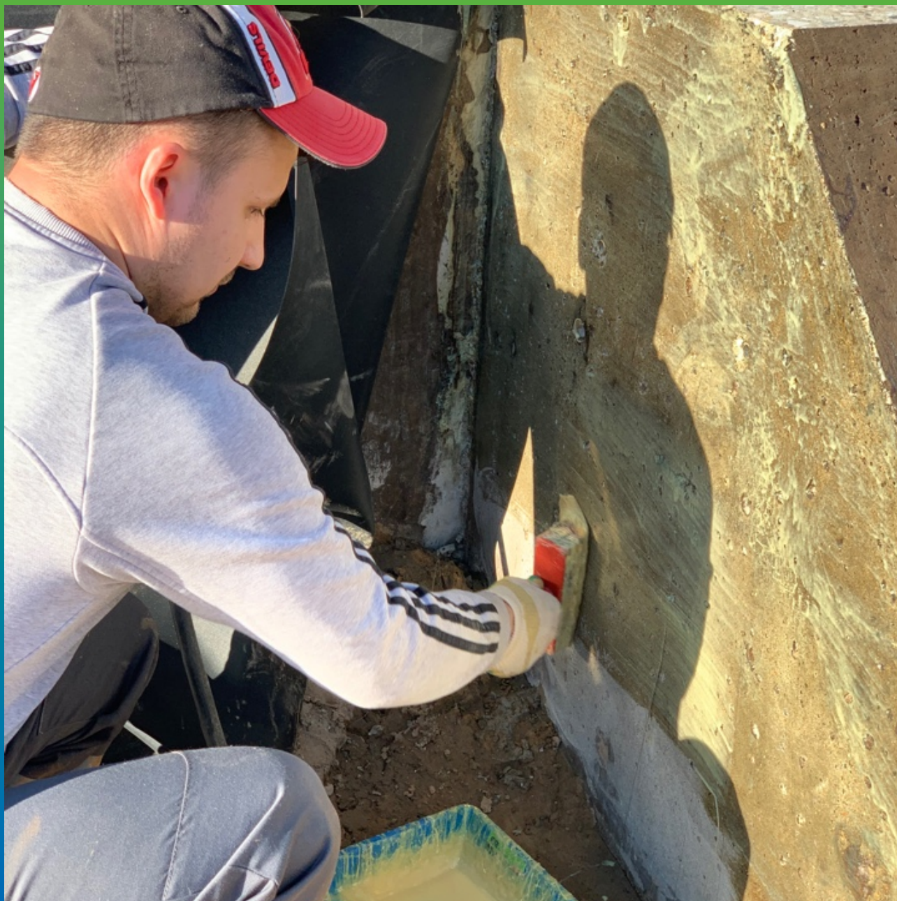
Нанесение Адгезива П400 на контрфорс
