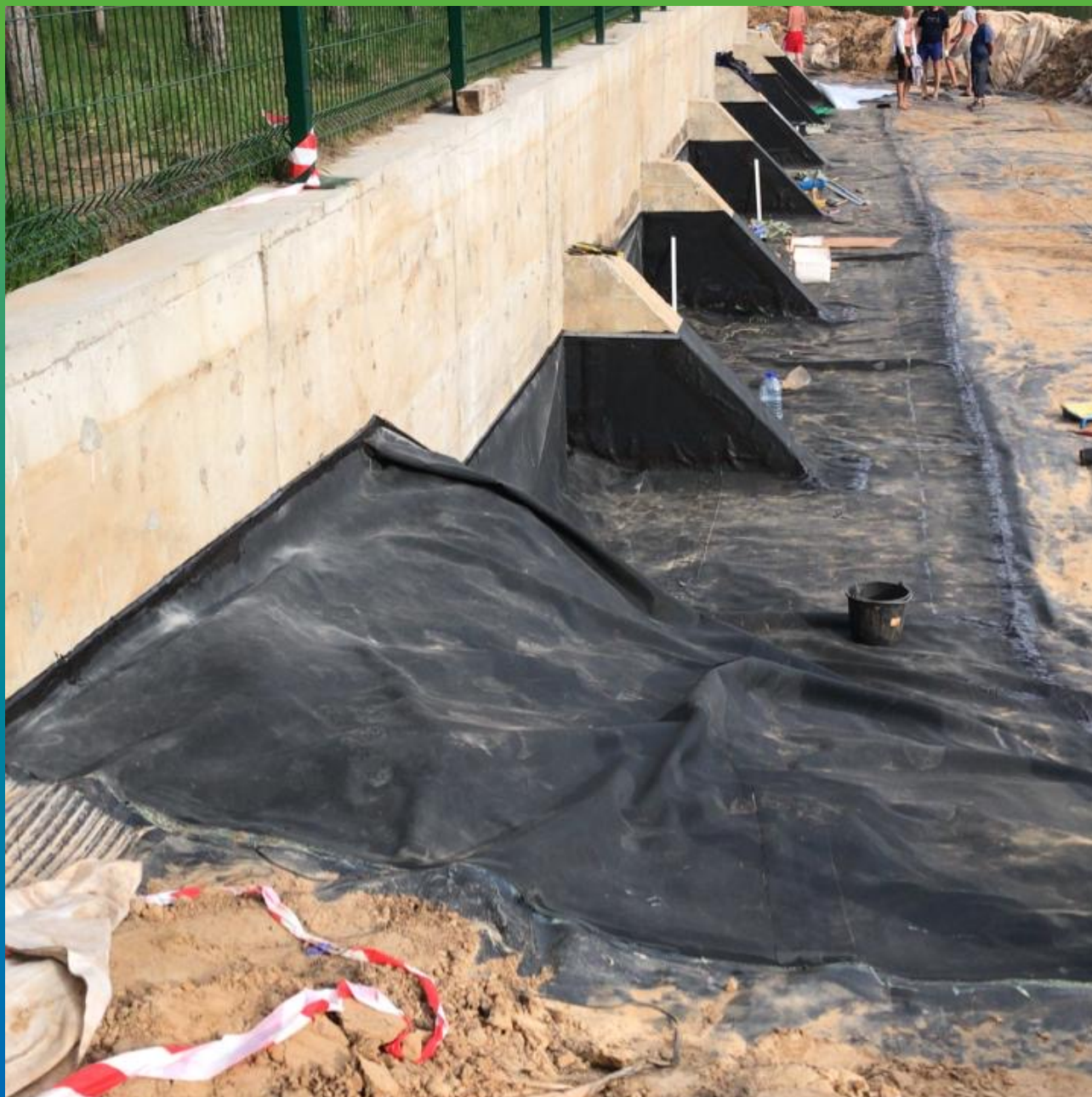
Соединенные полотна ЭПДМ и ПВХ.
