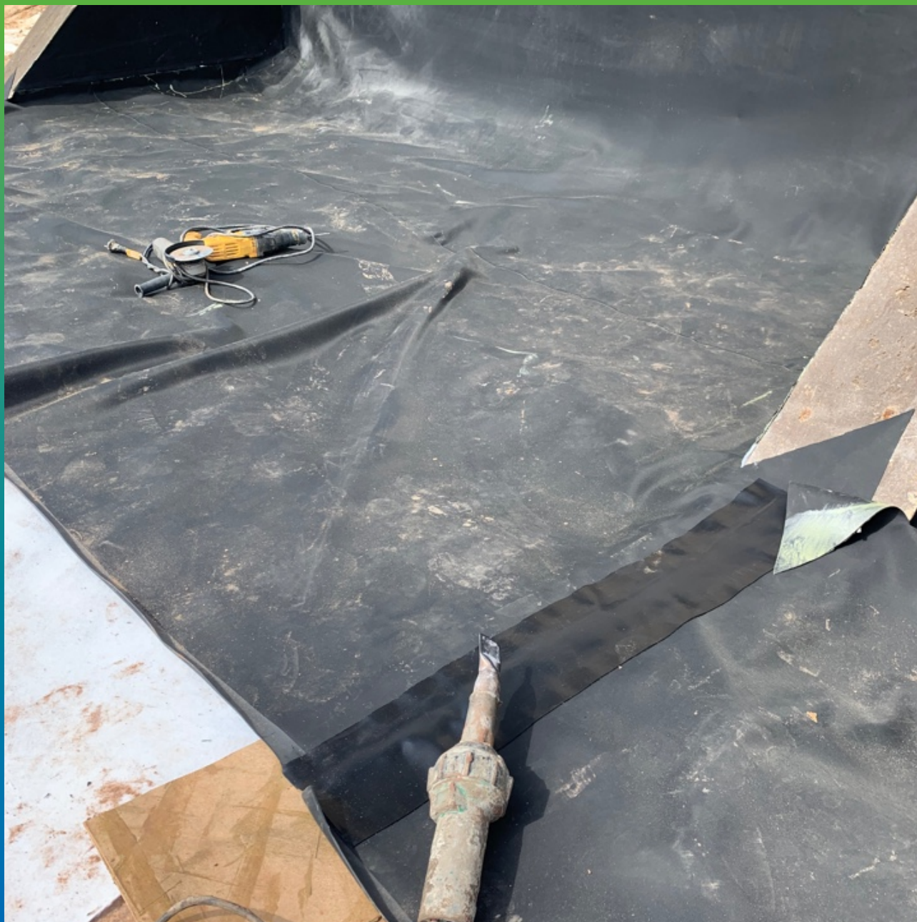
Сварка горячим воздухом полотен мембраны с помощью ленты Термобонд.
