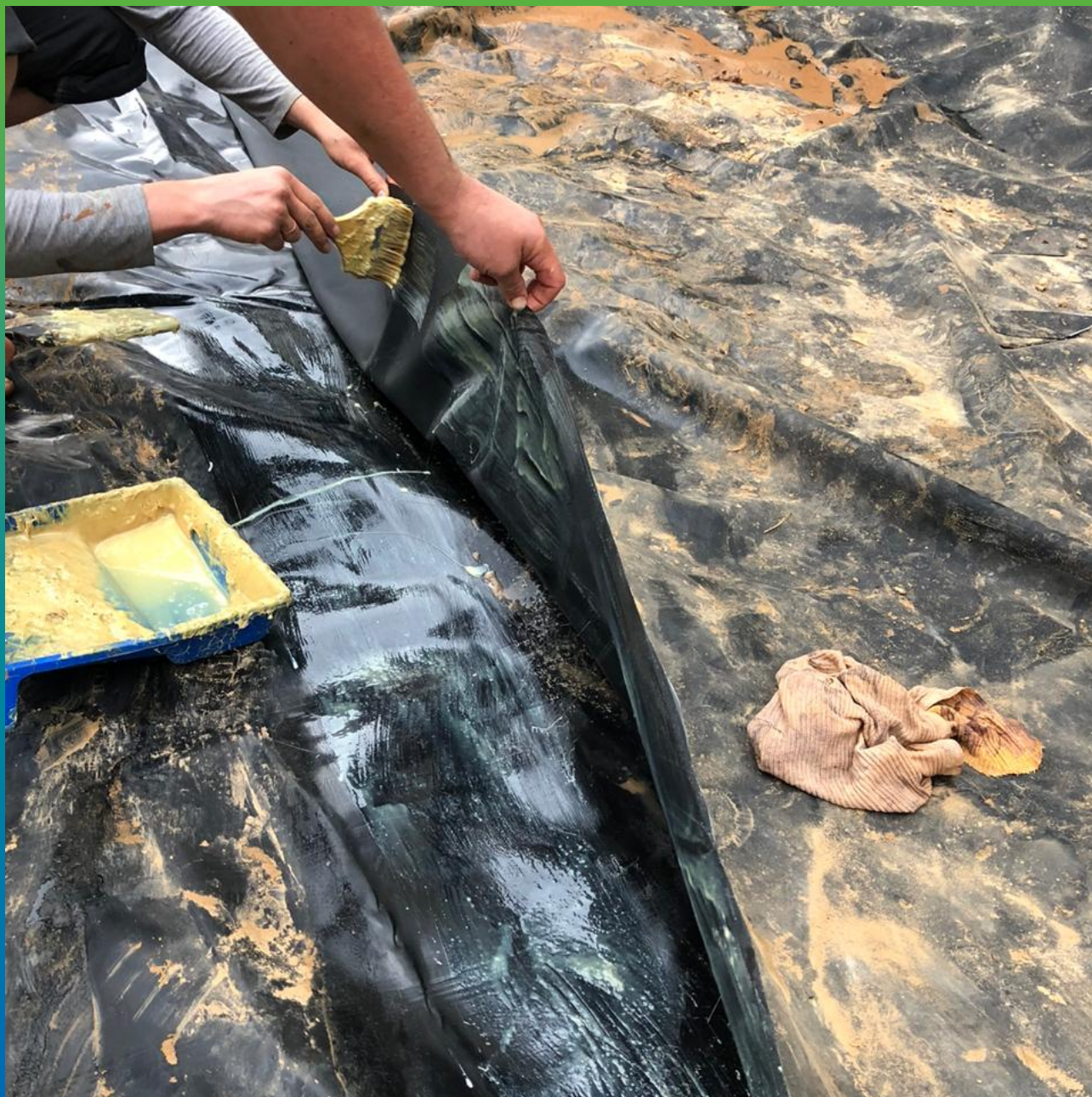
Соединение старого гидроизоляционного покрытия и Прелести СТ на адгезив П400 и Манодил Бонд Ф.
