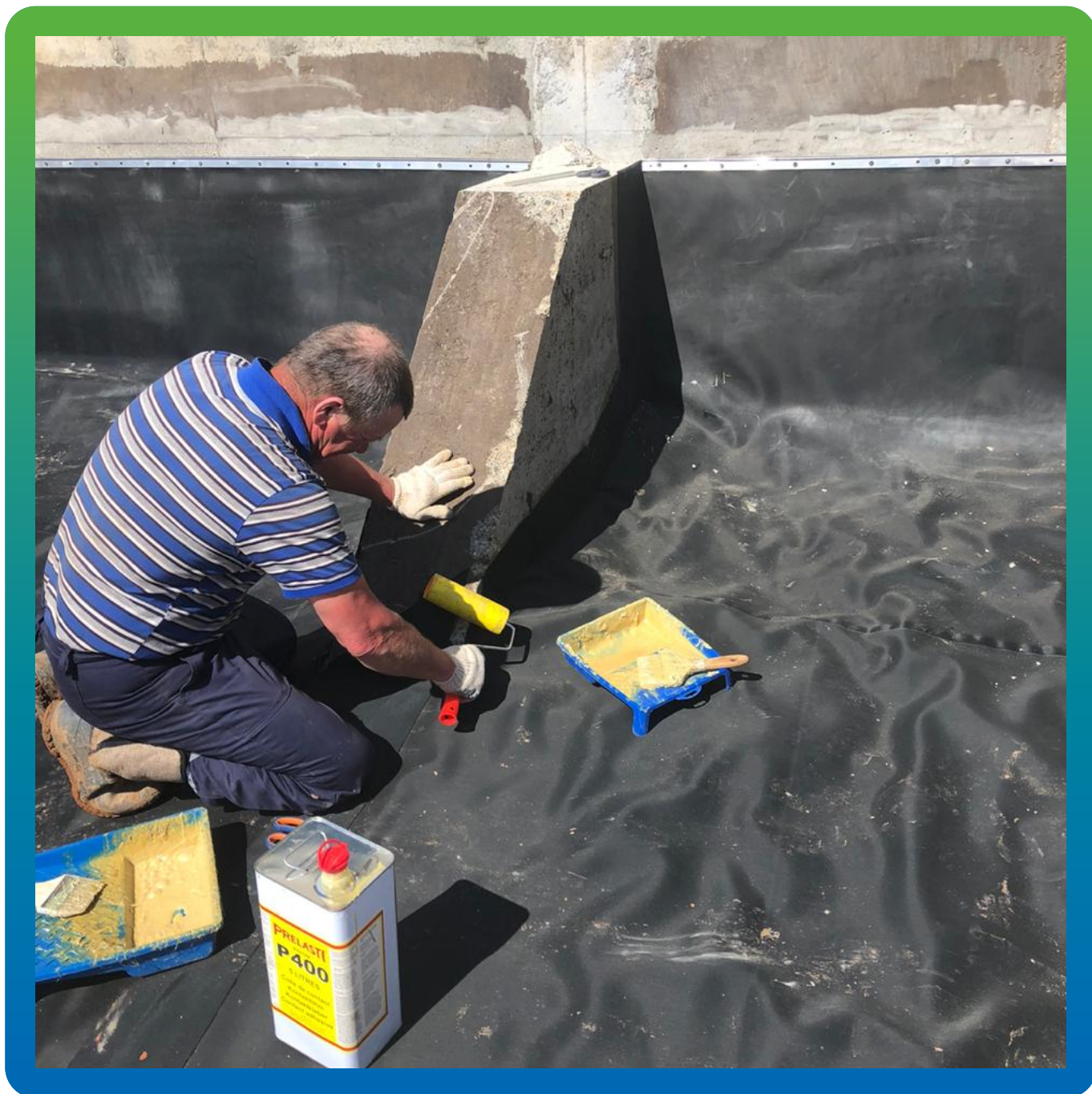
Приклеивание ЭПДМ мембраны Преласты СТ к торцевой стене контрфорсов.
