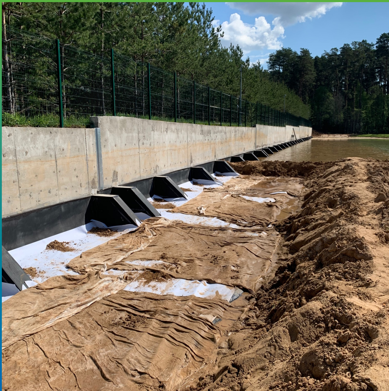
Обратная засыпка для подведения воды к подпорной стенке.
