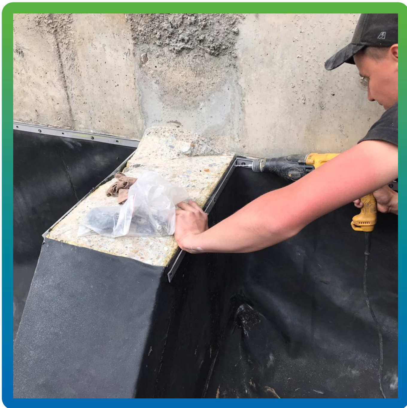
Фиксация Преласты СТ с помощью краевой рейки.
