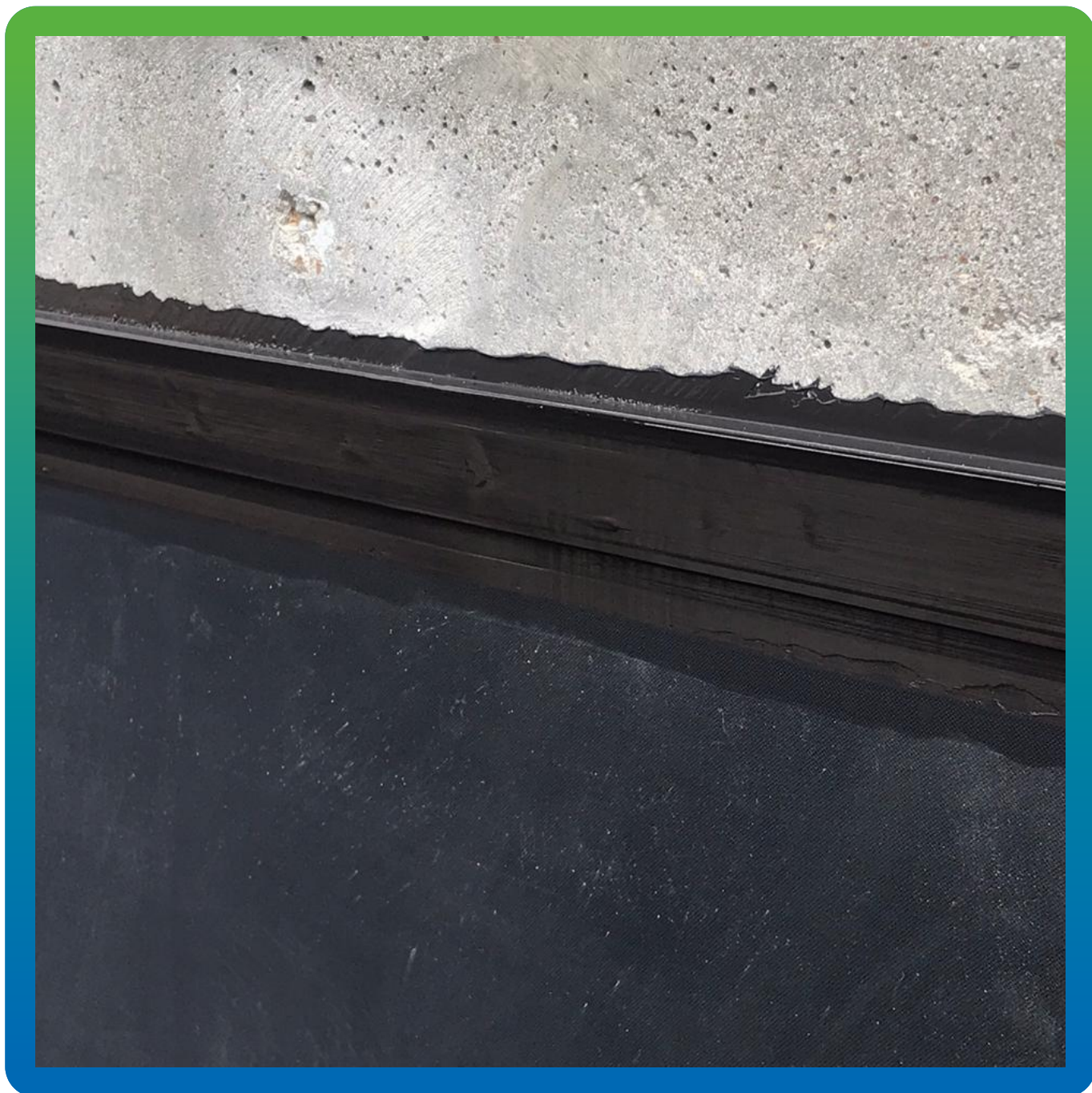
Верхняя краевая рейка с нанесенным слоем Манодил Бонд Ф.
