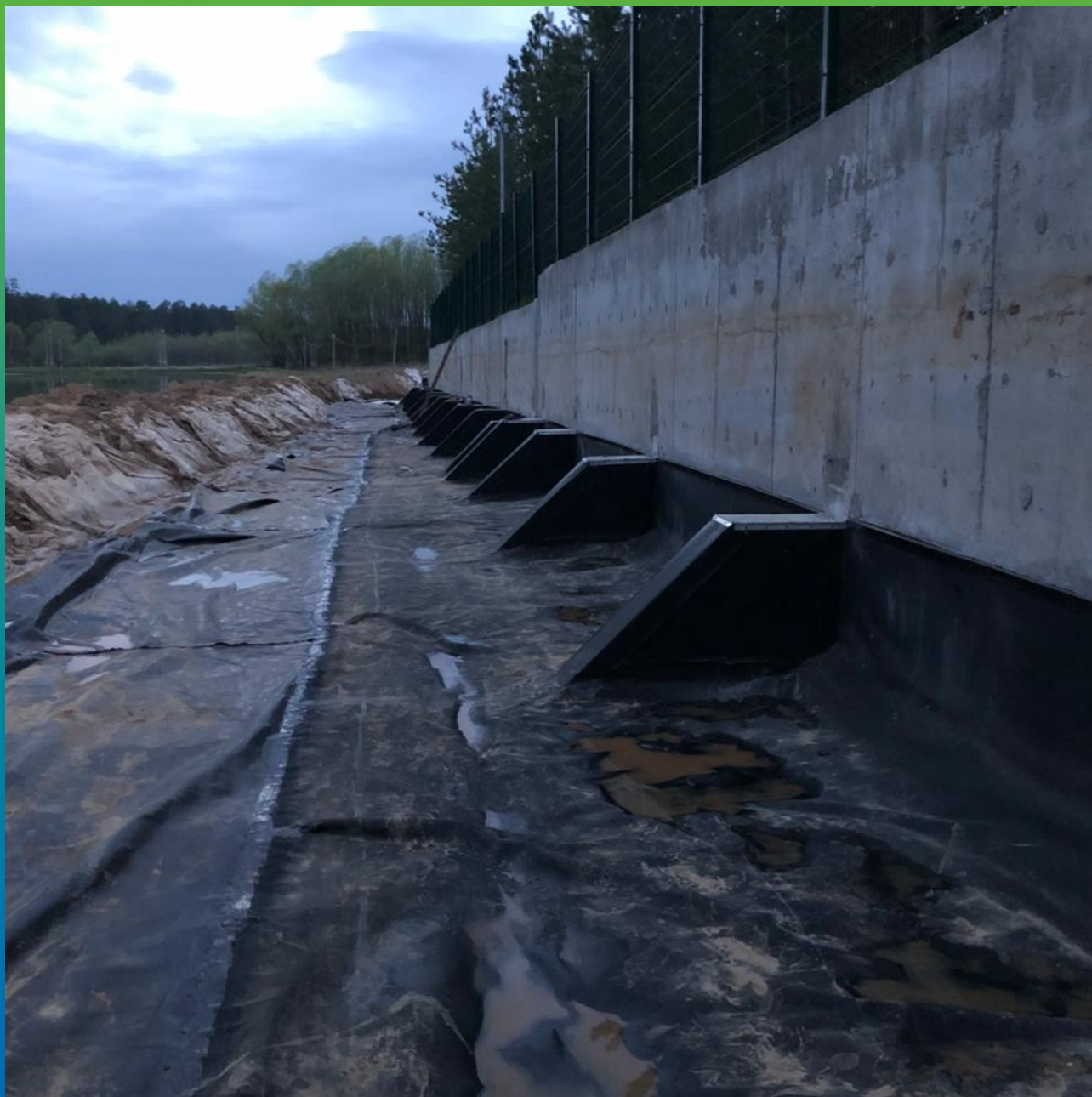
Соединенные полотна ЭПДМ и ПВХ.
