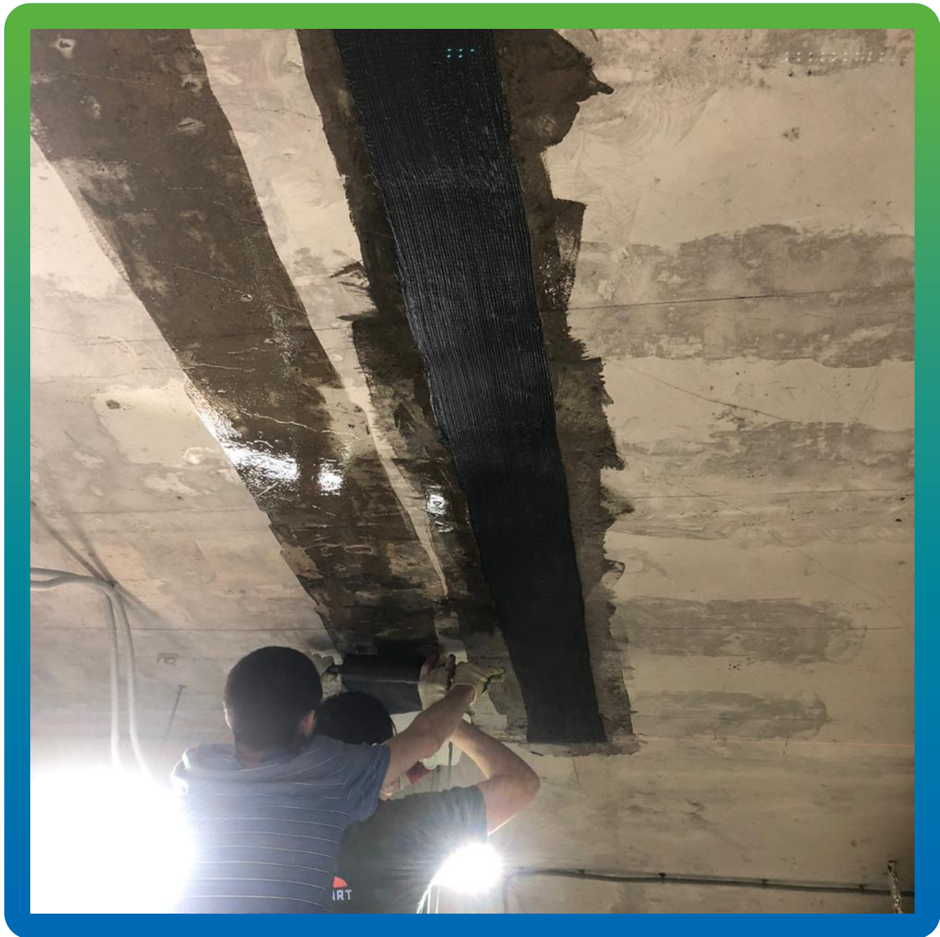
Монтаж системы Армошел
