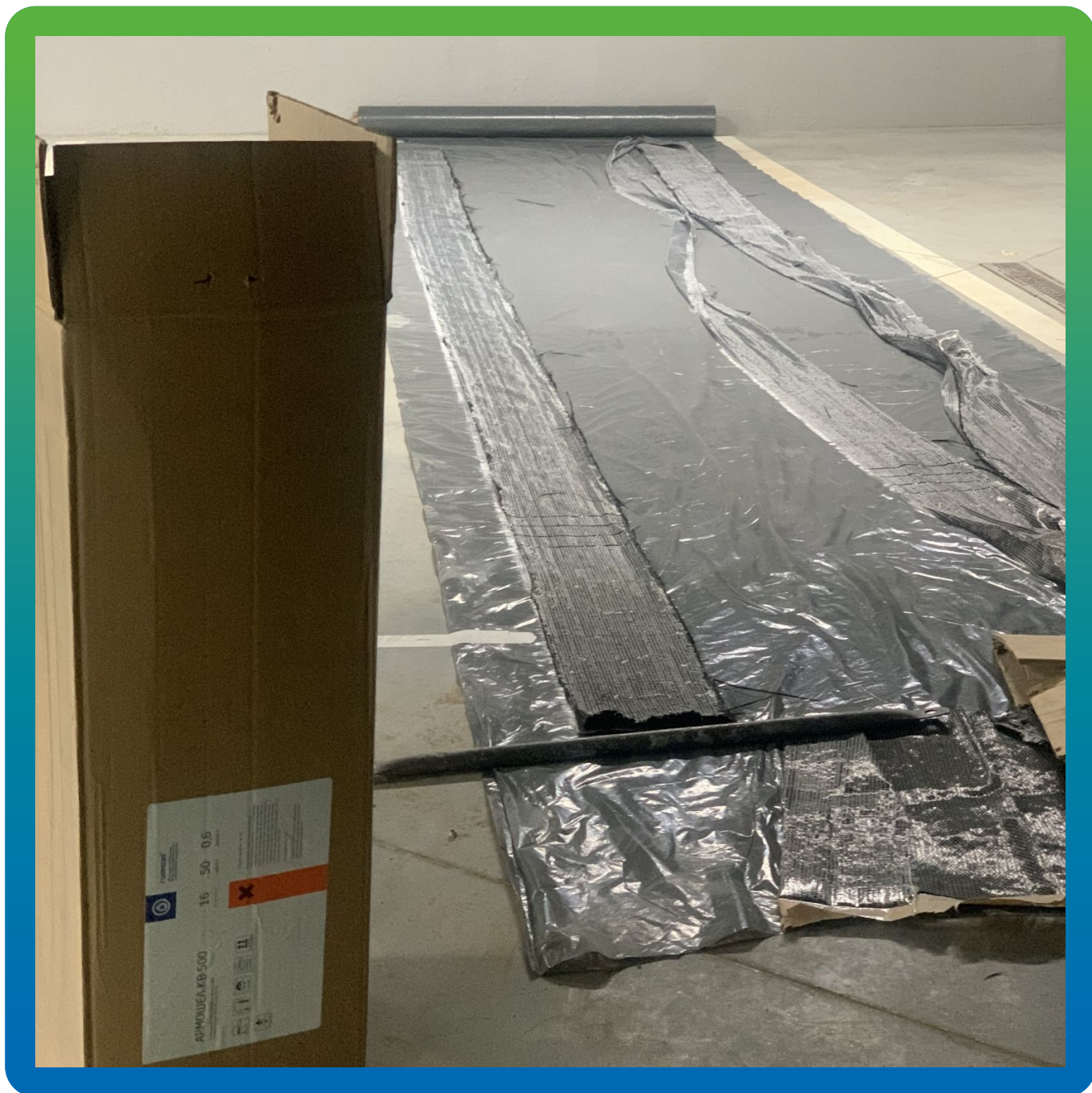
Раскладка и нарезка холста для последующей пропитки
