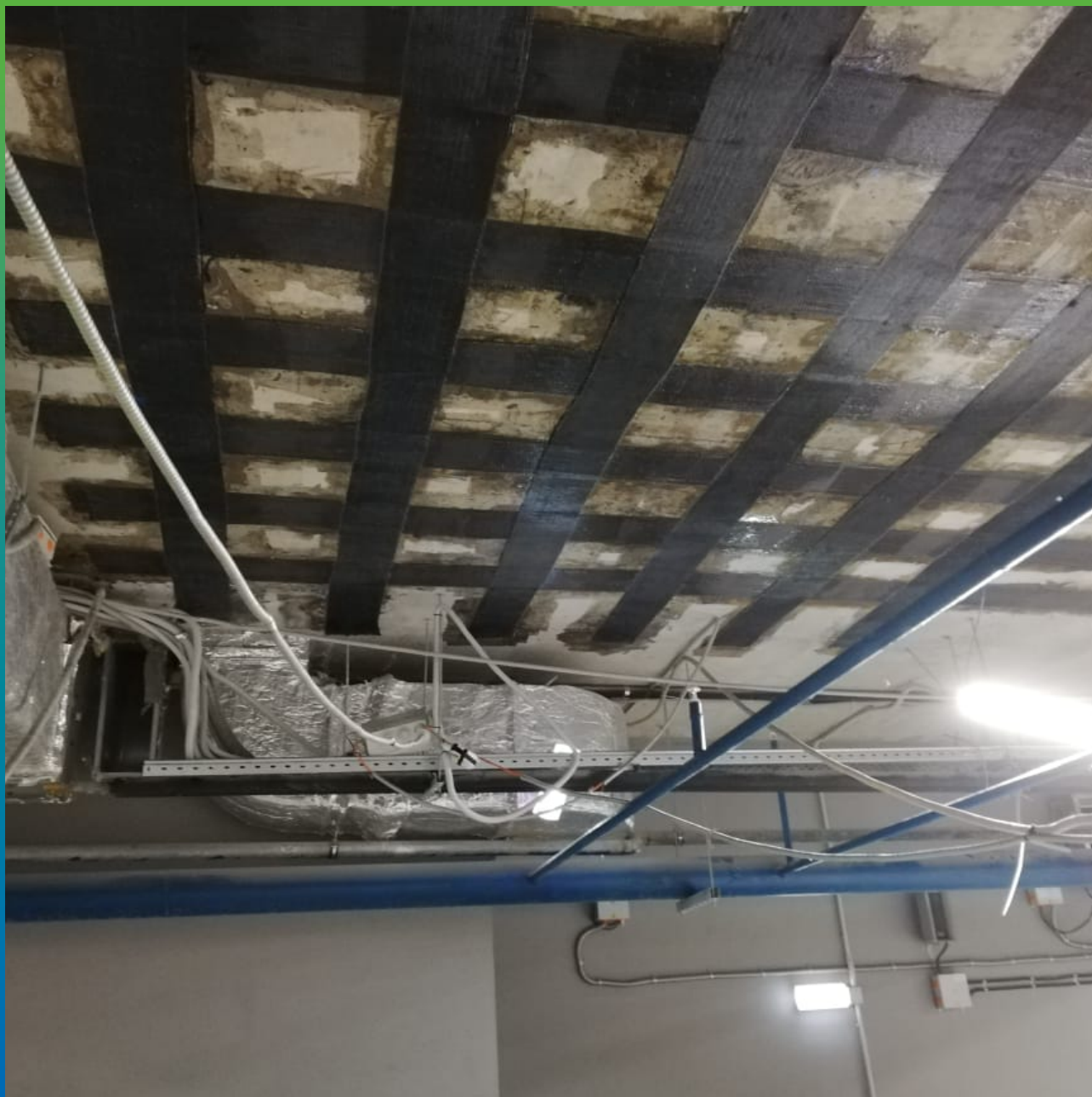
Монтаж системы Армошел
