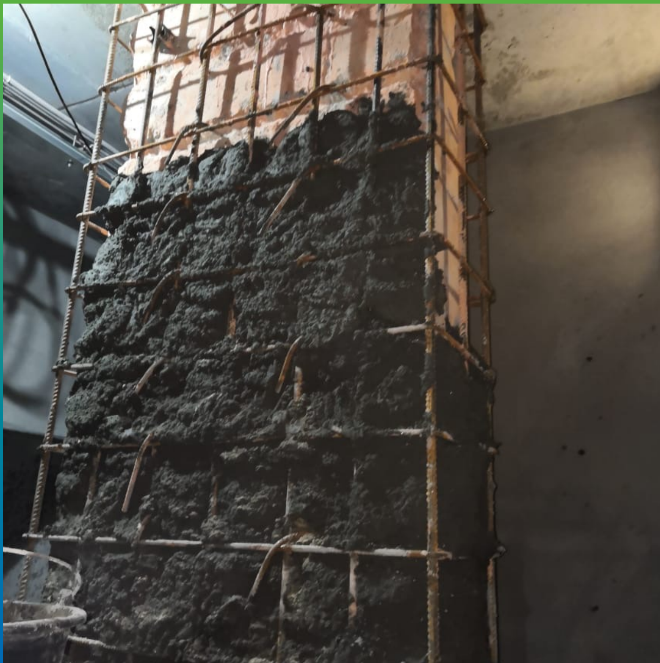
Нанесение Стармекс РМЗ на загрунтованную поверхность
