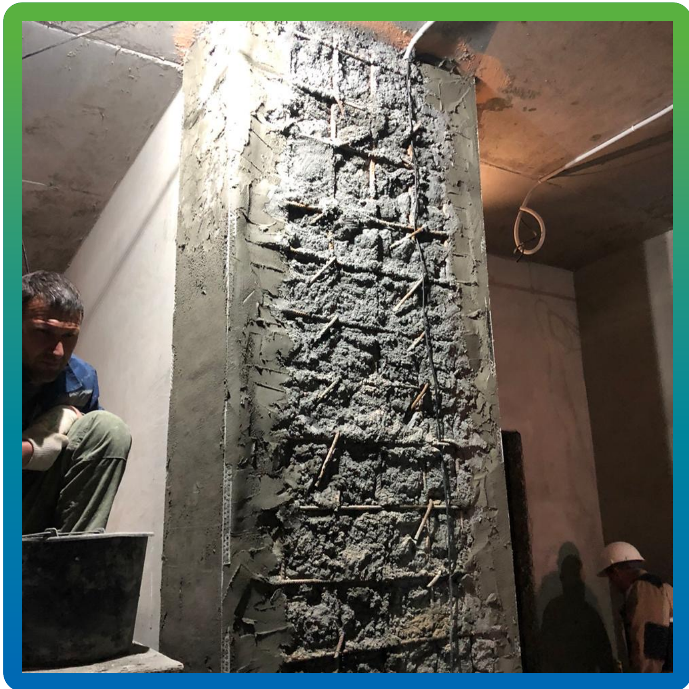
Нанесение Стармекс РМЗ на загрунтованную поверхность
