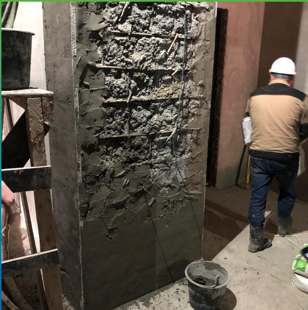
Нанесение Стармекс РМЗ на загрунтованную поверхность
