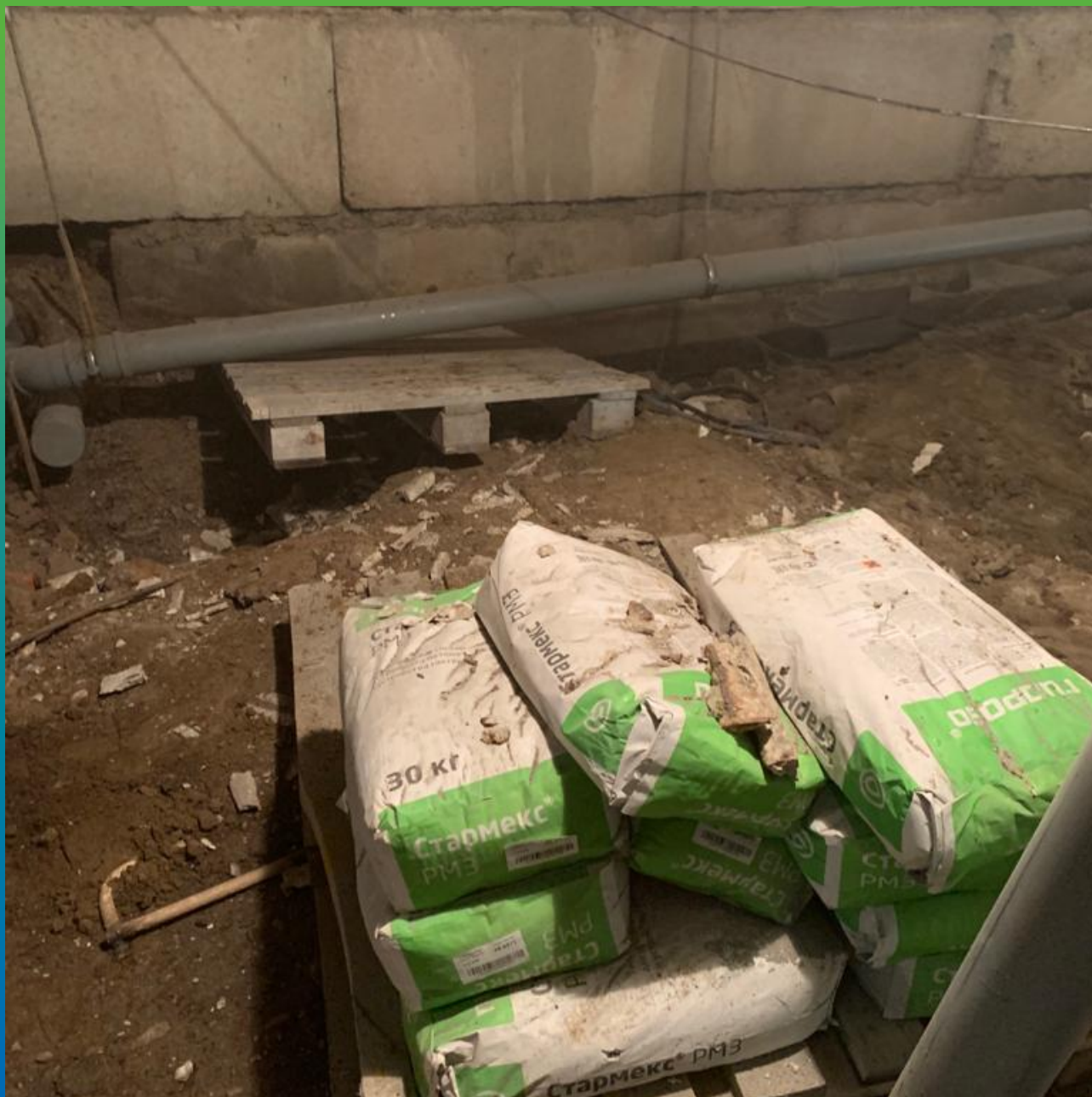
Ремонтный состав Стармекс РМЗ для последующего восстановления защитного слоя бетона.
