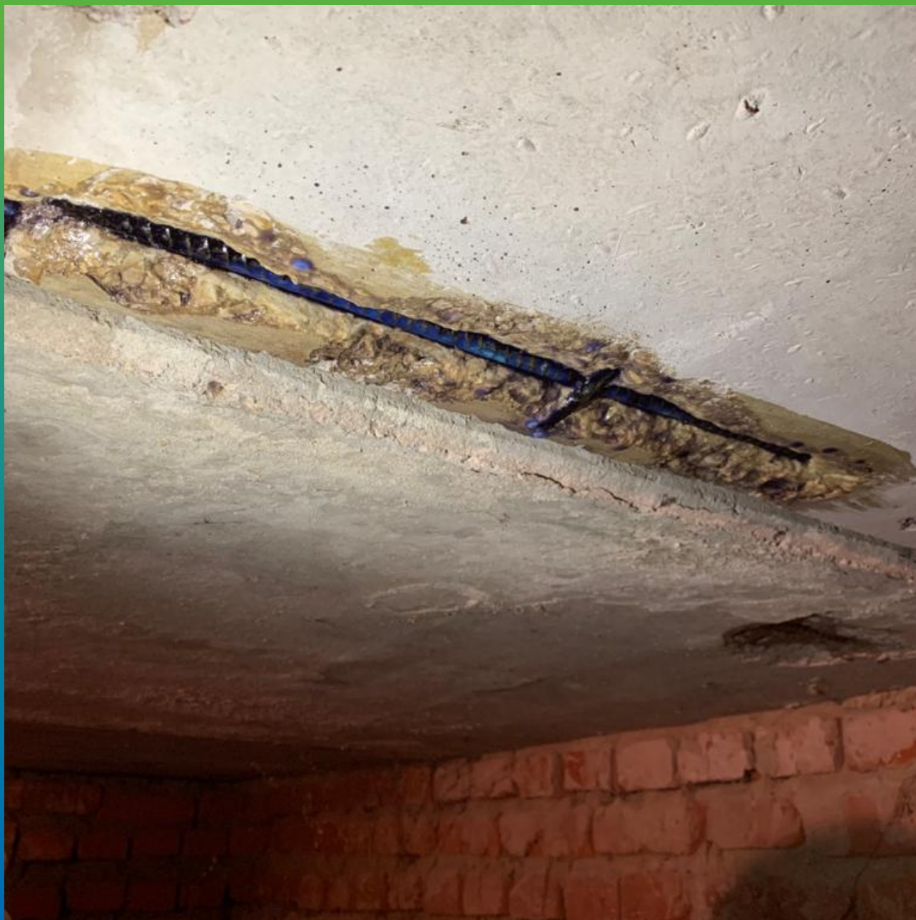
Арматура, обработанная составом для преобразования ржавчины и защиты арматуры.
