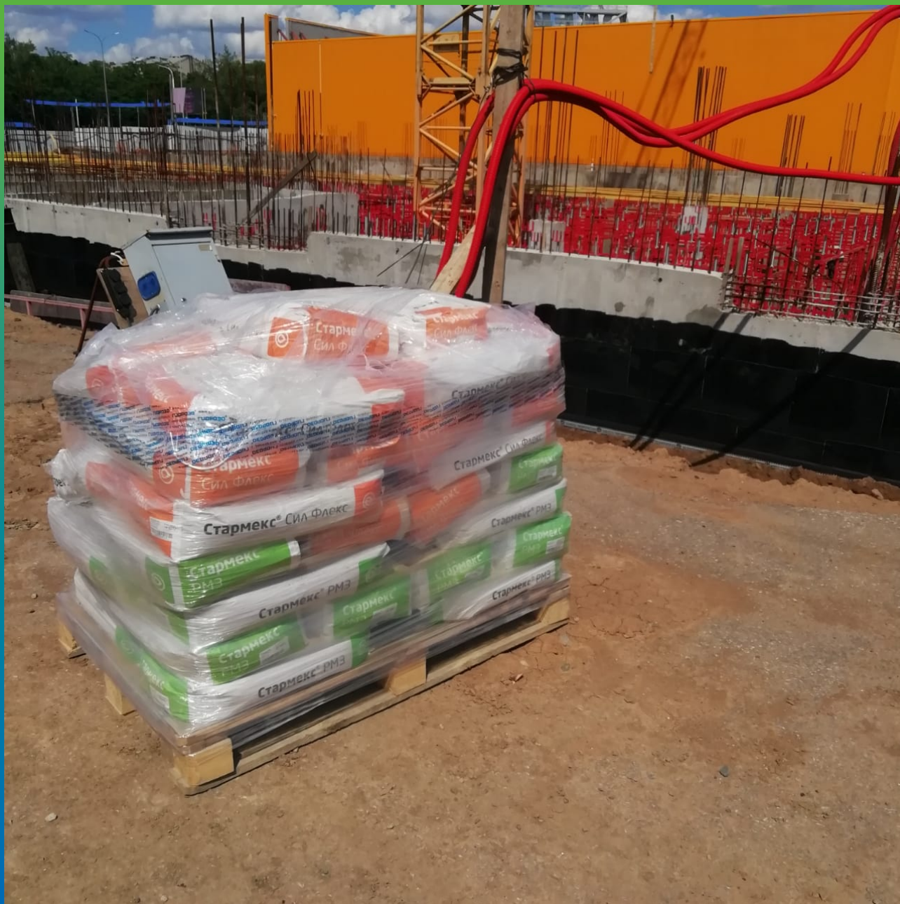
Материалы Гидрозо на объекте
