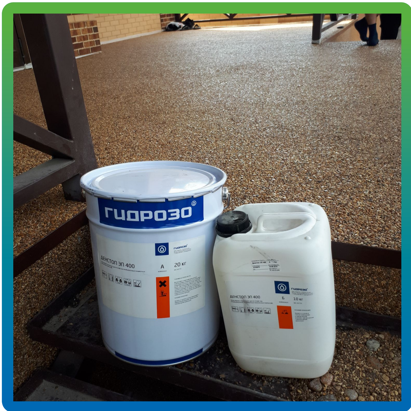
Материалы Гидрозо на объекте
