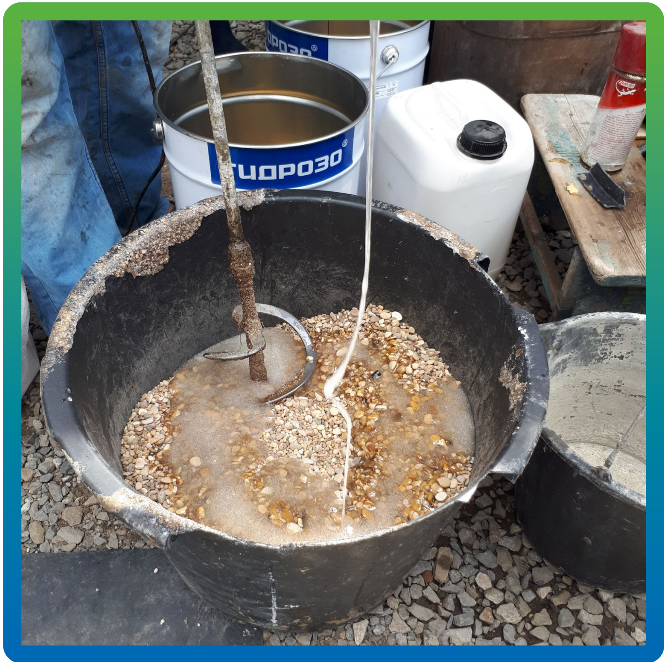
Смешивание прозрачного эпоксидного состава ДенсТоп ЭП 400 с галькой
