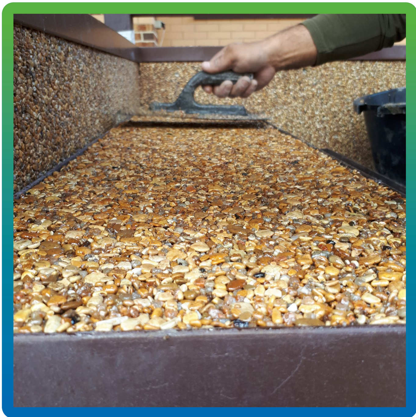
Укладка гальки с ДенсТоп ЭП 400
