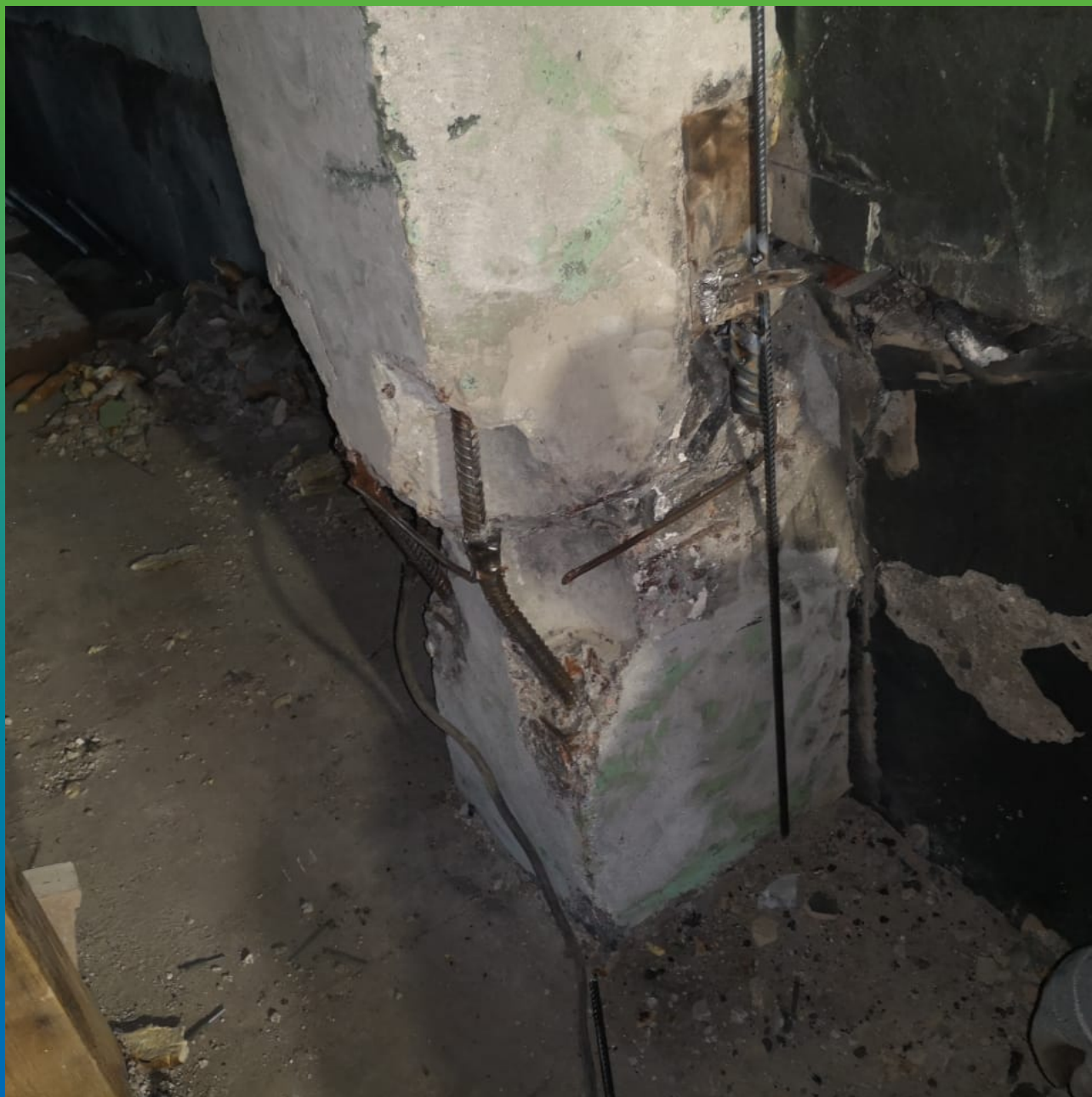
Разрушенная колонна
