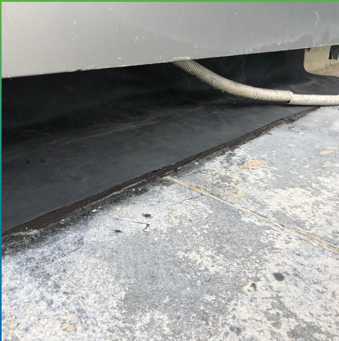
Процесс работы с Преласты СТ
