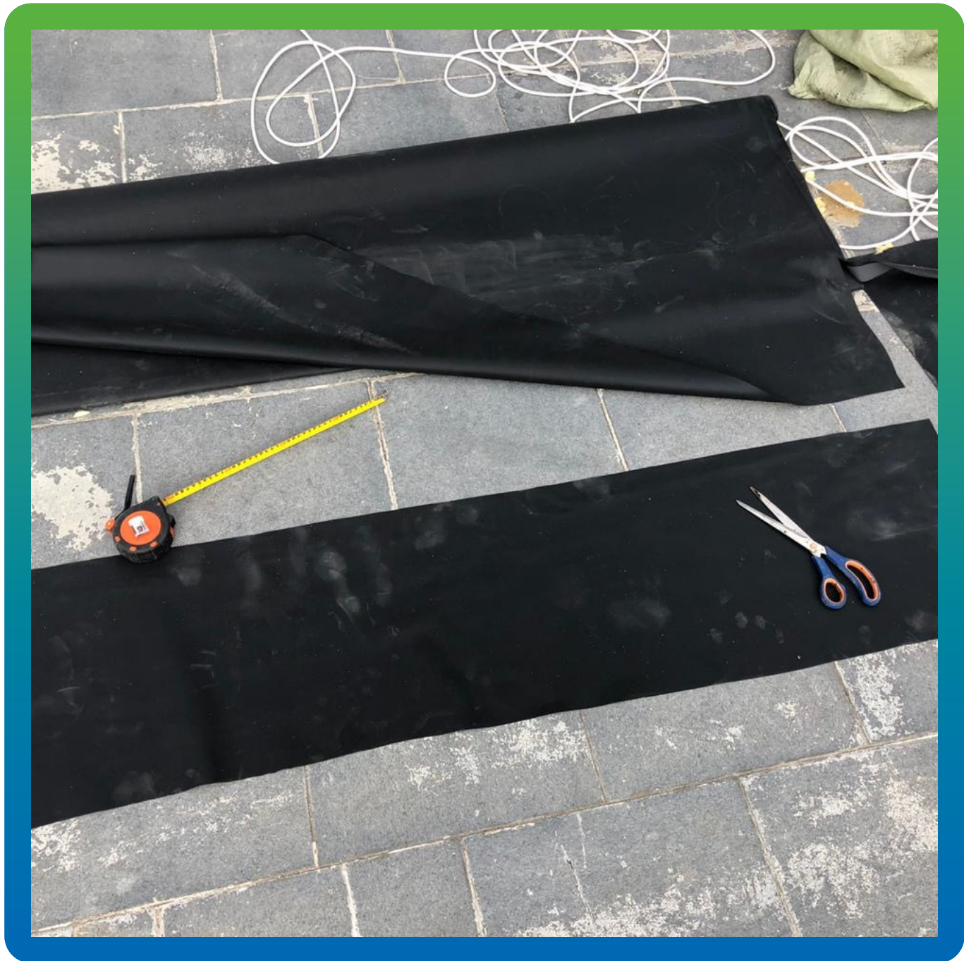
Подготовка (раскрой) мембраны для монтажа на шов примыкания
