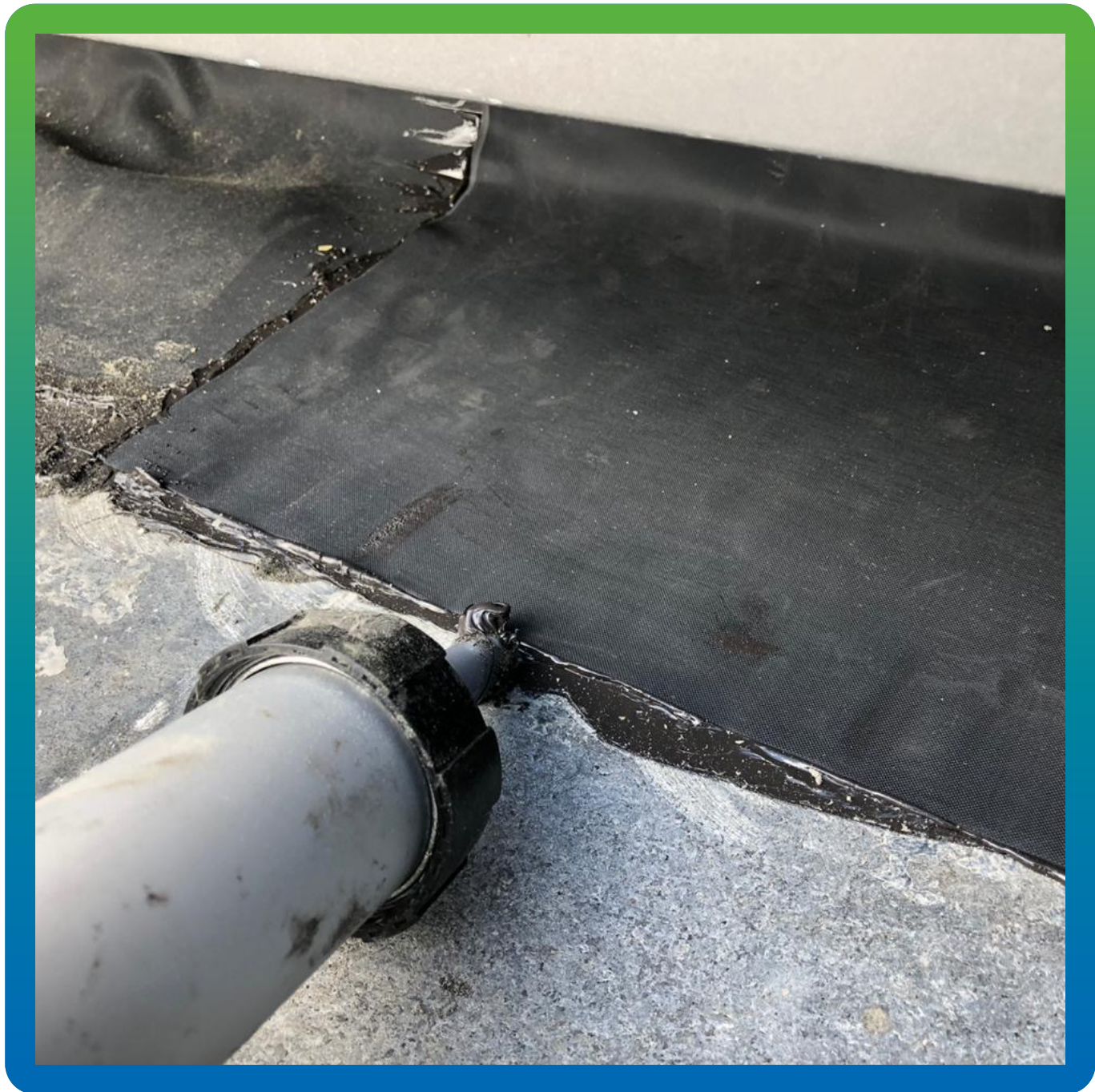
Нанесение Манодил Бонд Ф
