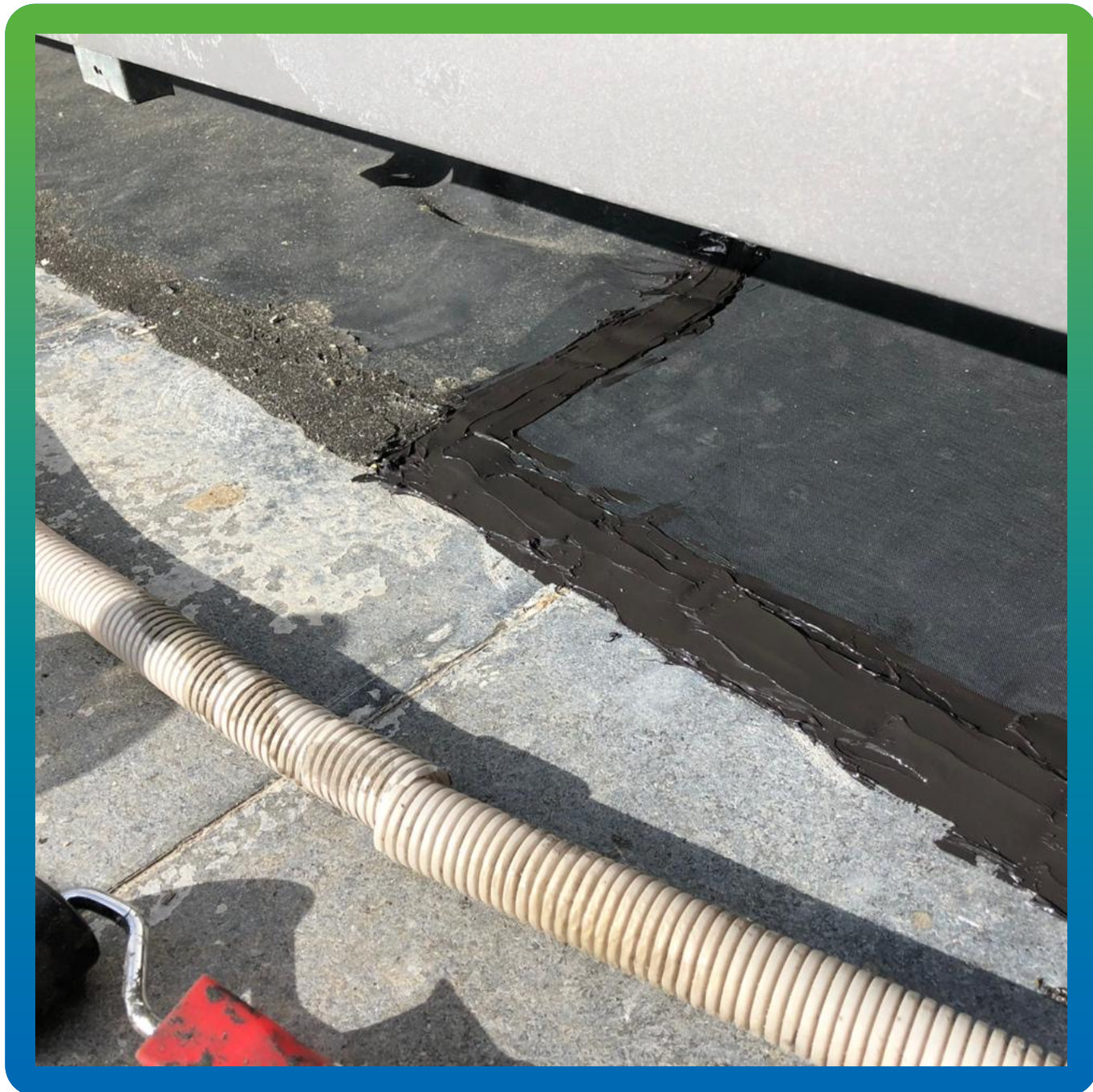
Стыковка участков ЭПДМ Мебраны Прелести
