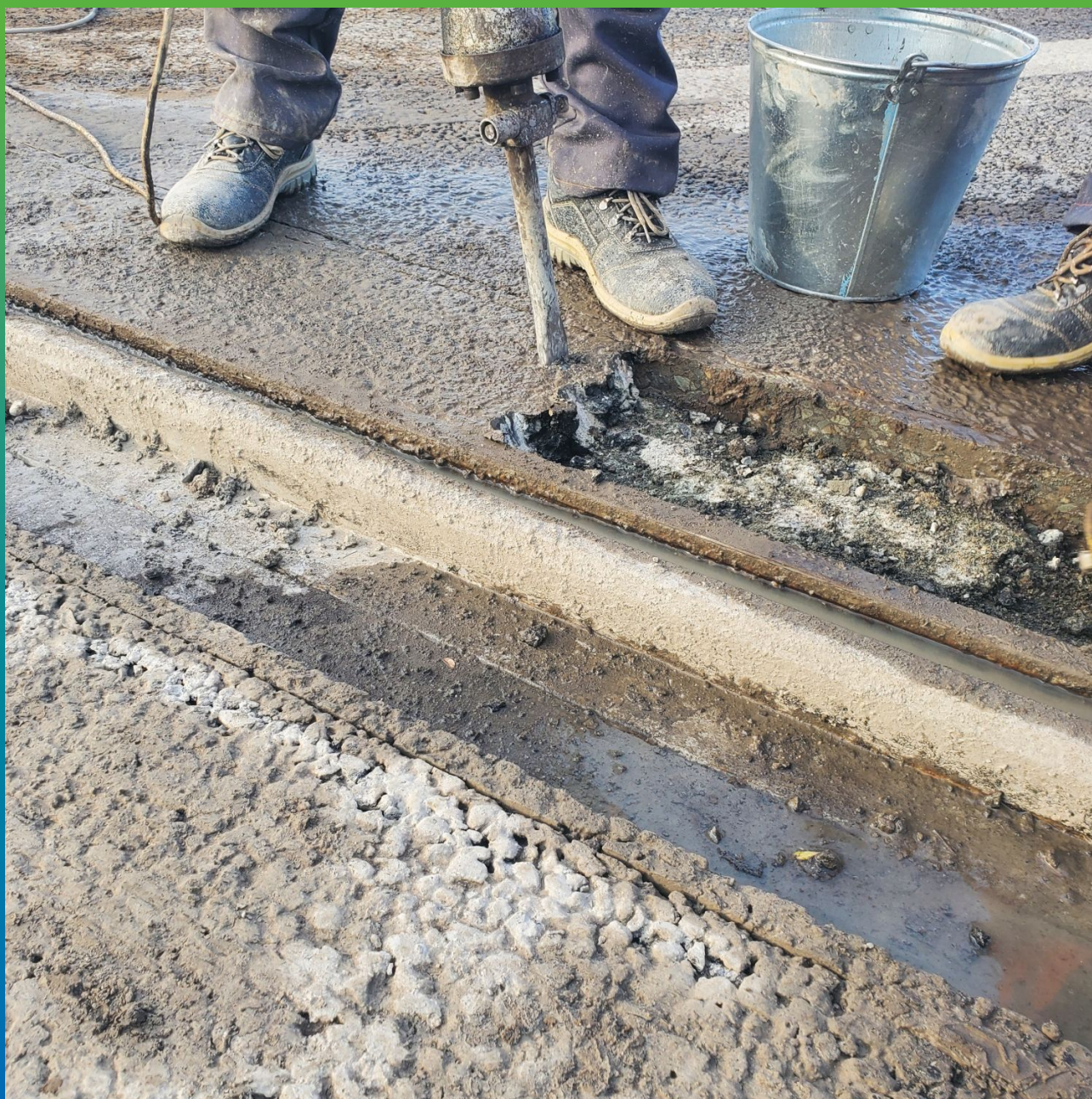
Демонтаж асфальтобетона в штробе при помощи отбойного молотка
