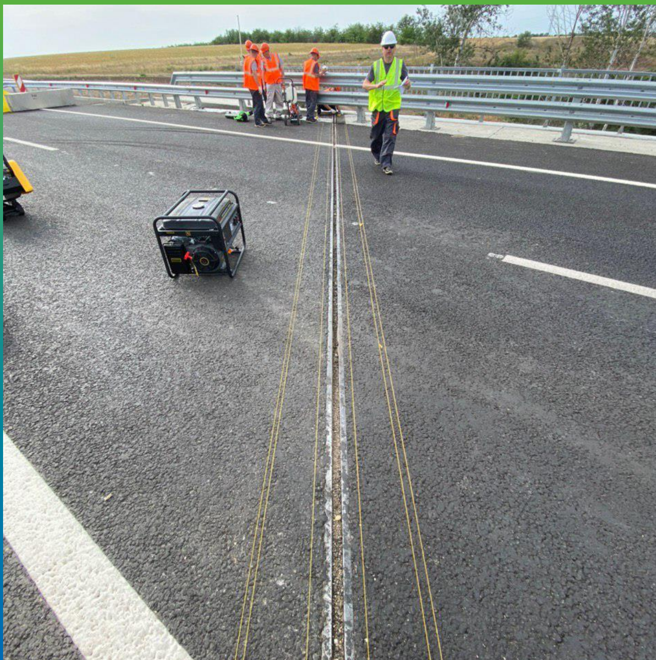
Разметка предшовной зоны перед устройством штроб
