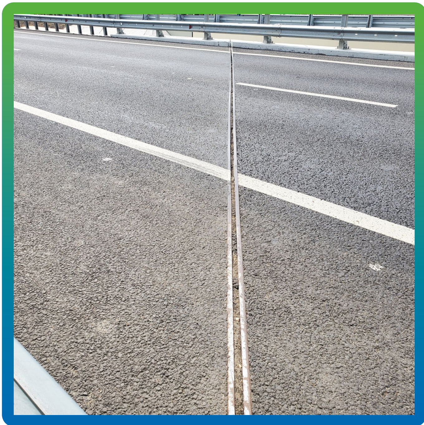
Вид деформационного шва до начала работ по устройству пришовной зоны.
