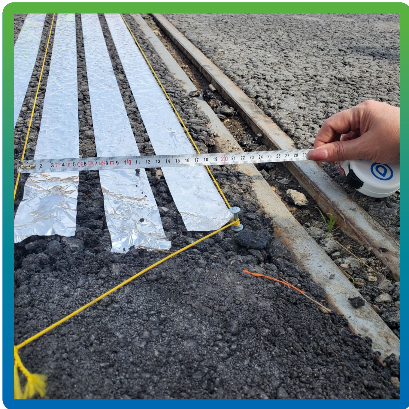
Разметка для дальнейшей нарезки штрыбы предшовной зоны
