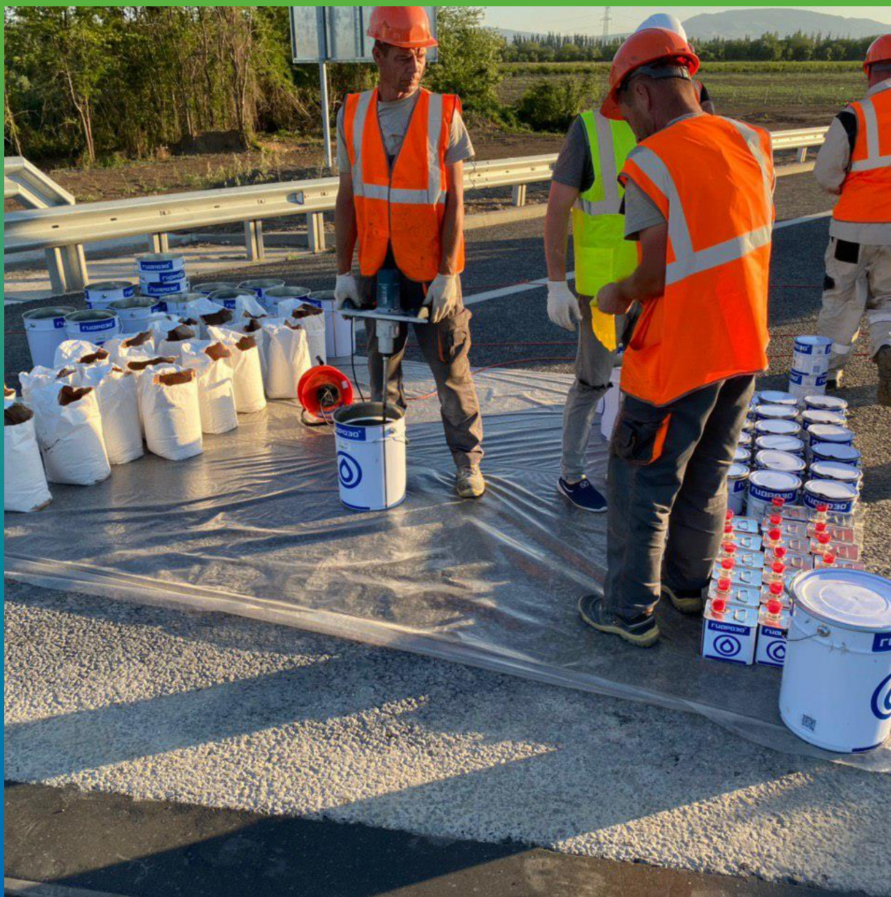
Рабочее место, подготовленное к замешиванию состава Манопур 336
