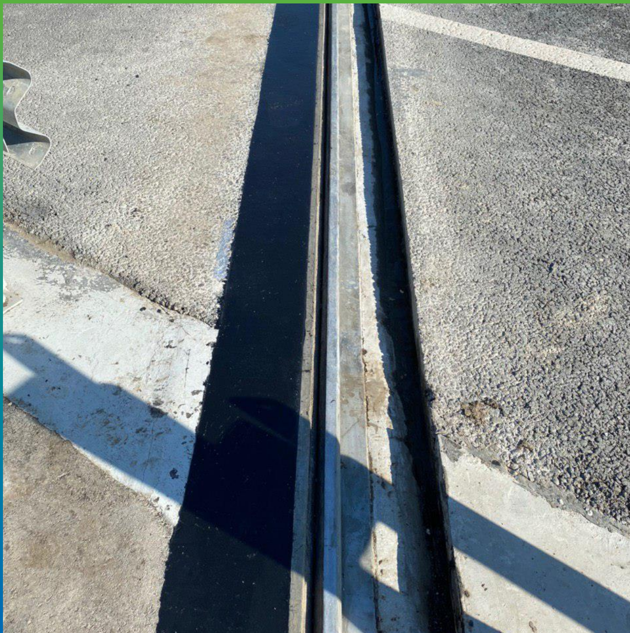
Заливка готового состава в штрабу, выравнивание при помощи шпателя
