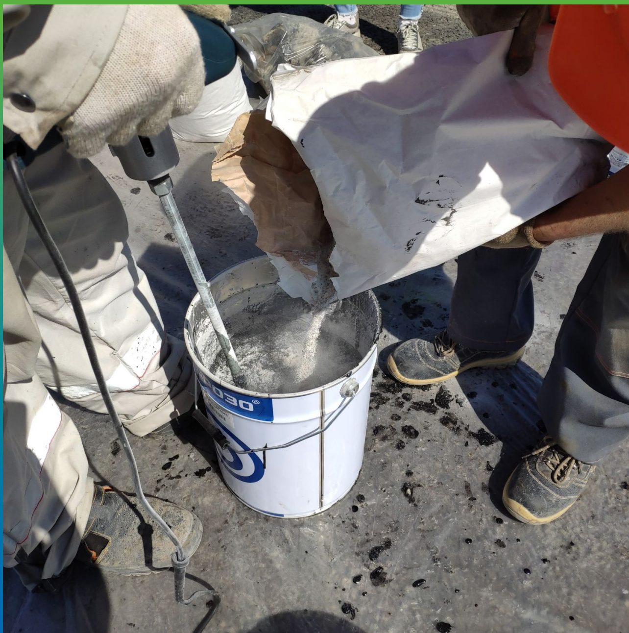
Процесс смешивания компонентов материала. Компонент А
