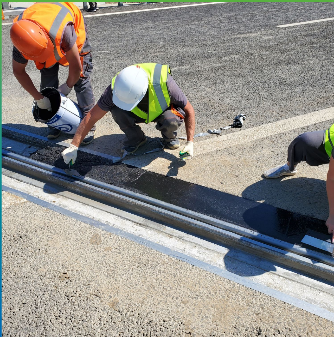
Выравнивание состава в штробе при помощи шпателя
