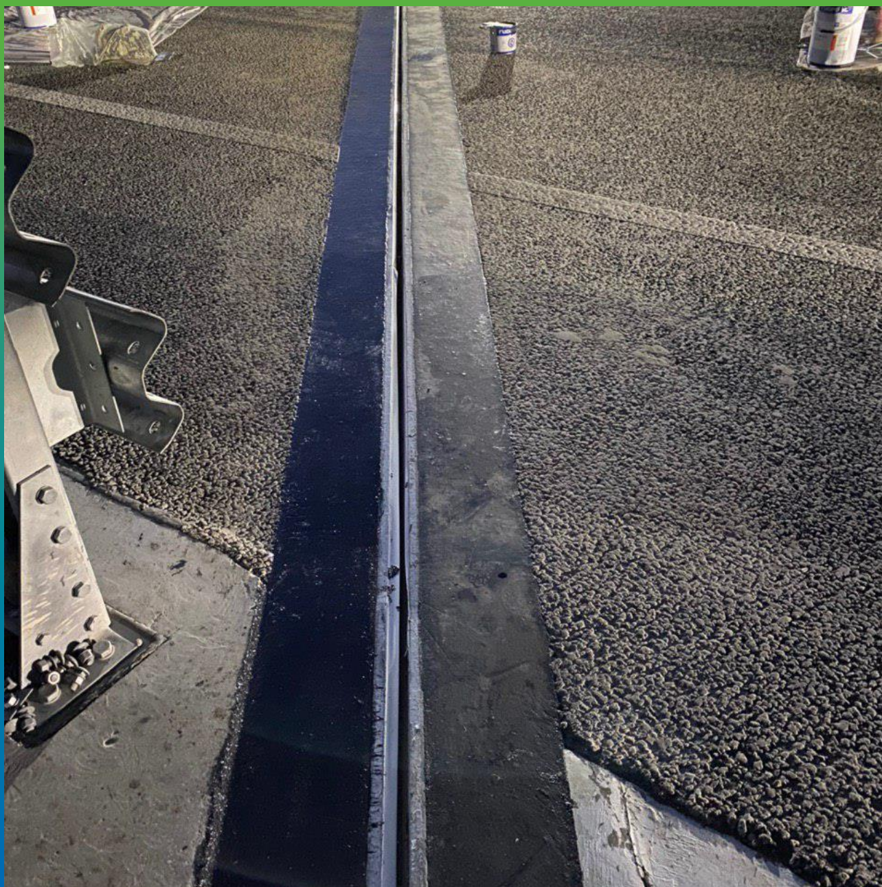
Деформационный шов с выполненной переходной зоной, готовый к эксплуатации.
