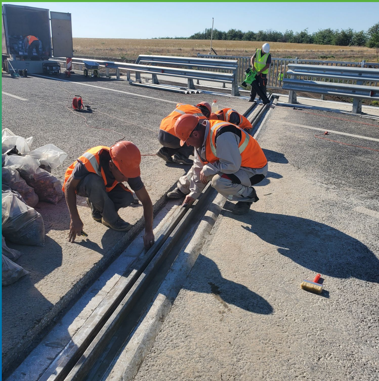
Обезжиривание металлических конструкций деформационного шва.
