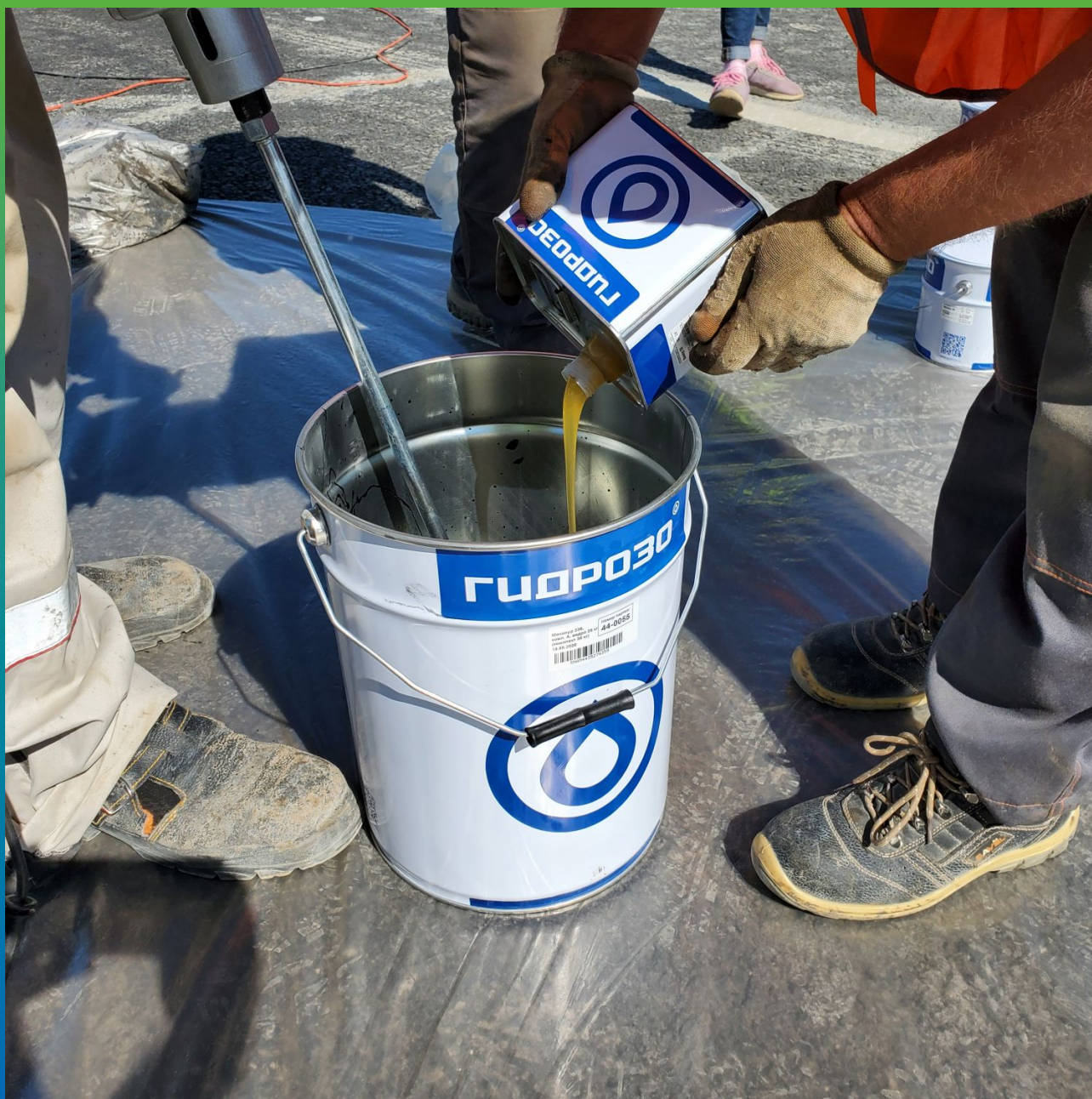
Процесс смешивания компонентов материала. Компонент Б2.
