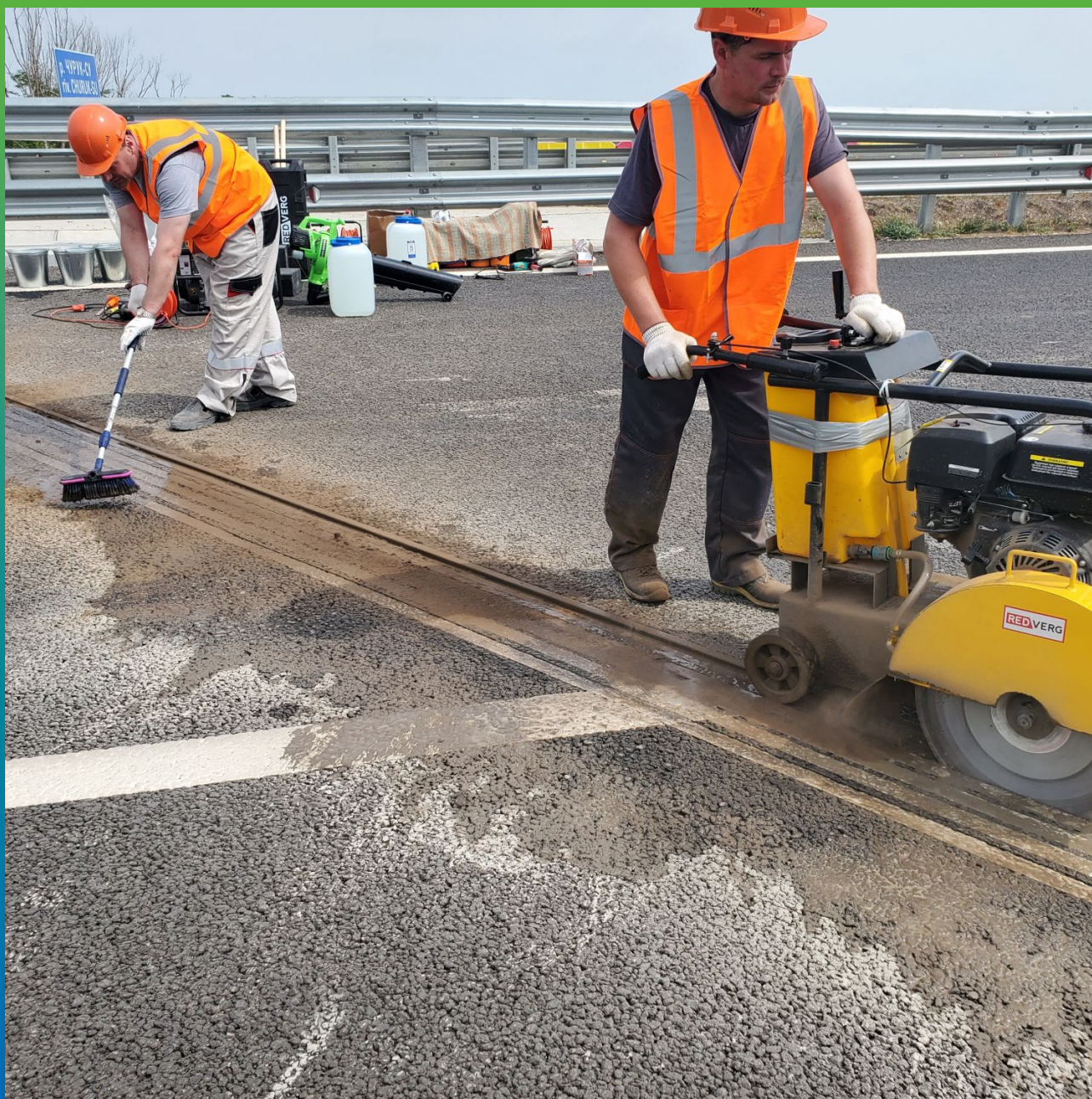
Устройство пропилов в асфальтобетоне швонарезчиком
