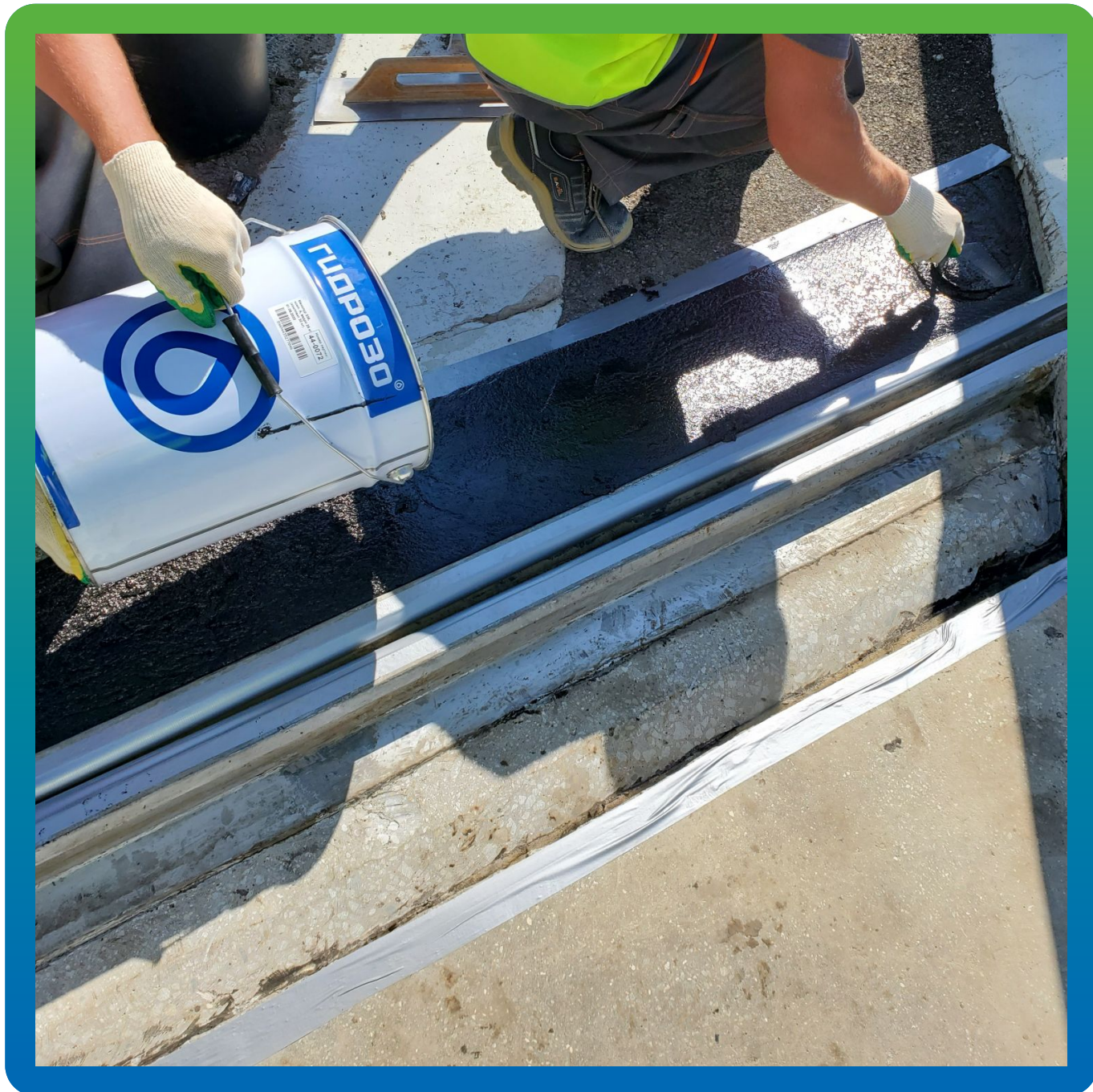
Заливка готового состава в штробу.
