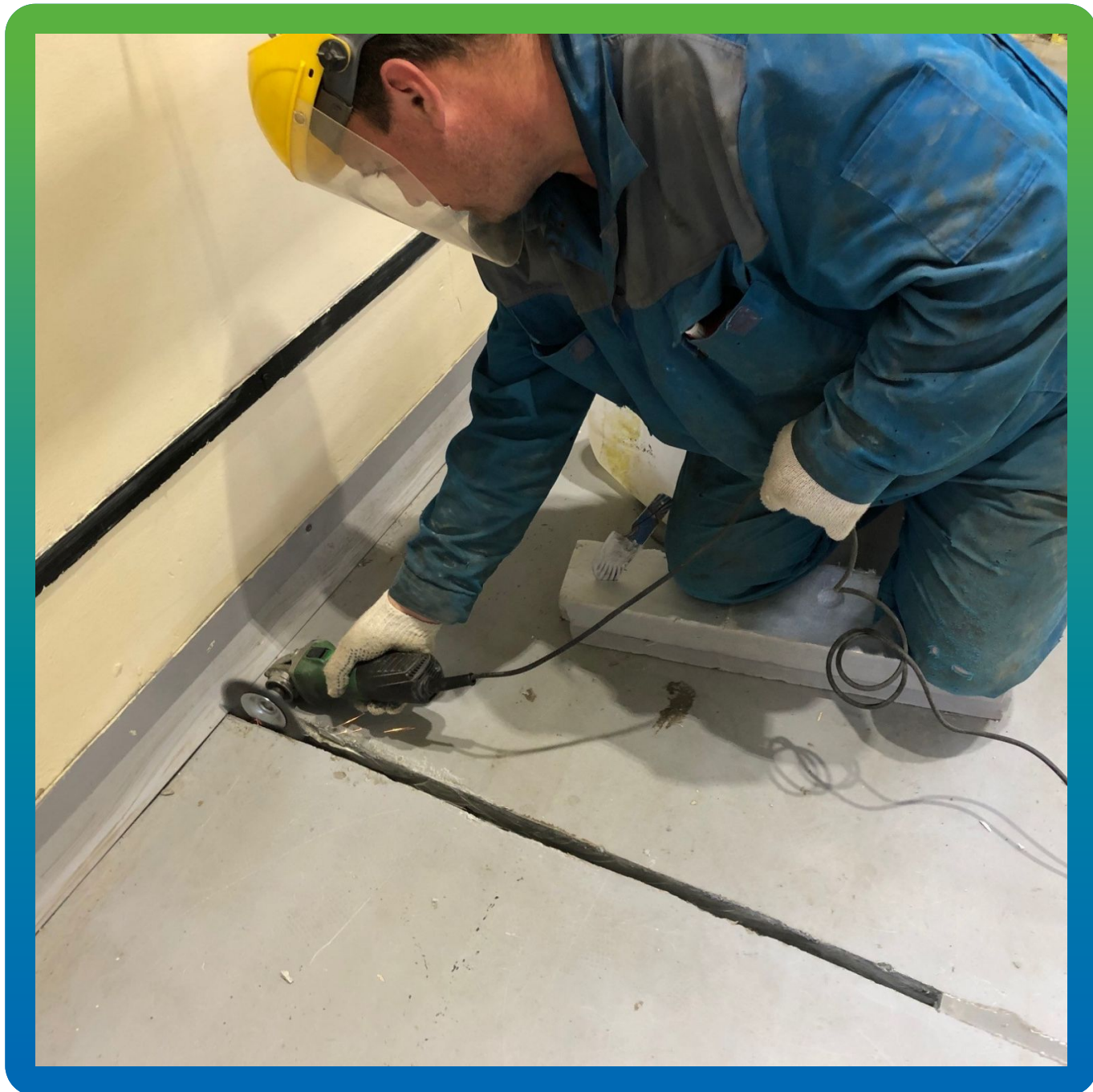
Зачистка кромок шва шлифовкой от старого герметика
