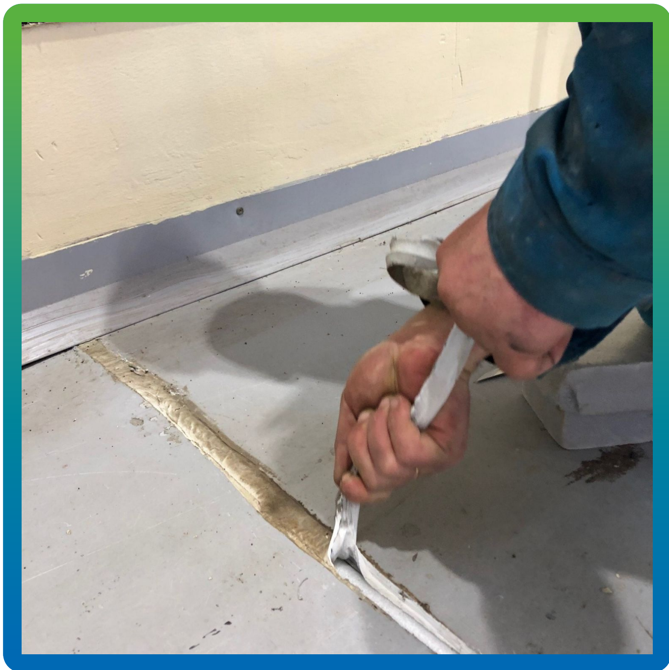
Демонтаж старого герметика
