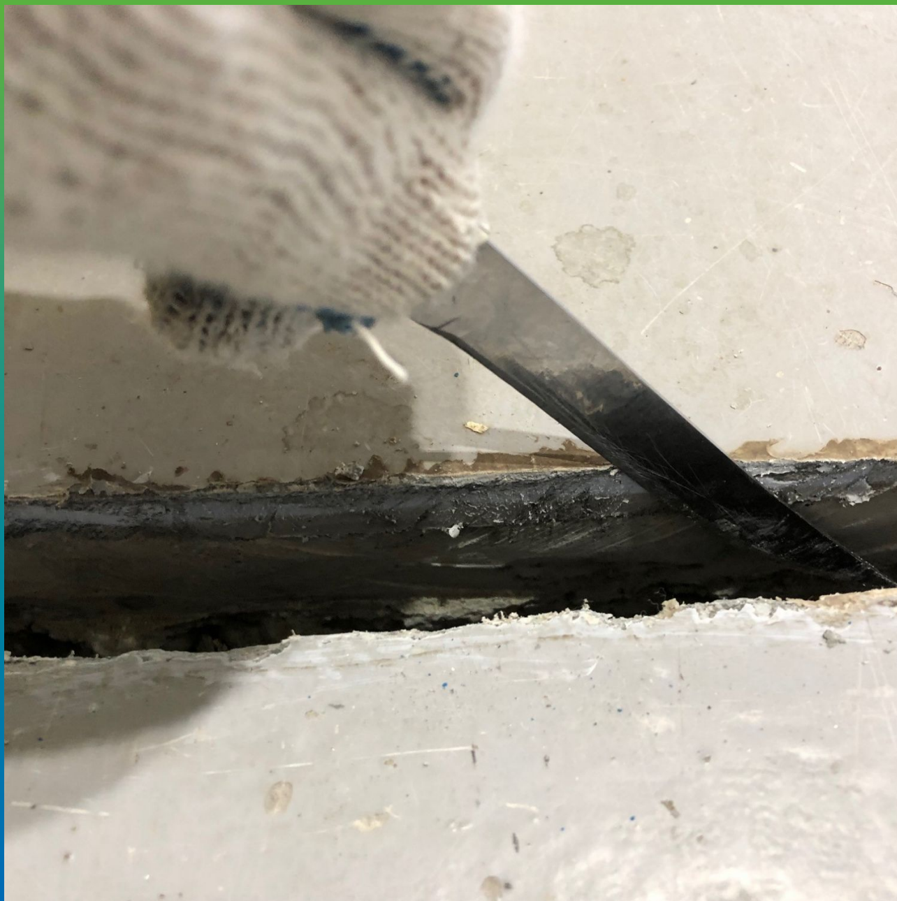
Очистка кромок шва от старого герметика
