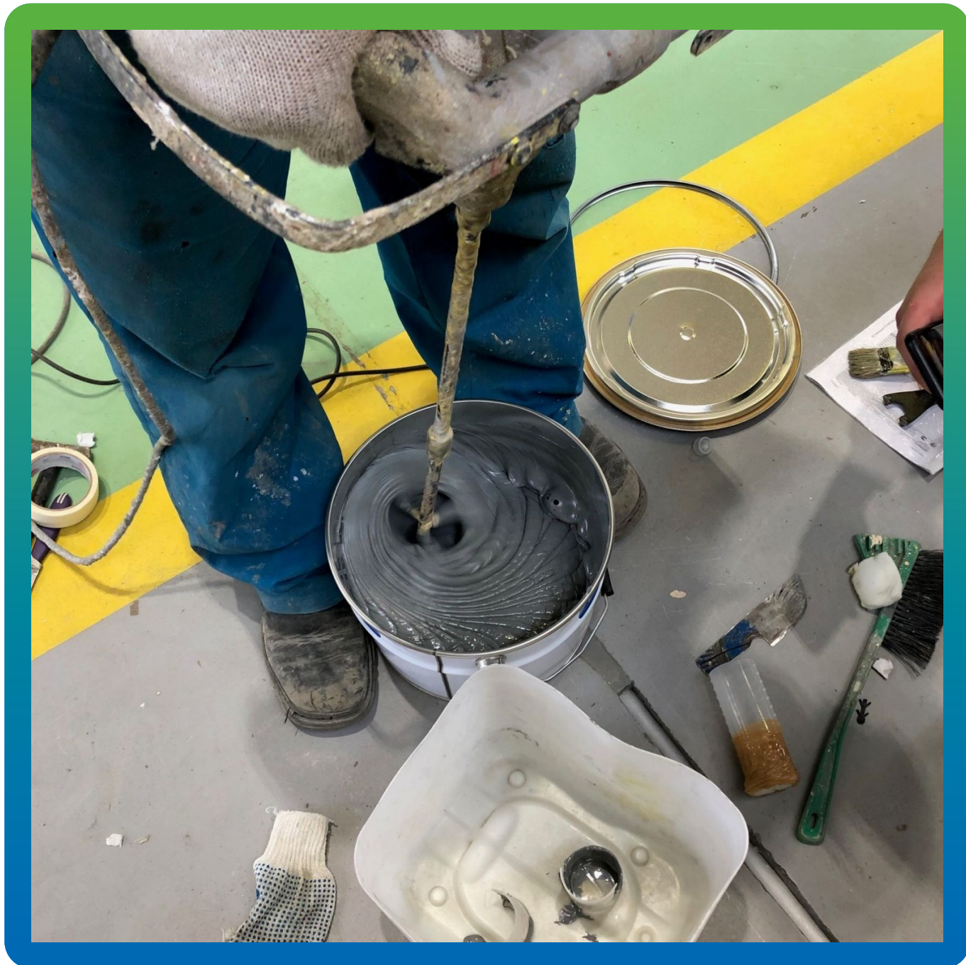
Замешивание компонентов А и Б литьевого герметика Манодил ПУ 696
