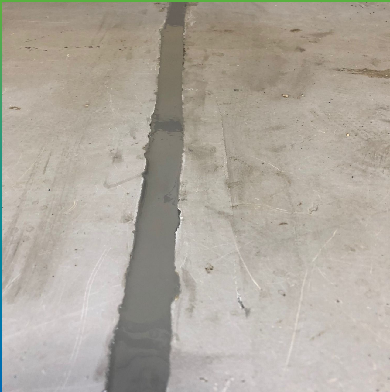
Вид смонтированного литьевого герметика Манодил ПУ 696
