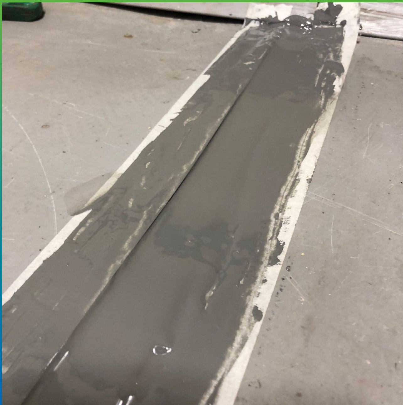
Заливка литьевого герметика Манодил ПУ 696 в сформированный шов
