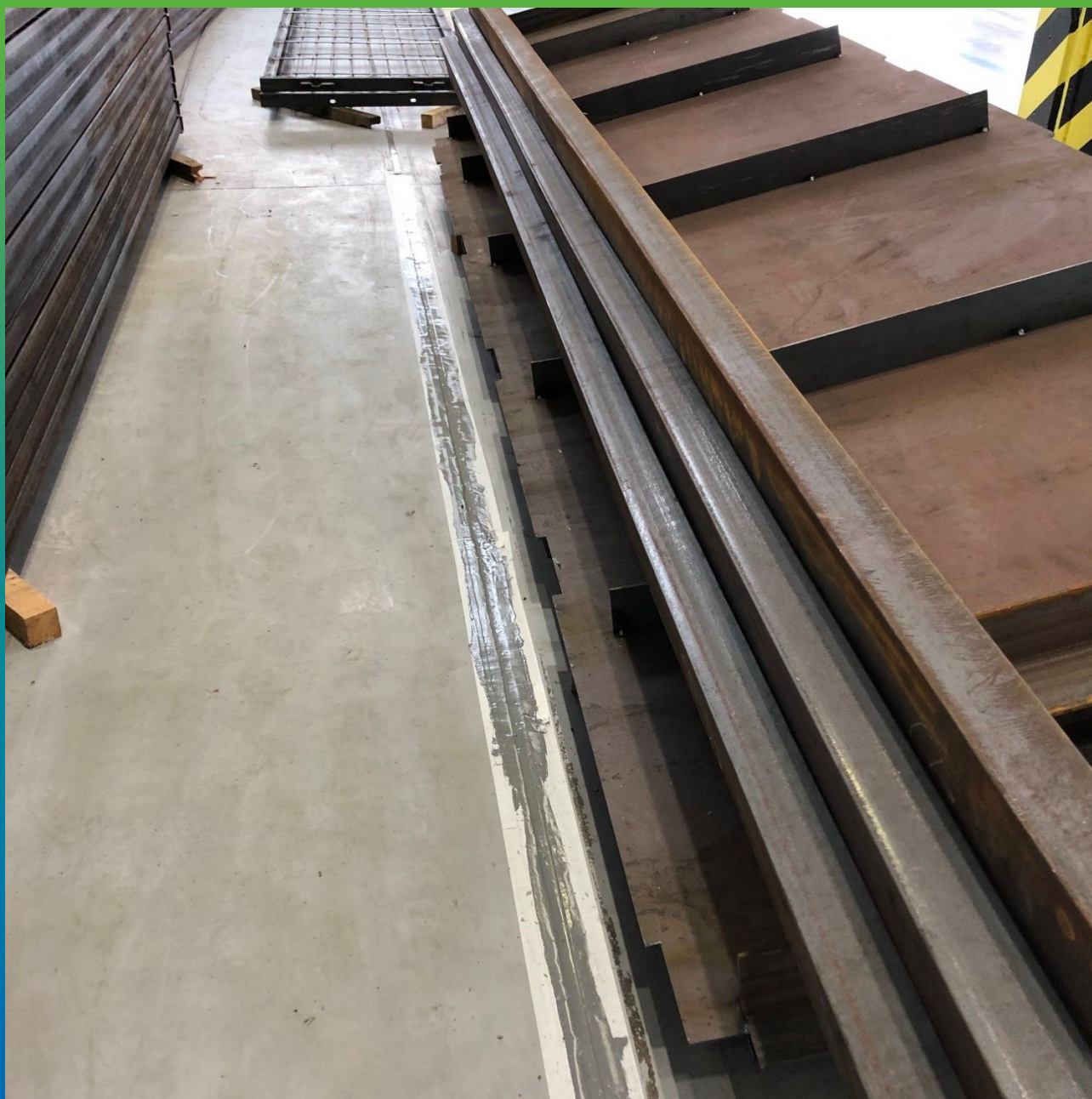
Другой вид смонтированного литьевого герметика Манодил ПУ 696
